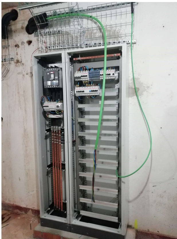
Proceso de montaje de cuadro general de baja tensión en sótano
