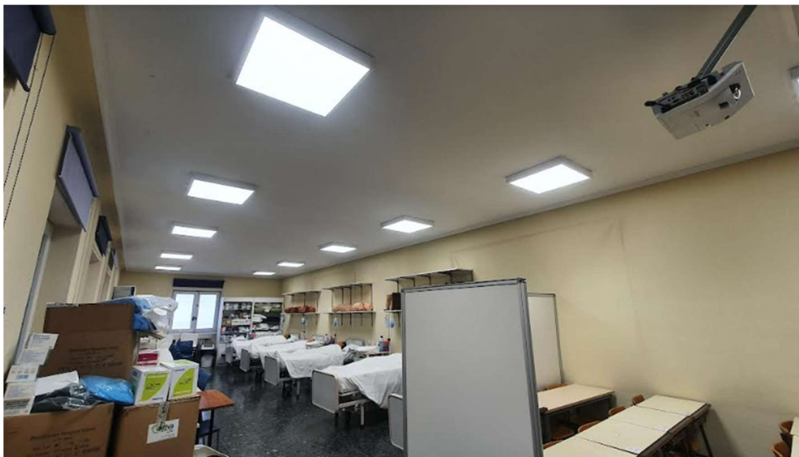
Sustitución de iluminación en aulas formativas
