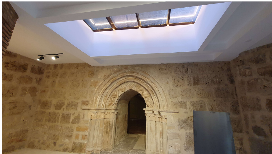
Proyectores de iluminación Led en carril
