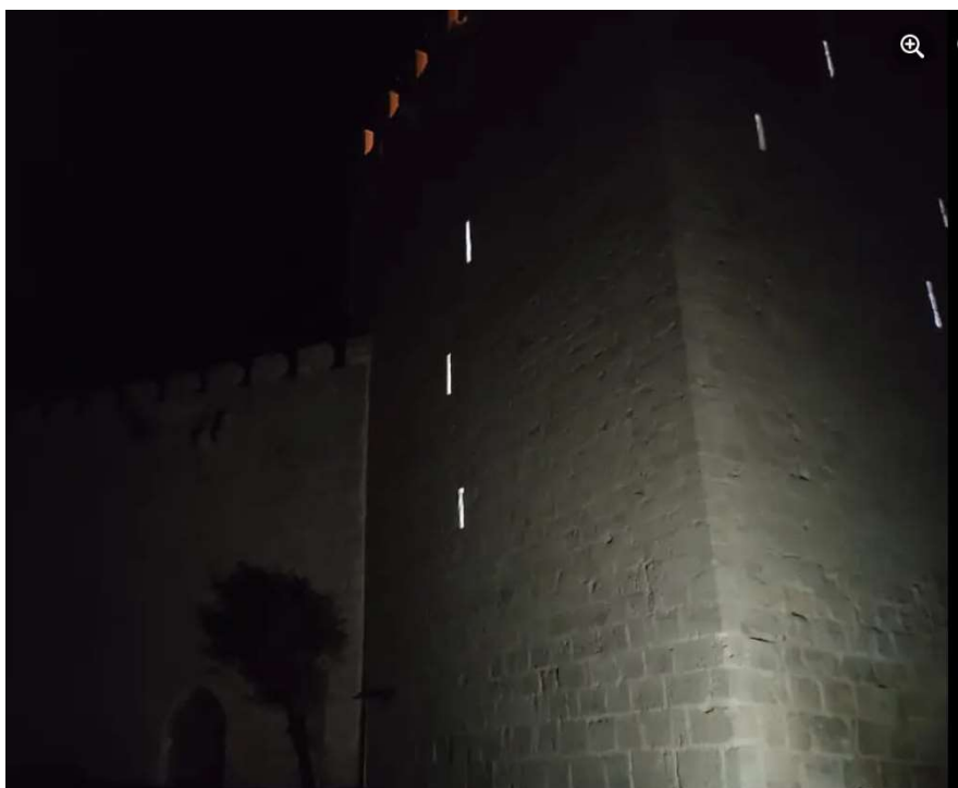
Iluminación exterior de las troneras y terraza con Led blanco dinámico
