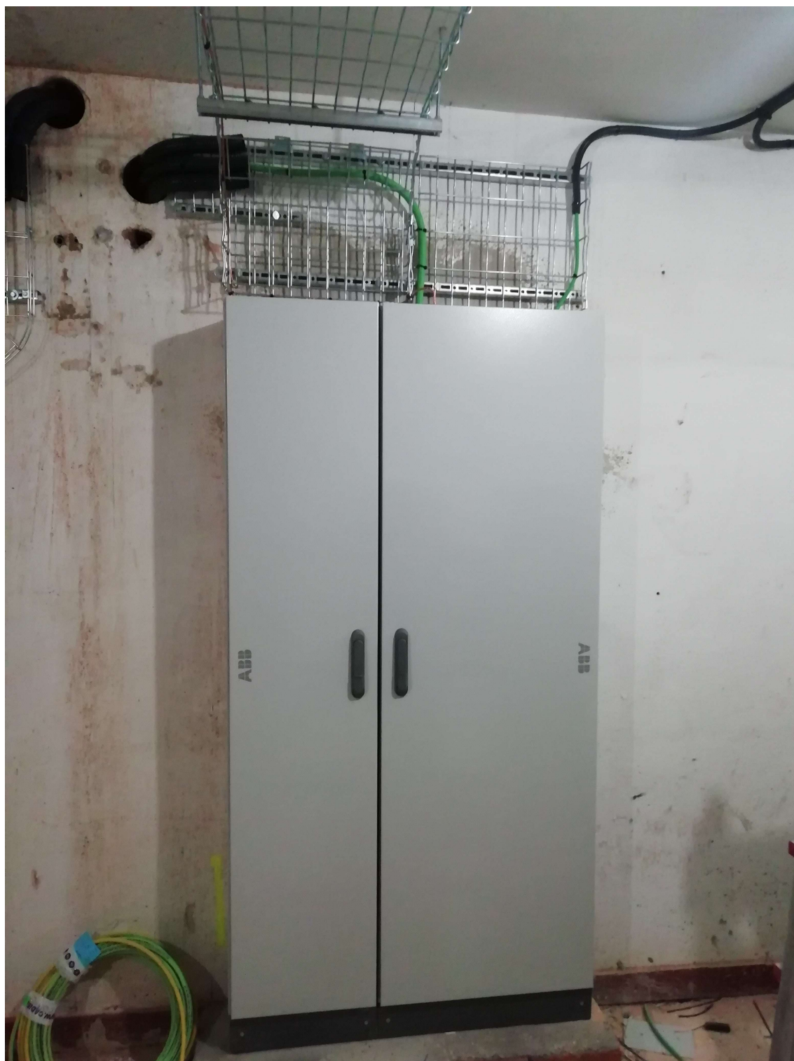
Cuadro general baja tensión, terminado
