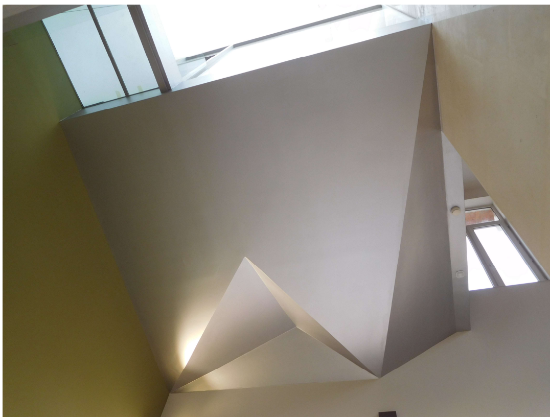
Iluminación y detalle constructivo de techo del acceso
