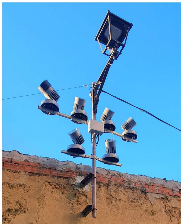
Sistema de proyección instalado en postelete
