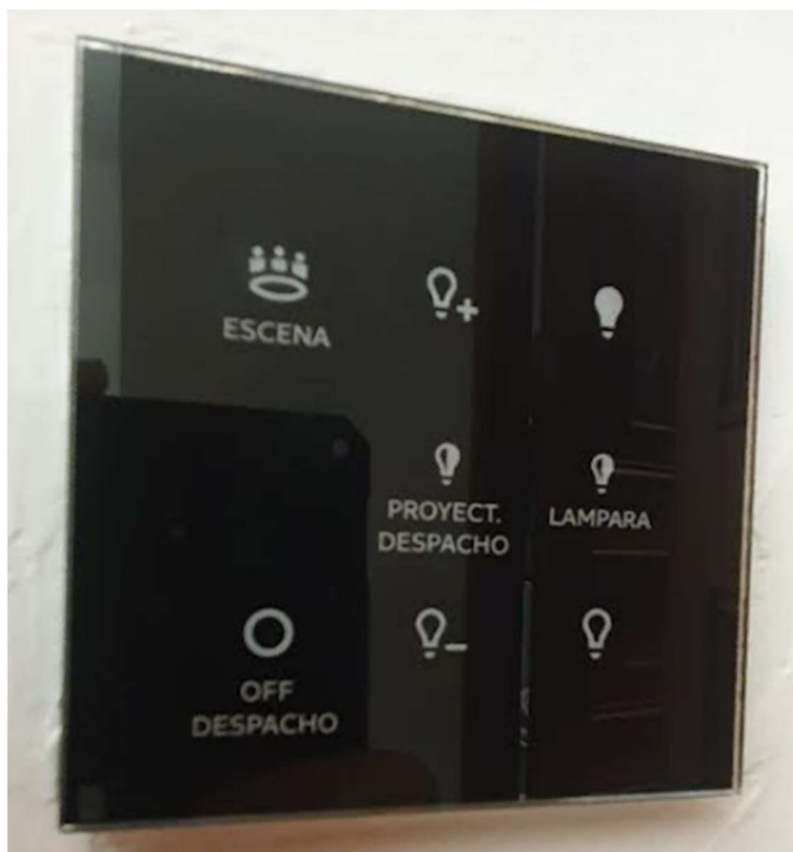
Panel de control multipulsador KNX
