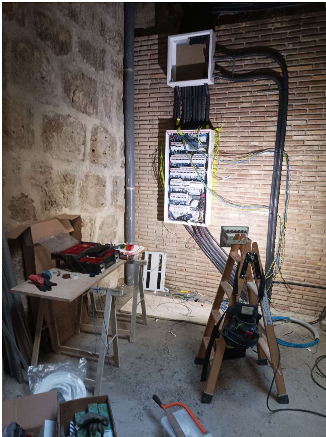
Montaje en obra de cuadro de secundario de torre
