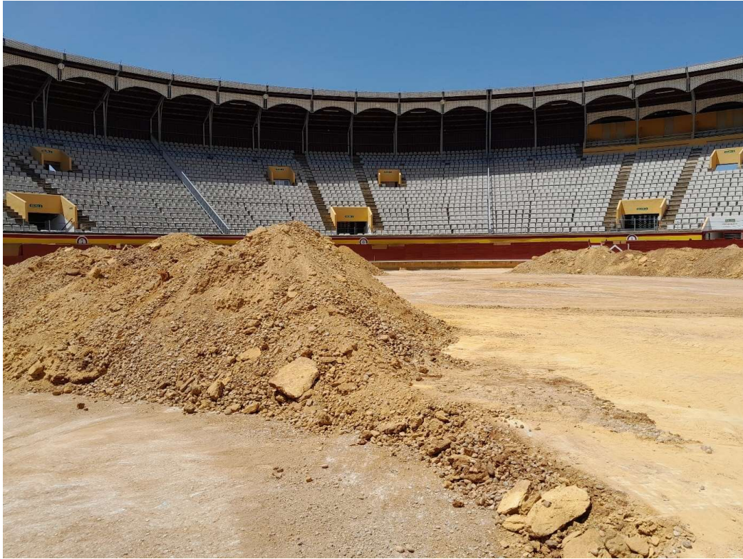
Retirada del material de baja permeabilidad.
