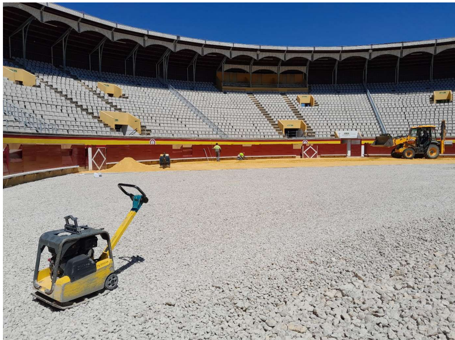
Retirada del material de baja permeabilidad.
