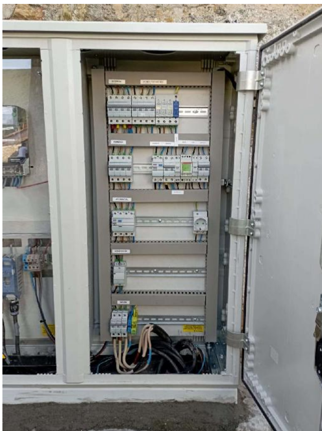
Reforma de cuadro de mando y protección
