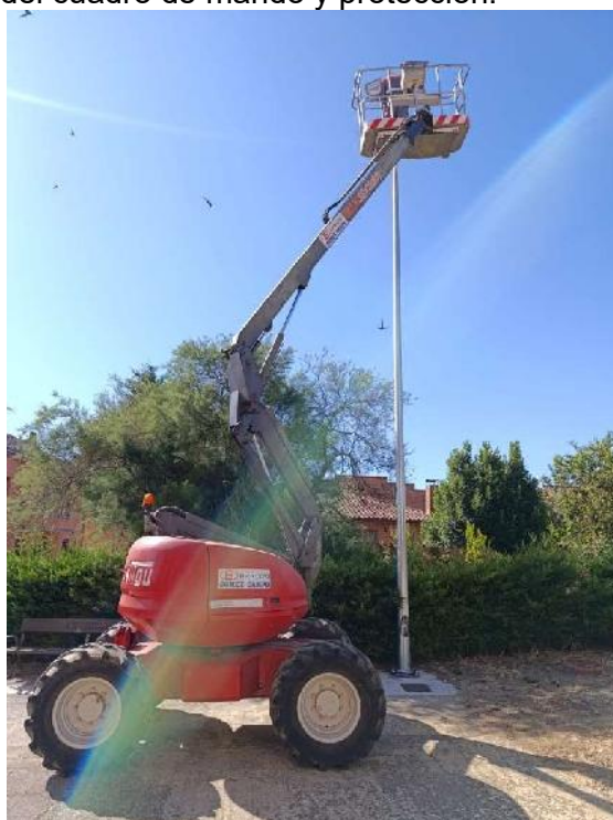
Trabajos instalación de punto luminoso en columna metálica
