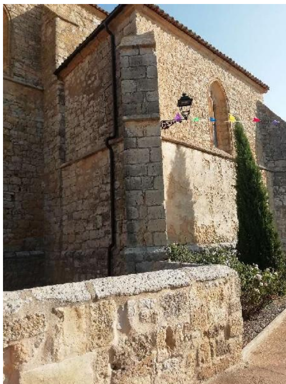
Nuevo farol villa Led en fachada de la iglesia
