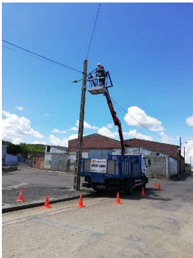
Trabajos sustitución luminarias viales en poste hormigón
