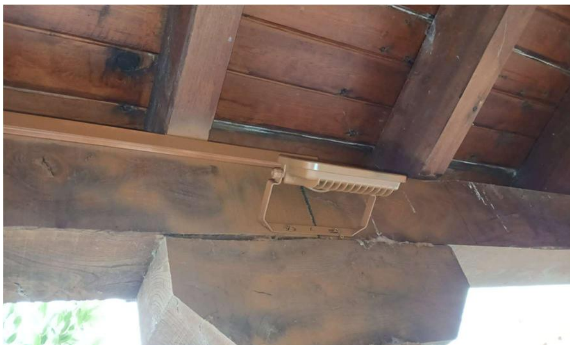
Integración y disimulado de proyector y canaleta en soportal de San Nicolás
