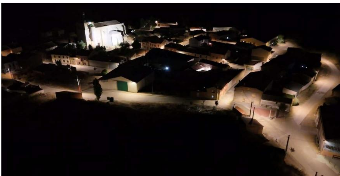
Vista nocturna de la instalación reformada
