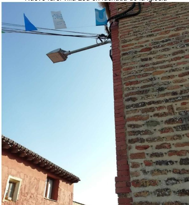
Nueva luminaria vial Led en fachada
