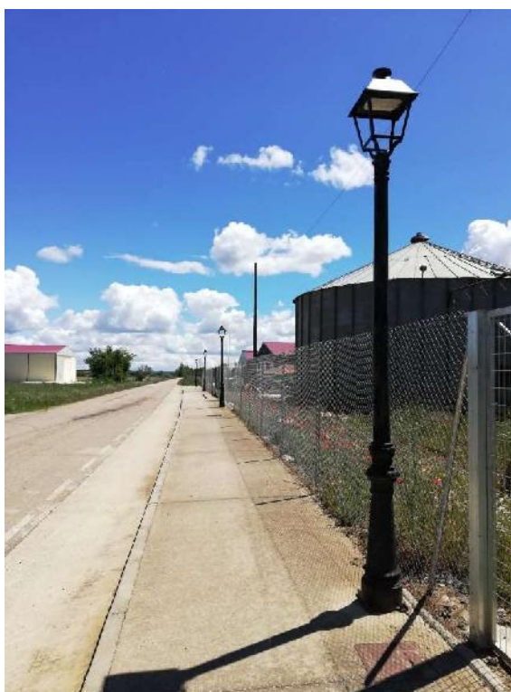
Luminarias villa sustituidas en zona carretera
