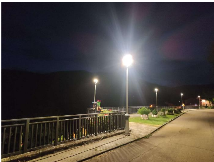
Luminarias tipo zona peatonal sustituidas
