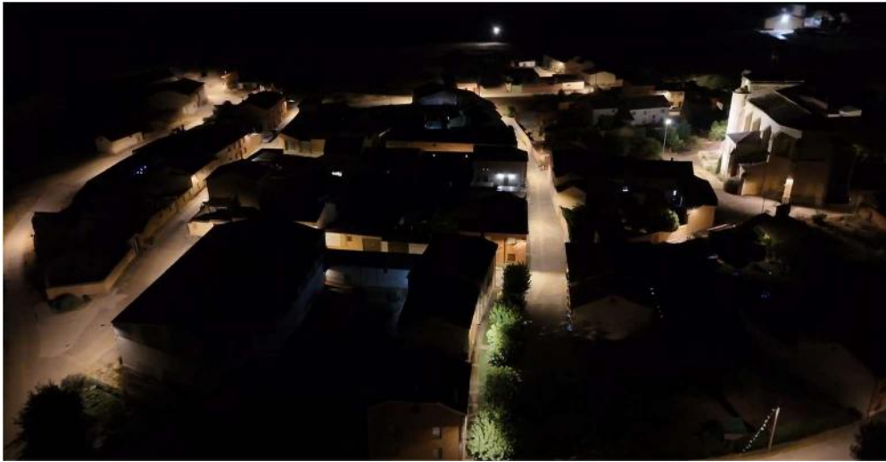
Vista nocturna de la instalación reformada
