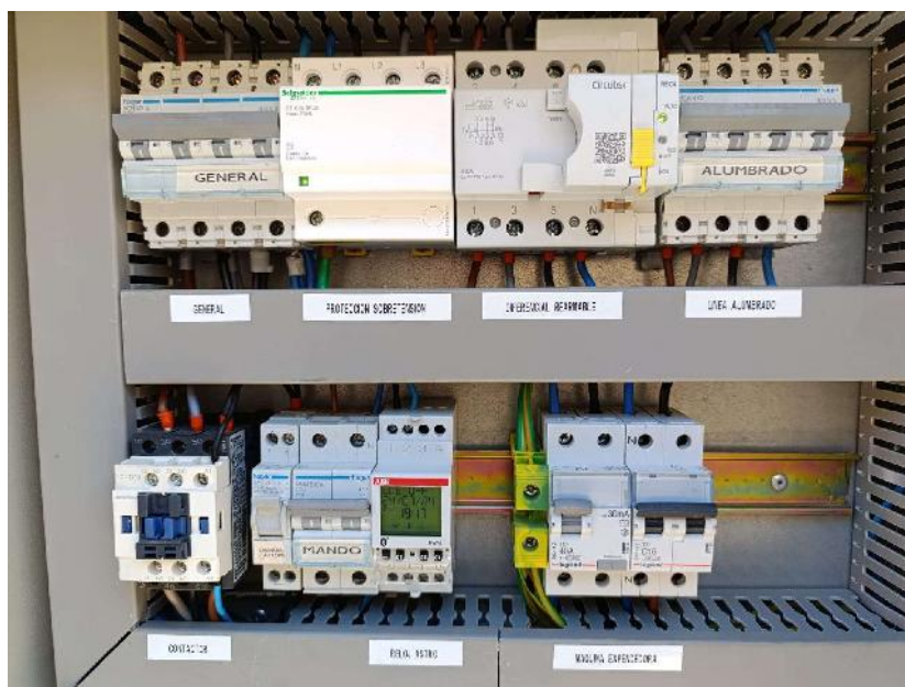
Reforma de cuadro de mando y protección
