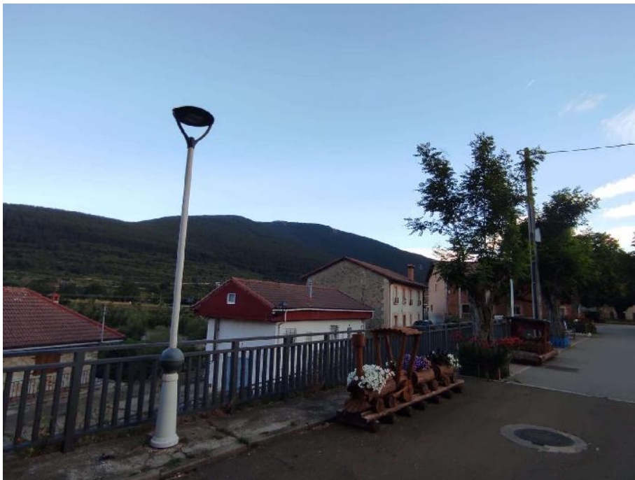
Luminarias tipo zona peatonal sustituidas
