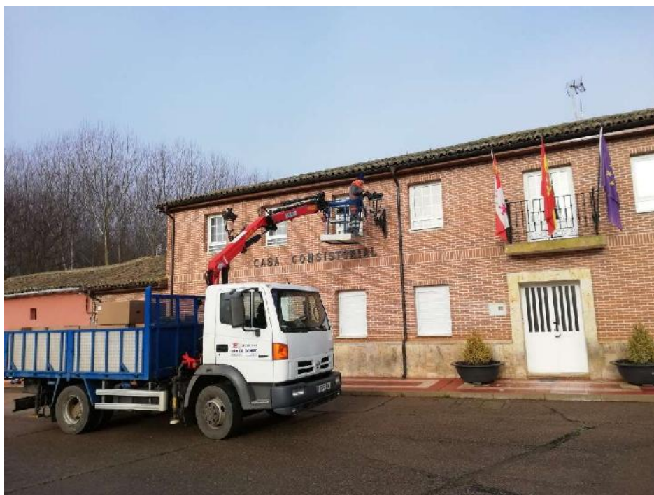
Instalación de bloques ópticos
