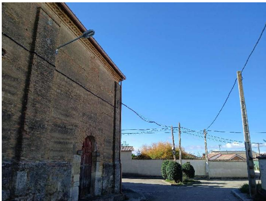
Nueva luminaria sobre fachada de iglesia
