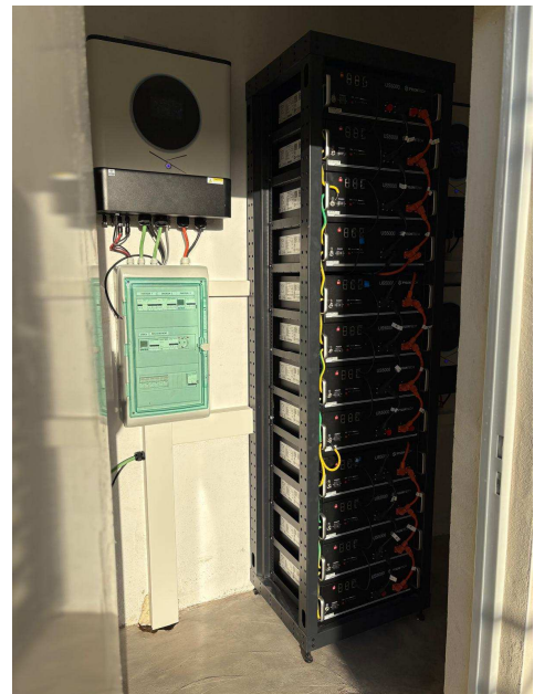
Baterías, cuadros eléctricos, inversores
