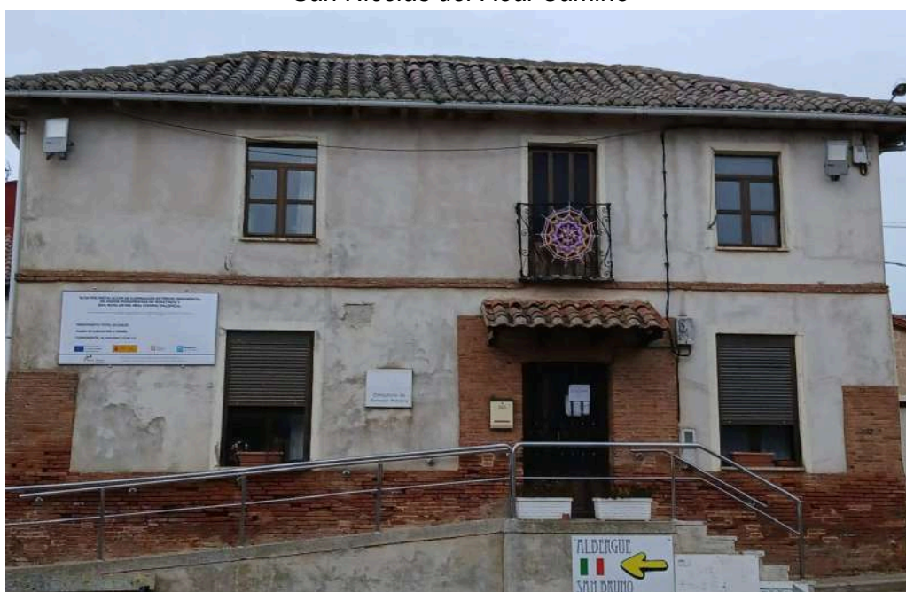
Moratinos - Proyectoros y cartel de obra
