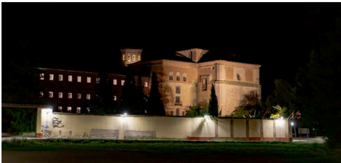
Carrión de los Condes – Zona habitaciones, fachada Este
