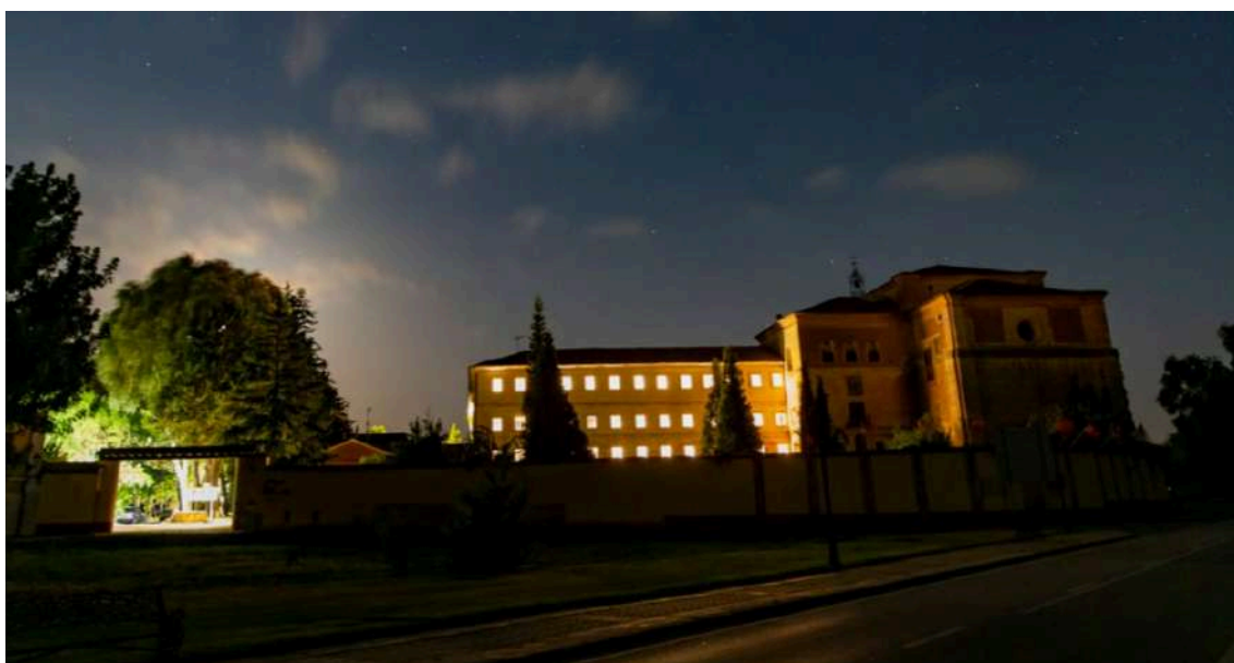
Carrión de los Condes – Zona habitaciones, fachada Este
