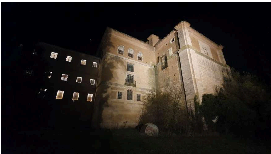
Carrión de los Condes – Zona habitaciones, fachada Este
