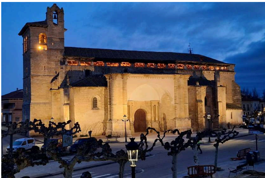
Frómista – Zona de bajo cubierta iluminada
