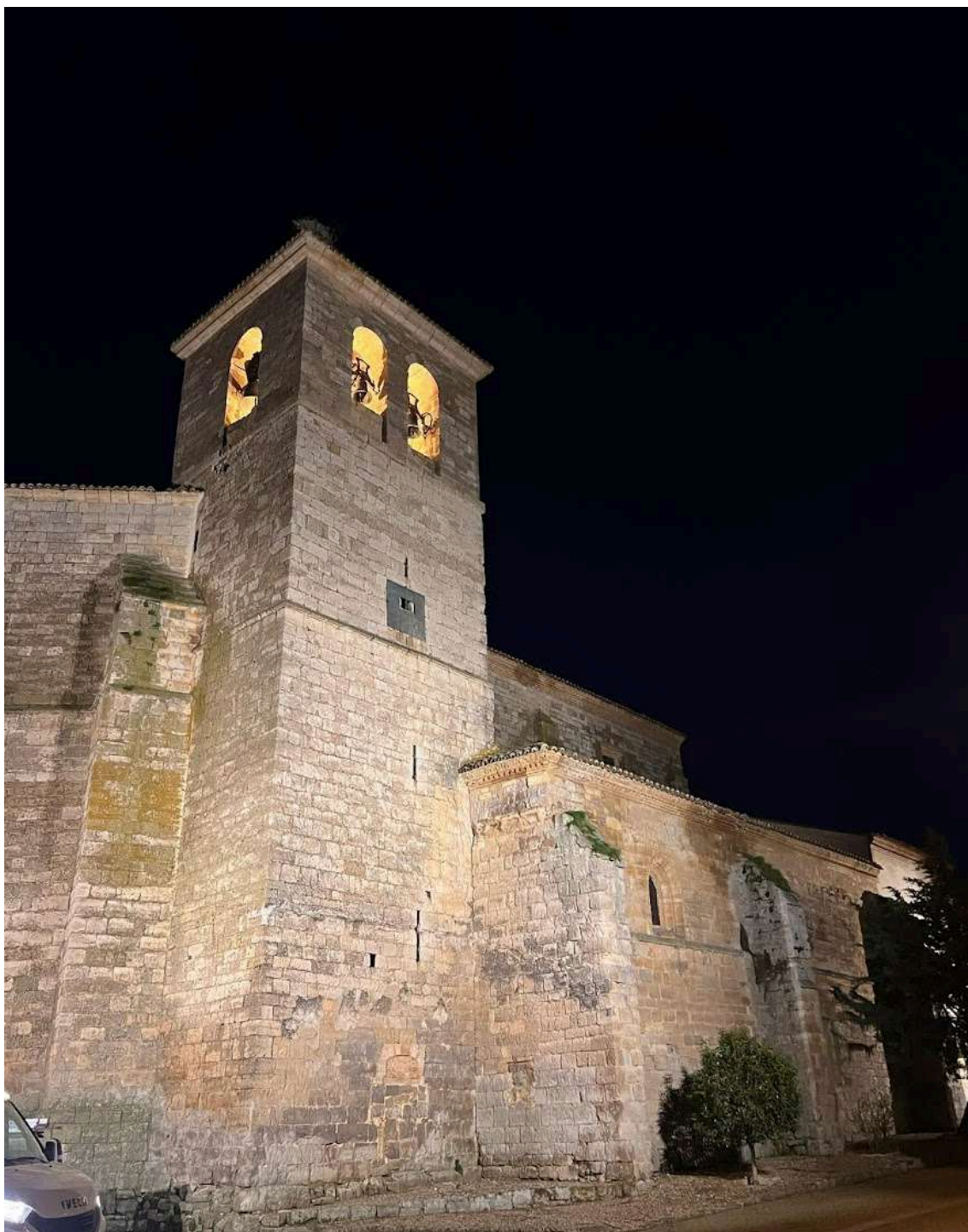
Boadilla de Camino – Proyector en fachada
