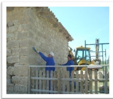
8.10 Acondicionamiento de la fachada exterior
