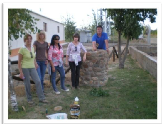
38.5 Rehabilitación del pozo
