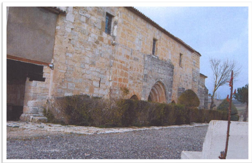
24.4 Vista de la fachada de la ermita
