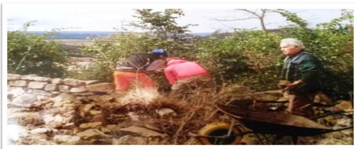
19.1.8 Voluntarios en pleno proceso de obras
