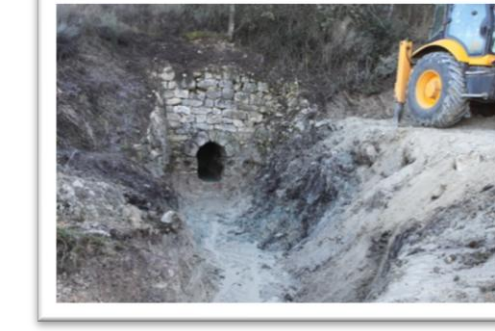
35.10 Estado final de la zona tras las obras
