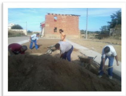
15.7 Extensión de tierra y limpieza
