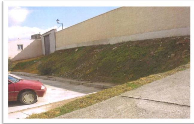
5.8 Situación inicial del talud
