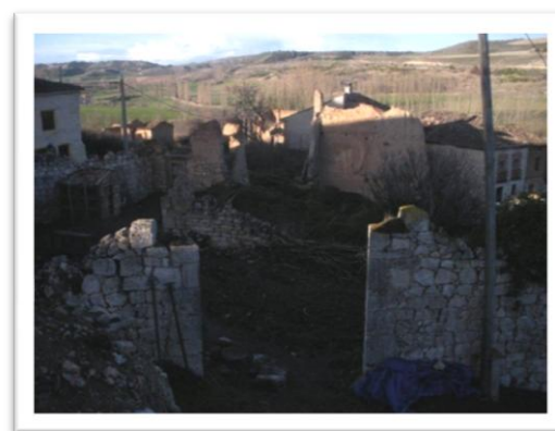
2.4 Estado del barrio
