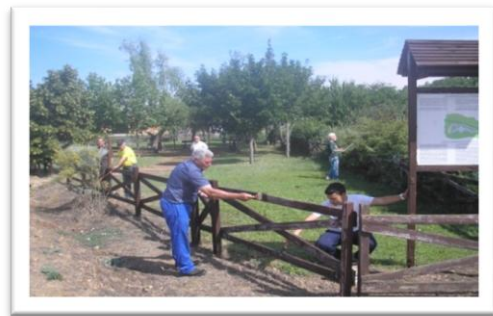
13.5 Acondicionamiento del vallado
