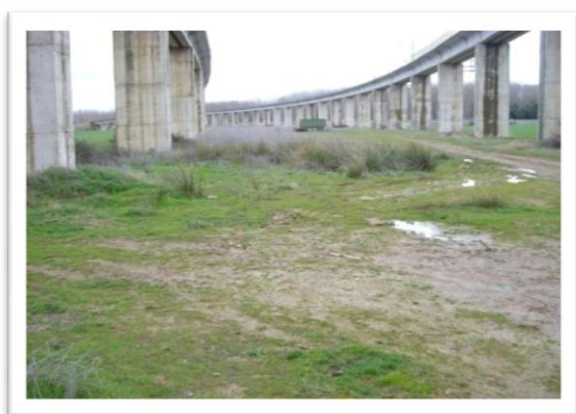
23.6 Estado inicial del suelo; Terrreno encharcado,
