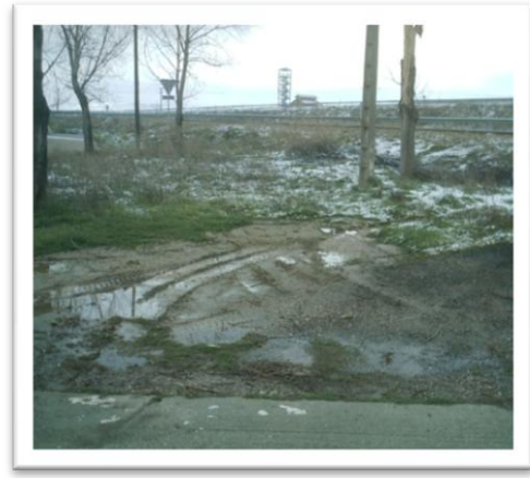
4.4 Estado inicial de la zona a rehabilitar
