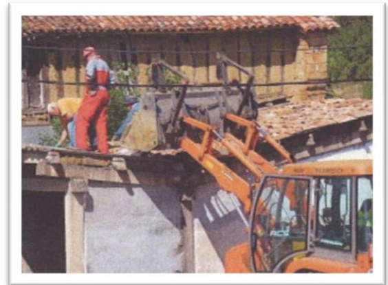
10.7 Trabajos de colocación de la teja
