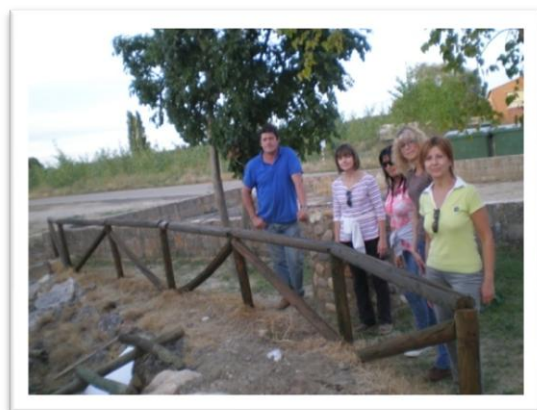
38.6 Reparación y embellecimiento del vallado
