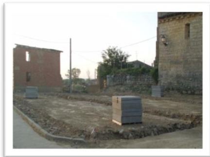
15.5 Desbroce del terreno y clareado
