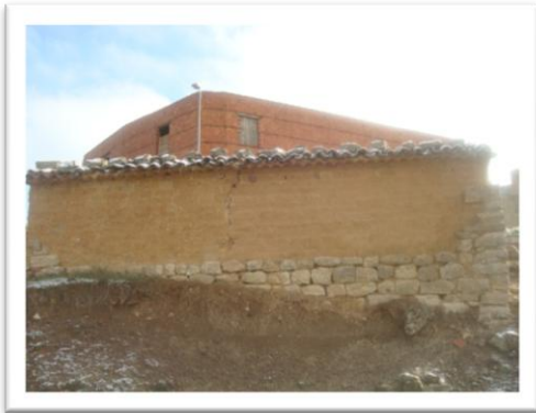
7.3 Estado inicial de la caseta
