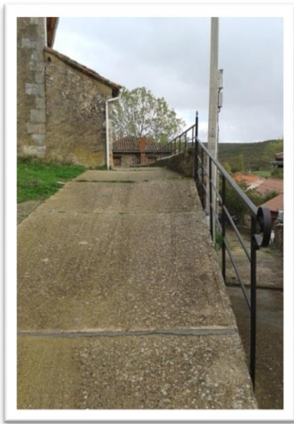
18.3 Firme acondicionado y barandilla embellecida
