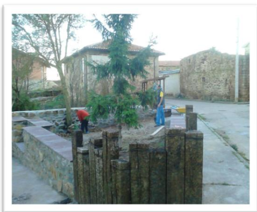
27.8 Rehabilitación de muro de piedra
