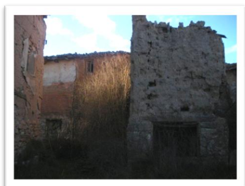
2.3. Estado del barrio
