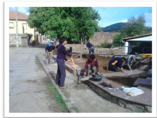
27.6 Pavimentado de la zona (creando un camino)
