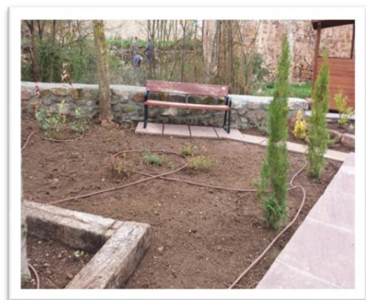
27.9 Instalación del sistema de riego y plantación
