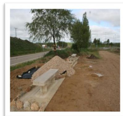
28.6 Instalación de bancos
