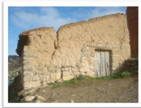
7.4 Vista lateral de la caseta
