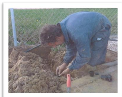
5.6. Colocación de sistema de riego
