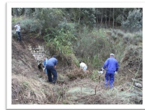
35.6 Limpieza de la zona (poda y desbroce)
