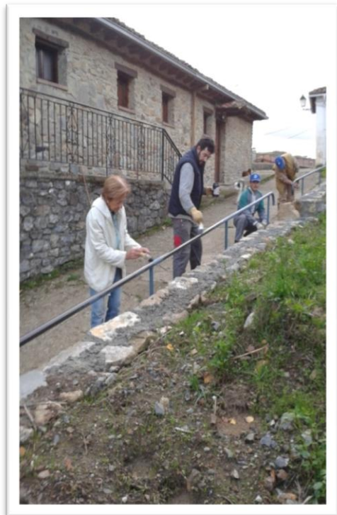
18.5 Voluntarios reparando y pintando la valla
