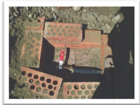
4.9. Instalación de un sistema de riego para su posterior mantenimiento.
