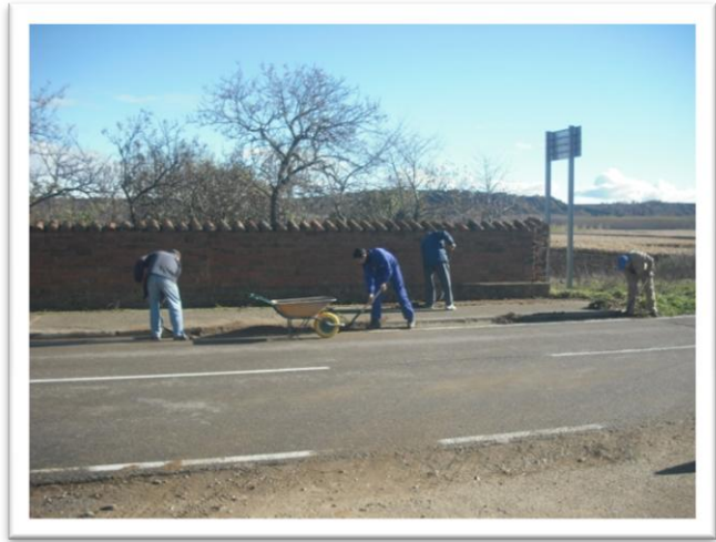
34.4 Saneamiento y compactación del terreno
