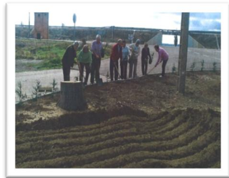
4.7. Finalmente acondicionamiento y plantación
