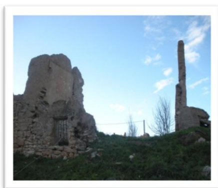
2.3 Estado del barrio
