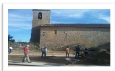
15.9 Compactación del terreno
