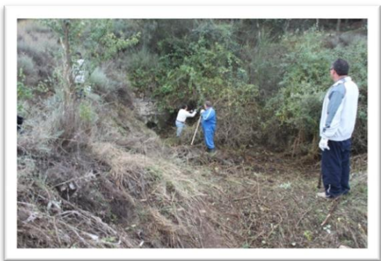
35.5 Limpieza de la zona (poda y desbroce)
