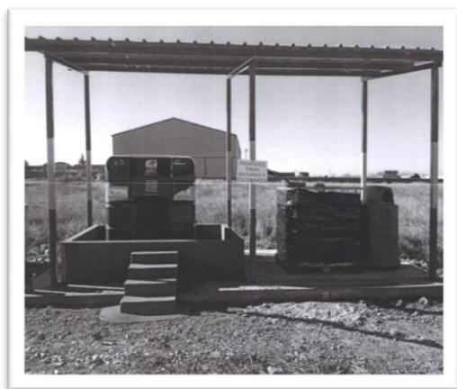
32.6 situación final de contenedores
