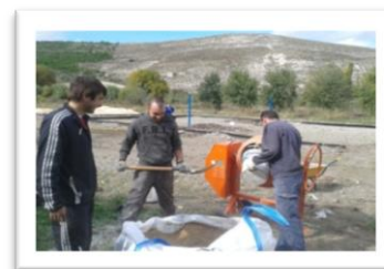
6.7 Colocación de postes
