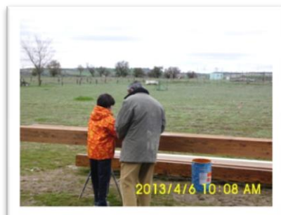
8.14 Barnizado de madera
