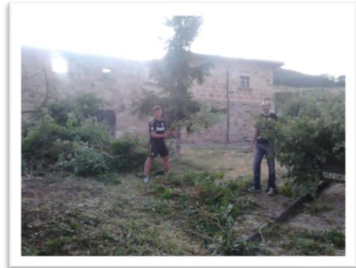
27.4 Desbroce y saneamiento del lugar
