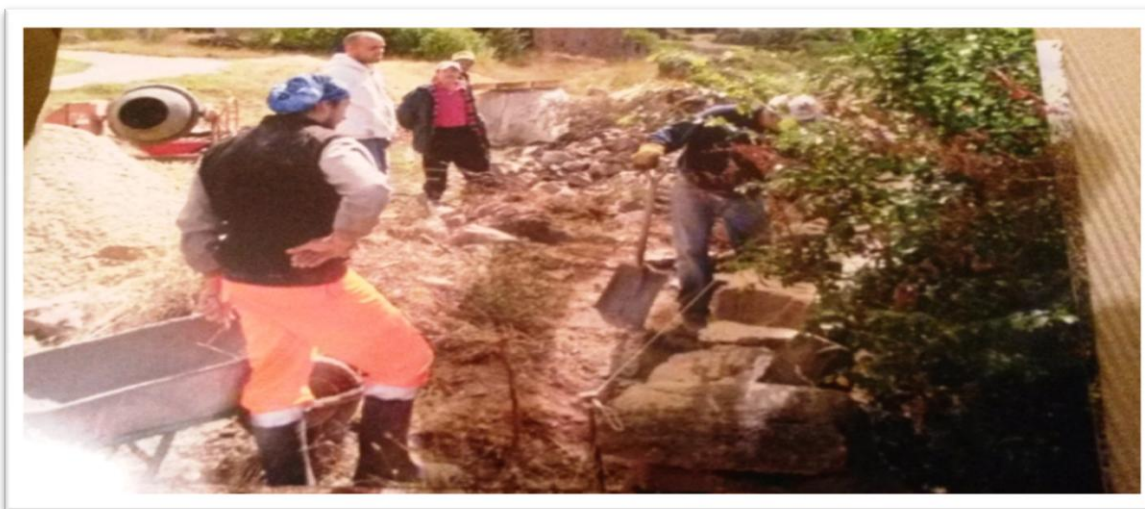
19.1.6 Voluntarios realizando labores de desbroce y retirada de maleza
