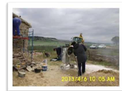
8.13 Reparación facha externa
