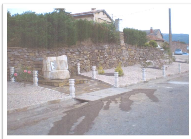
11.4 Estado final tras la actuación
