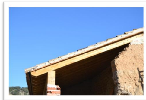
7.4 Reparación del tejado
