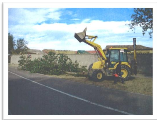
4.5. La retroexcavadora, retira la tierra en mal estado.
