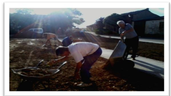
15.8 Desbroce y saneamiento del terreno
