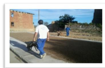
15.10 Allanamiento del terreno
