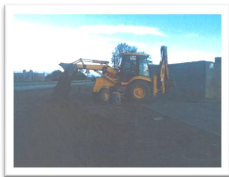
4.6. Compactación del terreno
