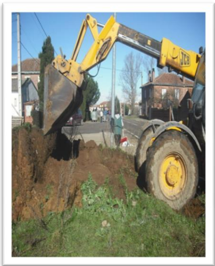
34.5 Uso de excavadora
