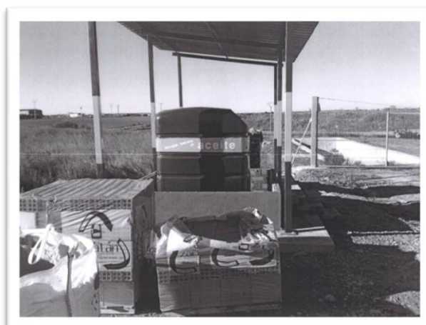
32.8 Proceso de las obras
