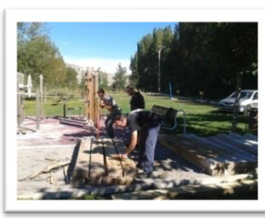
6.9 Colocación del entablillado
