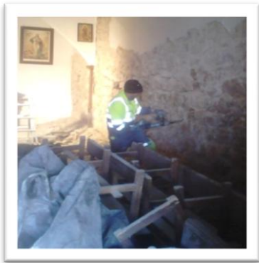
8.8 Reparación de la fachada interior
