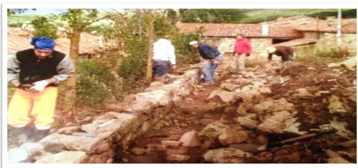
19.1.7 Voluntarios realizando tareas de saneamiento y acumulo del terreno
