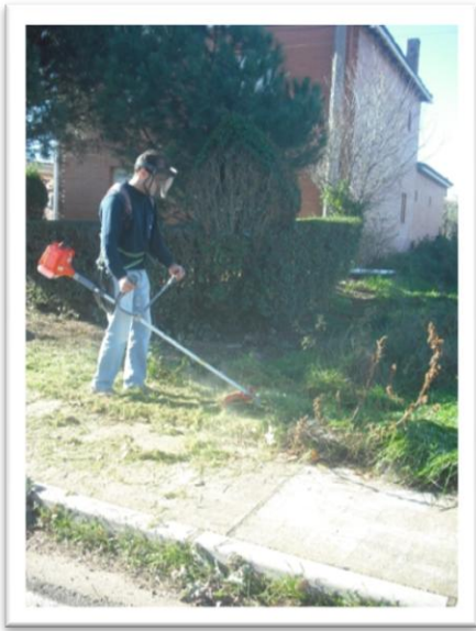
34.3 Desbroce del terreno y saneamiento
