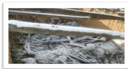
7.5 Estado del tejado
