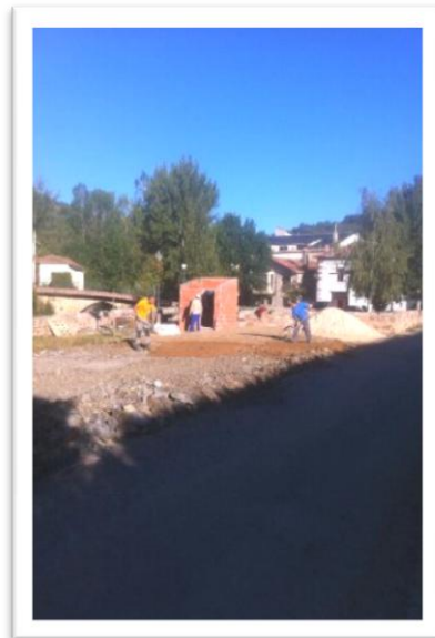
3.4. Proceso de construcción de la caseta apreciamos el realizado por voluntarios.
