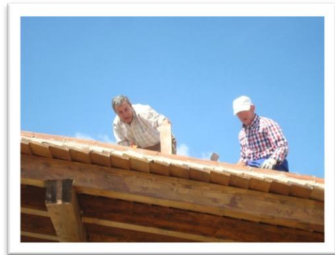
8.9 Reparación del tejado
