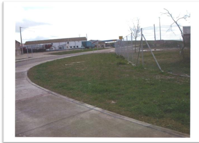
5.3. Estado inicial de la zona de actuación
