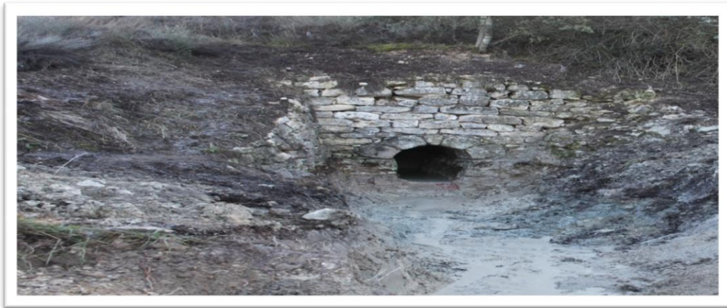
35.13 Estado final tras las actuaciones
