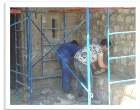
8.11 Reparación de la fachada exterior
