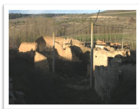
2.4. Estado del barrio
