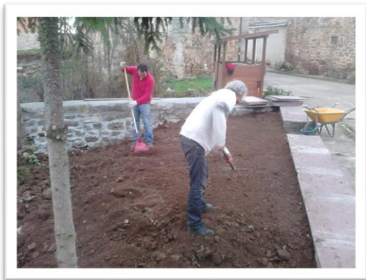
27.5 Extensión de tierra y compactación del terreno
