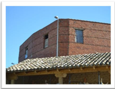
7.3 Estado final de la caseta
