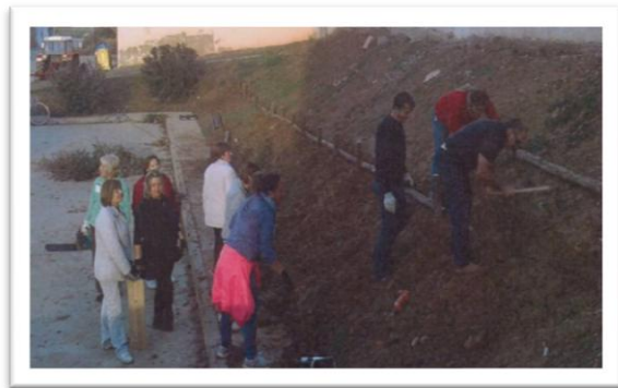
5.9. Colocación de la empalizada, para corregir la pendiente
