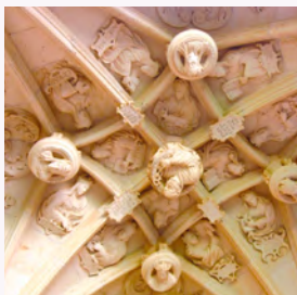
Bóveda del claustro.
