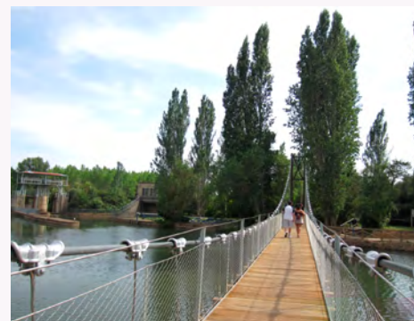
Pasarela. Herrera de Pisuegra
