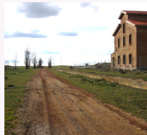
Vista de la vía desde la estación de Mazariegos
