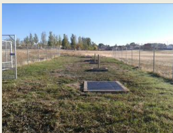
Fosa séptica. Torreiglesias (Segovia)
