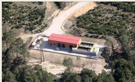
Vista aérea de la depuradora de Duruelo de la Sierra (Soria)
