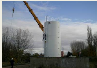
Colocación de lecho bacteriano. Tariego de Cerrato (Palencia)
