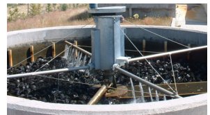
Lecho bacteriano en Hoyos del Espino (Ávila) e imagen del interior de un lecho bacteriano
