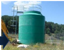
Lecho bacteriano en Hoyos del Espino (Ávila) e imagen del interior de un lecho bacteriano
