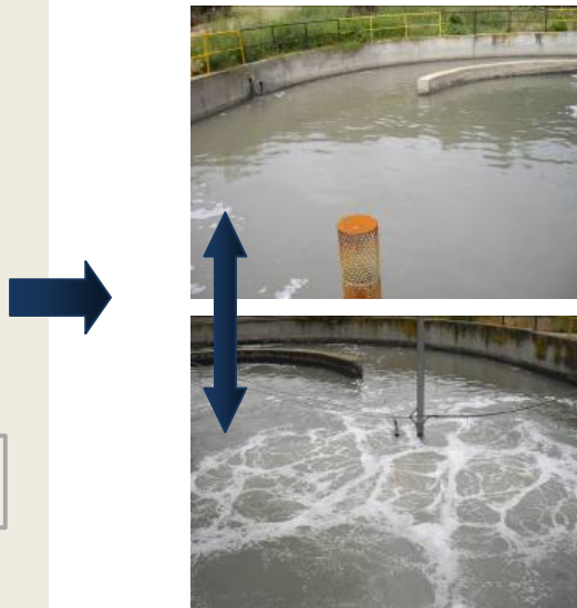
Zonas sin y con funcionamiento de soplantes en el reactor
