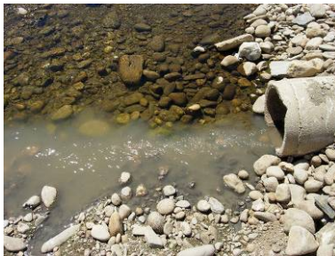
Vertido doméstico directo sin depuración
