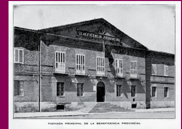
1928 ca. Edificio de los Establecimientos Provinciales de Beneficencia en la Plaza de la Maternidad (Actual Plaza de Abilio Calderón)
