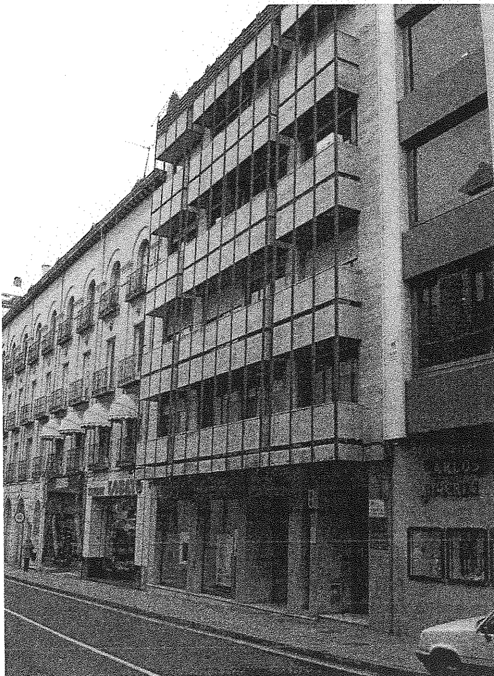
ANTIGUAS OFICINAS RECAUDACION PALENCIA
