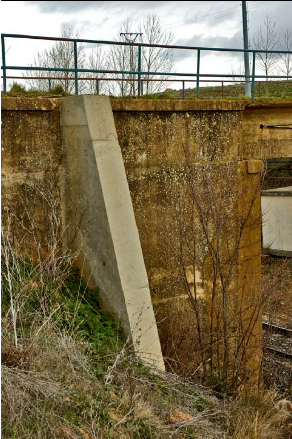
- FOTO 3 Detalle de un contrafuerte, ejecutado recientemente.
