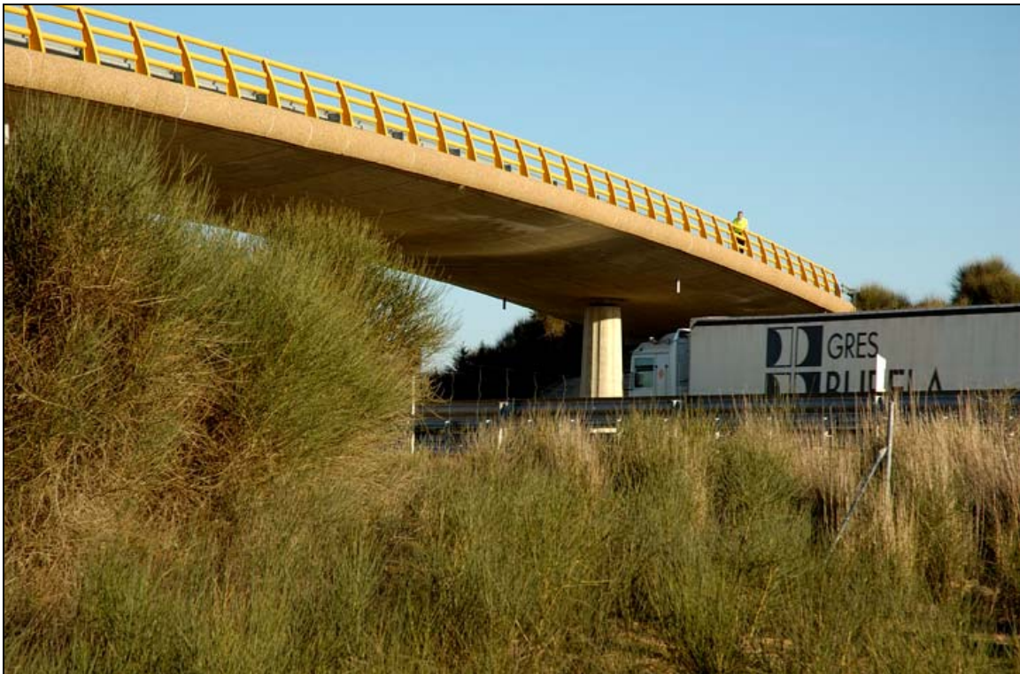
- FOTO 2 La losa y la barandilla metálica.
