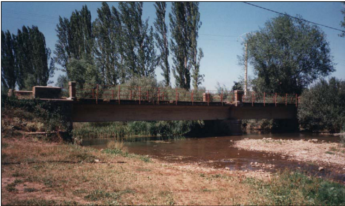
- FOTO 2 Vista desde aguas abajo.
