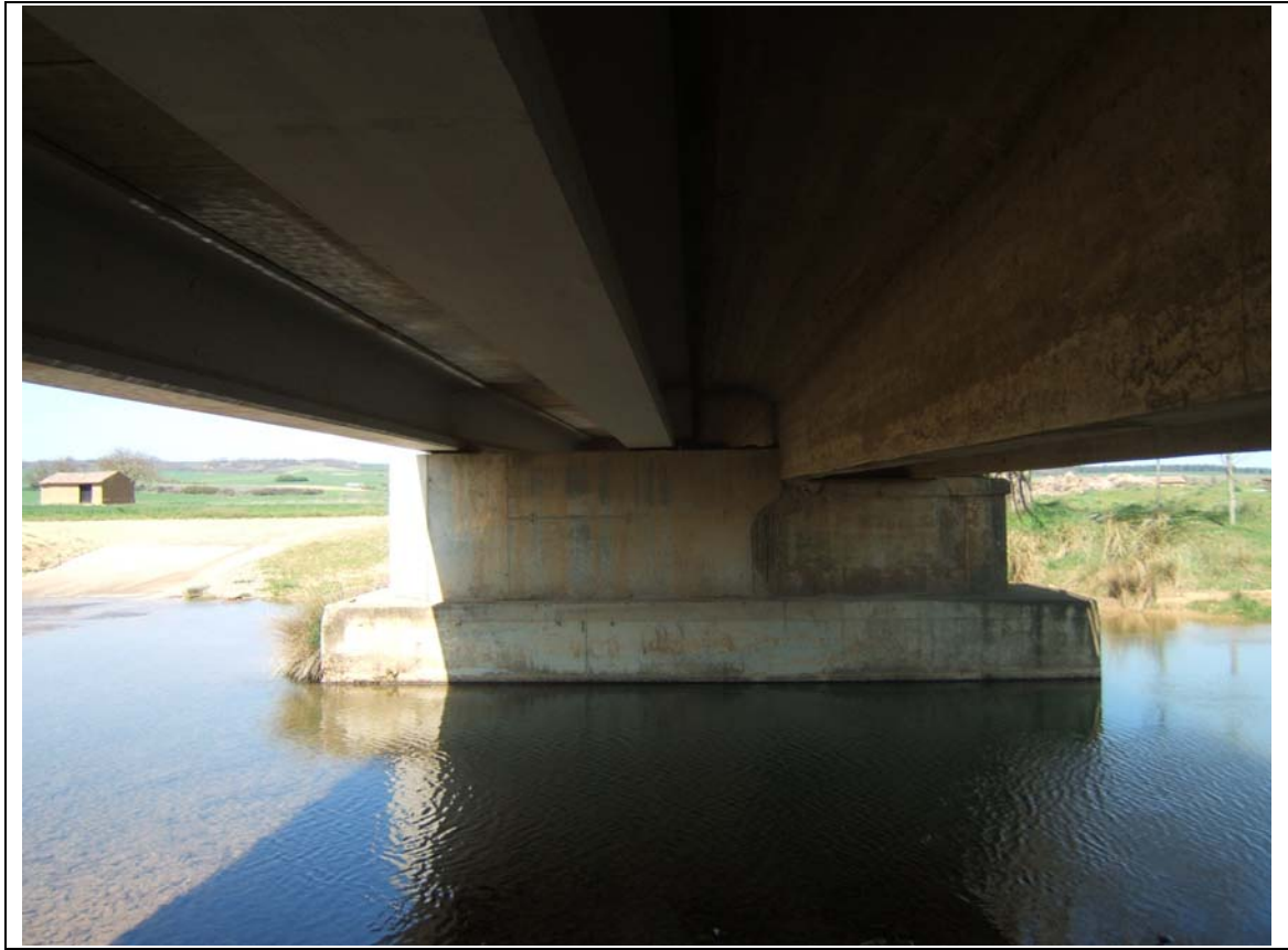
- FOTO 3 Detalle desde abajo del tablero.
