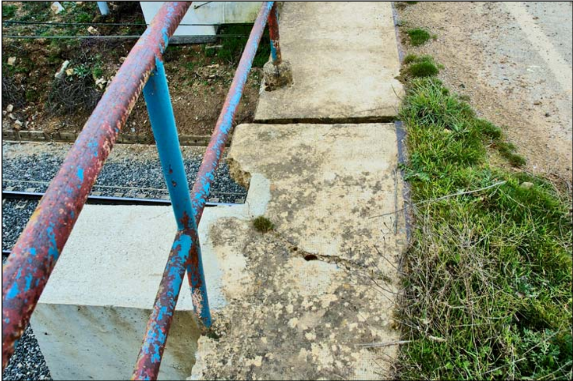
- FOTO 4 Detalle de la barandilla metálica.
