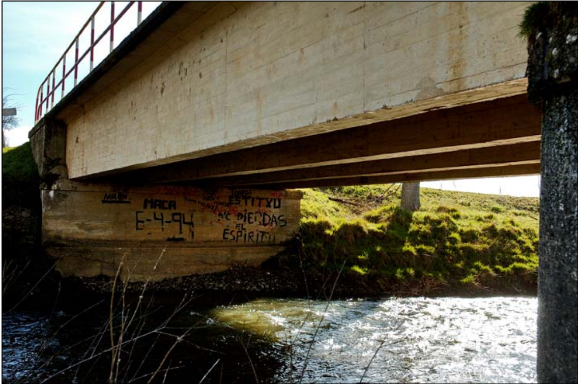
- FOTO 6 Las vigas del tablero vistas desde abajo.
