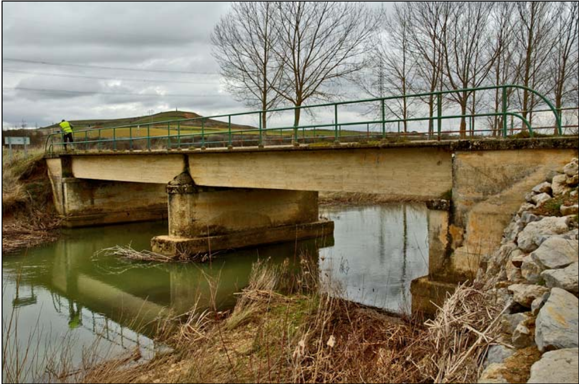
- FOTO 2 Vista general del Puente y el río.
