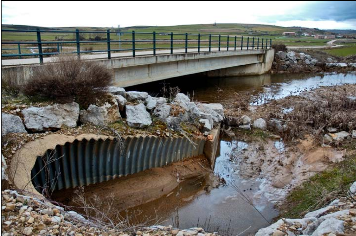
- FOTO 1 Vista del Puente desde aguas arriba.
