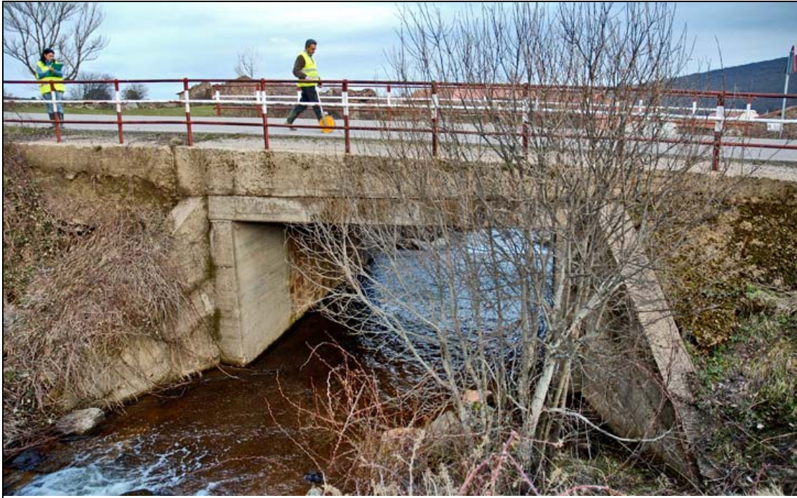
- FOTO 2 El Puente con su barandilla y el río.
