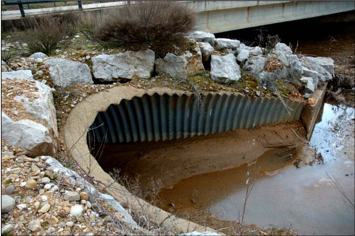
- FOTO 3 Detalle tubo arco de aguas arriba.
