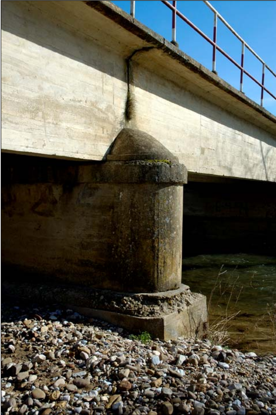
- FOTO 5 Detalle del apoyo de las vigas.
