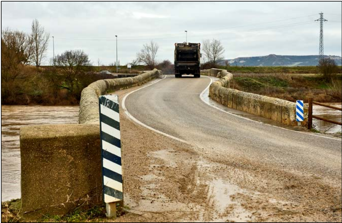
- FOTO 6 La calzada del Puente.
