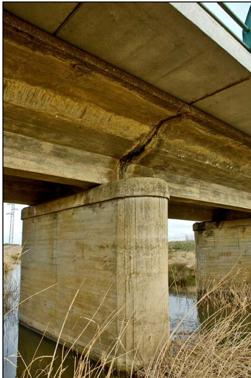
- FOTO 4 Detalle de una de las pilas.
