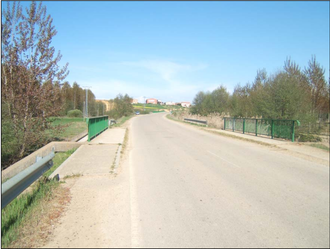
- FOTO 3 La planta del Puente.
