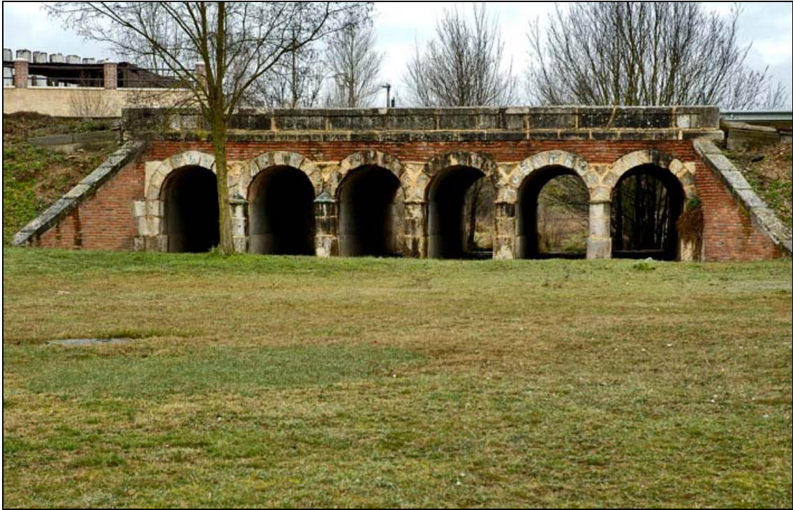
- FOTO 1 Vista general desde aguas arriba.
