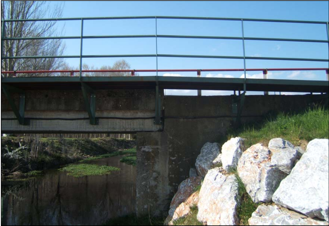
- FOTO 6 Vista frontal del Puente pequeño.
