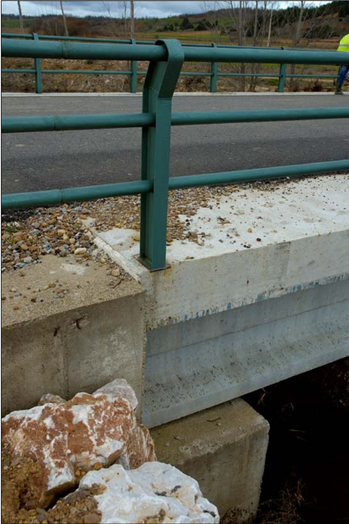
- FOTO 5 Detalle del apoyo de las vigas.
