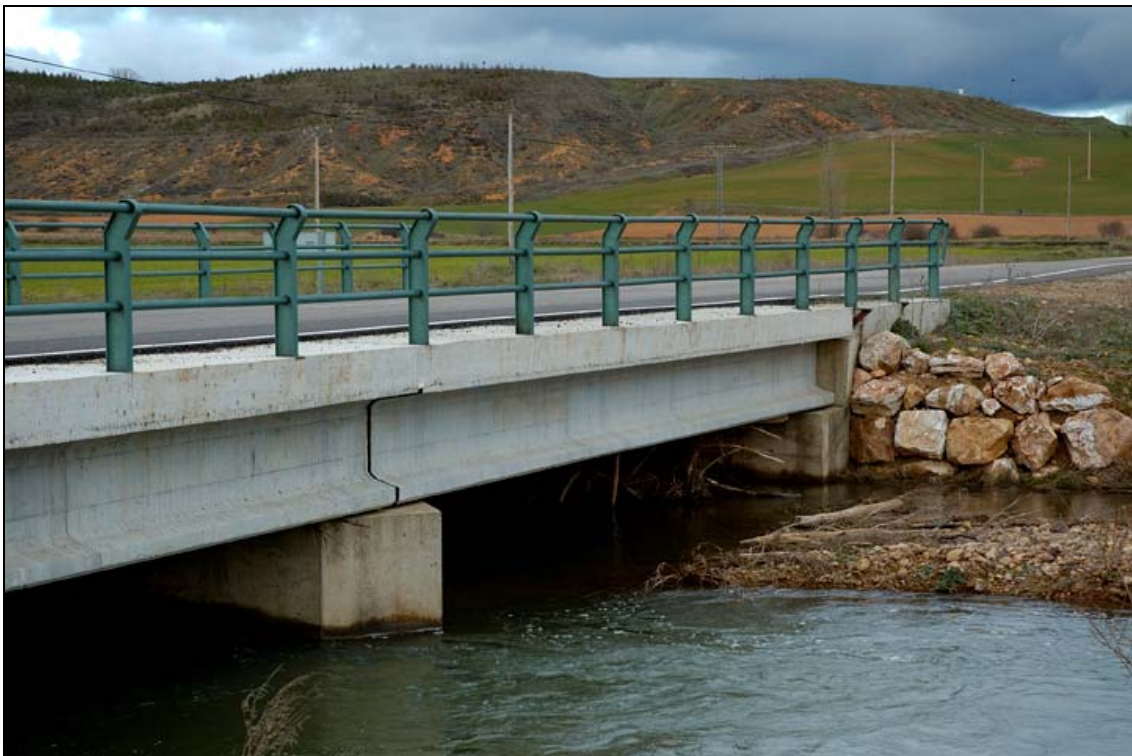
- FOTO 2 Detalle de las vigas y la barandilla.
