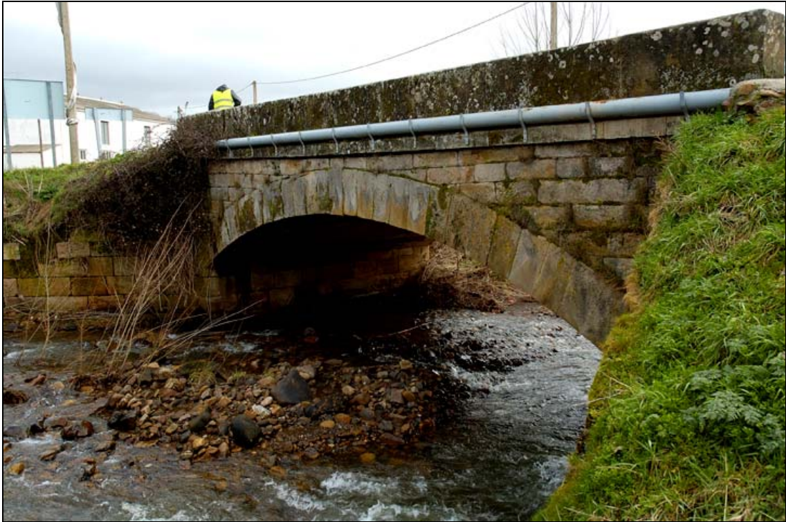
- FOTO 3 Tubería adosada en uno de los paramentos.
