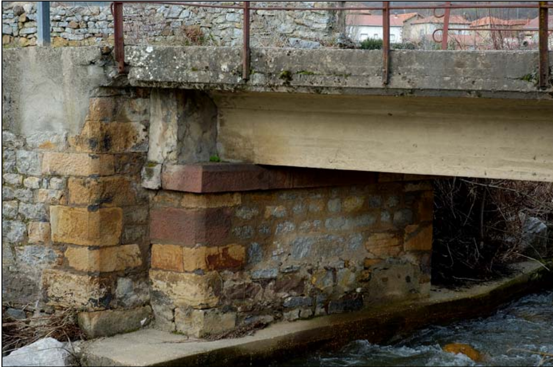
- FOTO 3 Detalle de la viga apoyada en el estribo.
