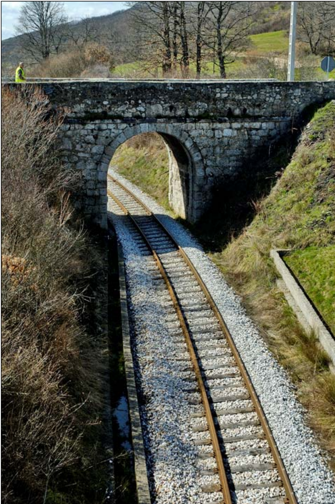
- FOTO 1 Vista general del Puente y la vía.
