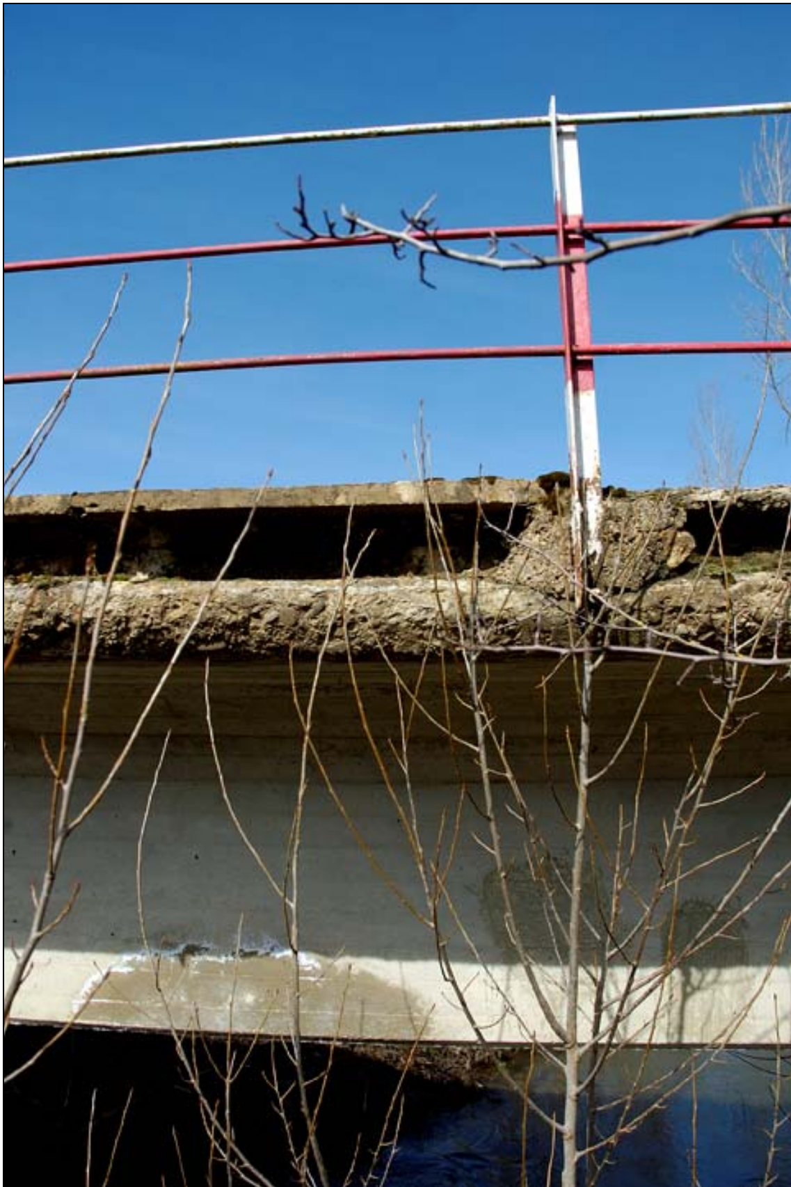
- FOTO 2 Detalle de la barandilla.
