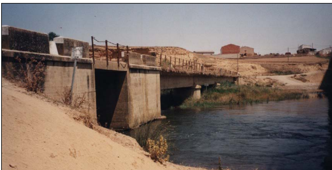
- FOTO 2 El Puente viejo (desaparecido) visto desde aguas abajo.
