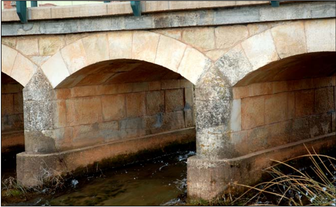
- FOTO 3 Detalle arcos y pila.
