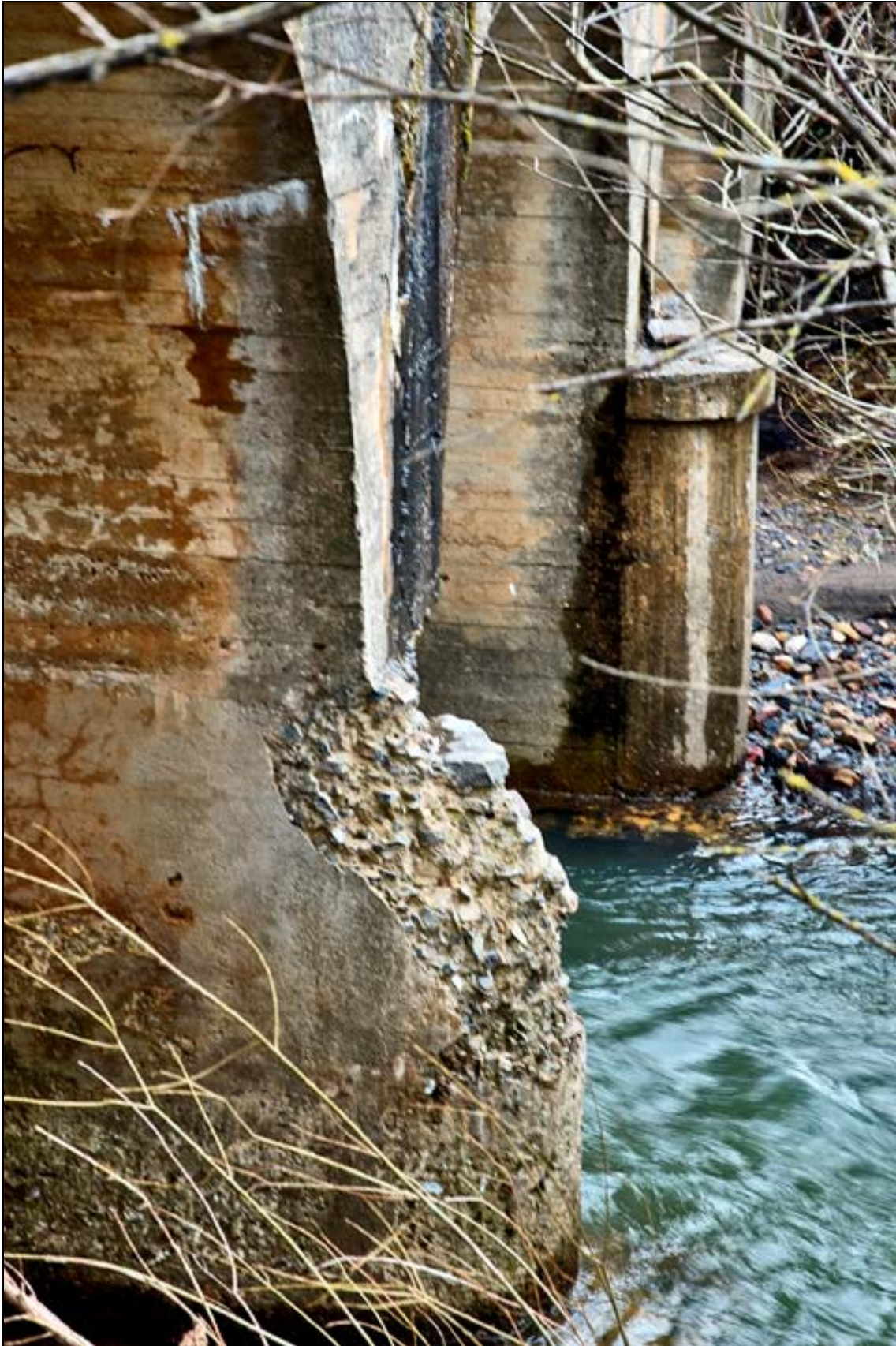
- FOTO 4 Detalle de uno de los tajamares.
