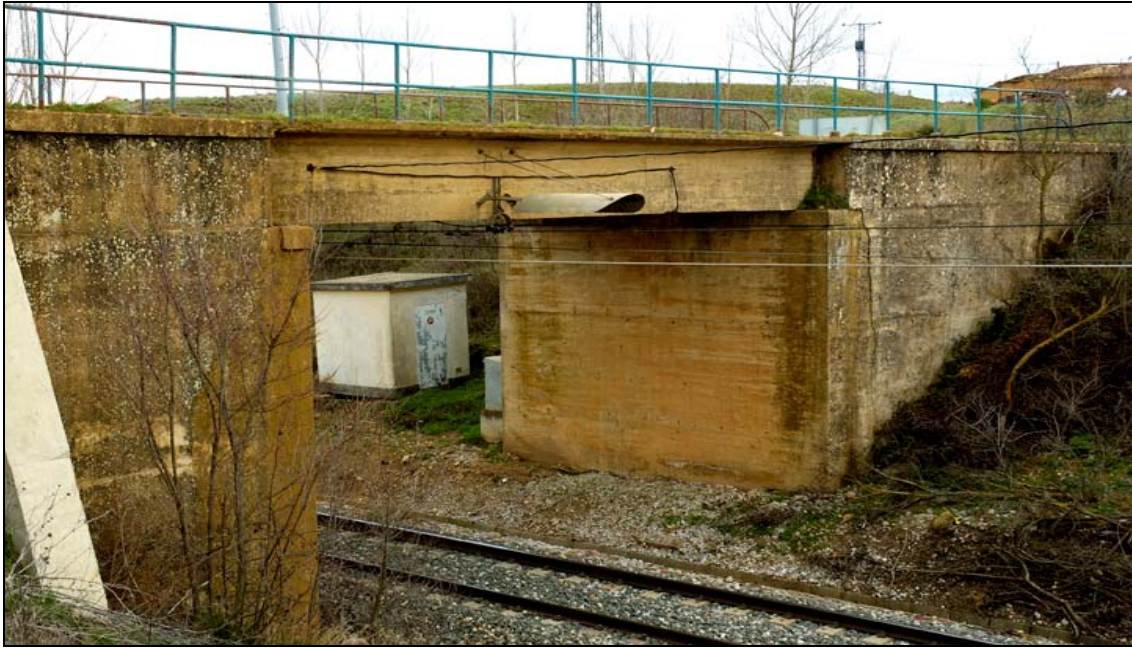
- FOTO 1 Vista del Puente y la vía de hierro.
