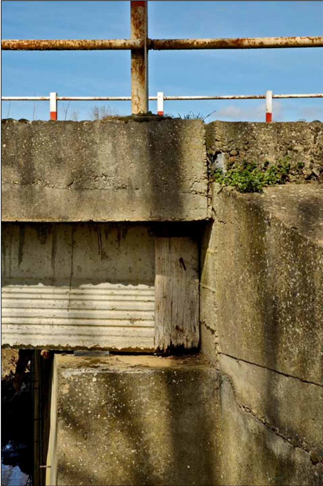
- FOTO 5 Detalle de estribo-losa.
