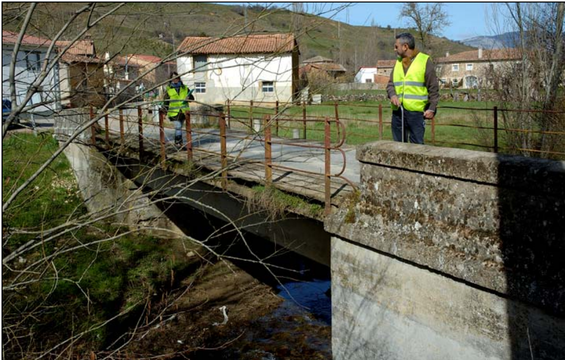
- FOTO 2 Detalle de la barandilla y el pretil.
