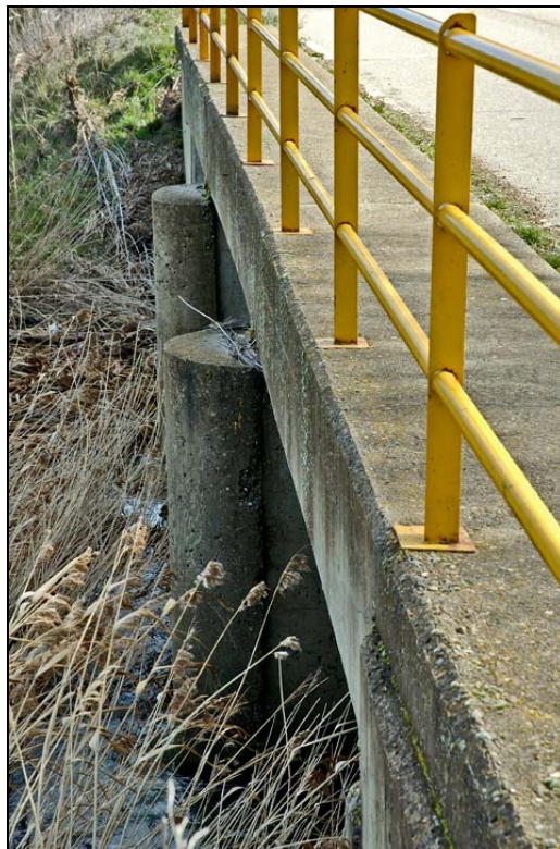
- FOTO 4 Vista de la barandilla.
