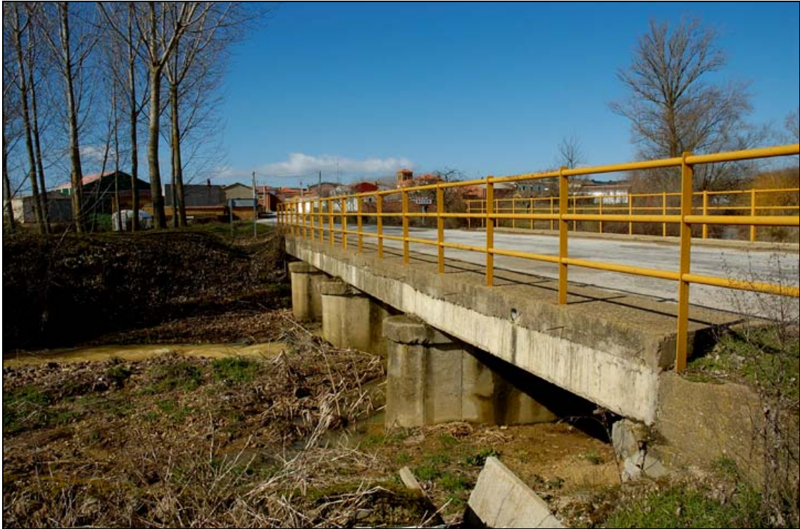
- FOTO 1 Vista general del Puente.
