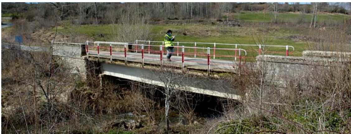
- FOTO 1 Vista general del Puente y su entorno.
