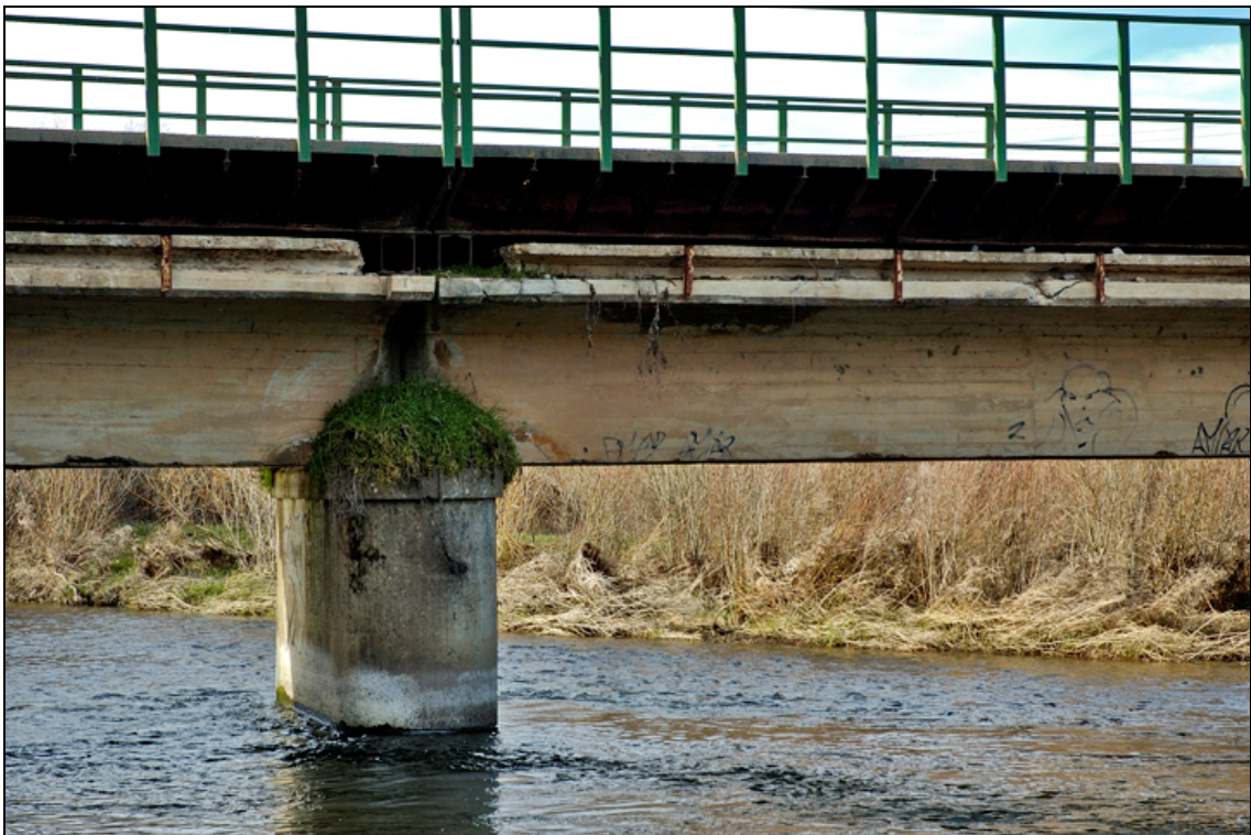
- FOTO 6 Detalle de pila-vigas-barandilla.
