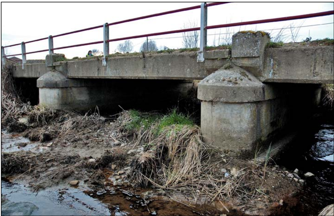
- FOTO 2 La barandilla del Puente.
