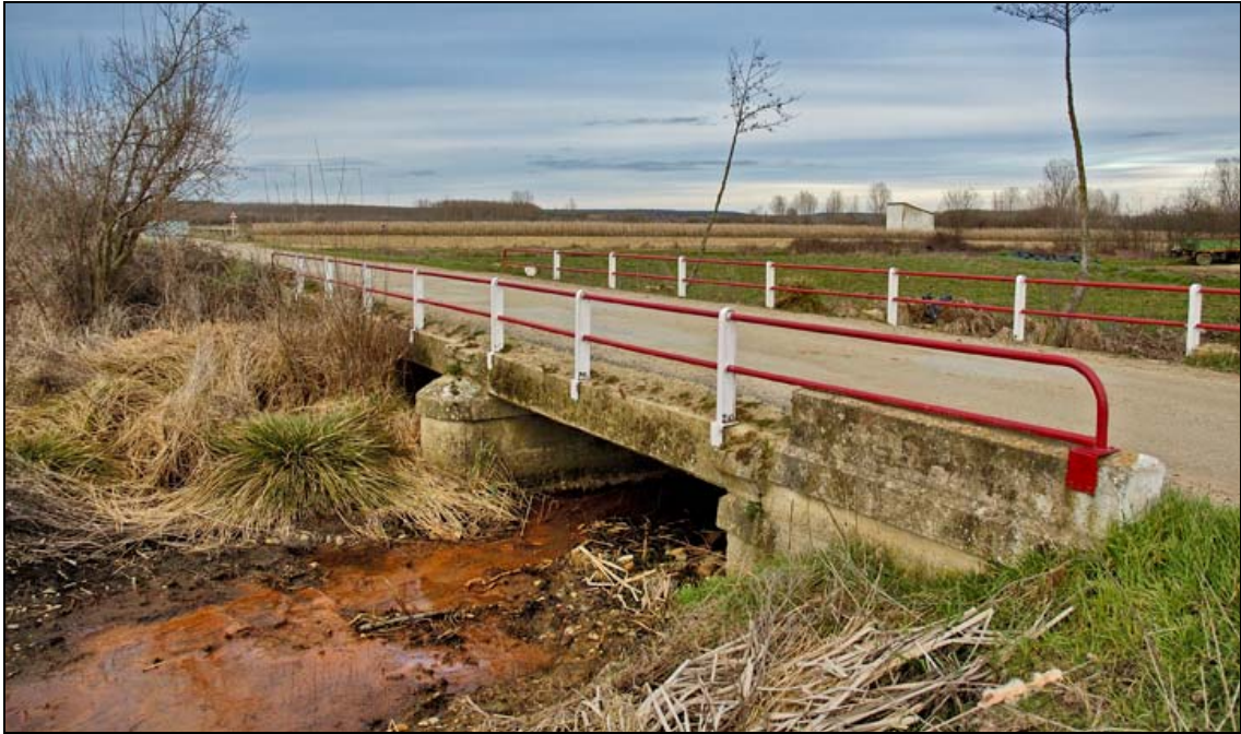
- FOTO 1 Vista general del Puente y su entorno.
