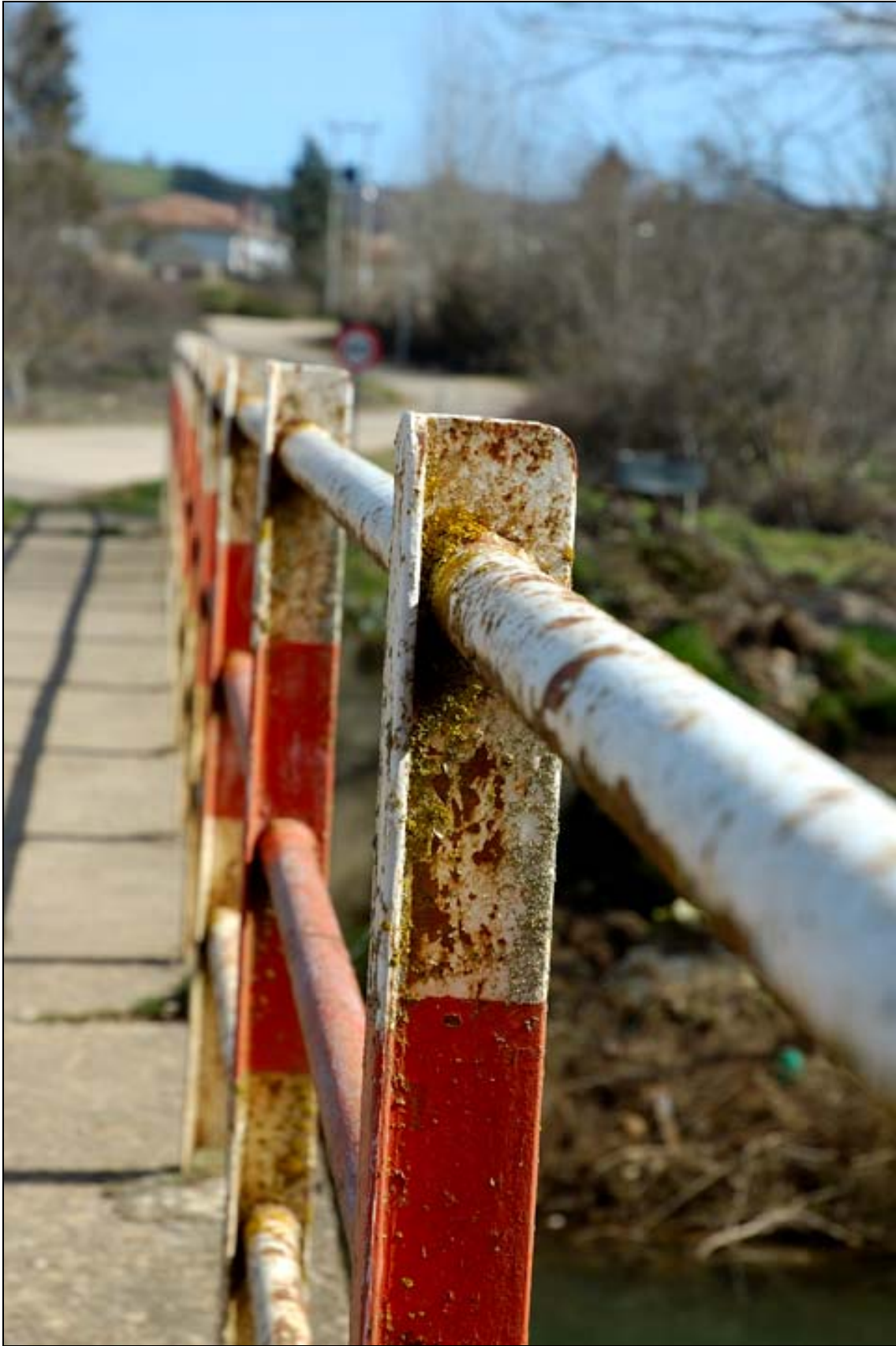
- FOTO 6 Detalle de la barandilla.
