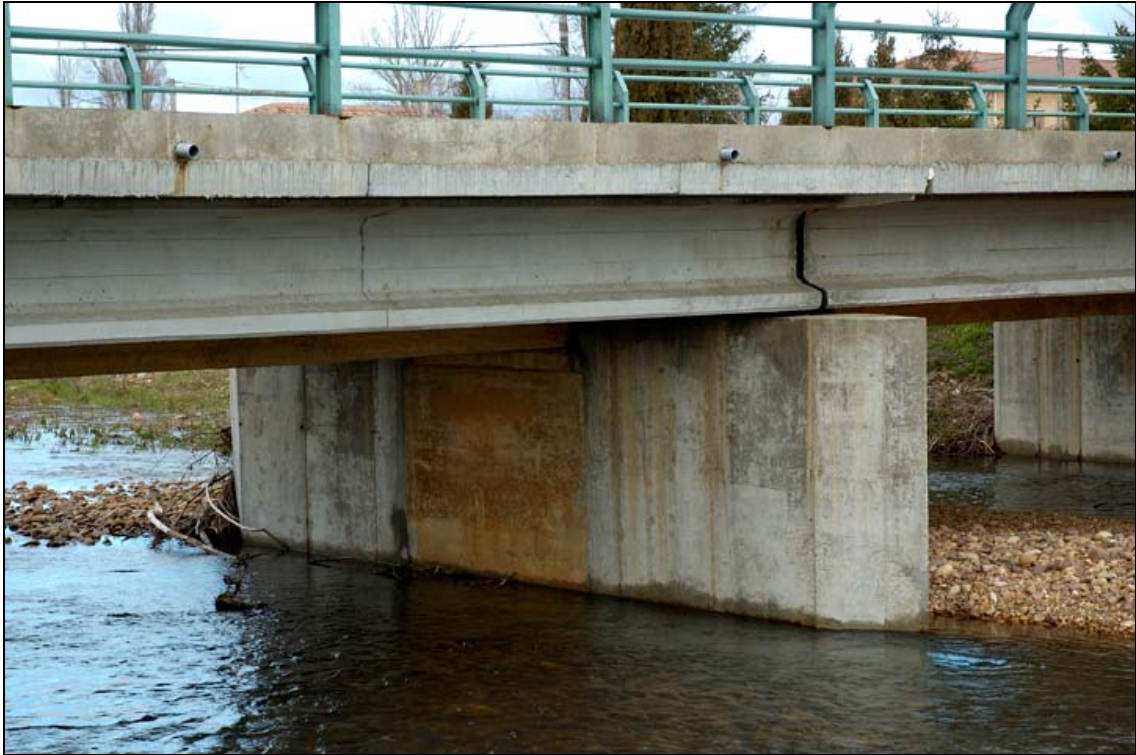
- FOTO 3 Pila, vigas y barandilla.
