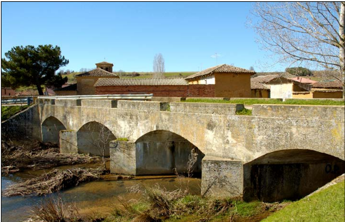
- FOTO 2 El perfil del Puente.
