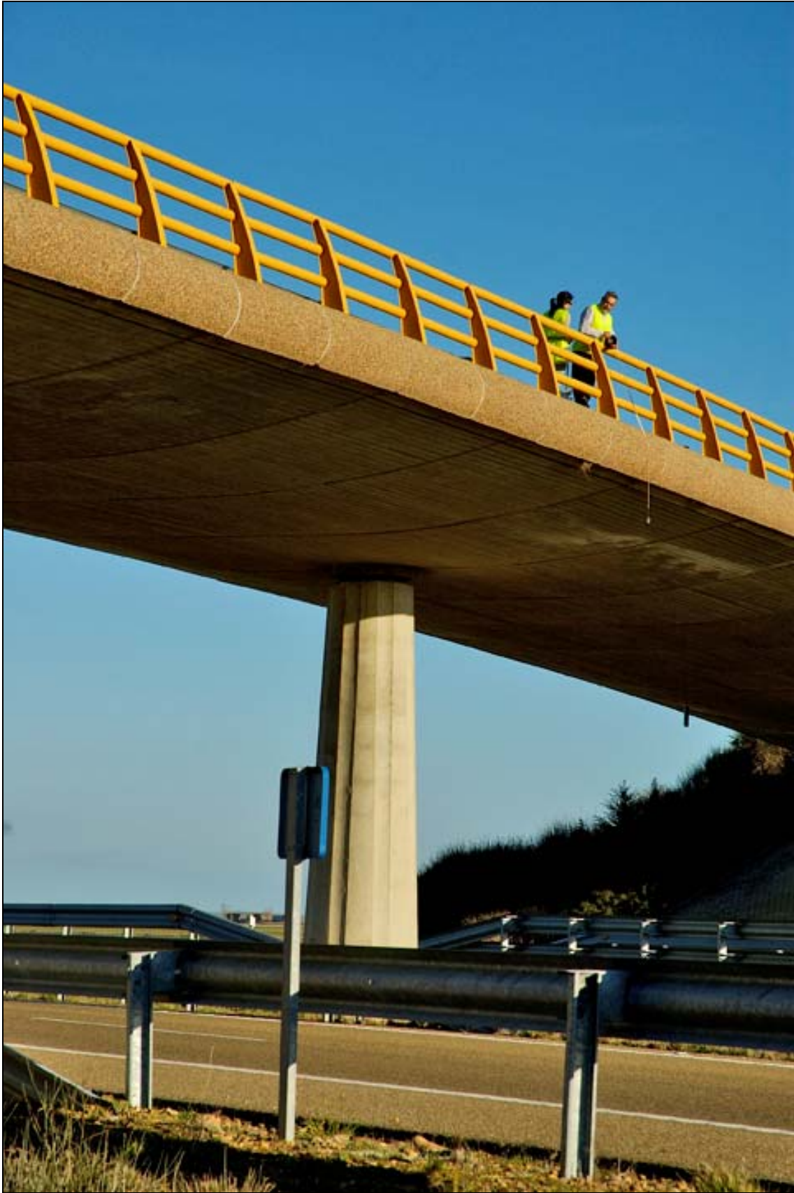
- FOTO 5 Detalle de una de las pilas y la losa.
