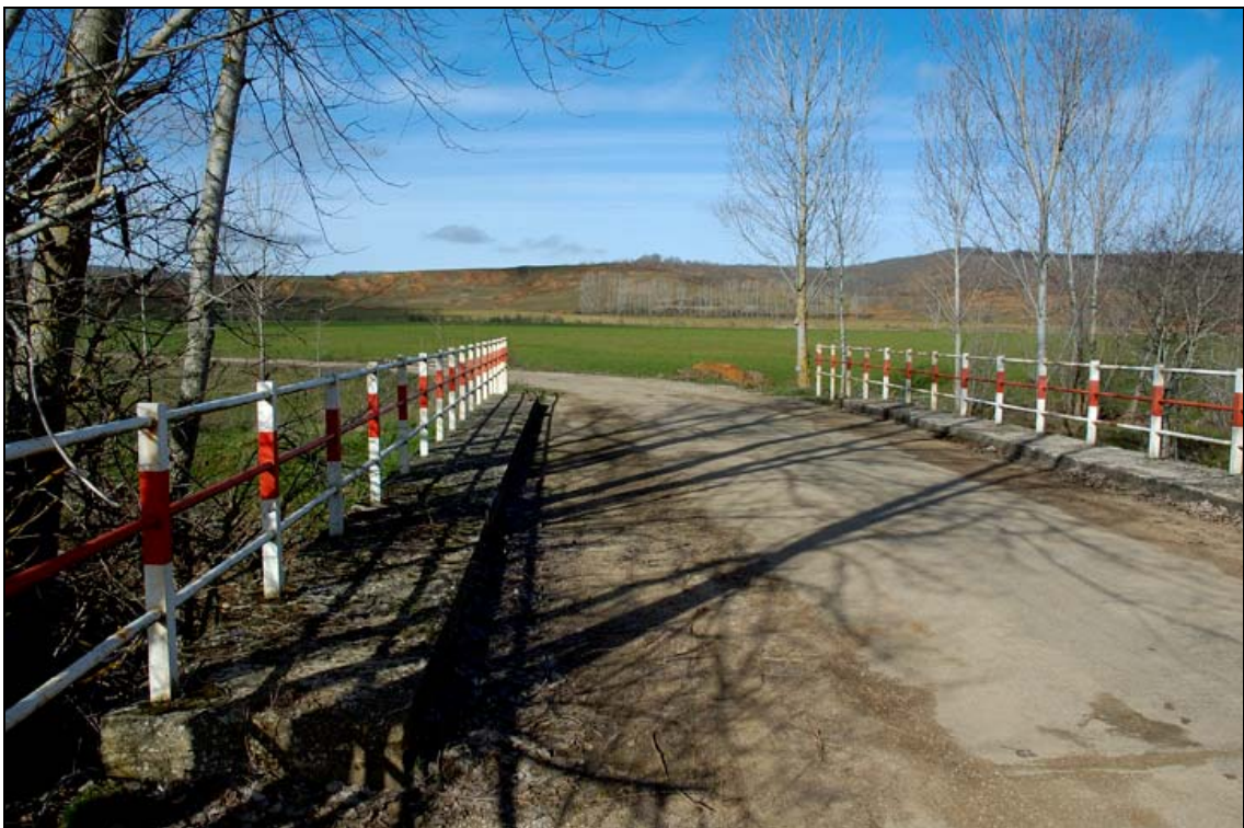
- FOTO 6 La calzada del Puente.
