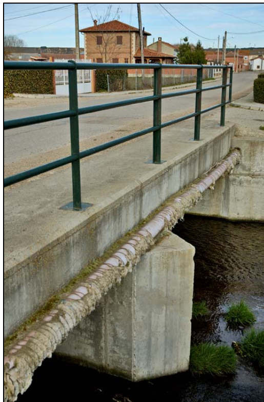
- FOTO 4 Detalle de la barandilla.
