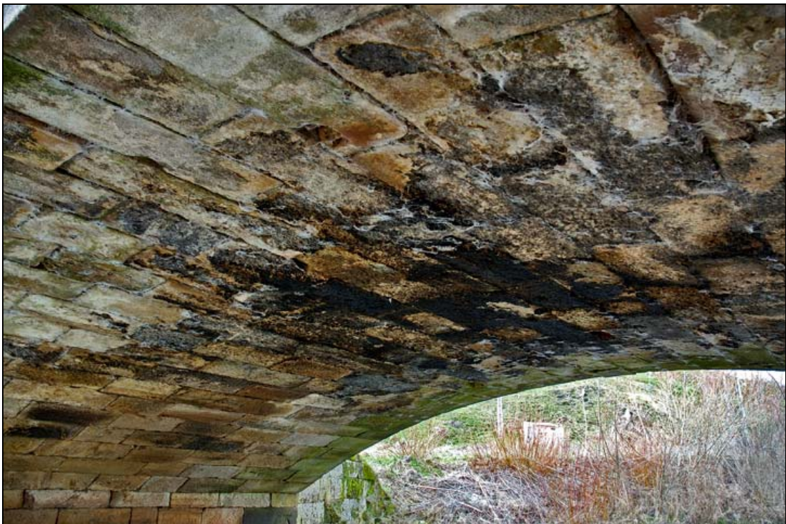
- FOTO 6 Interior de la bóveda del arco.
