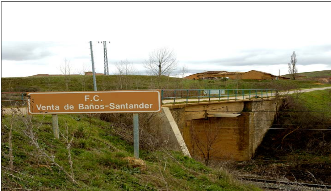
- FOTO 2 Vista general del Puente y la señalización.
