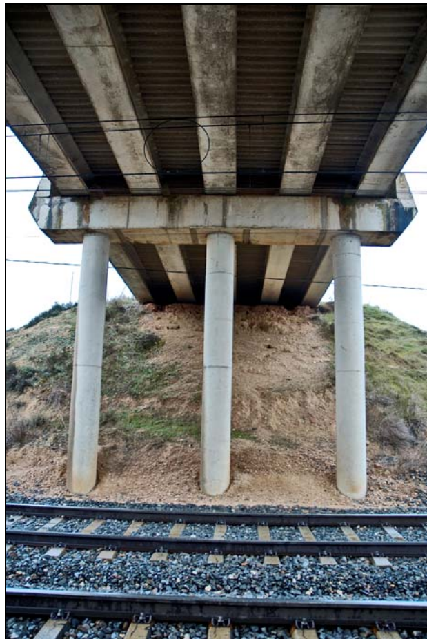
- FOTO 2 Vista de las pilas, el dintel y las vigas.
