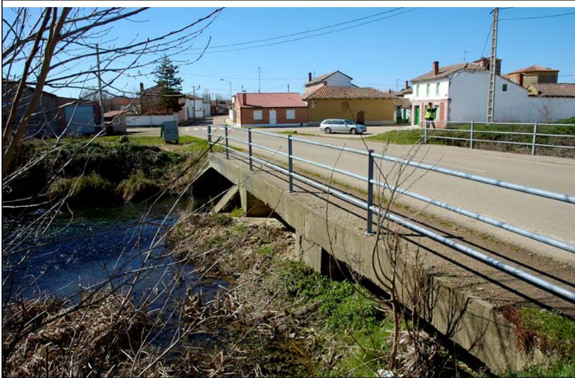
- FOTO 1 Vista general del Puente.
