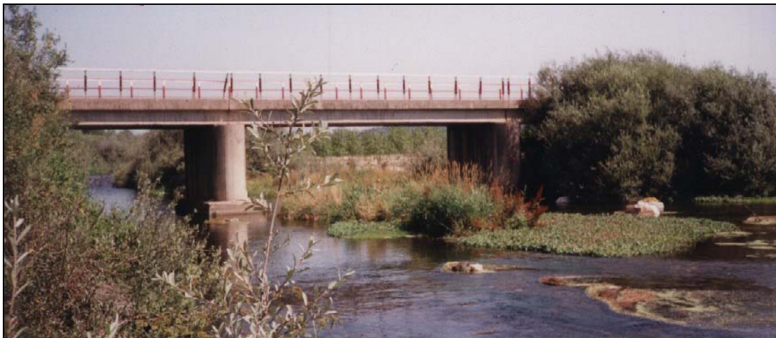
- FOTO 1 Vista desde aguas abajo.
