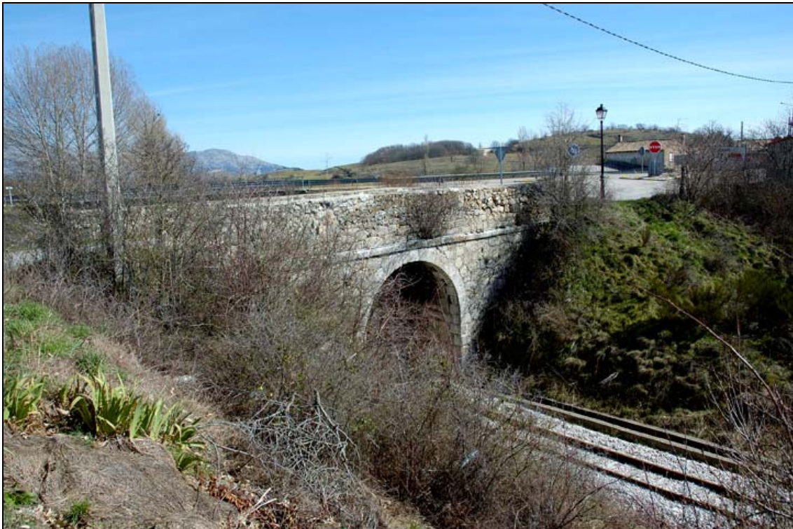
- FOTO 4 Vista lateral del Puente y la vegetación.
