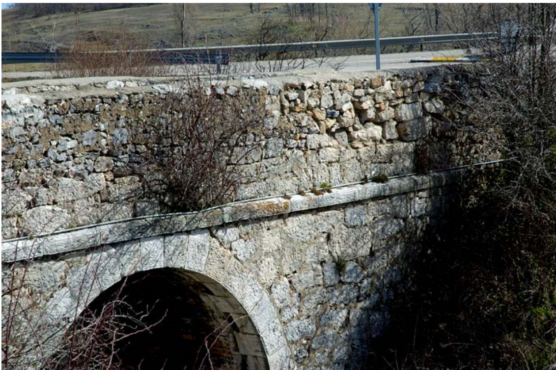
- FOTO 3 Detalle del arco-imposta-pretil.
