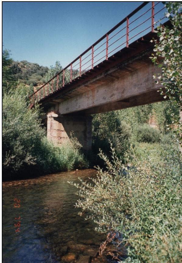
- FOTO 3 Vista desde aguas arriba.
