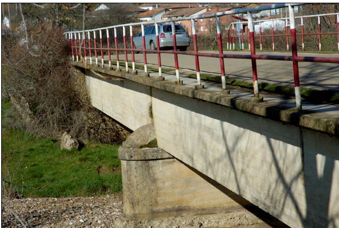
- FOTO 4 Las vigas y la barandilla.
