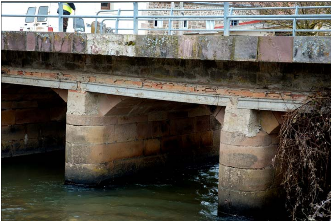
- FOTO 5 Pilas, imposta y barandilla.
