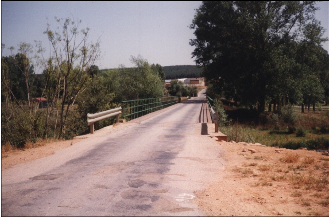
- FOTO 1 Vista de la planta.
