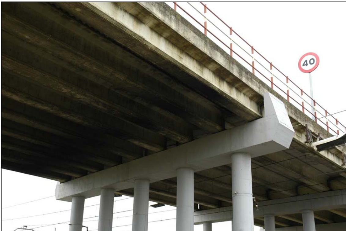
- FOTO 4 Las pilas, los dinteles y el tablero del Puente.
