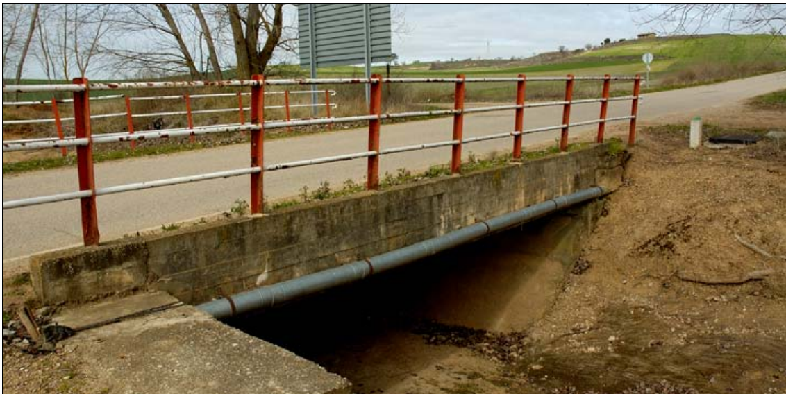
- FOTO 2 El Puente y el canal.
