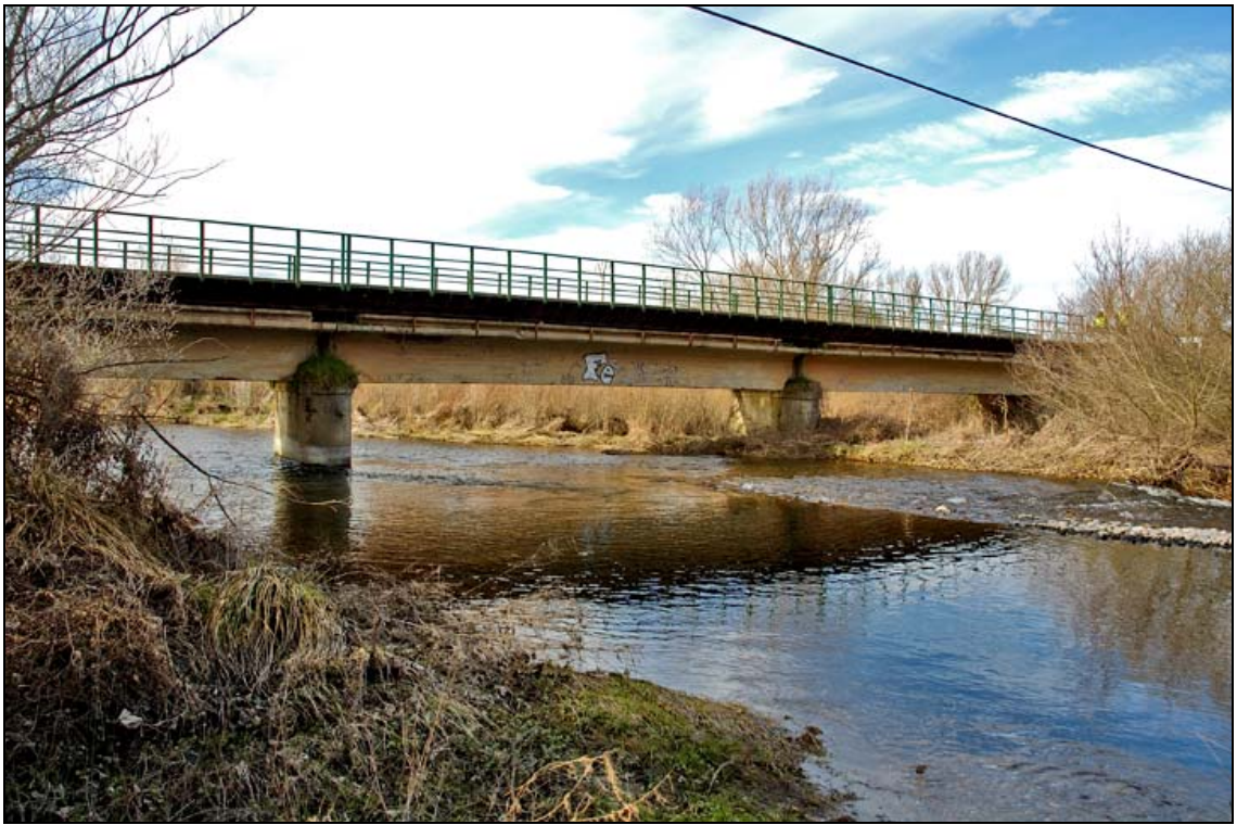
- FOTO 4 El Puente y el río.
