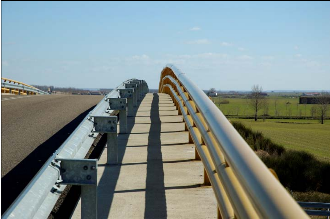
- FOTO 3 Detalle de barandilla-acera-banda bionda.
