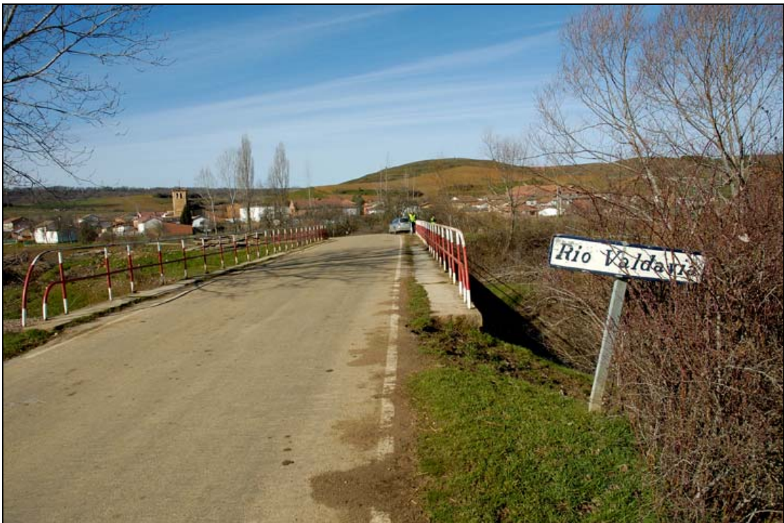
- FOTO 7 La planta de la calzada del Puente.
