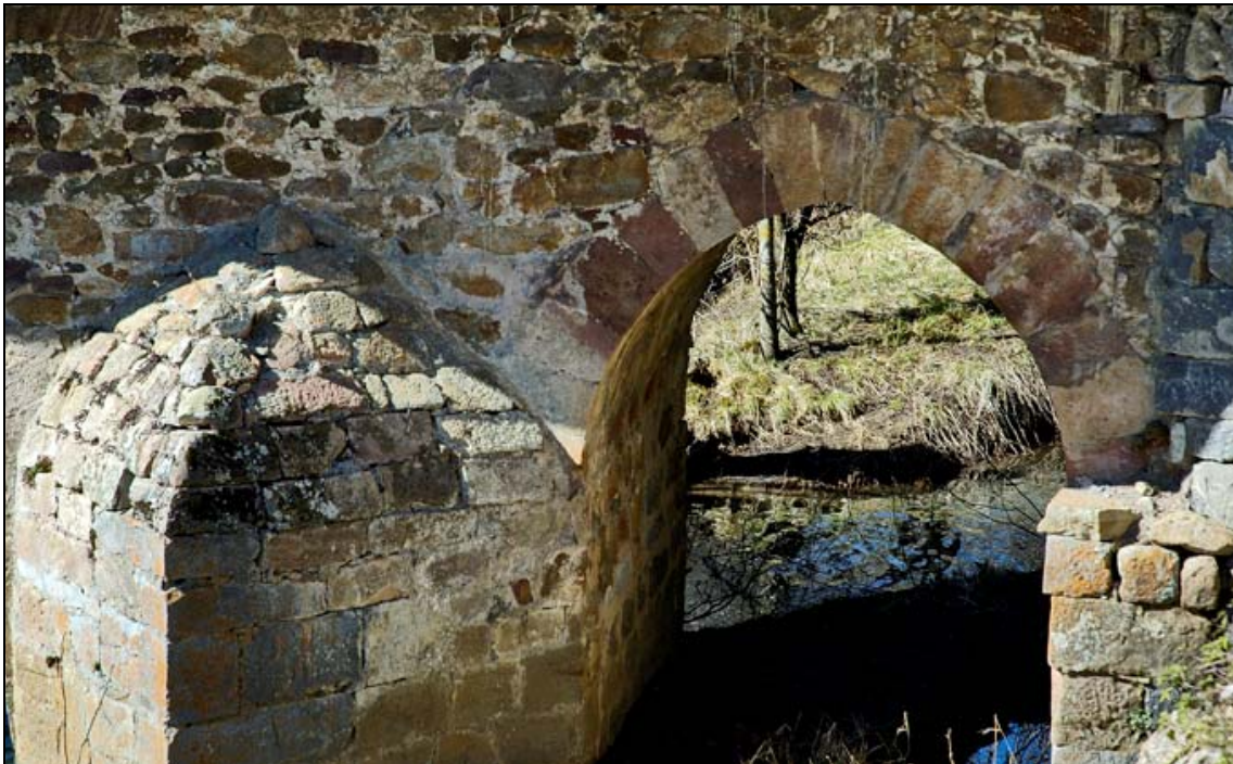
-FOTO 4 Detalle arco aliviadero y espolón.
