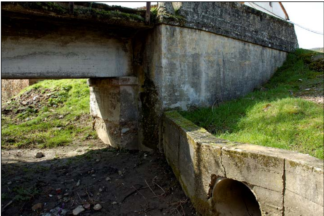
- FOTO 4 Detalle apoyo de la viga.
