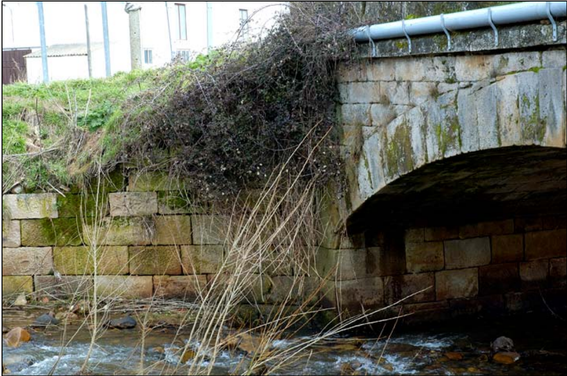
- FOTO 5 Detalle de estribo-aleta-arco.
