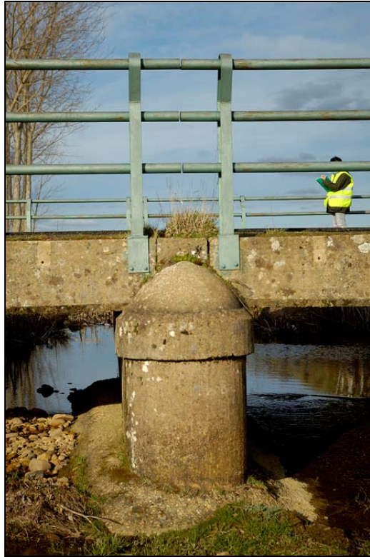
- FOTO 5 Detalle de la pila central.
