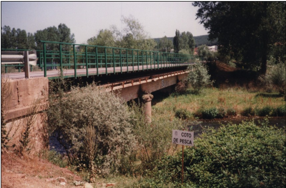
- FOTO 2 El Puente visto desde aguas abajo.
