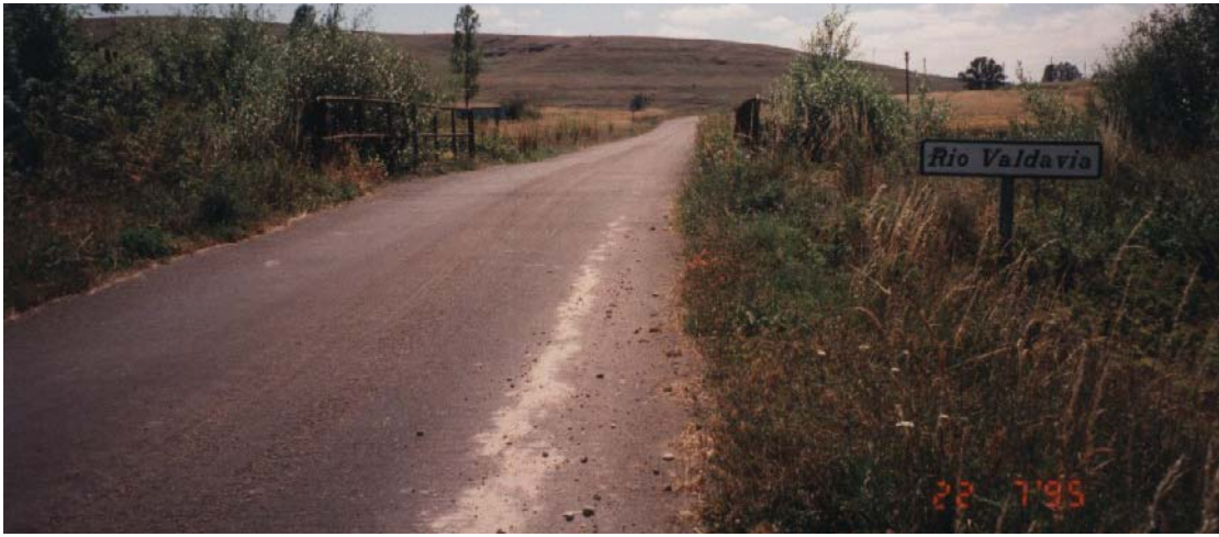
- FOTO 1 Vista de la planta desde la margen izquierda. Cuando el lunes 5 de marzo de 2007 vimos este Puente, presentaba el siguiente aspecto:
