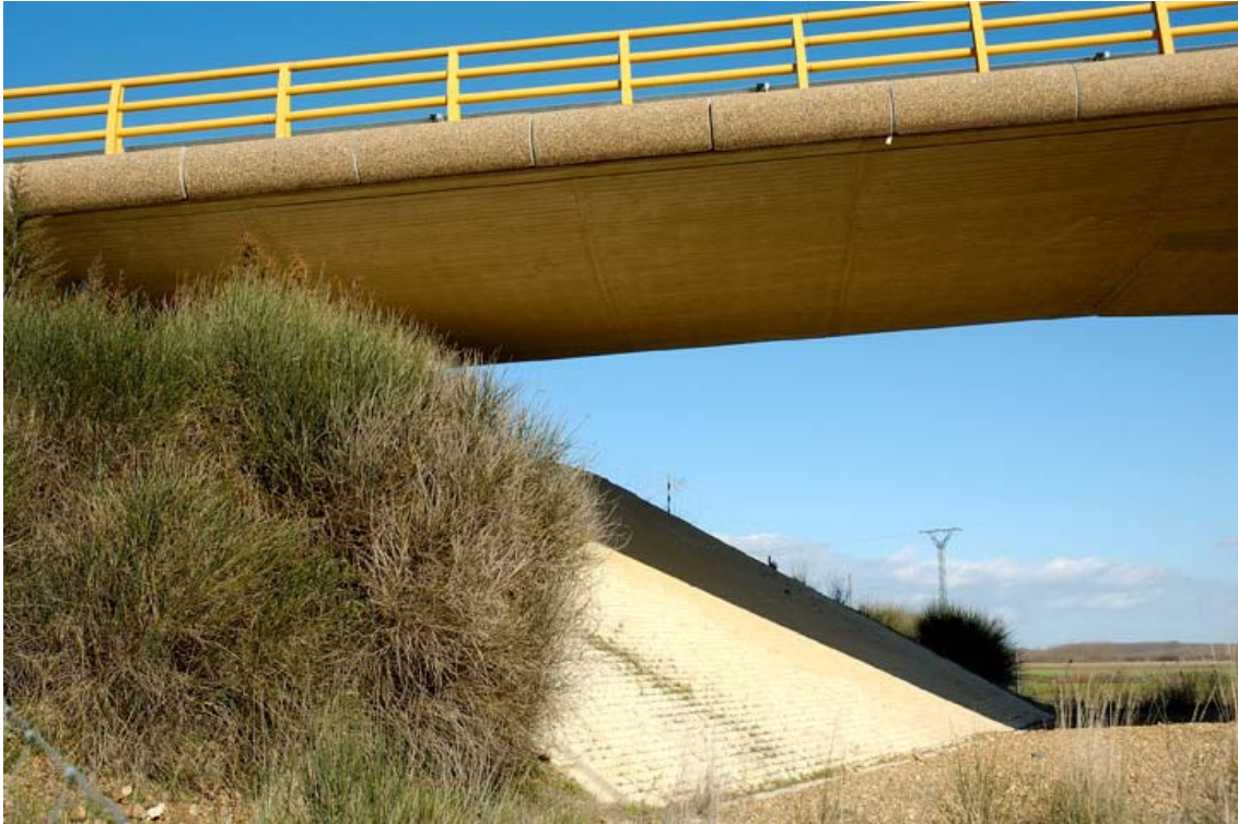
- FOTO 7 Detalle de uno de los estribos y la losa.
