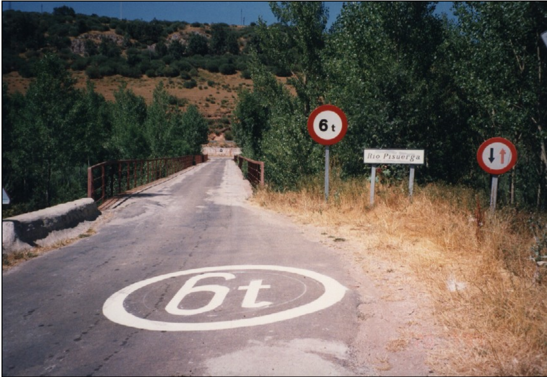
- FOTO 2 Planta desde la margen derecha.
