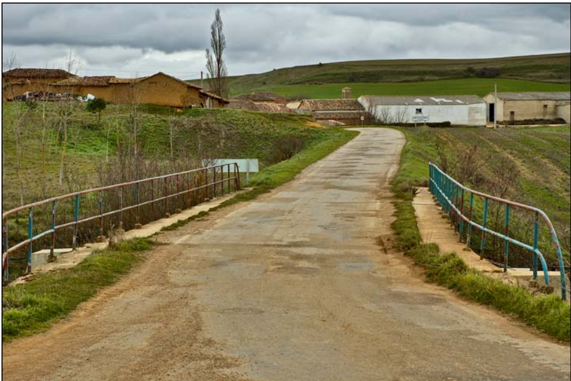
- FOTO 5 Vista de la calzada.
