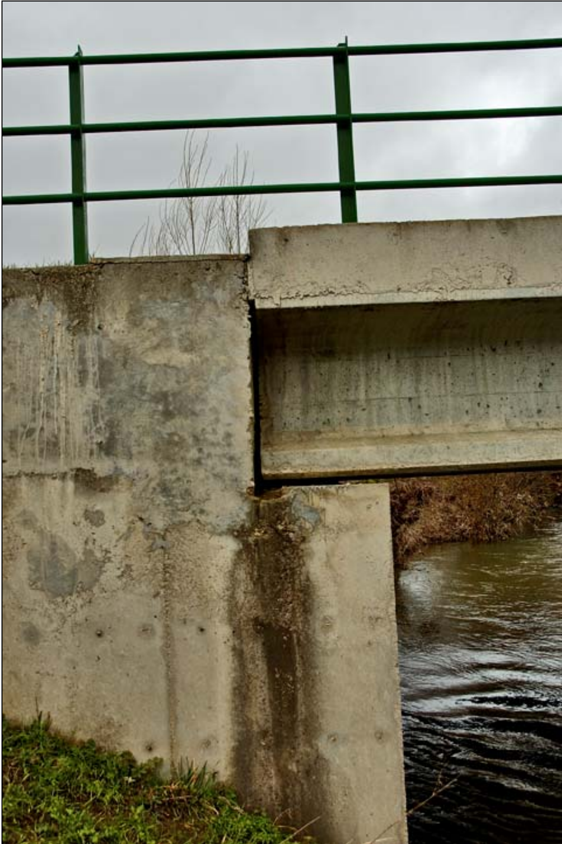
- FOTO 3 Detalle de apoyo viga-estribo.
