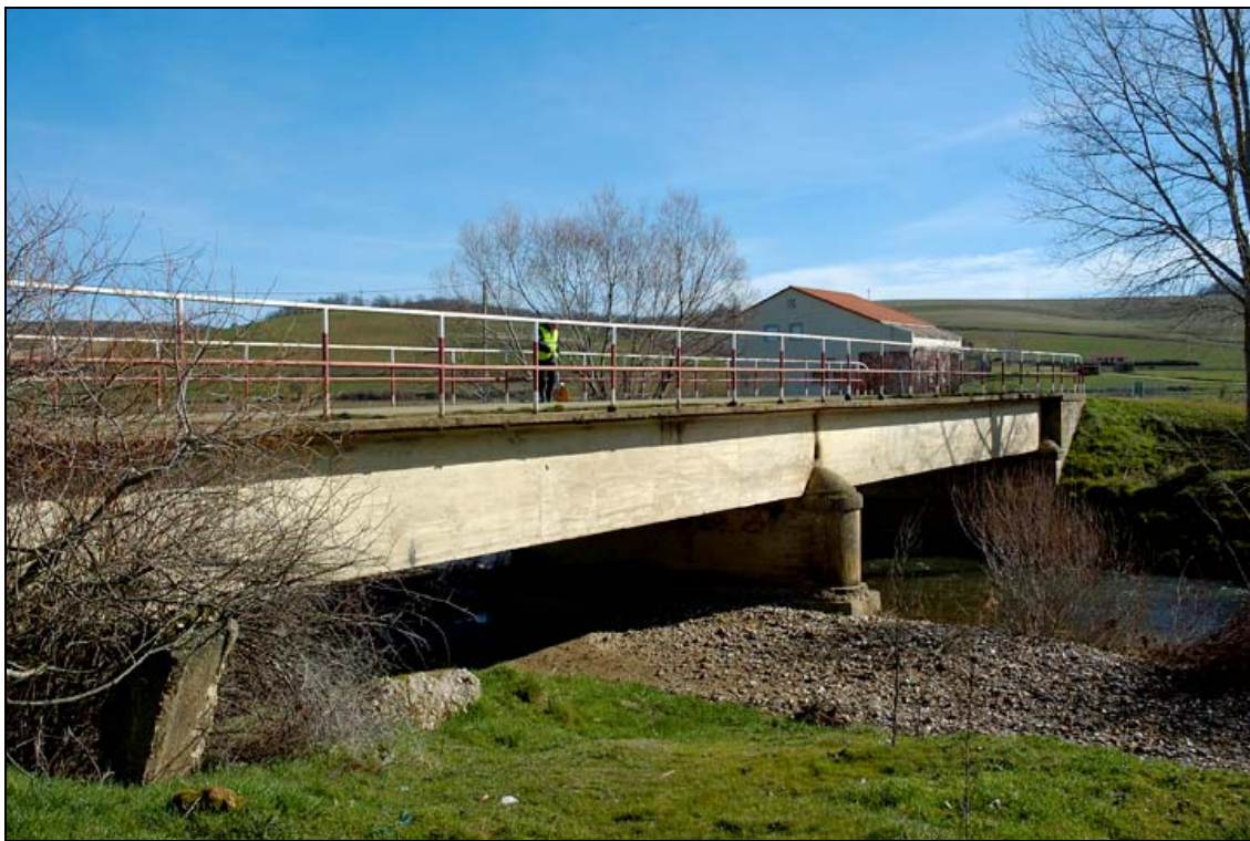
- FOTO 3 Vista general del perfil del Puente.
