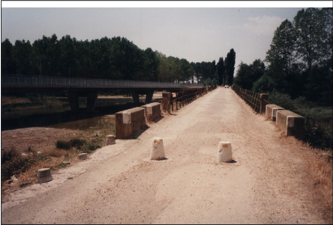
- FOTO 3 La planta del Puente viejo vista desde la margen izquierda.
