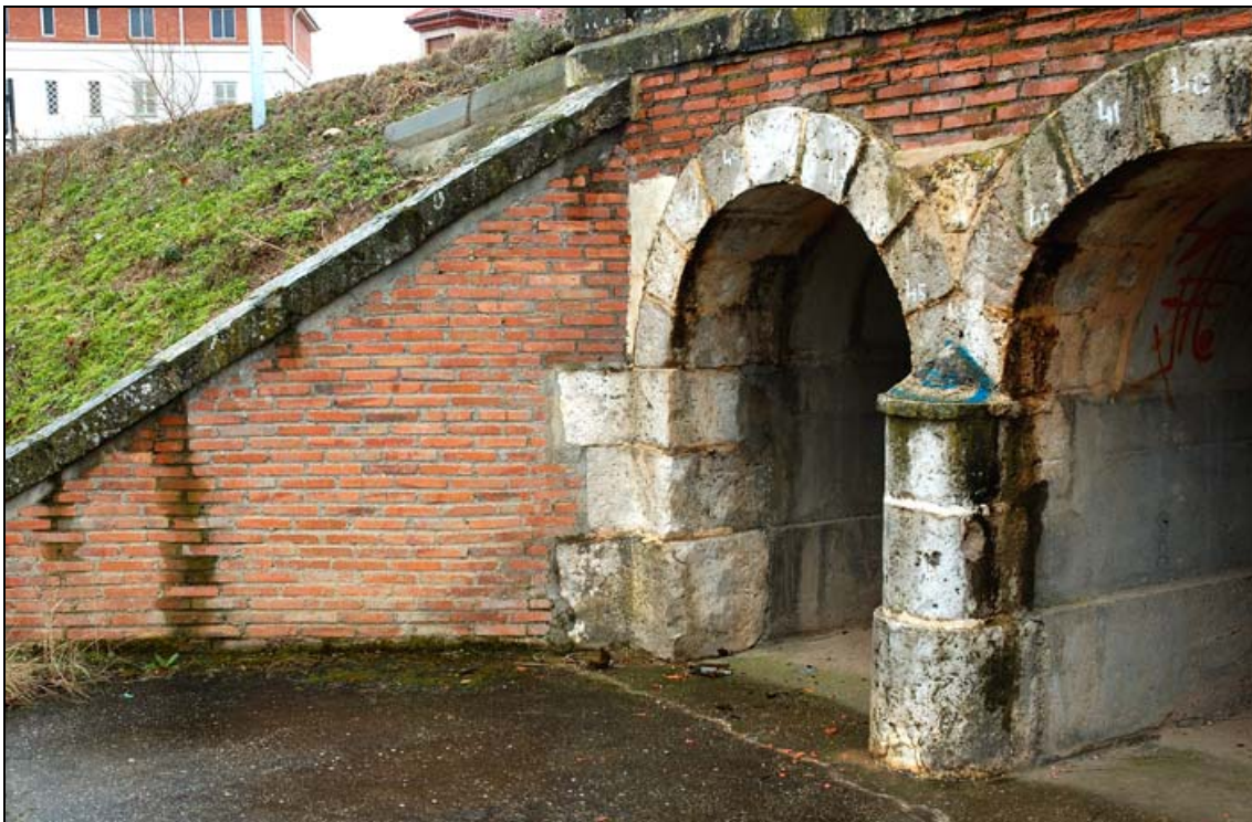
- FOTO 4 Detalle de arco y aleta.
