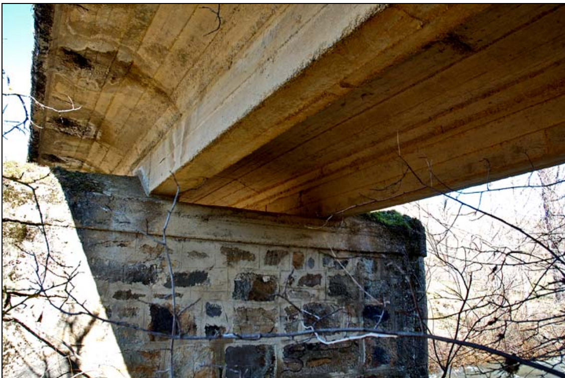
- FOTO 2 Detalle de la viga y uno de los estribos.
