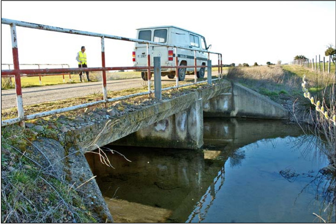
- FOTO 3 Puente de dos vanos.
