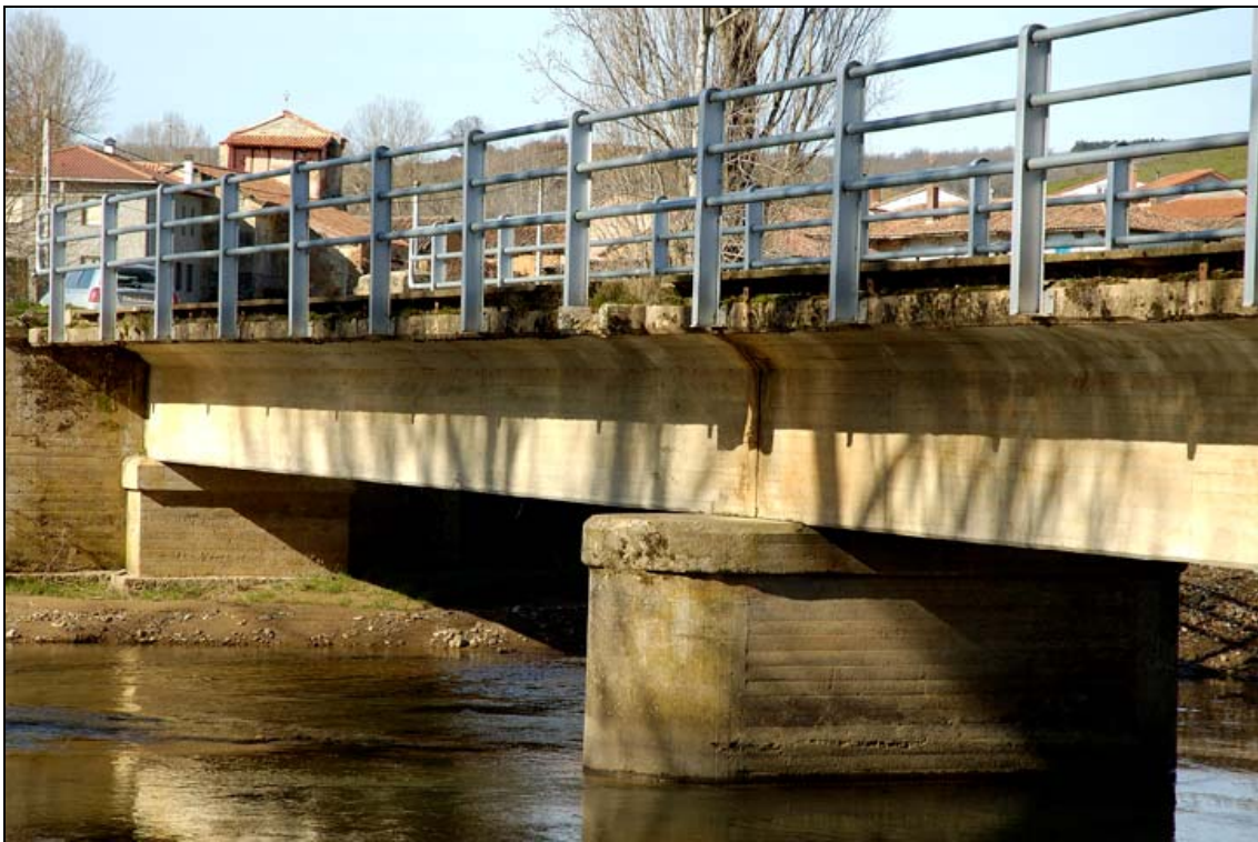
- FOTO 4 Detalle de las vigas y la barandilla.
