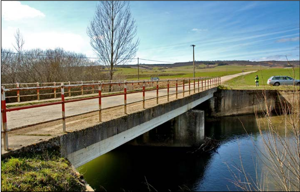
- FOTO 1 El perfil longitudinal del Puente.
