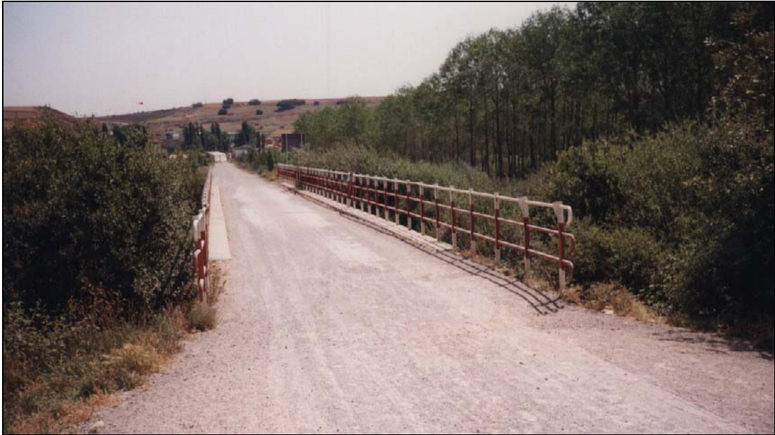
- FOTO 2 Planta desde la margen derecha.
