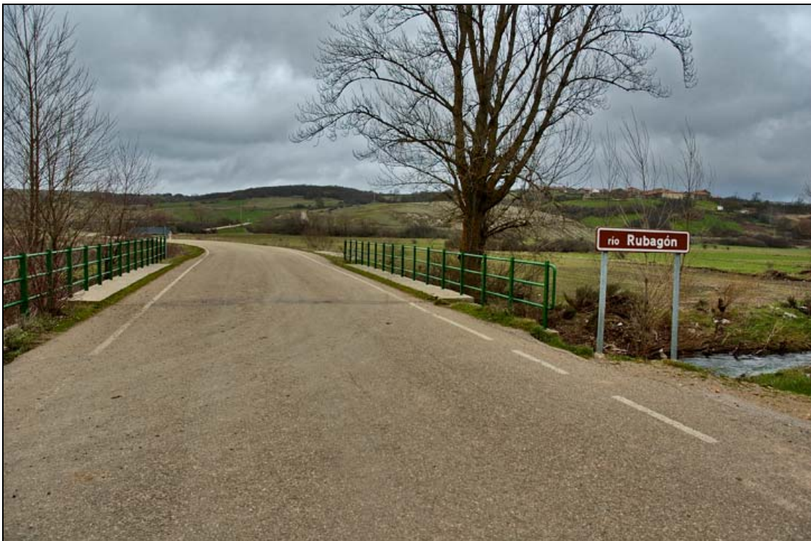
- FOTO 5 La planta de la calzada del Puente.
