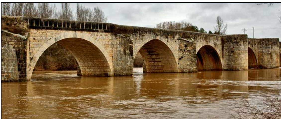
- FOTO 2 Los arcos 5, 6 y 7 vistos desde aguas arriba.
