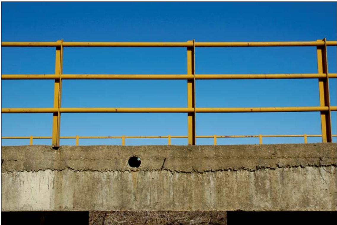
- FOTO 4 Detalle de la barandilla.
