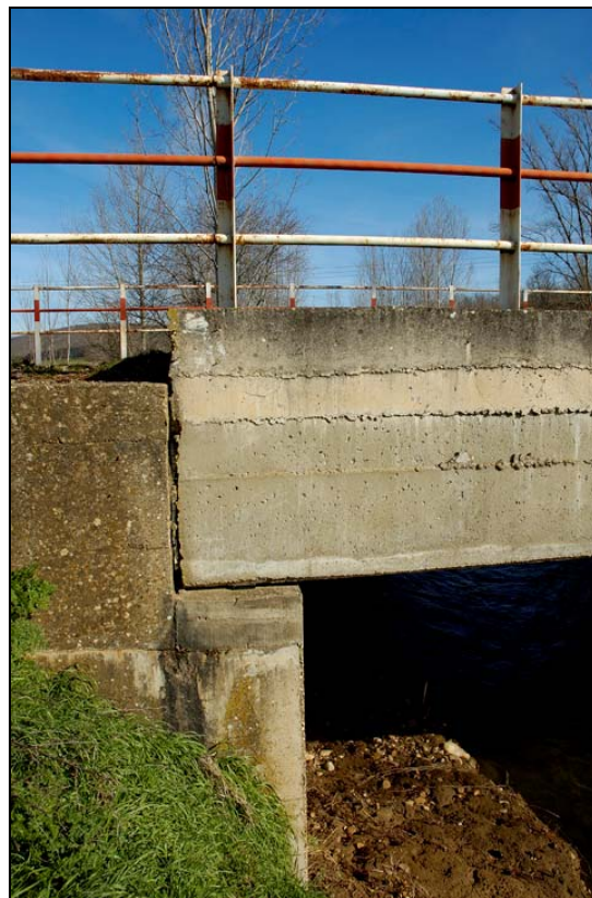
- FOTO 4 Detalle tablero-estribo.
