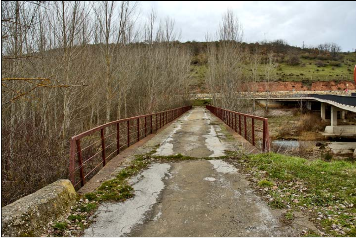
- FOTO 5 La planta de la calzada.
