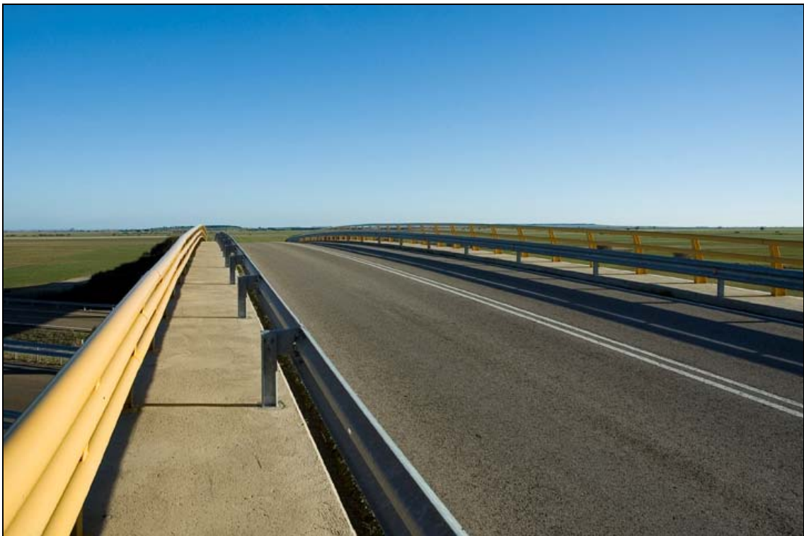
- FOTO 4 Detalle de barandilla-acera-banda bionda-calzada.
