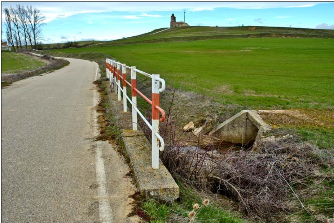
- FOTO 2 Detalle de la barandilla.
