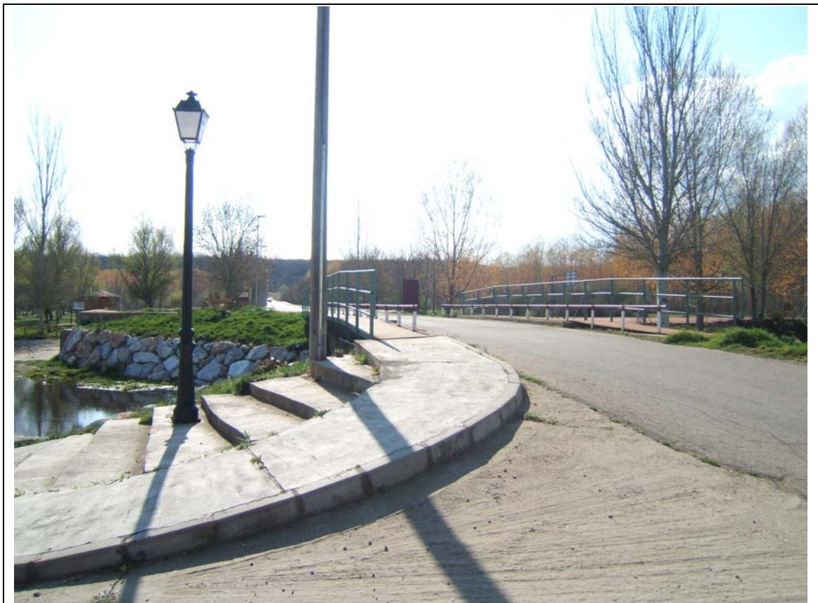
- FOTO 5 Calzada del Puente.
