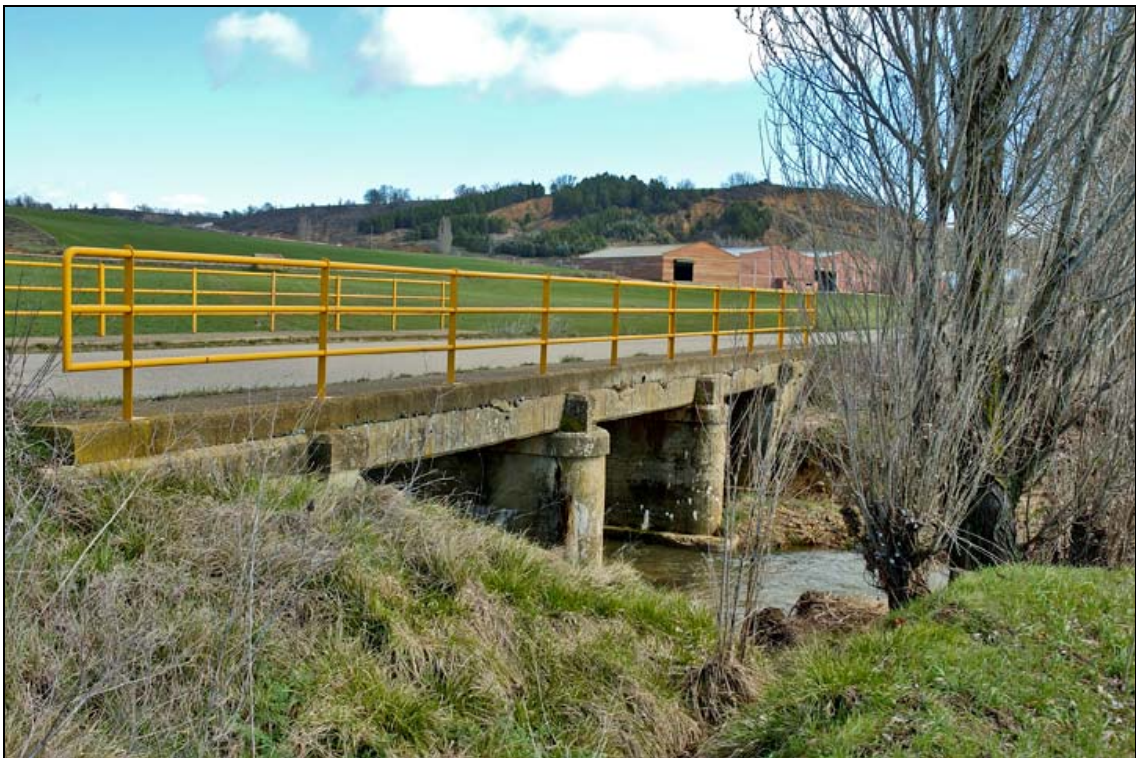
- FOTO 2 El perfil del Puente con su losa y su barandilla.
