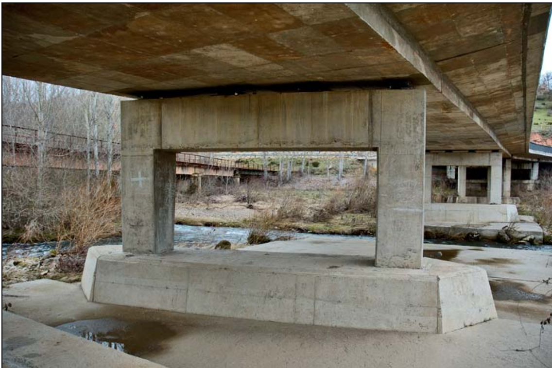
- FOTO 8 Detalle de plataforma, pila y losa de hormigón.
