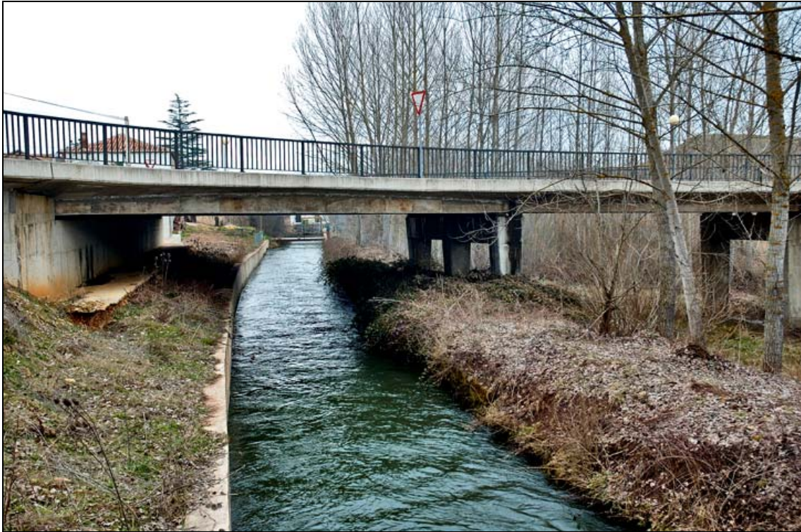
- FOTO 9 Paso del canal bajo el Puente.
