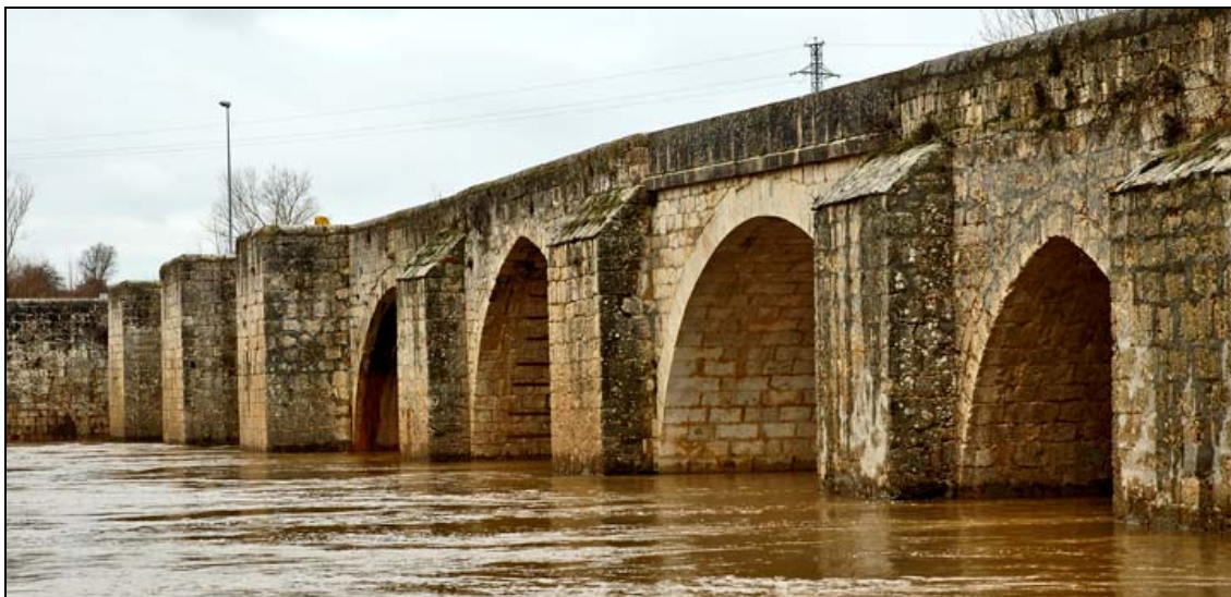
- FOTO 1 Vista general desde aguas abajo y la margen izquierda.
