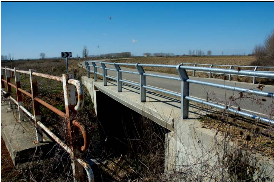
- FOTO 2 Puente nuevo y el Puente viejo.
