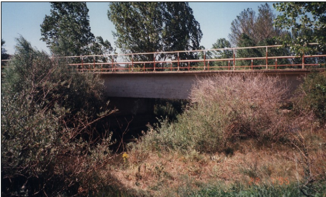
- FOTO 2 Detalle desde aguas abajo.
