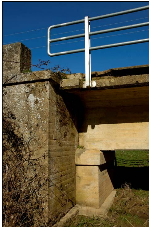
- FOTO 6 Detalle de la nueva barandilla.
