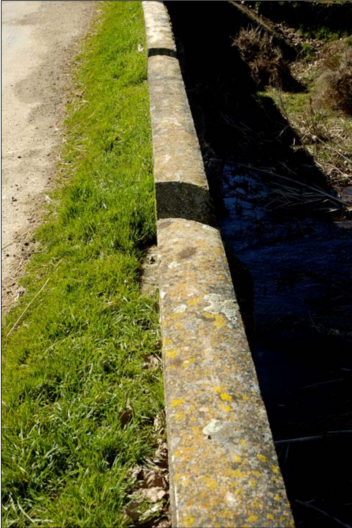
- FOTO 3 Detalle del pretil.
