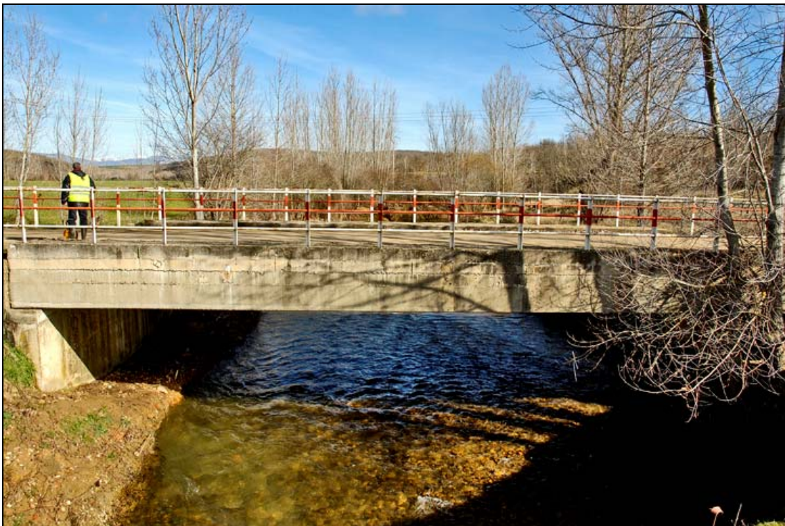
- FOTO 2 Vista general del Puente.
