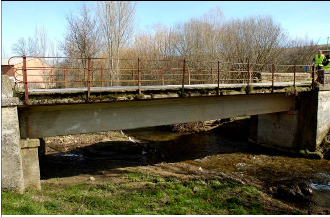
- FOTO 1 Vista general del Puente.
