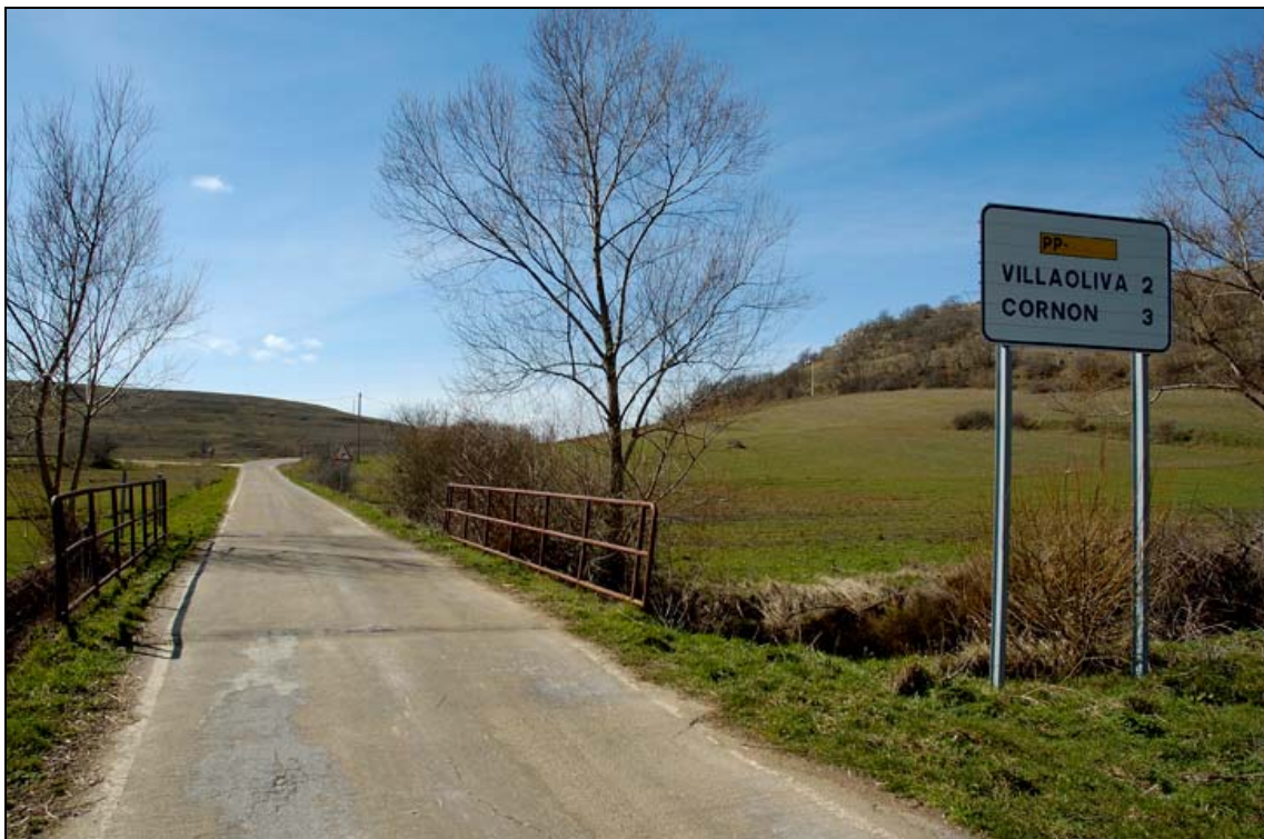
- FOTO 4 Vista de la calzada.
