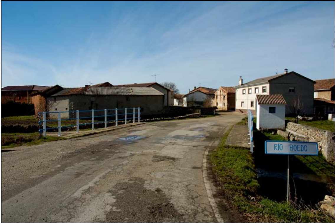
- FOTO 6 La carretera pasa por la calzada del Puente.
