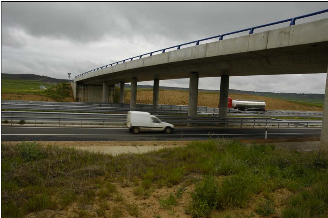
- FOTO 2 El Puente y su la autovía.
