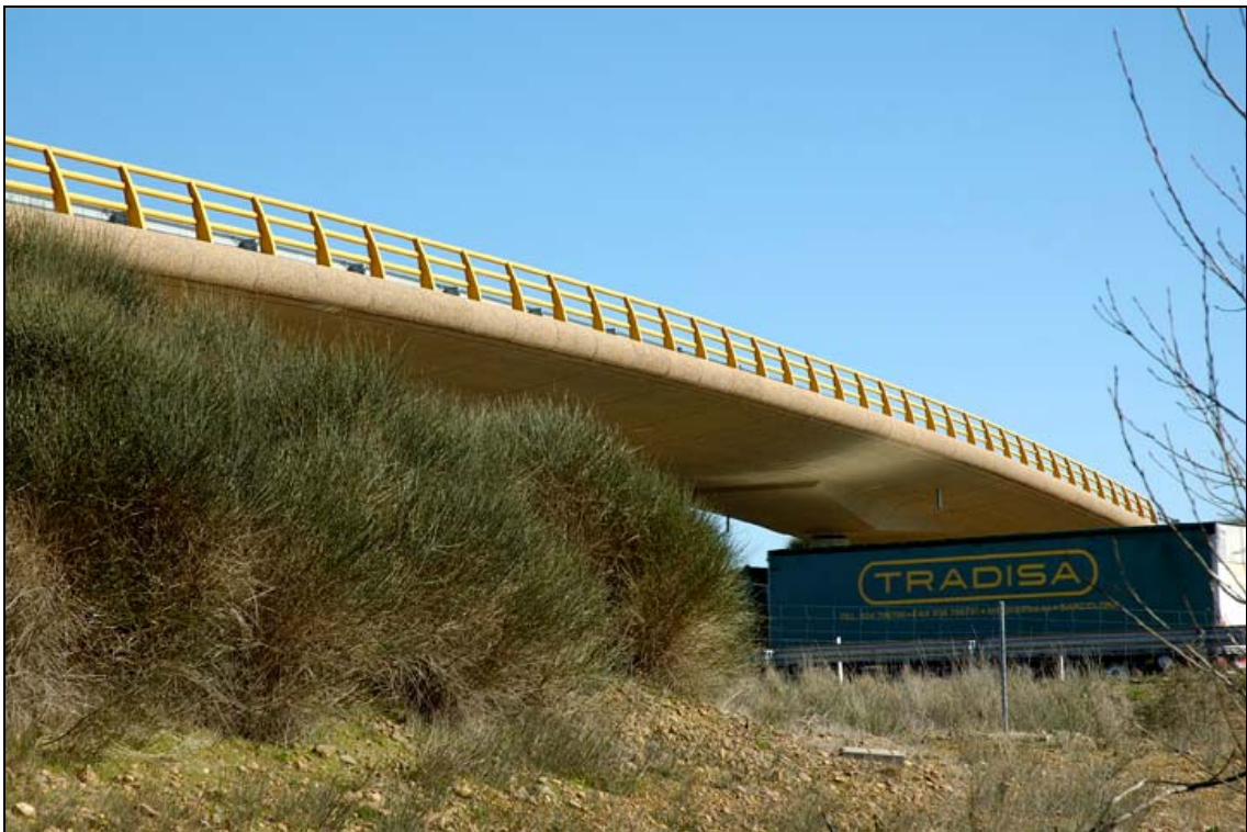
- FOTO 2 Vista de la losa y la barandilla.
