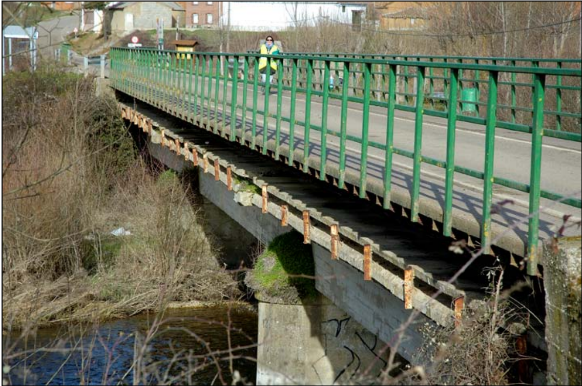
- FOTO 5 El perfil del Puente con la barandilla.
