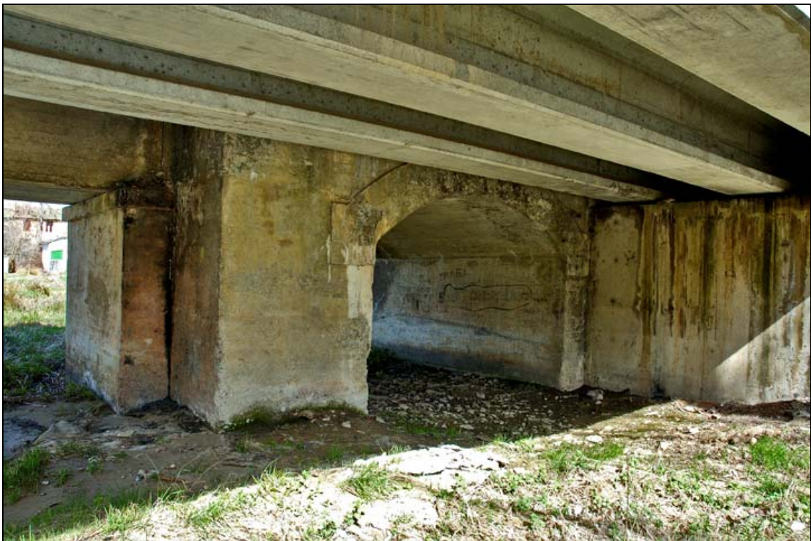
- FOTO 8 Interior del Puente. Detalle.
