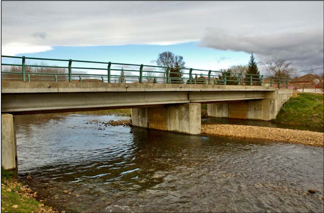
- FOTO 1 Vista general del Puente.
