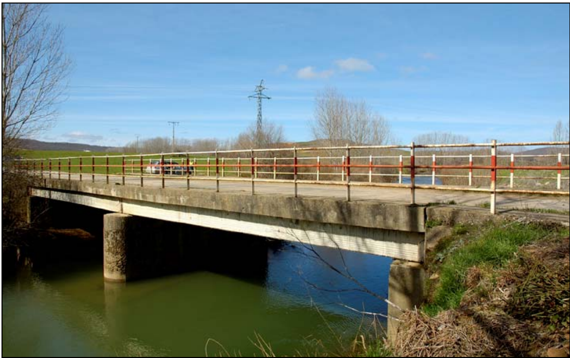
- FOTO 2 Otra vista de la rasante del Puente.
