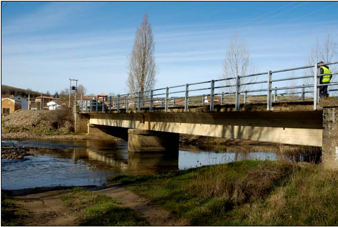
- FOTO 3 Vista general del perfil del Puente.
