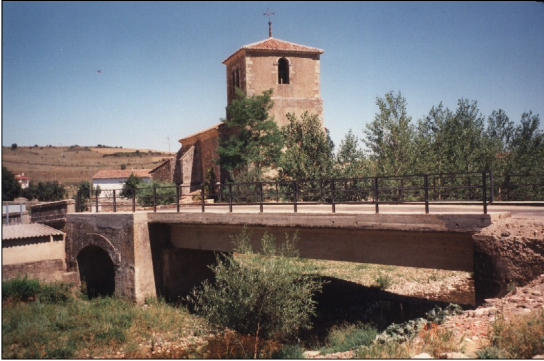
- FOTO 1 El Puente visto desde aguas arriba.
