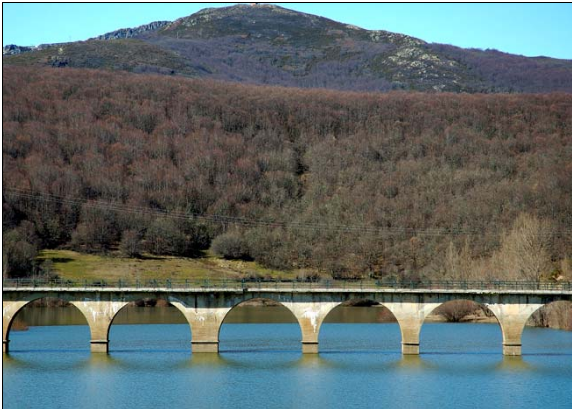
- FOTO 4 Vista general desde aguas abajo.
