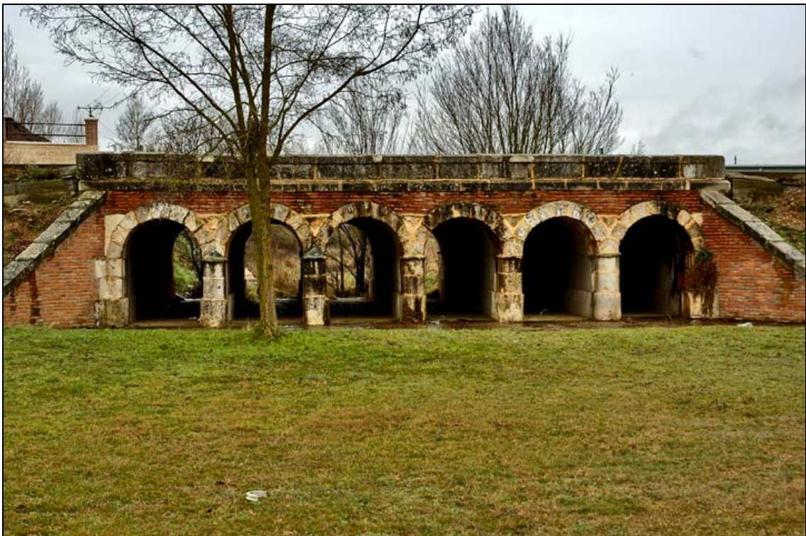
- FOTO 2 Vista general desde aguas abajo.
