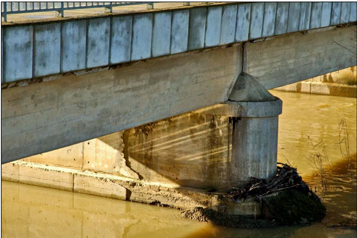
- FOTO 4 Detalle tablero-pila.
