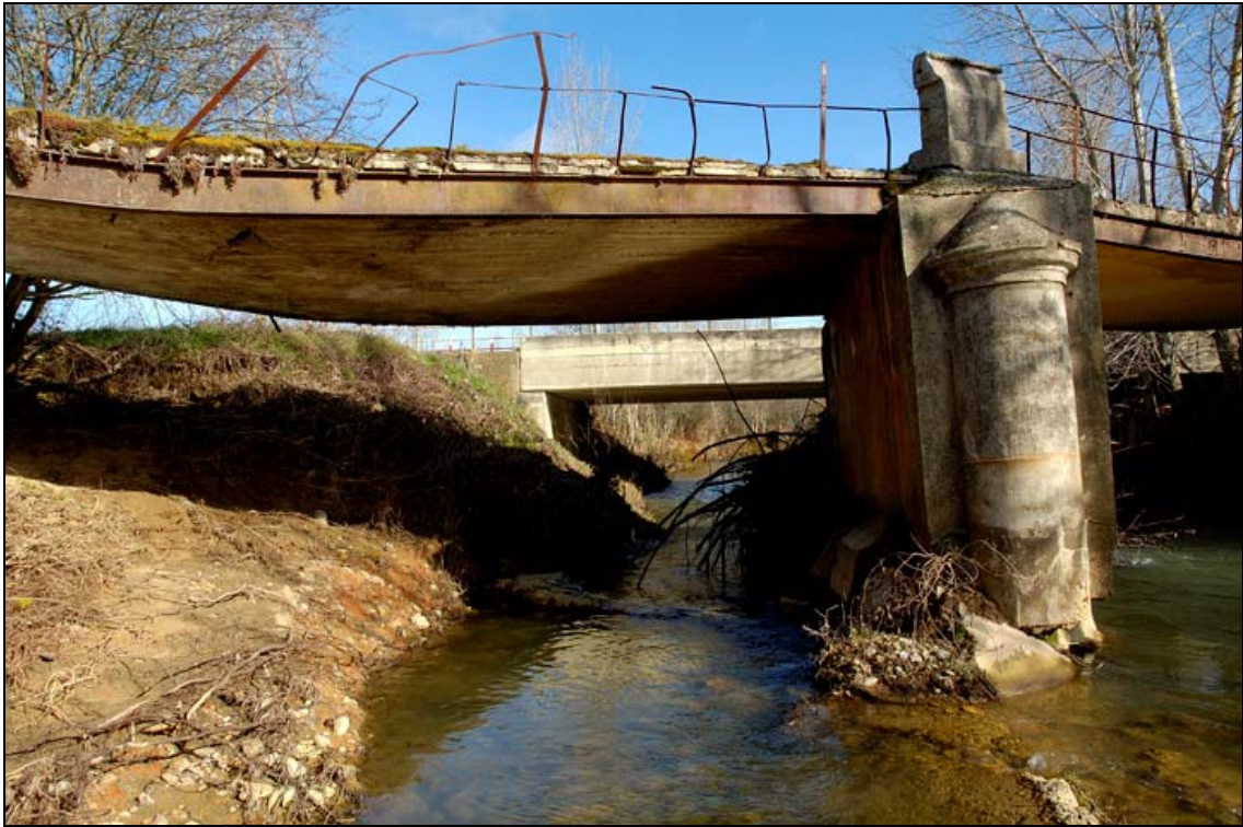
- FOTO 7 El Puente viejo, al lado, abandonado.
