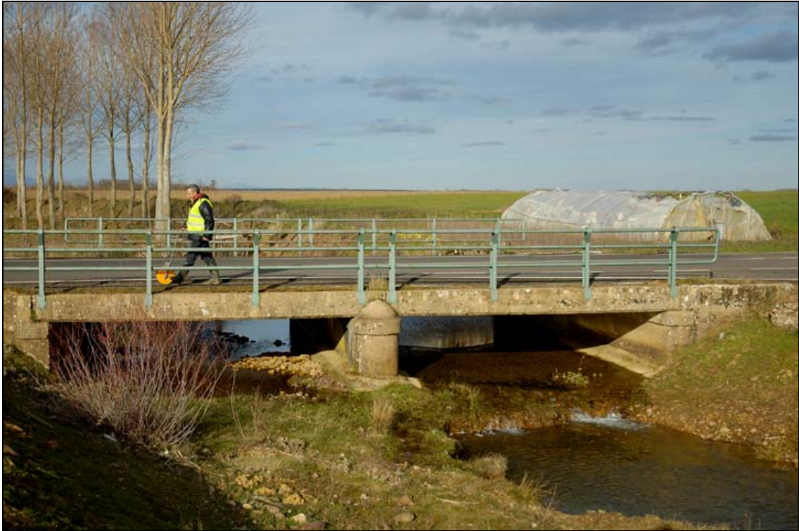
- FOTO 1 Vista del Puente.
