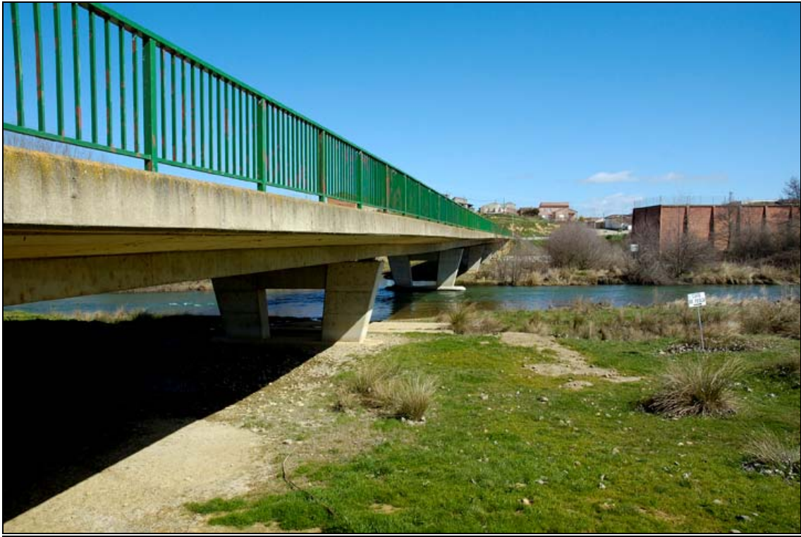
- FOTO 5 Vista del perfil y la barandilla metálica del Puente nuevo.
