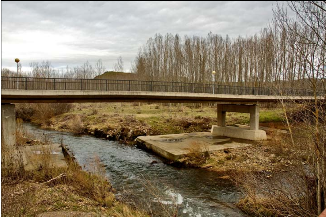
- FOTO 7 Vista del Puente Nuevo desde el antiguo
