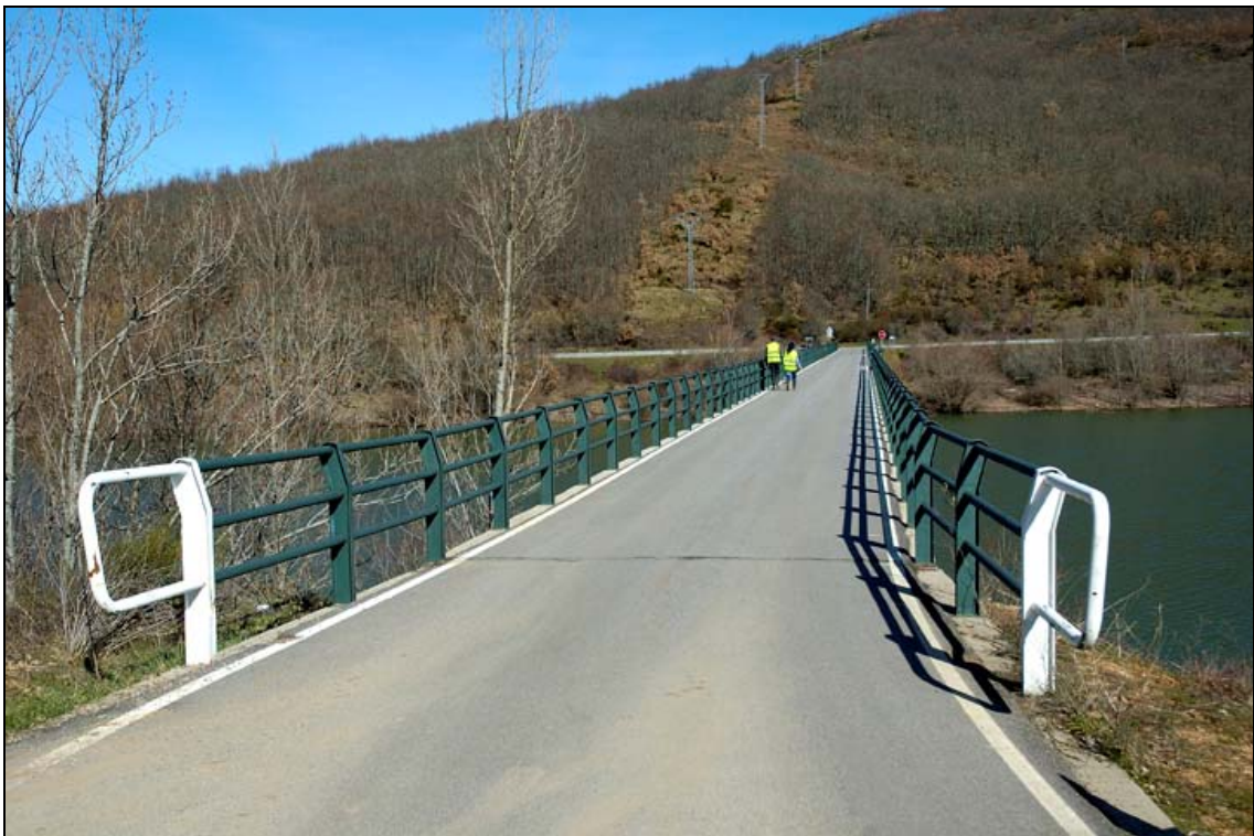
- FOTO 8 Vista general de la calzada del Puente.
