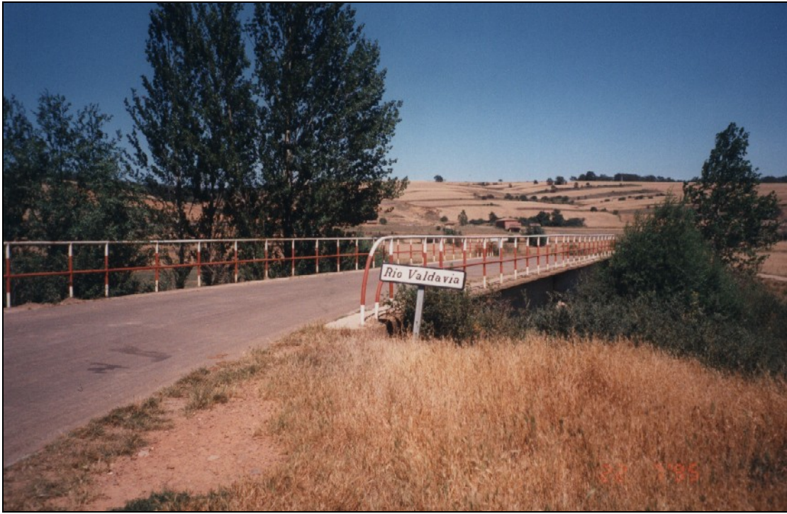
- FOTO 1 Vista de la planta del Puente desde la margen derecha.
