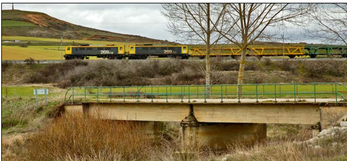
- FOTO 1 Vista del Puente y la vía del ferrocarril al fondo.
