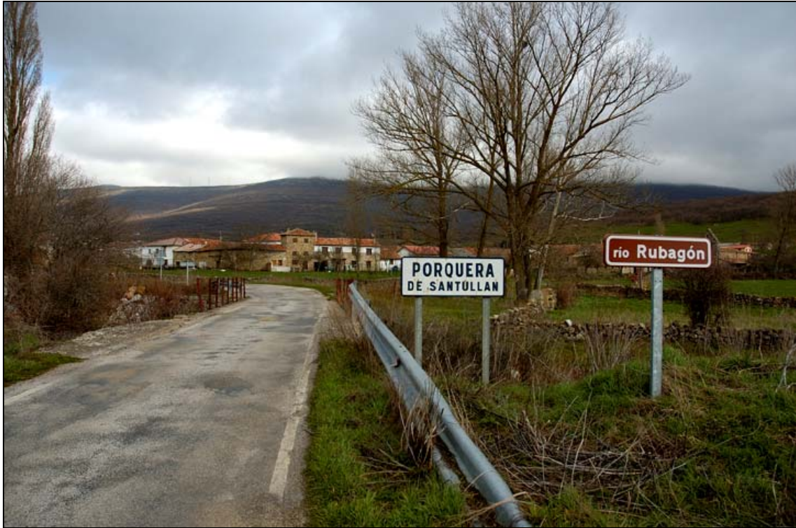
- FOTO 5 La calzada del Puente.
