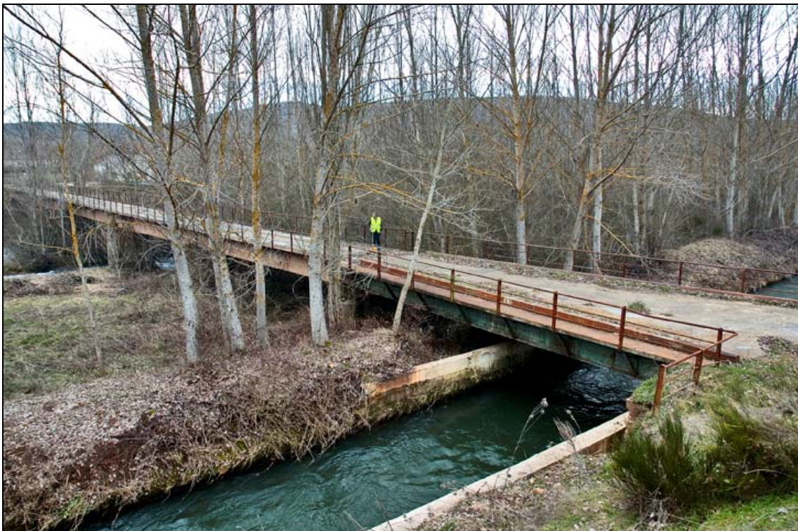
- FOTO 6 Vista general. Puente nuevo
