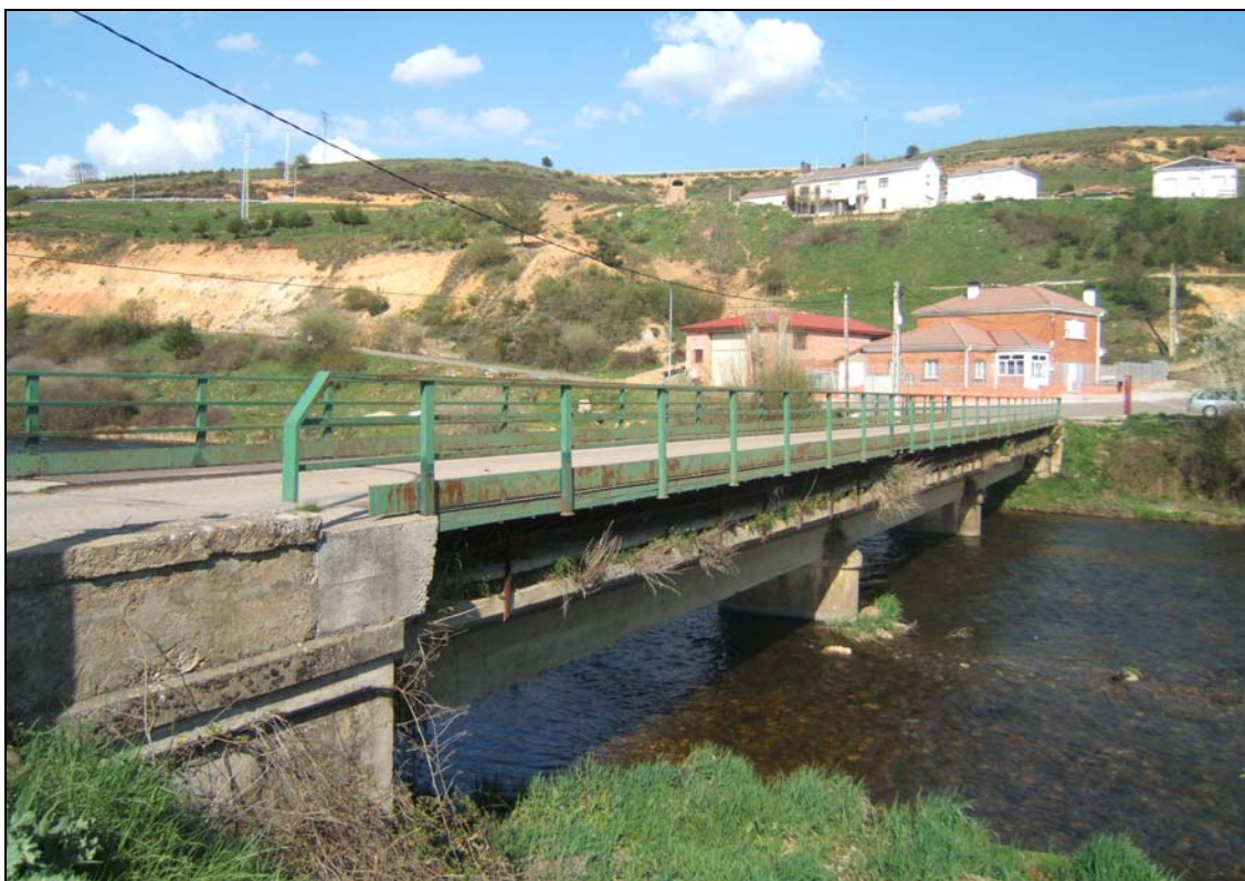
- FOTO 4 Vista general del Puente.
