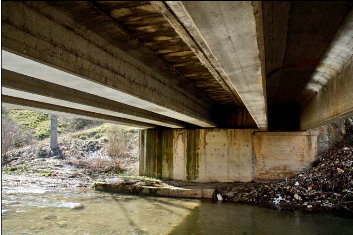
- FOTO 7 Detalle de las vigas.
