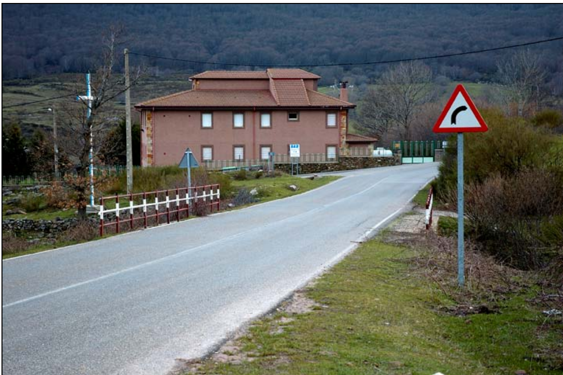
- FOTO 3 La calzada del Puente.
