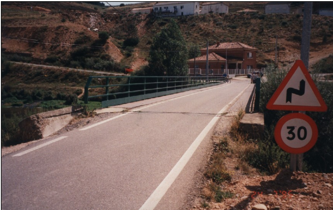
- FOTO 2 Planta desde la margen derecha.
