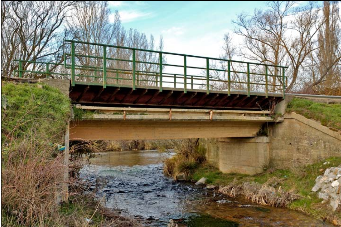
- FOTO 3 El Puente y el cauce.
