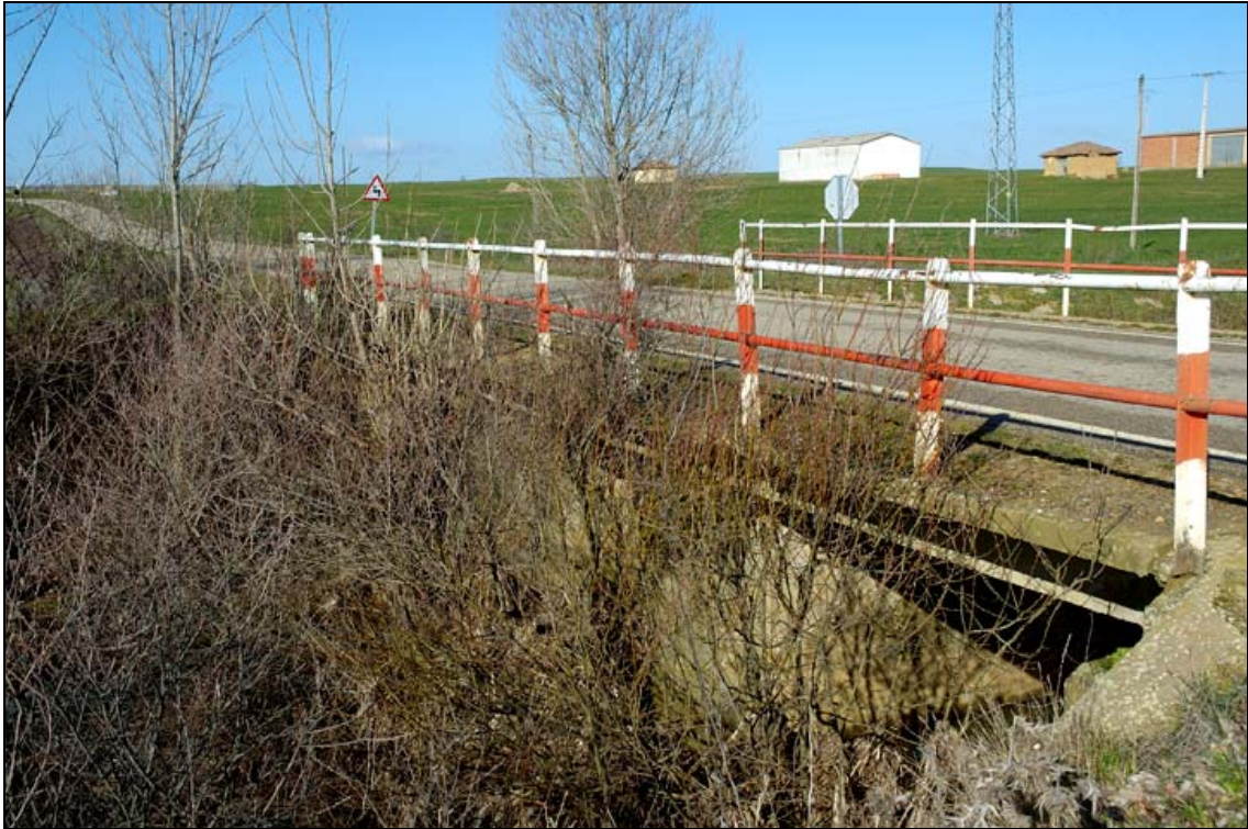
- FOTO 2 La barandilla del Puente.
