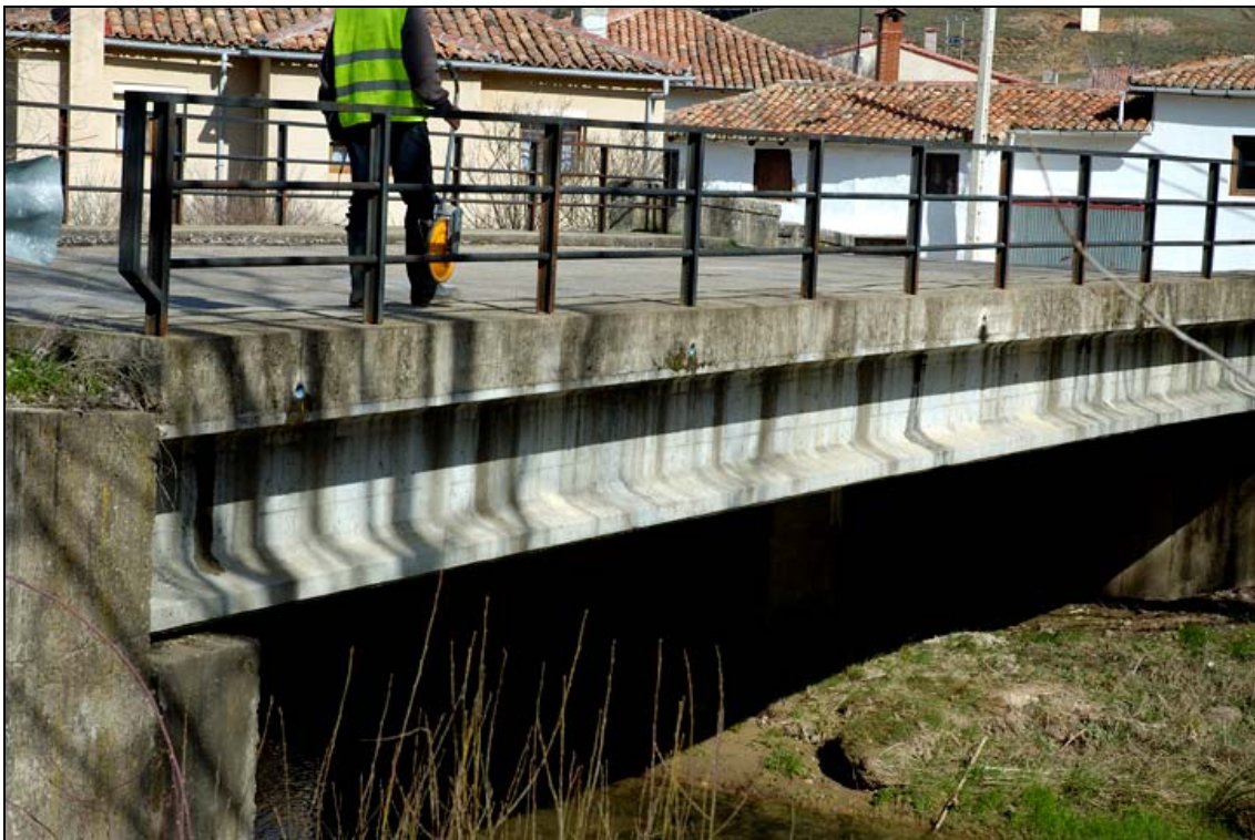
- FOTO 4 Una de las vigas y la barandilla actual.
