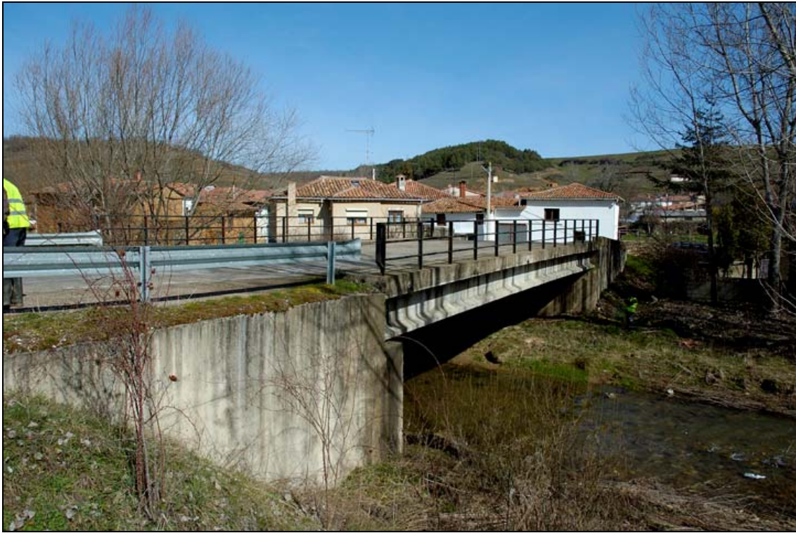
- FOTO 3 El perfil del Puente.
