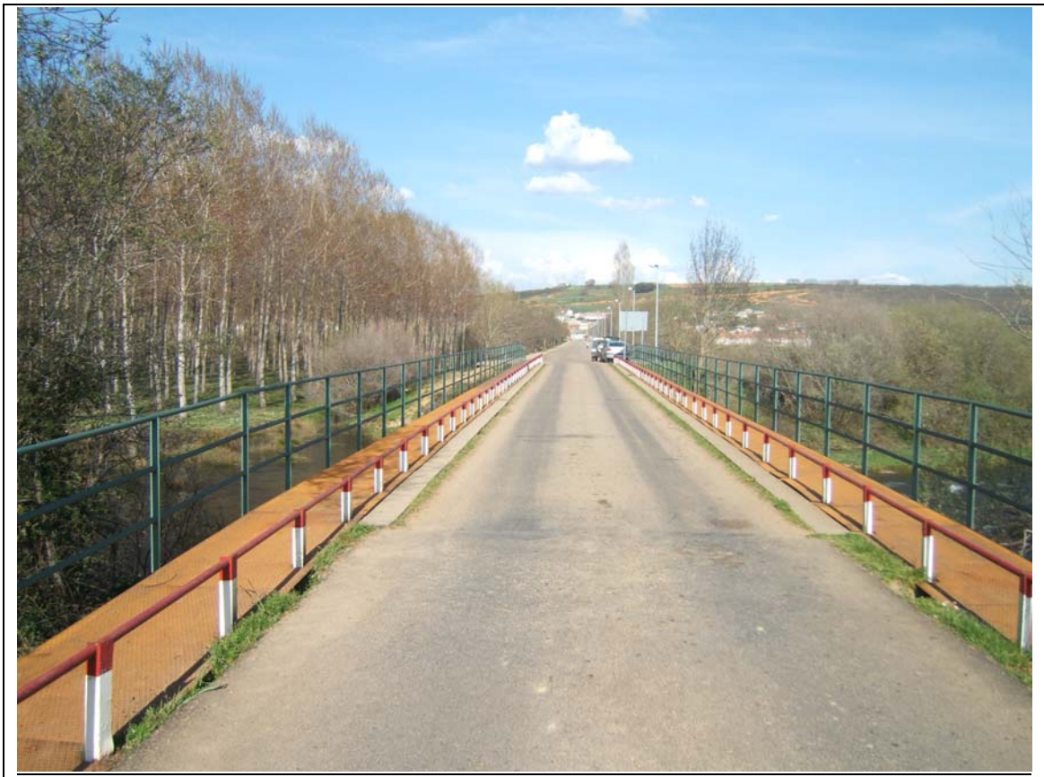
- FOTO 3 Vista general del Puente.
