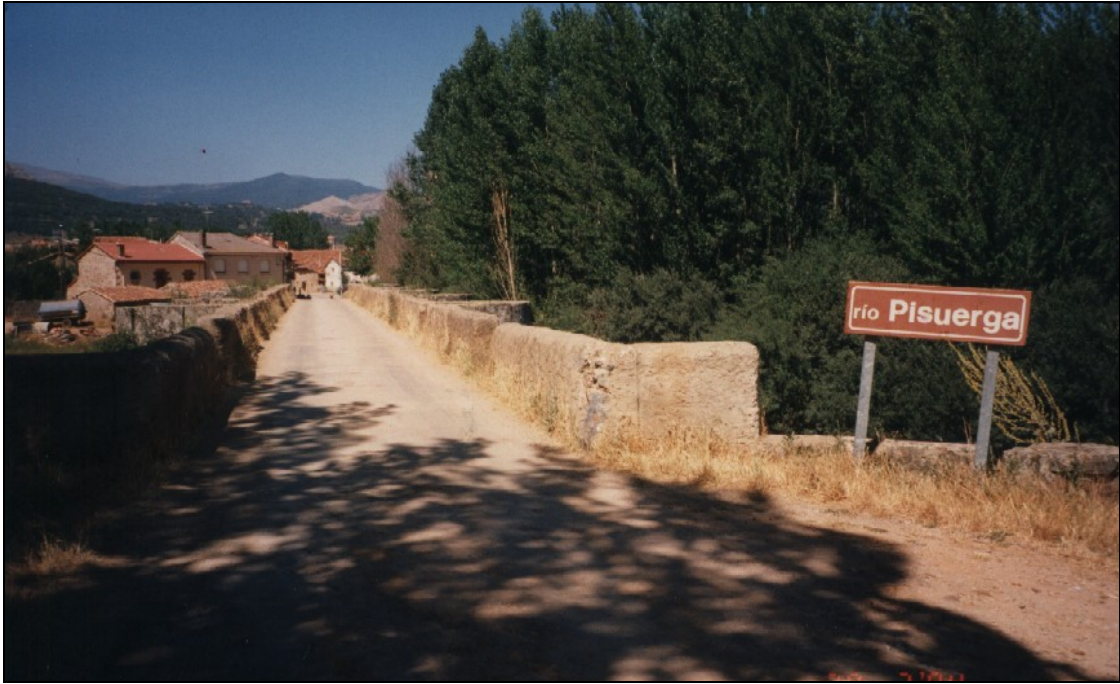
- FOTO 2 Planta desde la margen derecha. Marzo 2007:
