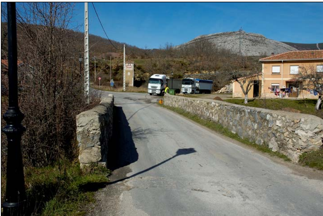
- FOTO 5 La planta y los pretilos.
