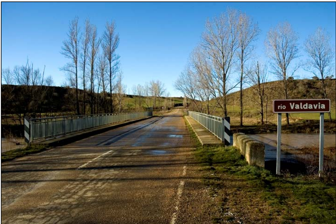
- FOTO 6 La calzada del Puente.
