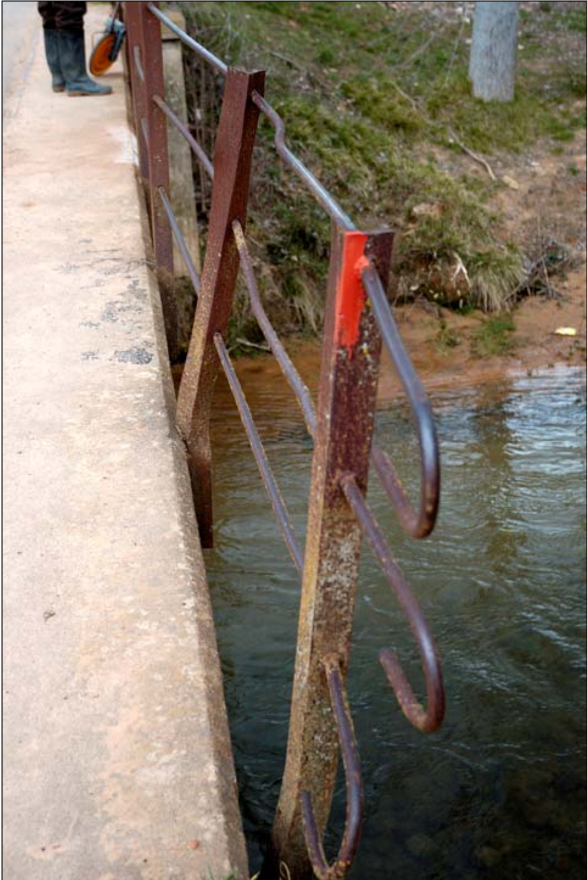
- FOTO 3 Detalle de la barandilla.
