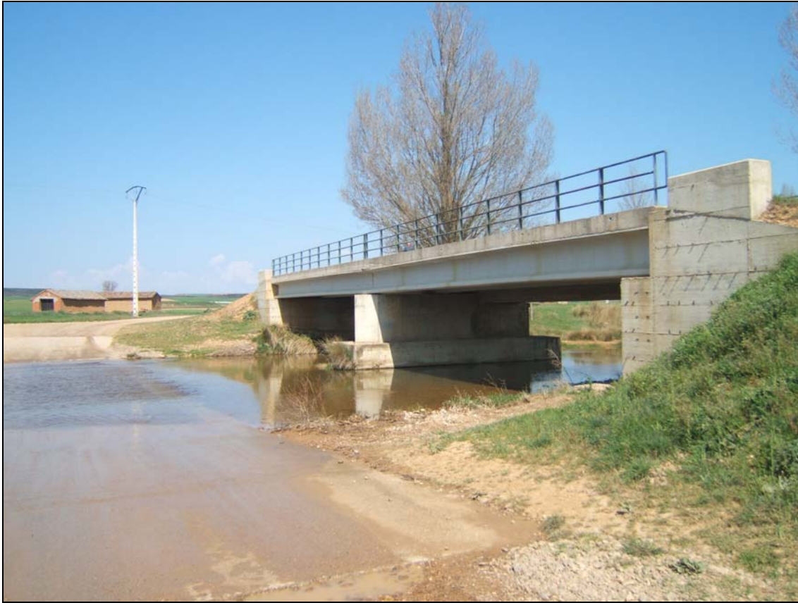
- FOTO 1 Vista general del Puente.
