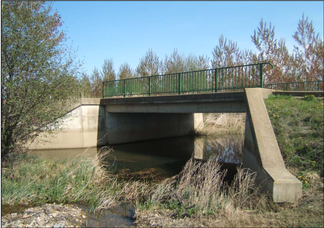
- FOTO 1 Vista del Puente.
