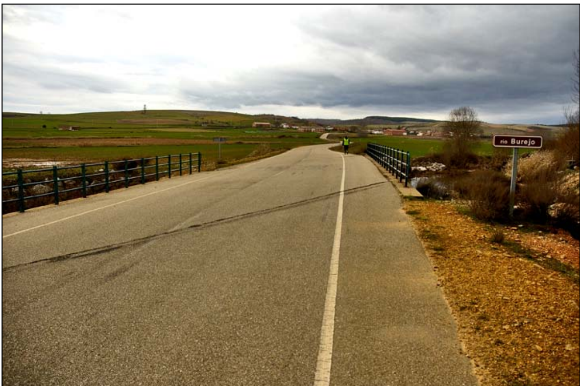
- FOTO 2 Planta desde margen izquierda.
