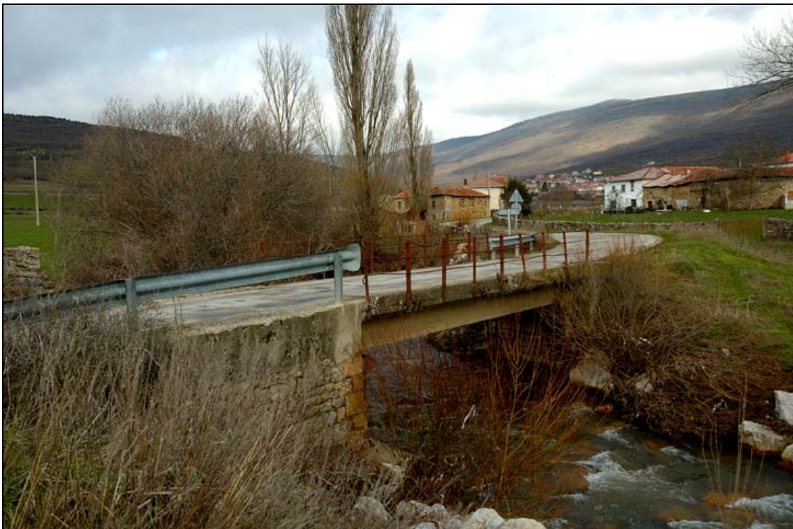
- FOTO 4 Vista general del conjunto.
