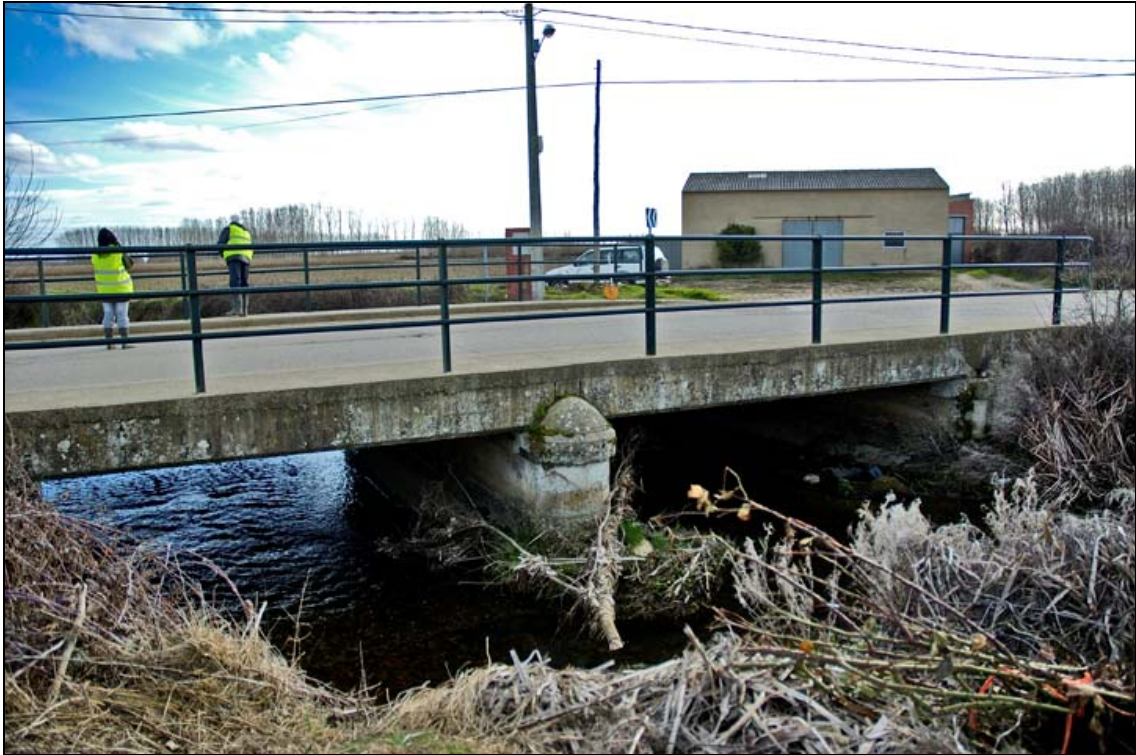
- FOTO 1 Vista del Puente.
