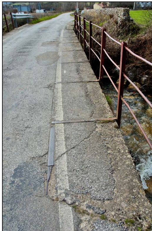
- FOTO 6 Detalle de la barandilla.
