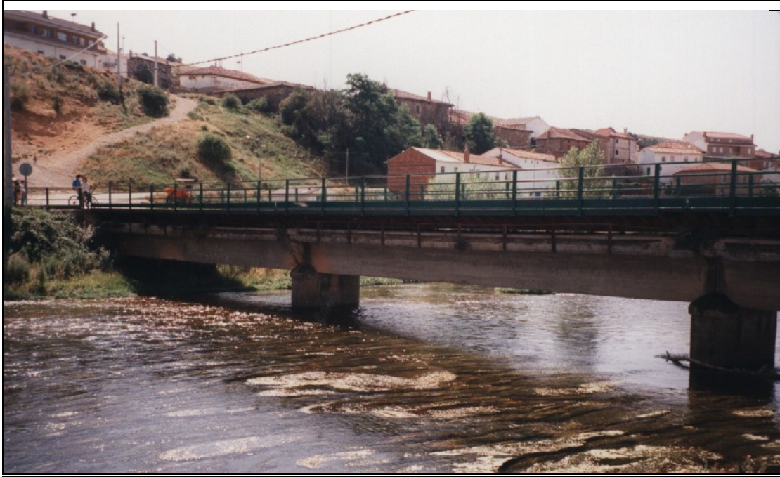
- FOTO 1 Vista desde aguas arriba.
