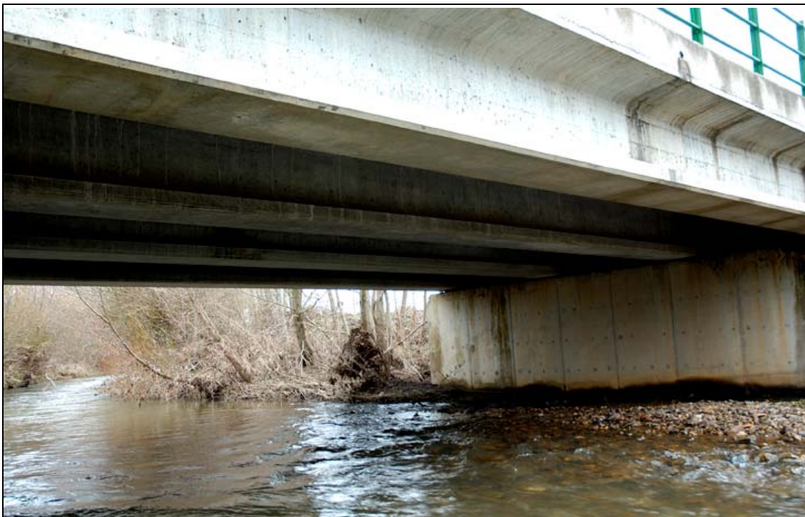
- FOTO 2 Las vigas y uno de los estribos.
