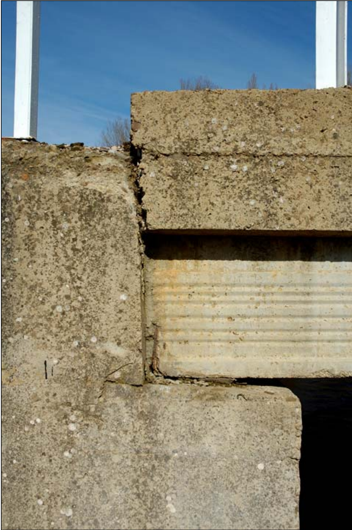
- FOTO 5 Detalle del apoyo de la losa.
