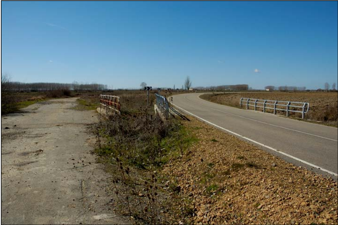
- FOTO 3 Silueta de la carretera con la calzada del Puente.
