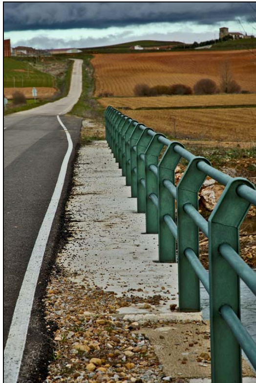
- FOTO 4 Detalle de la barandilla.
