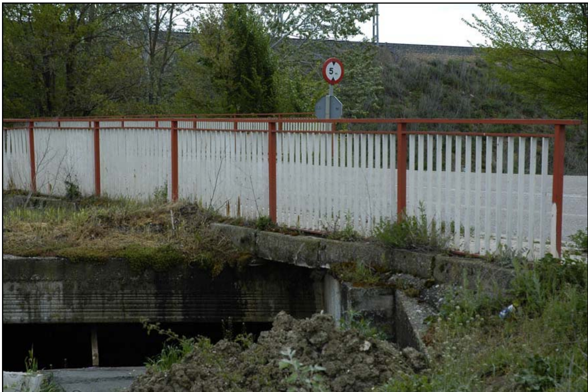
- FOTO 2 El Puente y la acequia.
