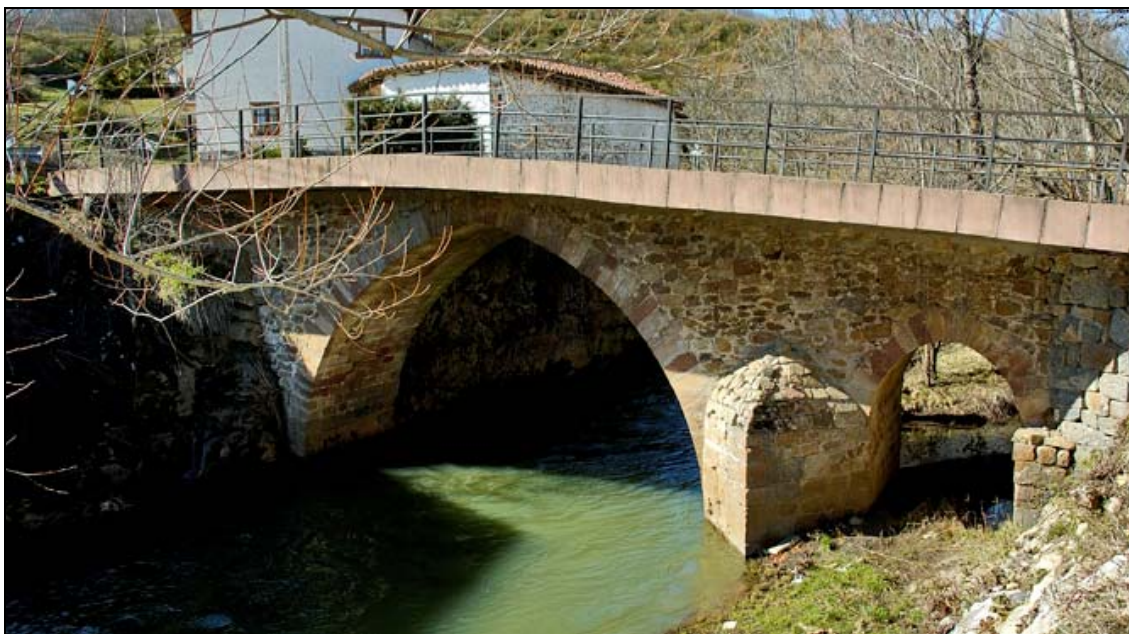
-FOTO 2 Vista general desde aguas abajo y la margen izquierda.
