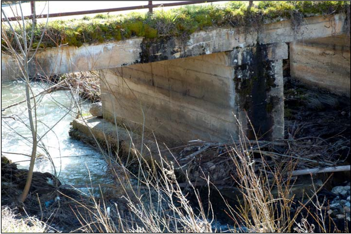
- FOTO 5 Detalle de la pilastra central.
