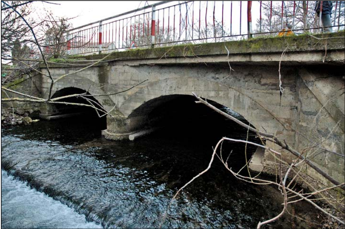
- FOTO 1 Los arcos del Puente.
