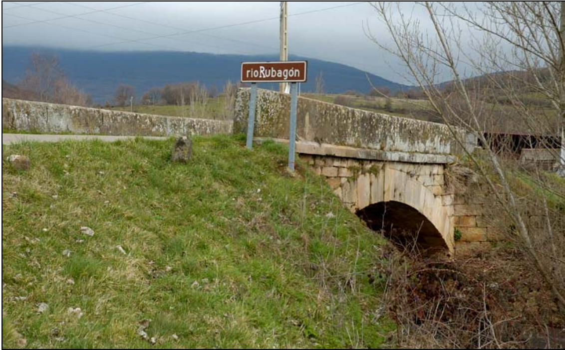
- FOTO 1 El Puente con el talud de uno de los laterales.
