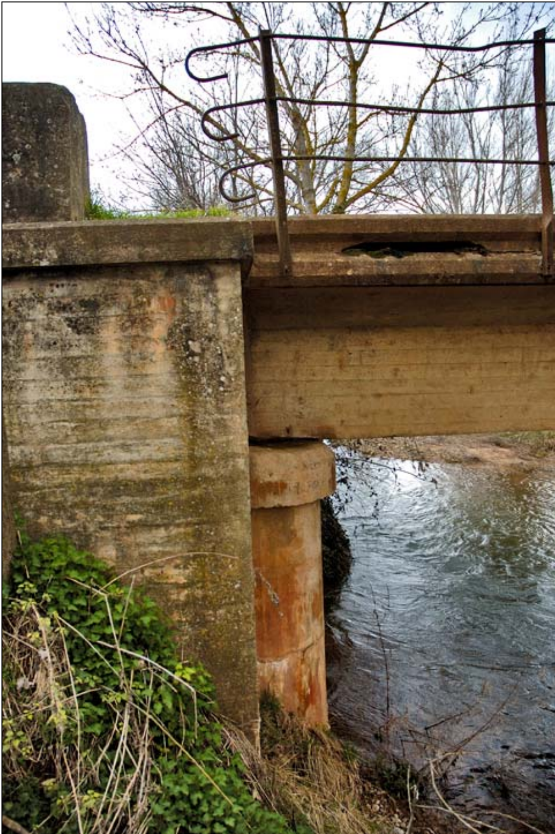
- FOTO 4 Detalle del estribo y de la viga.
