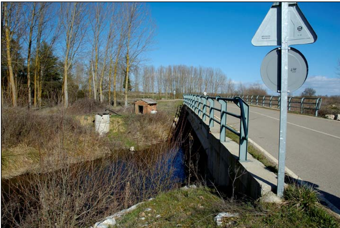
- FOTO 2 El Puente y el cauce.
