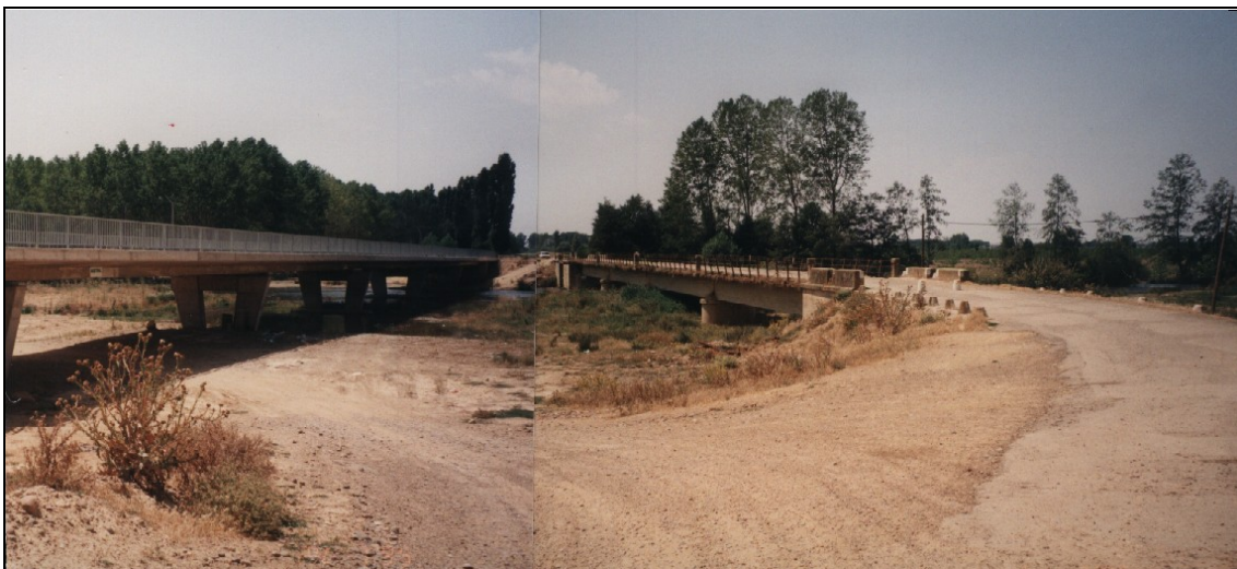
- FOTO 4 Vista general de los dos Puentes desde la margen izquierda.
