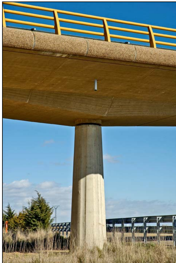
- FOTO 6 Detalle de una de las pilas con la losa apoyada.
