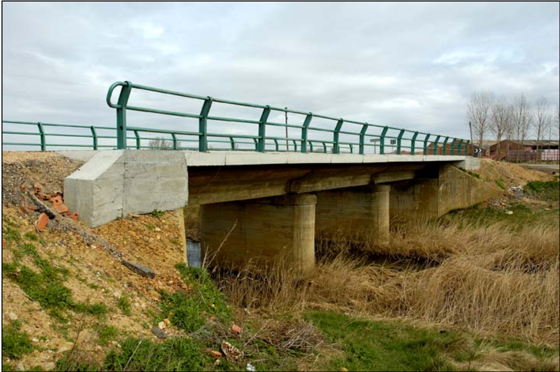
- FOTO 1 Vista del Puente.
