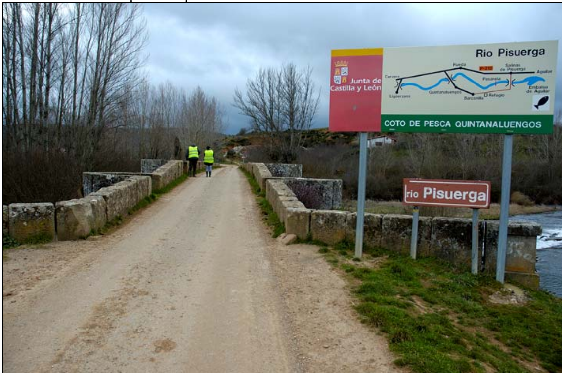
- FOTO 7 La planta del Puente.
