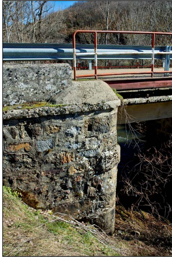
- FOTO 3 Estribo y barandilla.
