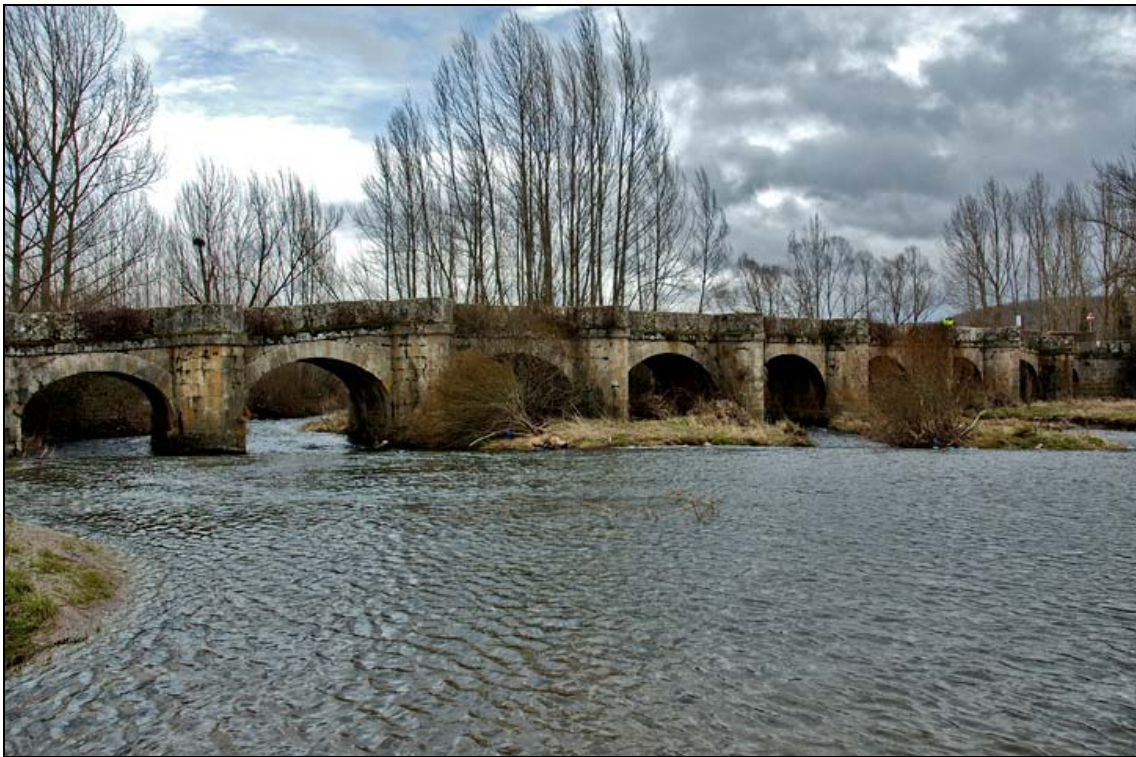
- FOTO 3 Vista del Puente desde aguas arriba y margen derecha.
