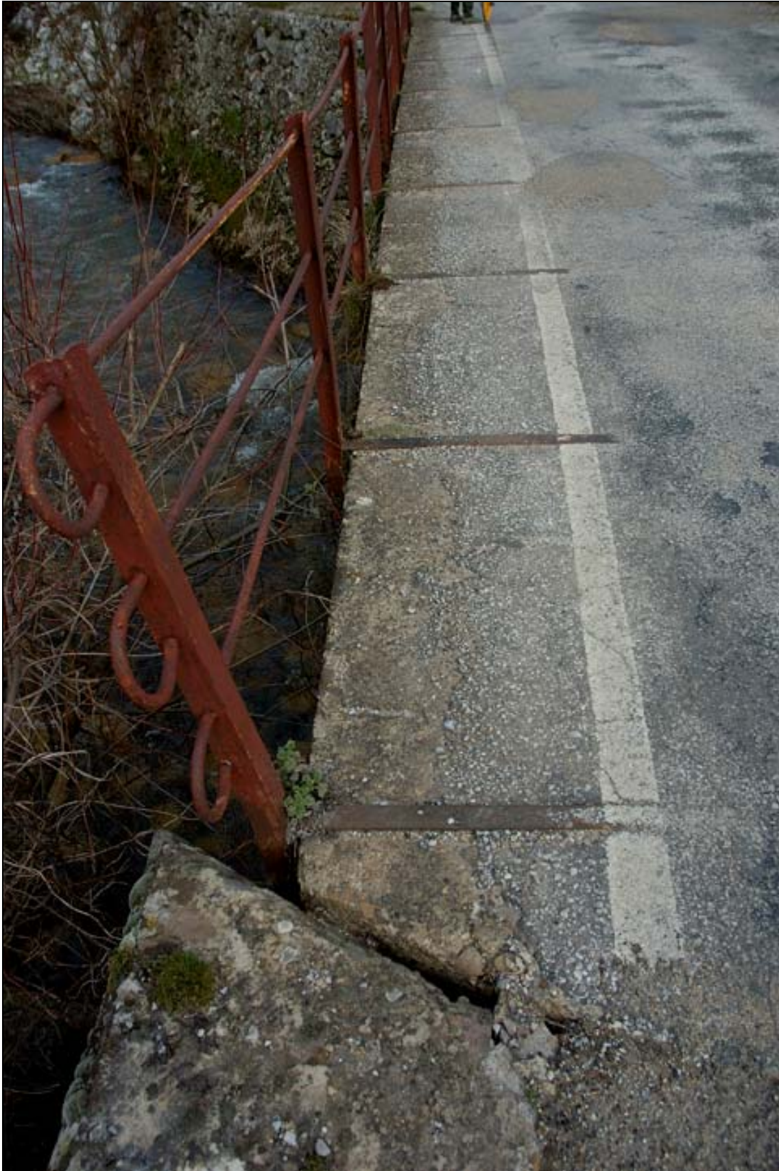
- FOTO 7 Detalle de la calzada.
