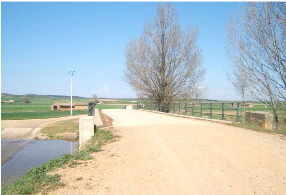
- FOTO 4 La carretera pasa por el Puente.
