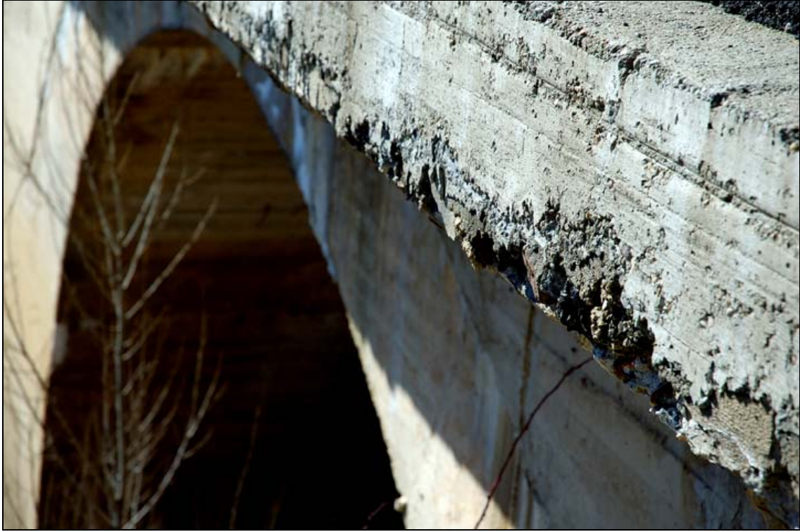
- FOTO 5 Detalle arco, plataforma.
