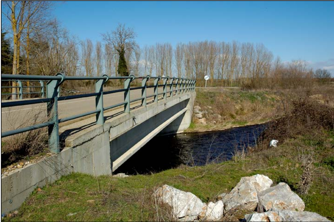
- FOTO 1 Vista del perfil y la barandilla metálica.
