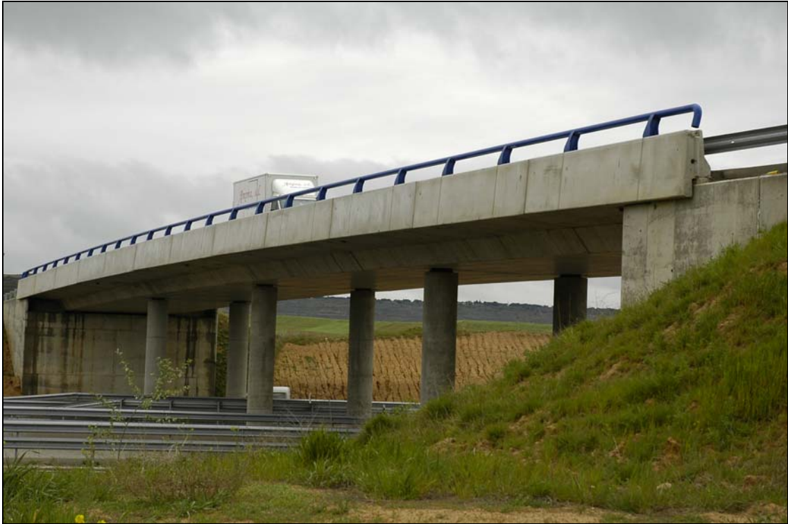
- FOTO 1 Vista del Puente.
