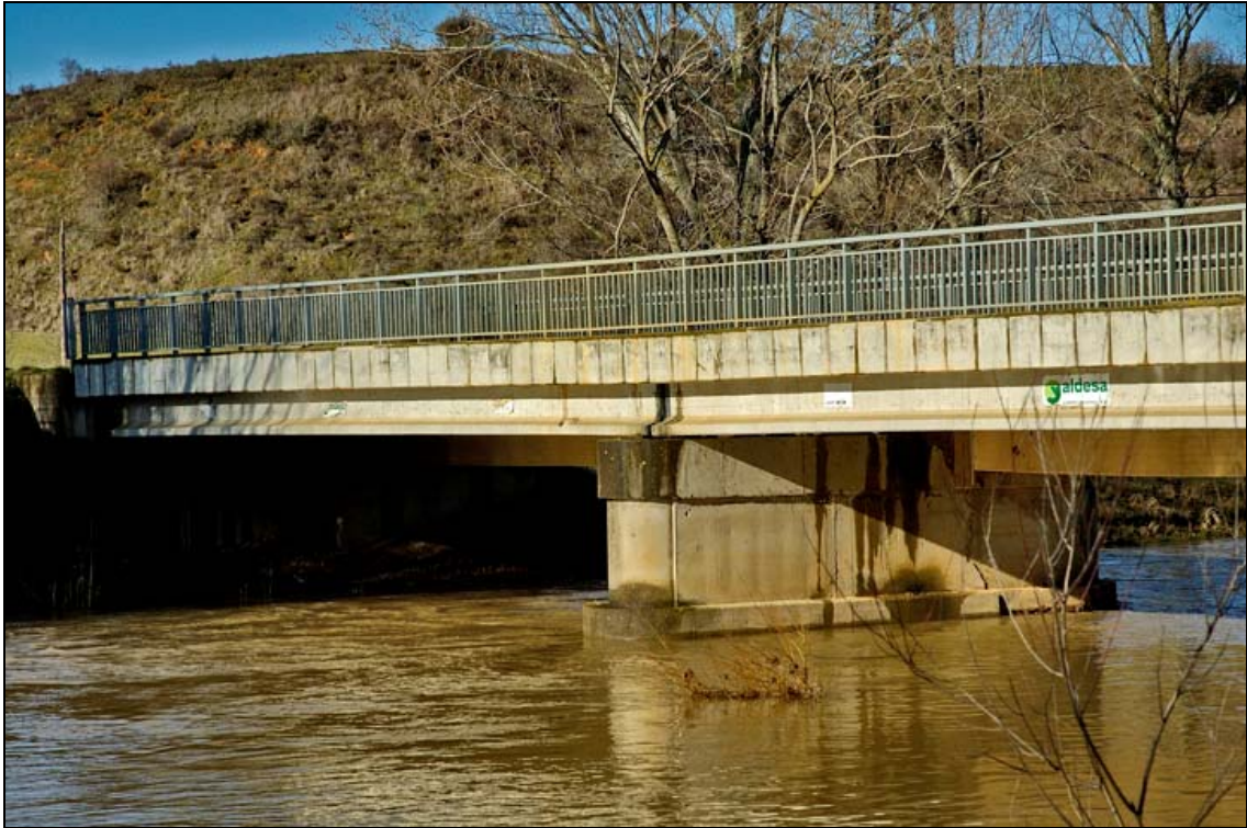
- FOTO 5 Puente con barandilla.
