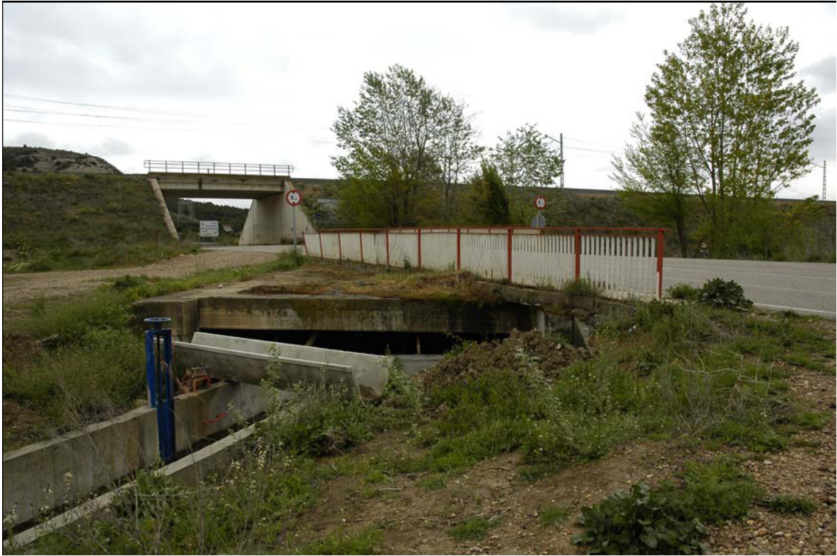
- FOTO 1 Vista del Puente.
