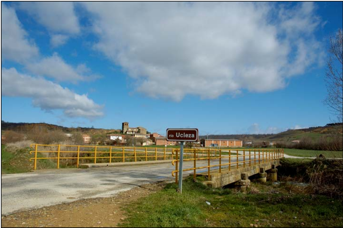
- FOTO 4 Vista de la calzada del Puente.
