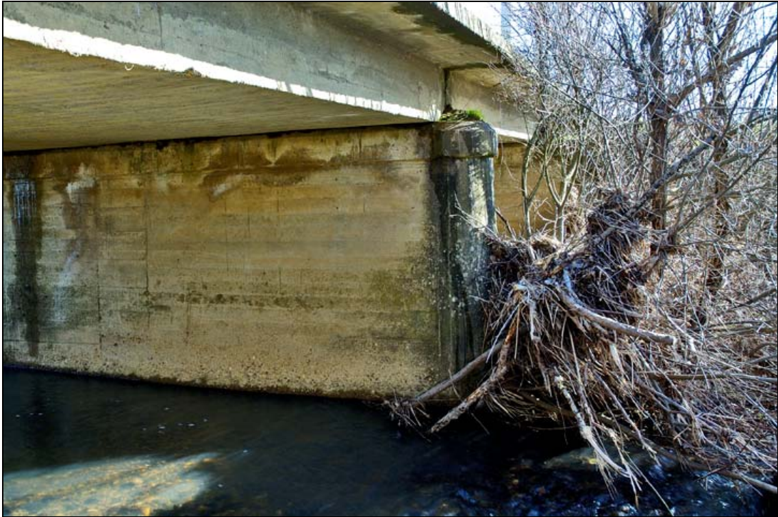
- FOTO 4 Detalle de la ampliación.
