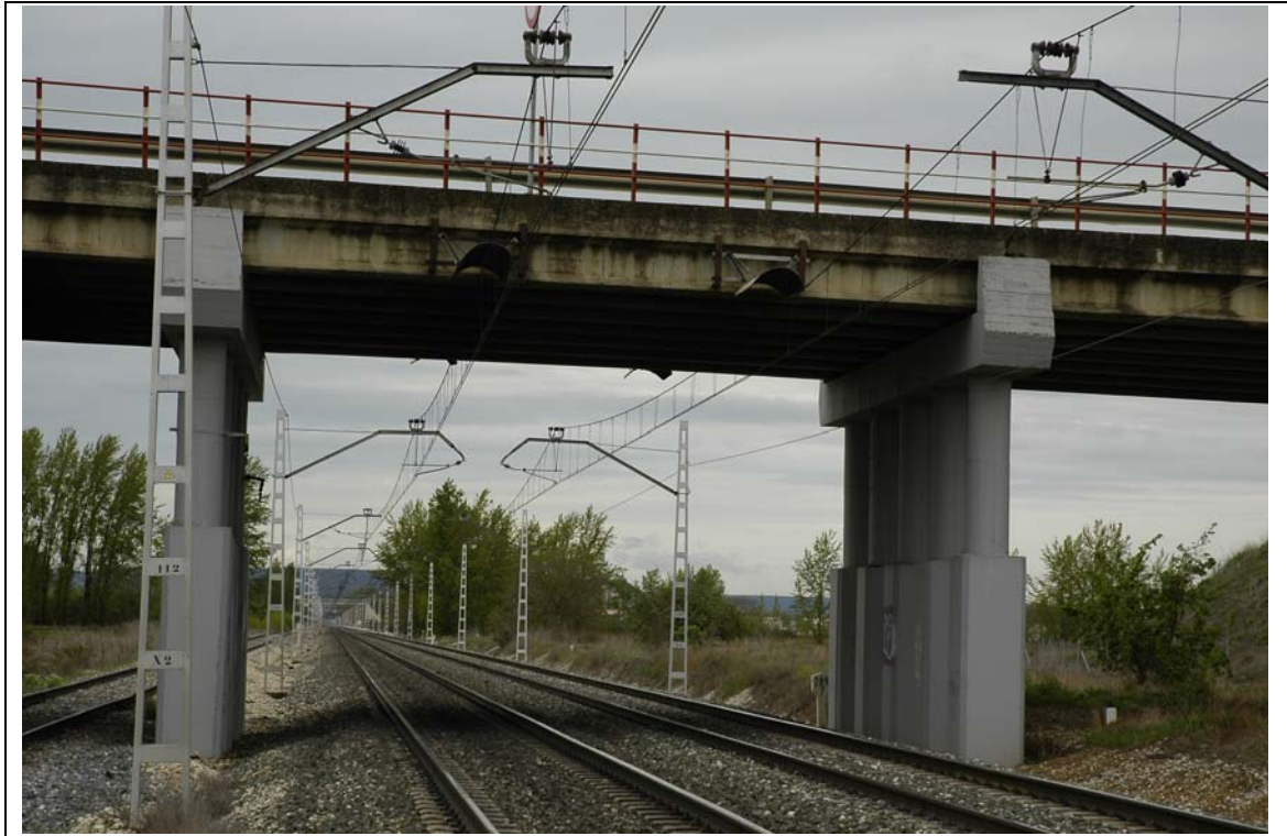
- FOTO 1 Vista del Puente.
