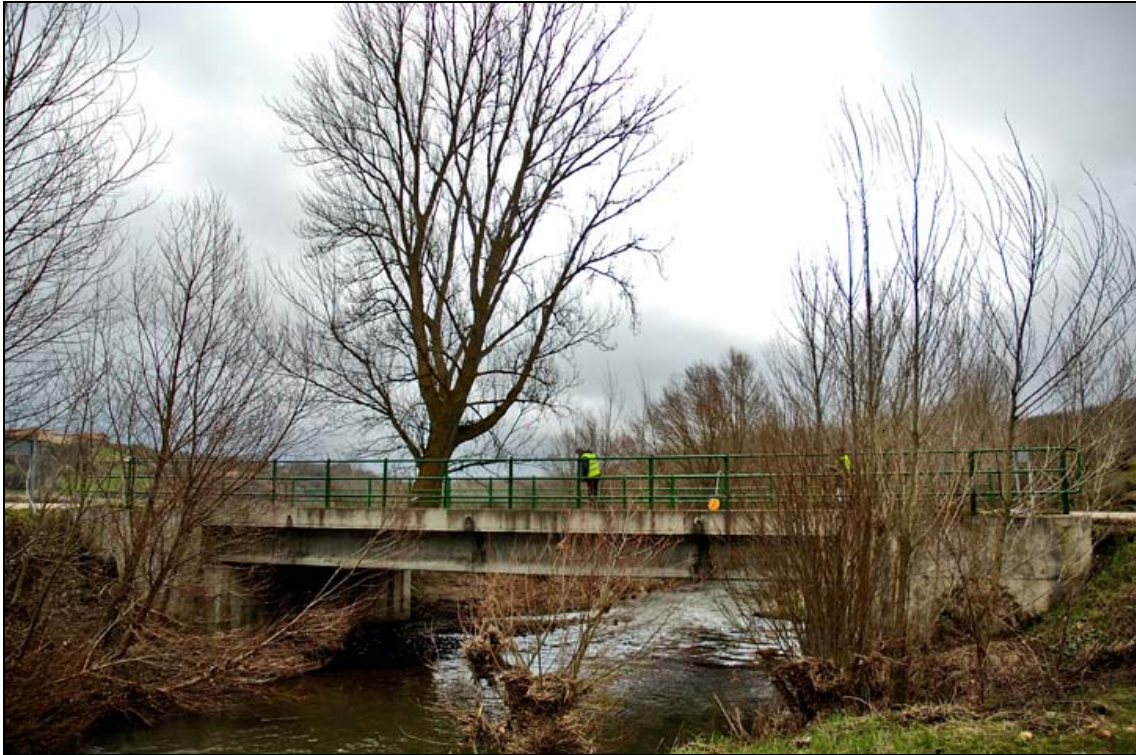
- FOTO 4 Vista general del Puente y su entorno.
