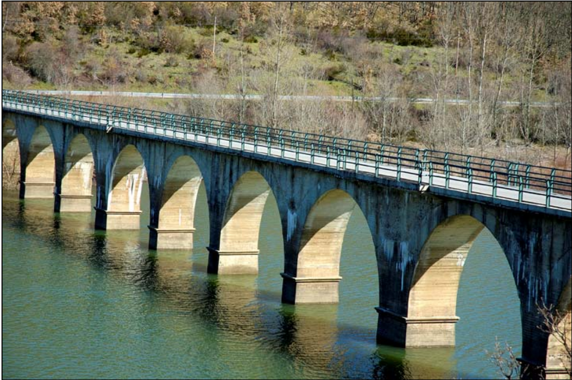
- FOTO 7 Vista parcial del Puente.
