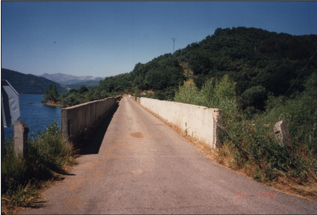
- FOTO 3 Vista de la planta desde la margen izquierda.
