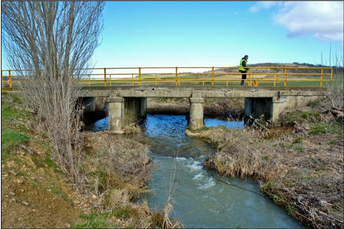
- FOTO 1 Vista general del Puente y del río.
