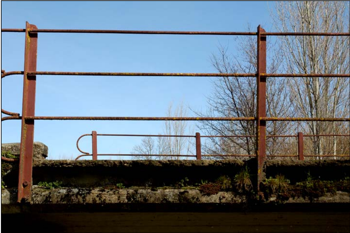
- FOTO 3 Detalle de la barandilla.
