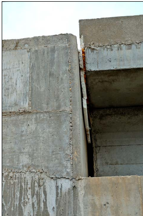
- FOTO 4 Detalle de apoyo de una de las vigas.
