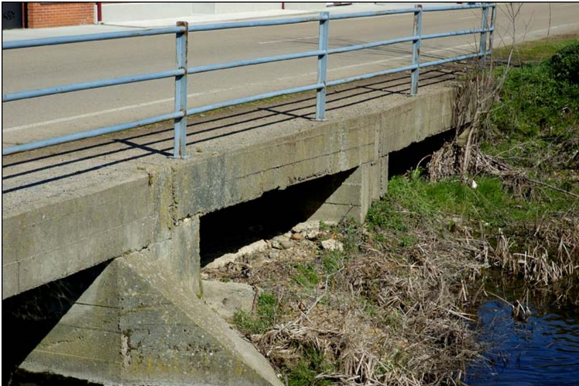
- FOTO 2 Detalle de la barandilla.
