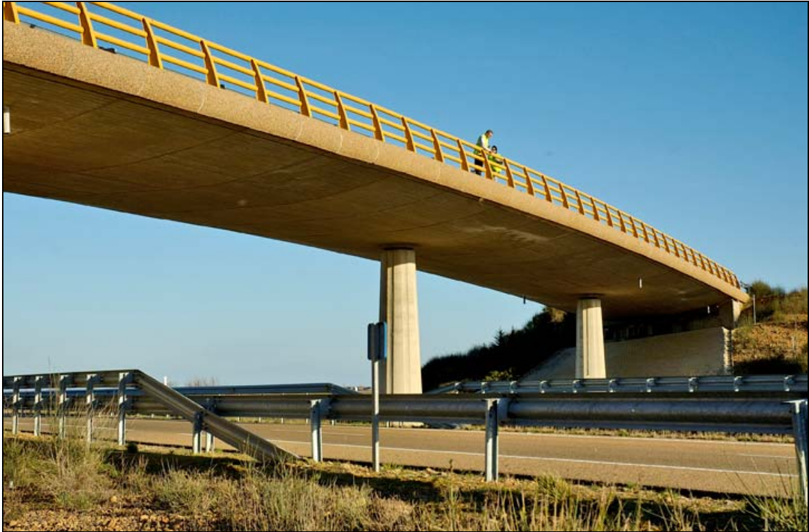
- FOTO 1 Vista general del Puente.
