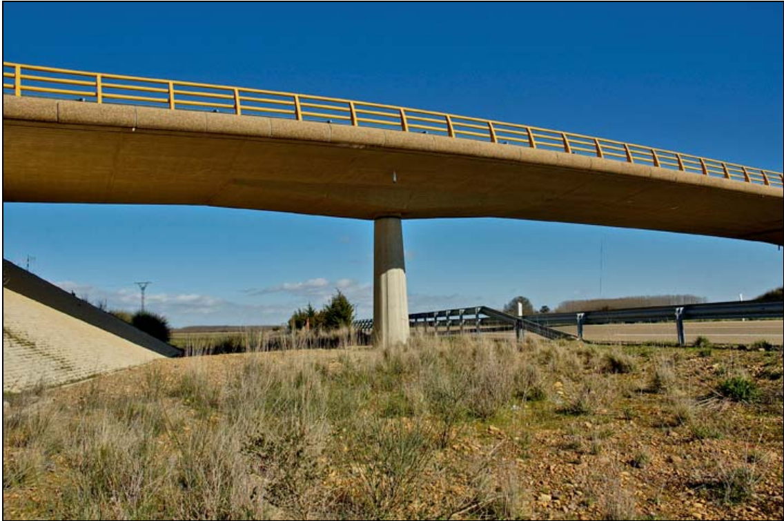
- FOTO 1 La estructura salta por encima de la autovía.
