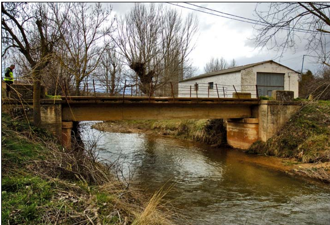
- FOTO 1 Vista del Puente.
