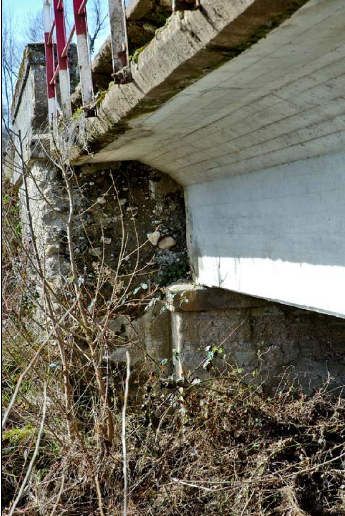
- FOTO 3 Detalle de la viga apoyada.
