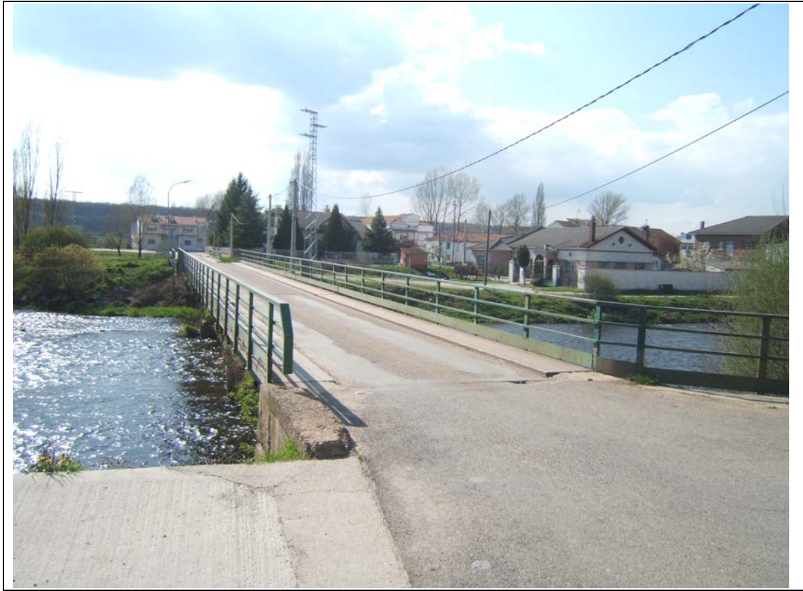
- FOTO 5 La planta de la calzada del Puente.
