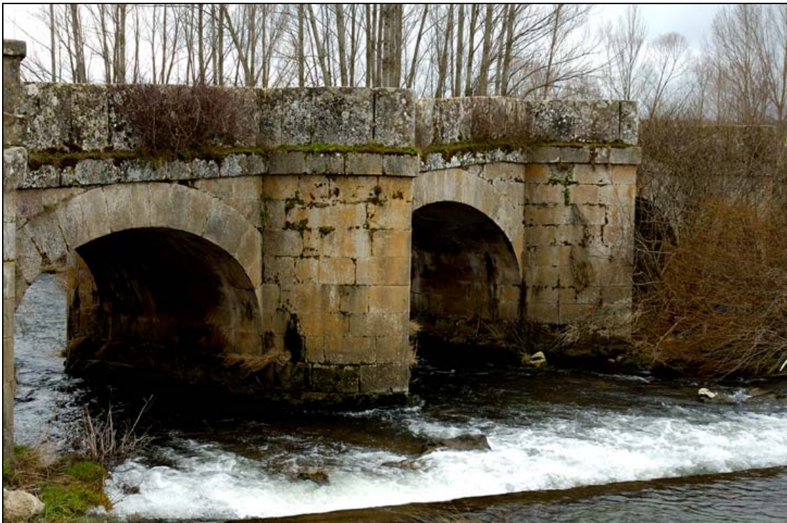
- FOTO 5 Vista parcial del Puente, desde aguas arriba y margen derecha.
