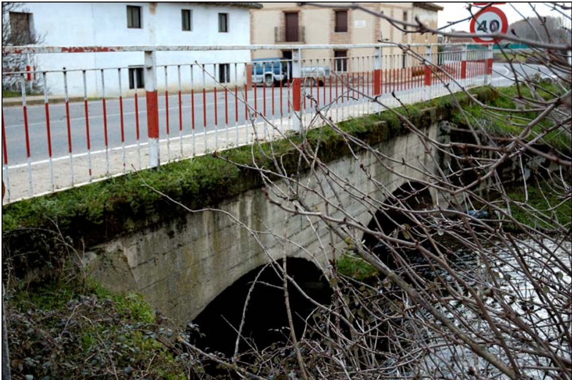
- FOTO 2 La barandilla del Puente.
