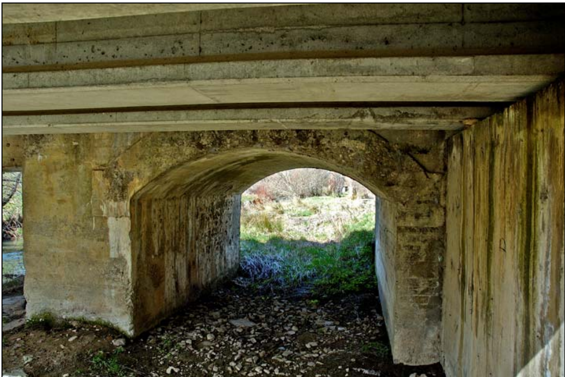
- FOTO 6 Detalle del arco.
