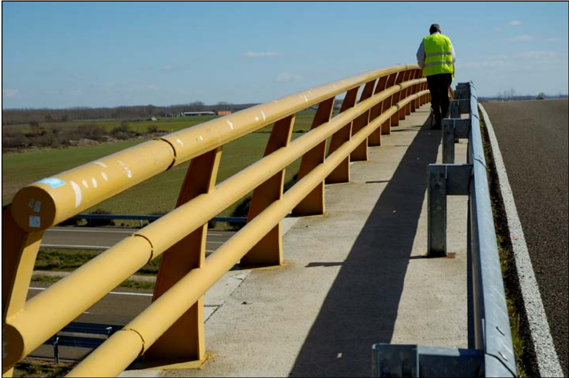
- FOTO 5 Acera. Detalle.
