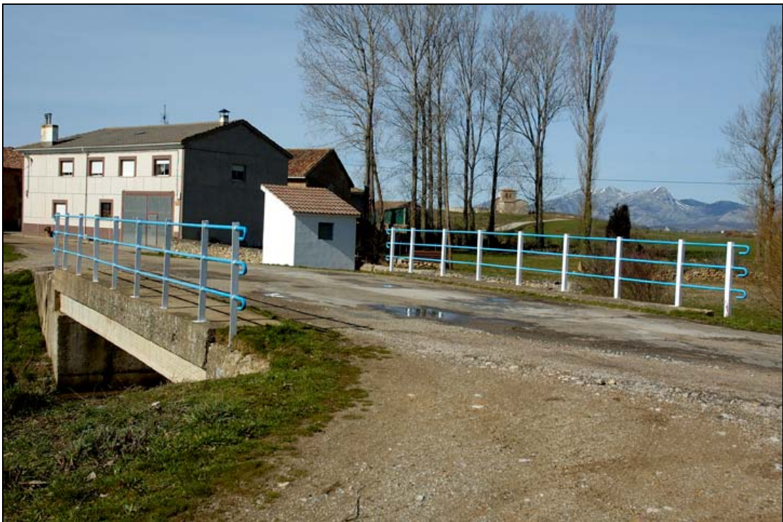
- FOTO 4 Detalle de la calzada y la barandilla.
