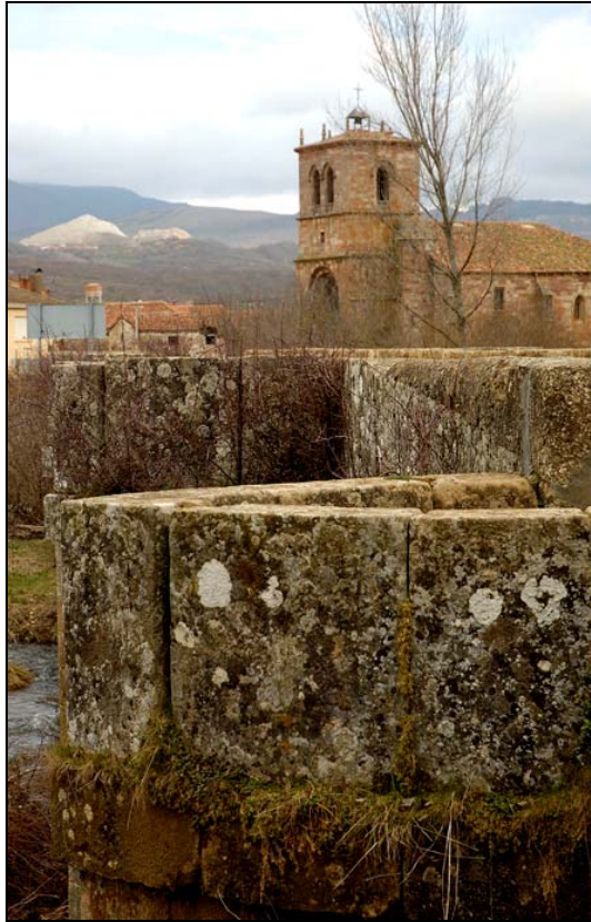
- FOTO 4 Detalle tajamar, con la Iglesia de San Pelayo al fondo.
