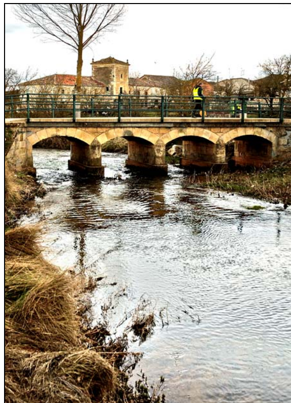
- FOTO 2 Vista general del Puente aguas abajo.
