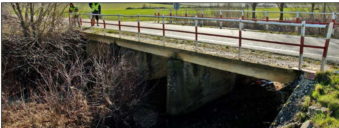
- FOTO 1 Vista general del Puente.
