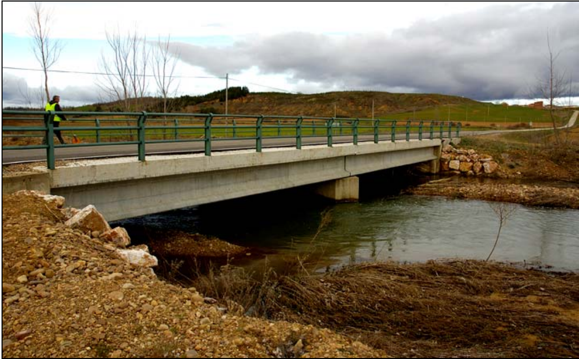
- FOTO 1 Vista de general del Puente y su entorno.
