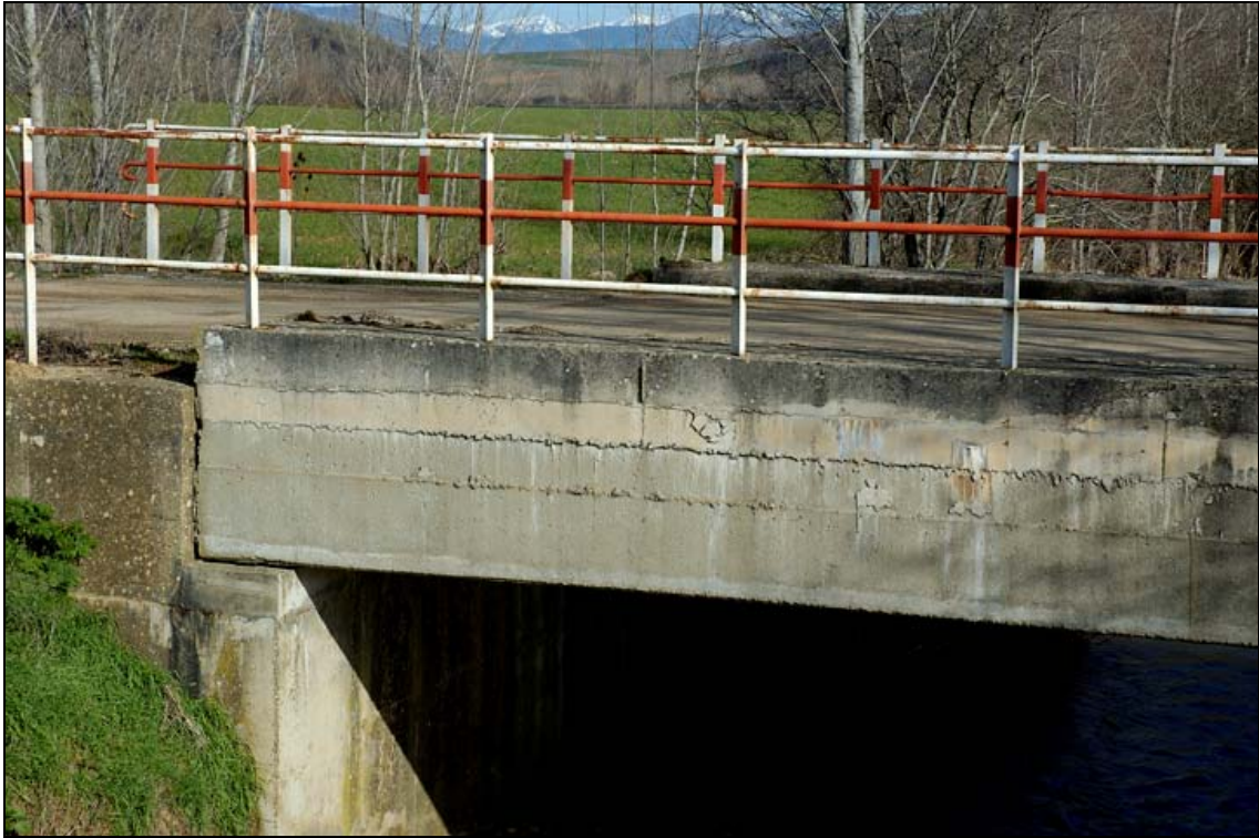
- FOTO 5 Tablero y barandilla.
