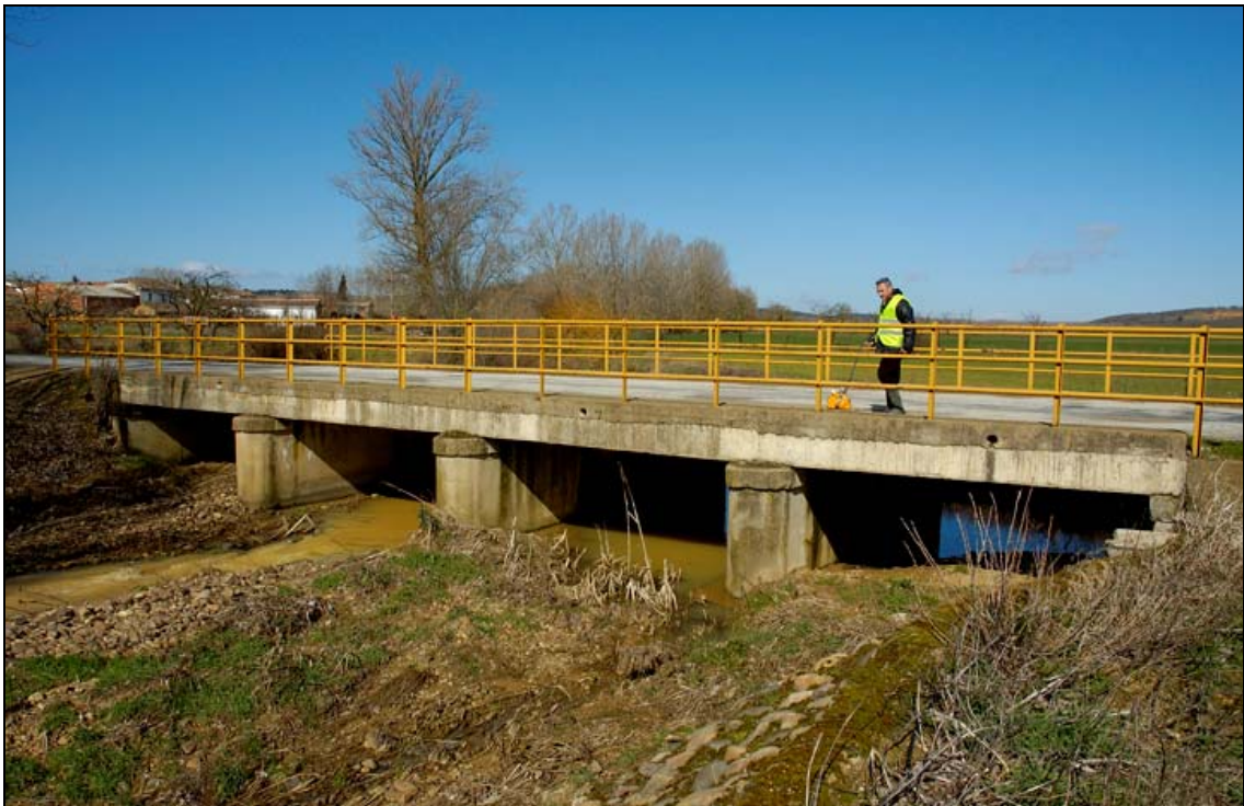
- FOTO 2 El perfil del Puente.
