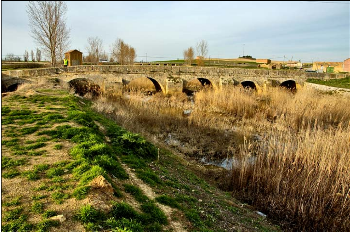
- FOTO 1 Vista del Puente y del río.
