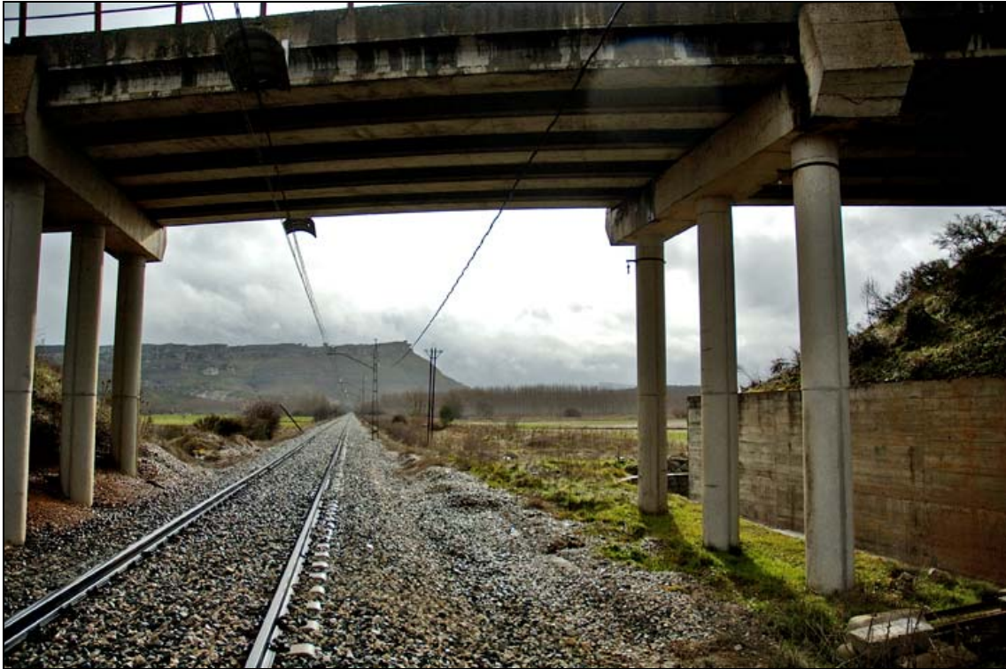
- FOTO 2 Vista frontal de la estructura: pilas, dinteles y vigas.
