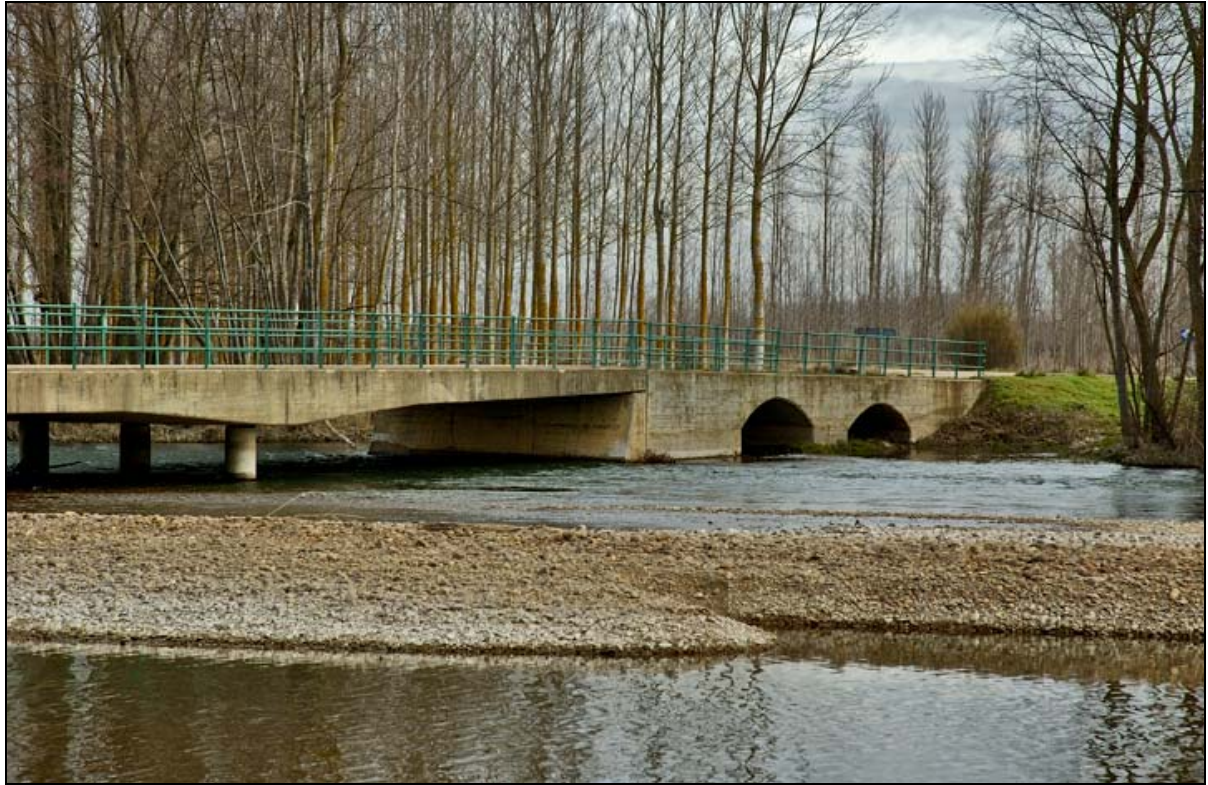
- FOTO 6 Arcos de estribo y losa.
