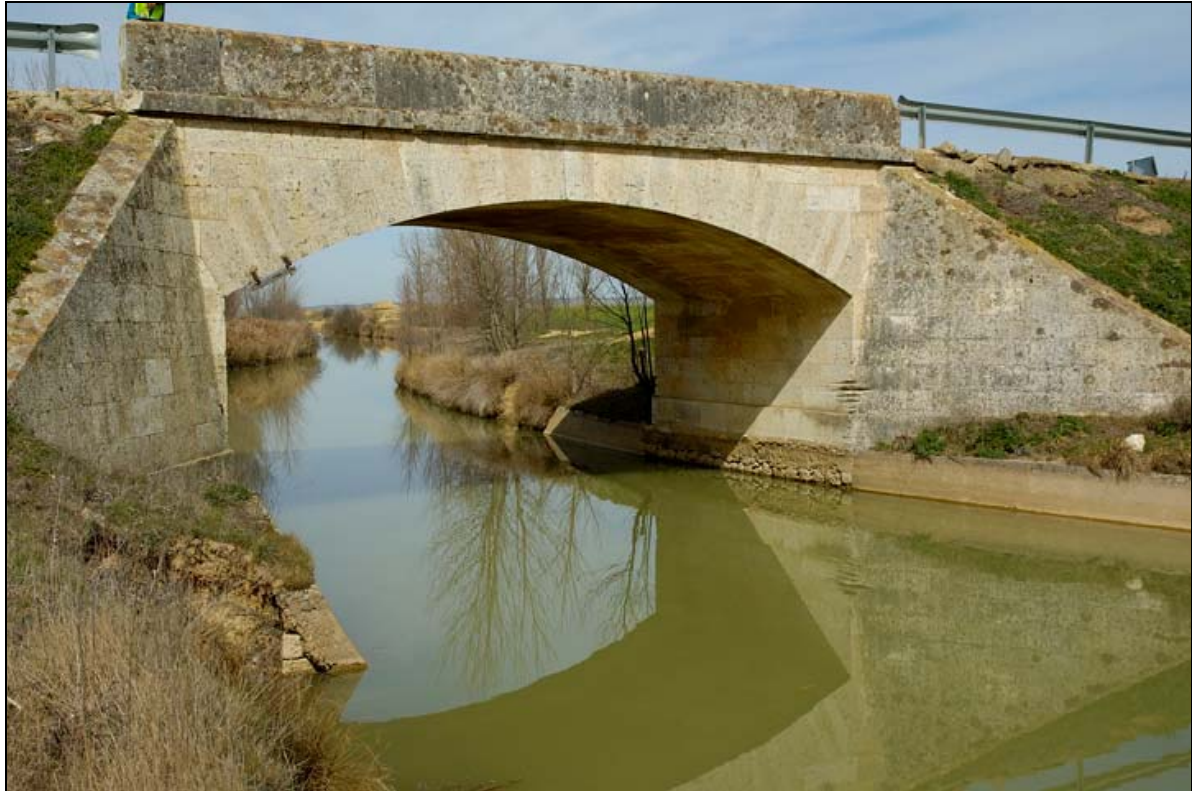
- FOTO 1 Vista frontal del arco, aletas y pretil.
