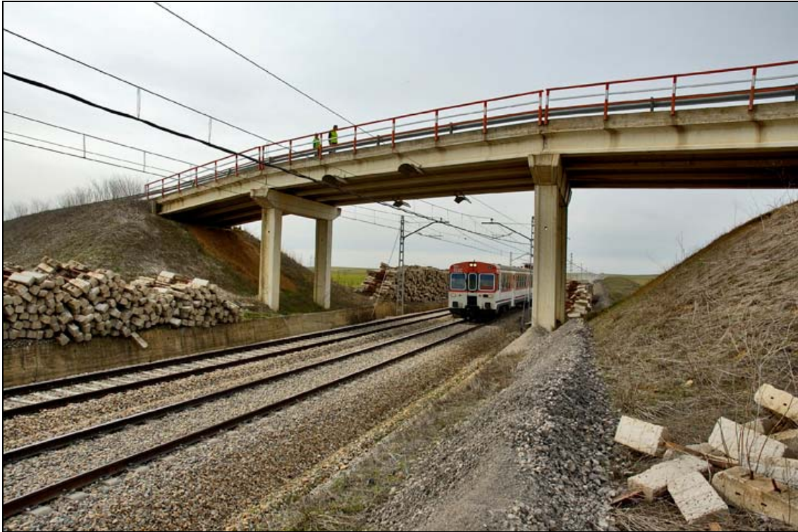
- FOTO 1 Vista general del Puente y el ferrocarril.
