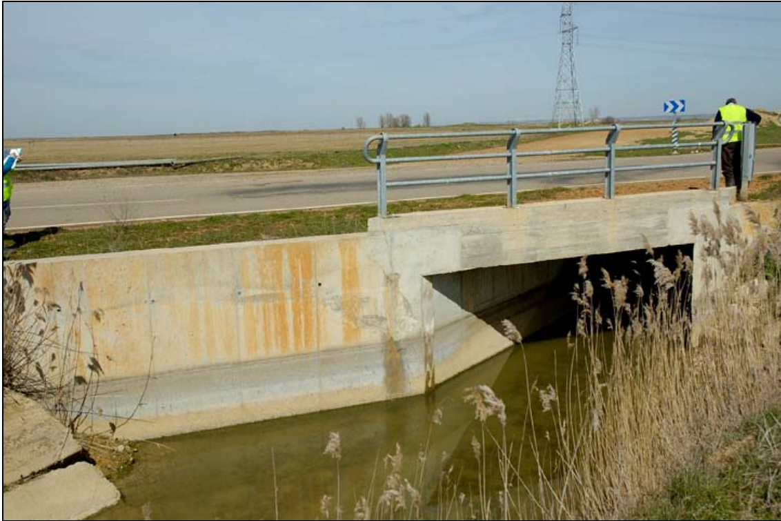
- FOTO 3 Detalle del estribo, losa y barandilla.
