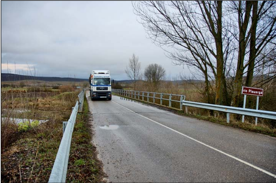
- FOTO 5 Planta desde margen derecha.
