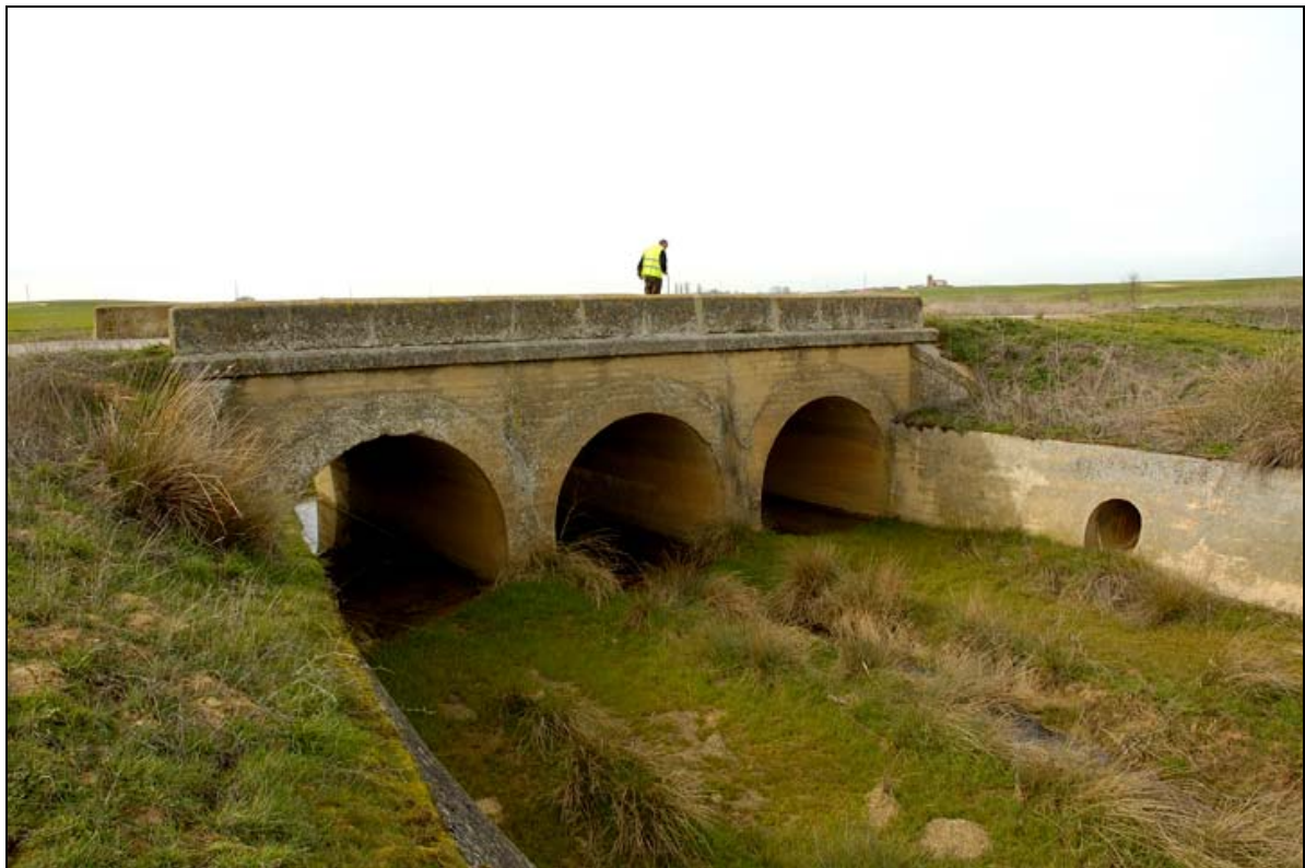
- FOTO 4 El Puente y el arroyo, canalizado.
