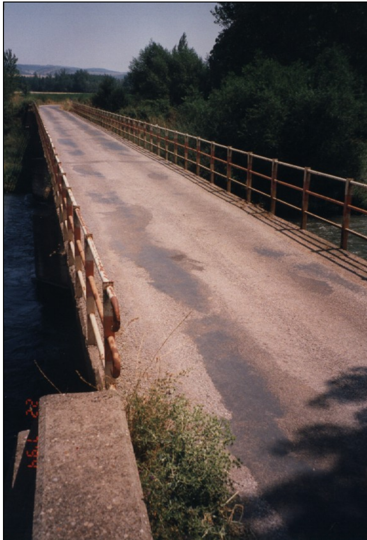
- FOTO 2 Planta desde la margen derecha.
