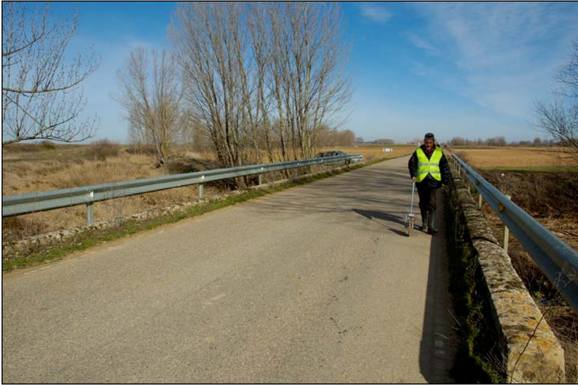
- FOTO 9 Vista de la calzada del Puente.
