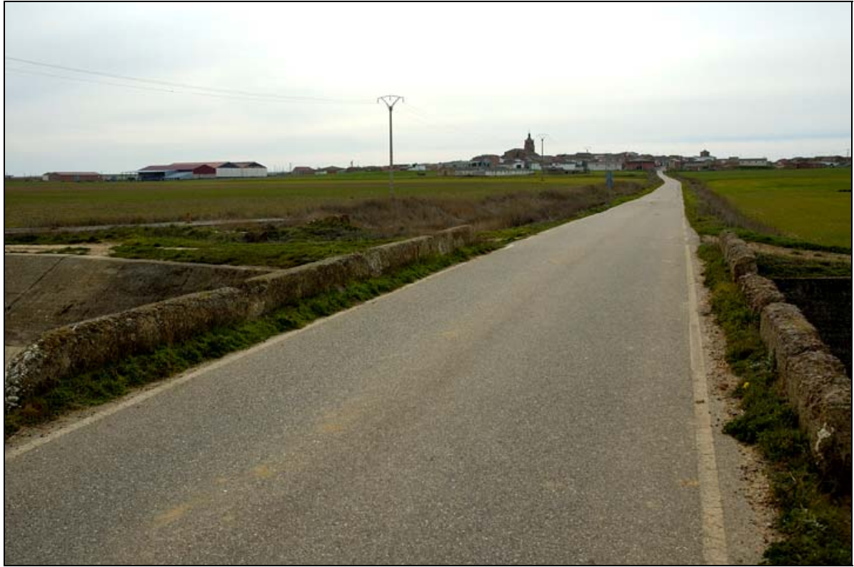
- FOTO 6 La calzada del Puente.
