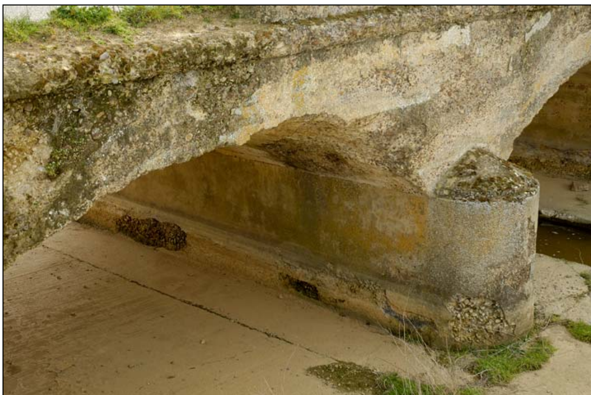
- FOTO 5 Detalle de la bóveda de uno de los arcos.
