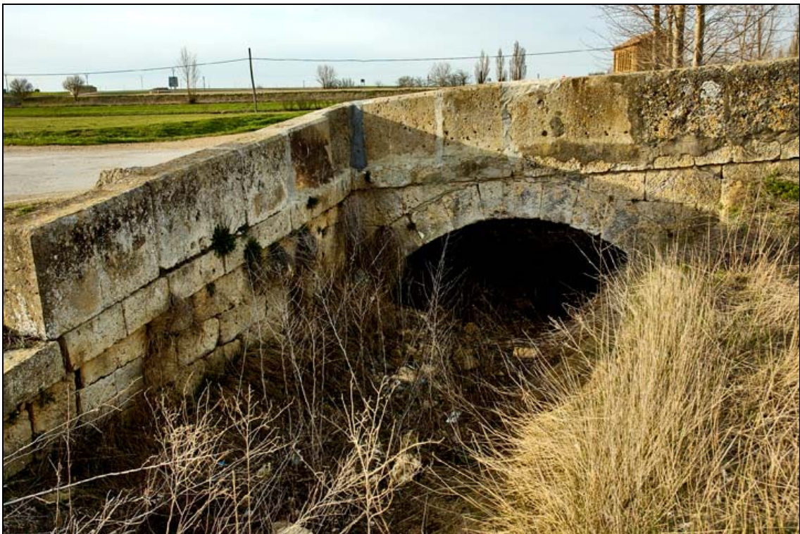
- FOTO 4 Detalle de uno de los estribos y uno de los arcos.
