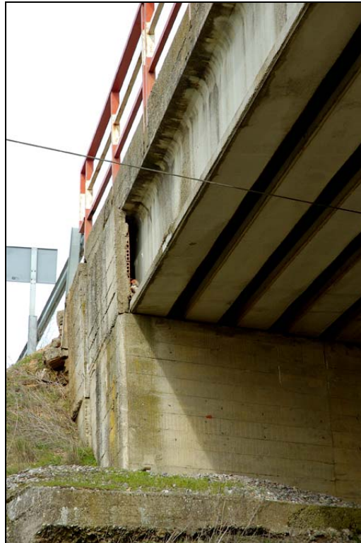
- FOTO 3 Detalle de barandilla-viga-estribo.
