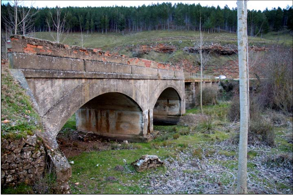
- FOTO 5 Arcos desde aguas arriba.
