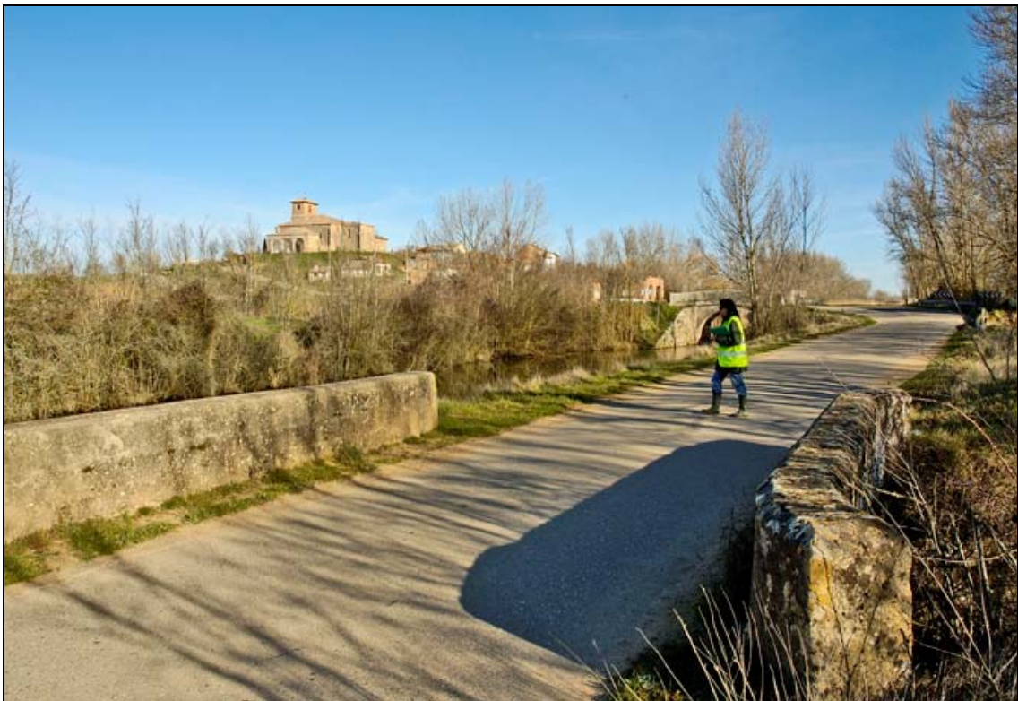
- FOTO 2 Vista de la calzada.
