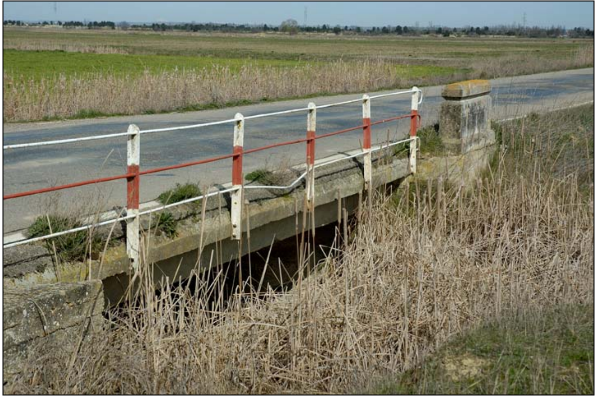
- FOTO 2 La barandilla metálica.
