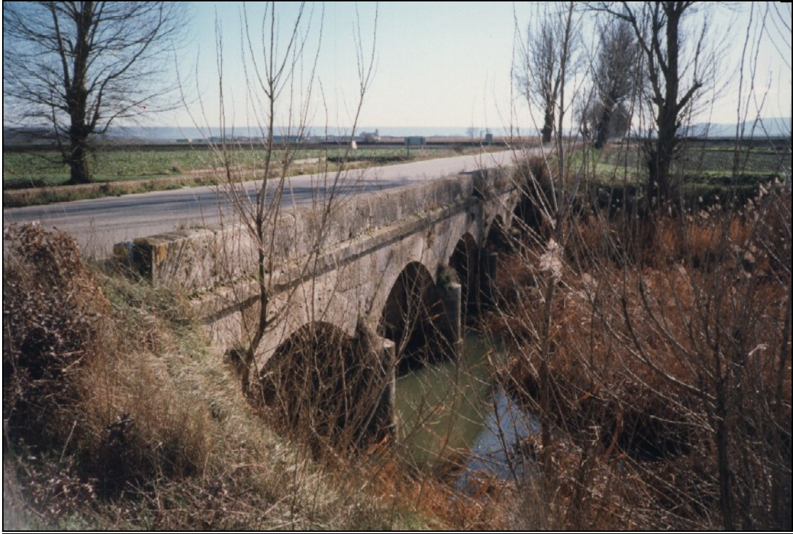
- FOTO 1 Vista desde aguas abajo.
