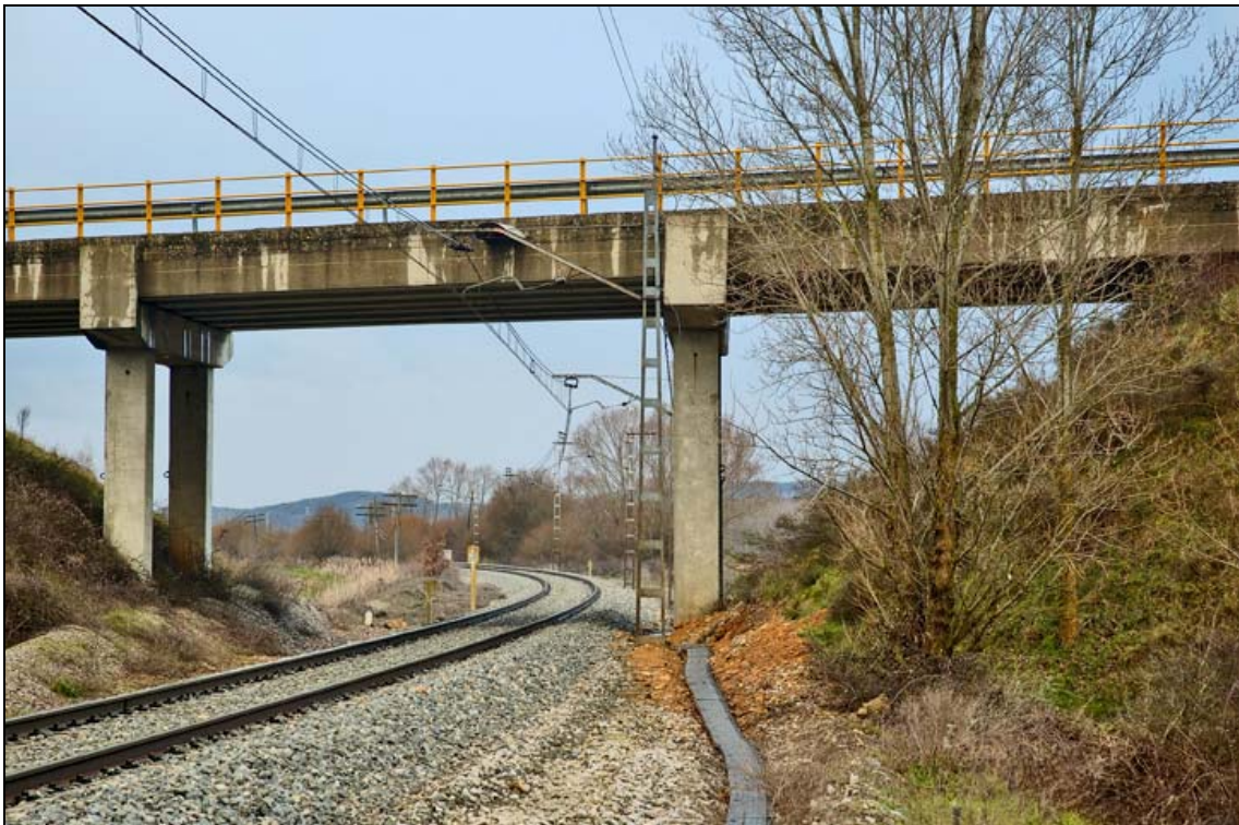
- FOTO 2 Vista frontal de la estructura.
