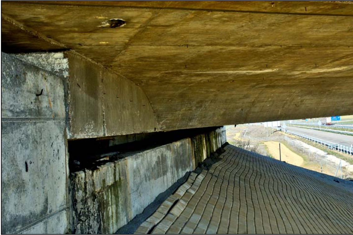
- FOTO 3 Detalle del uno de los estribos.
