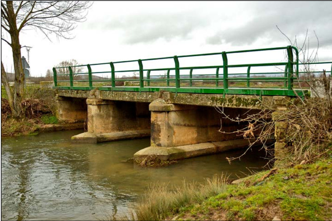
- FOTO 3 Las pilastras, la losa y la barandilla.
