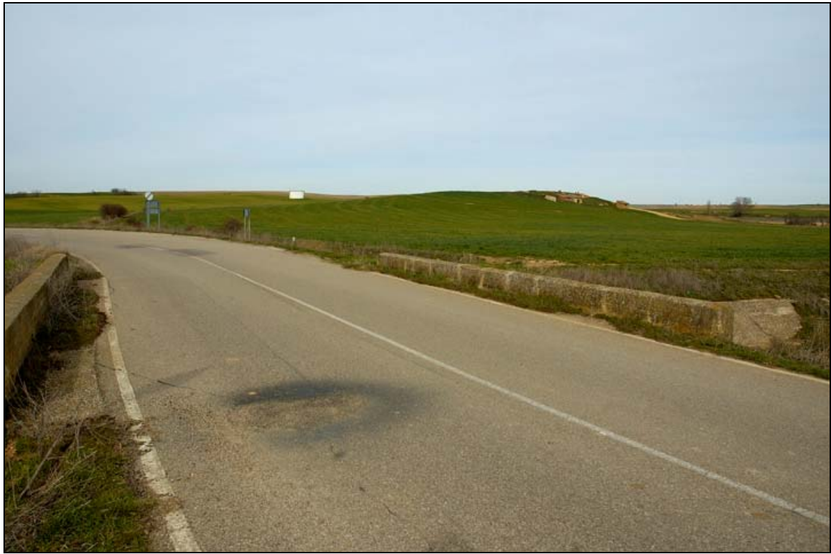
- FOTO 5 La planta del Puente.
