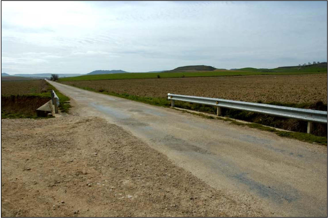
- FOTO 3 La calzada de la carretera pasa por el Puente.
