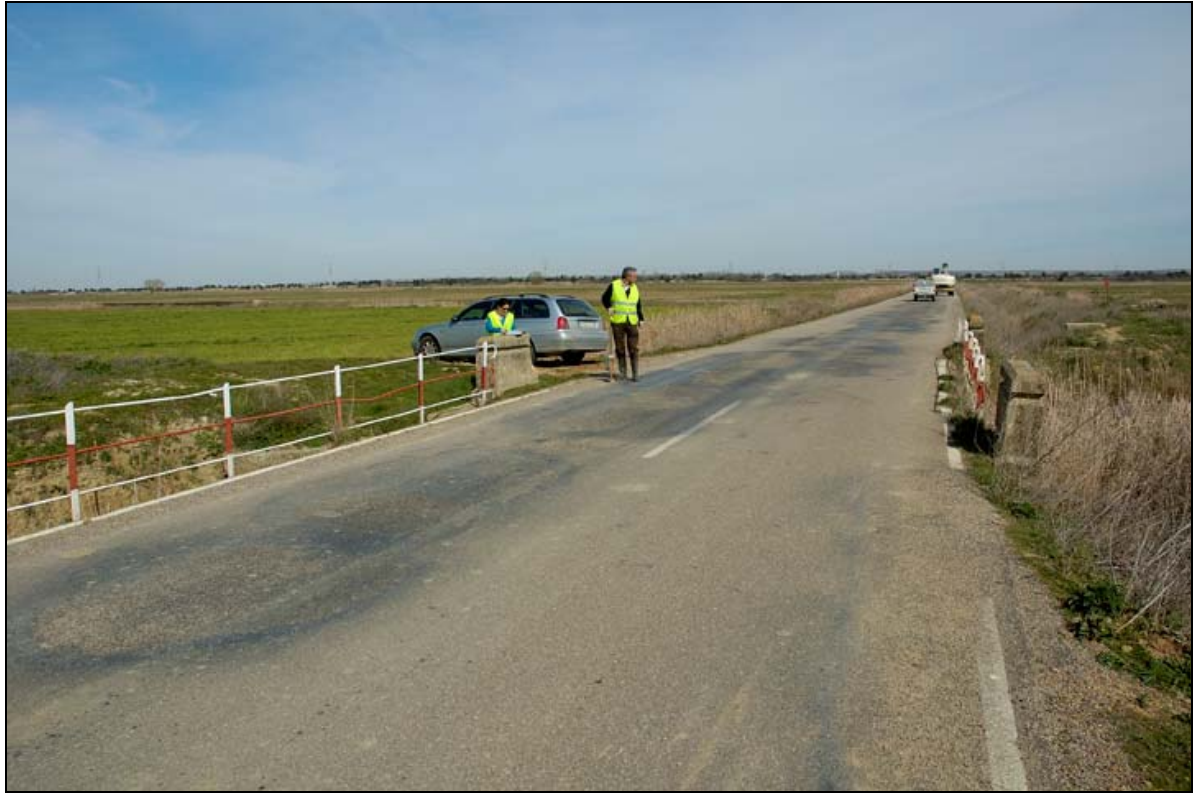
- FOTO 4 La calzada del Puente.
