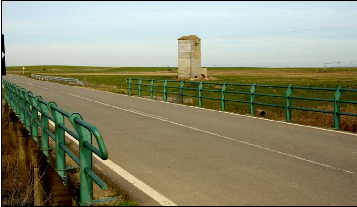
- FOTO 5 La calzada de la planta del Puente.
