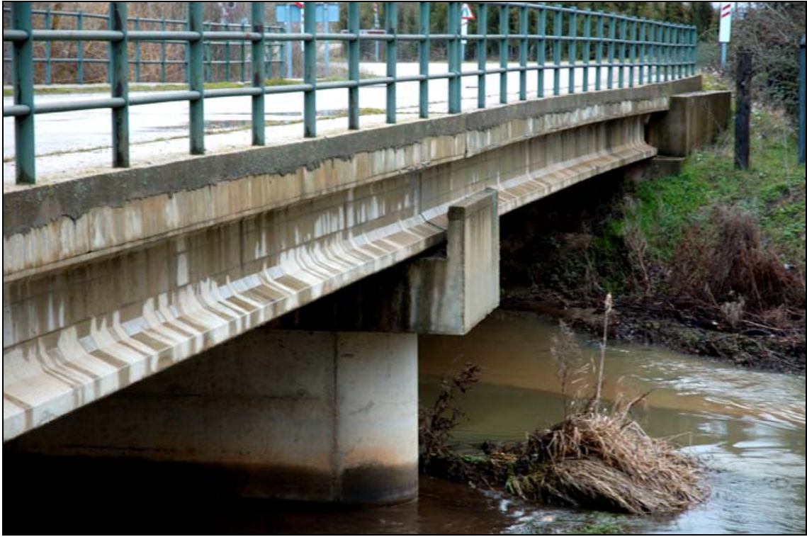
- FOTO 8 Detalle pila.
