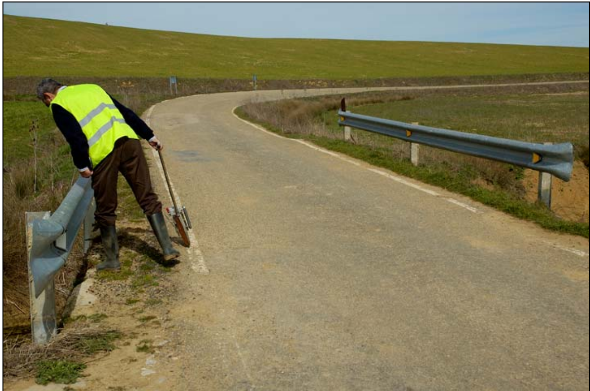
- FOTO 2 La calzada.
