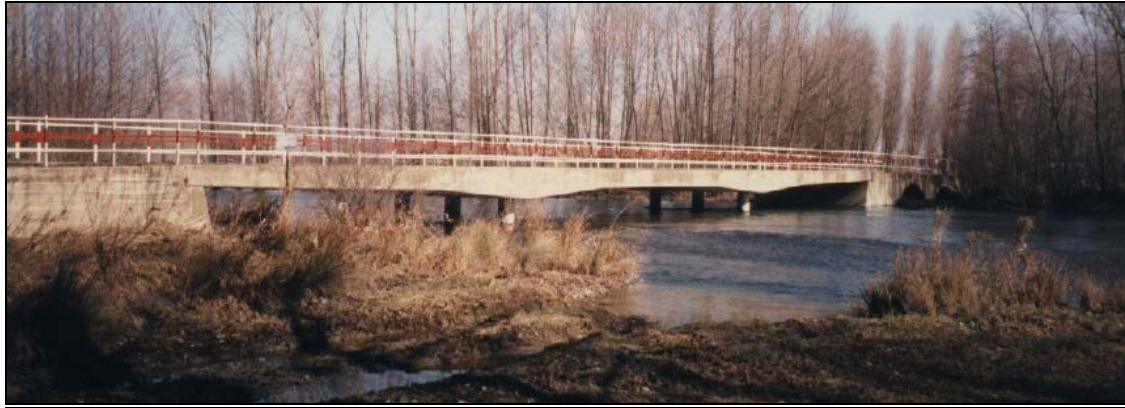
- FOTO 1 Vista desde aguas abajo.
