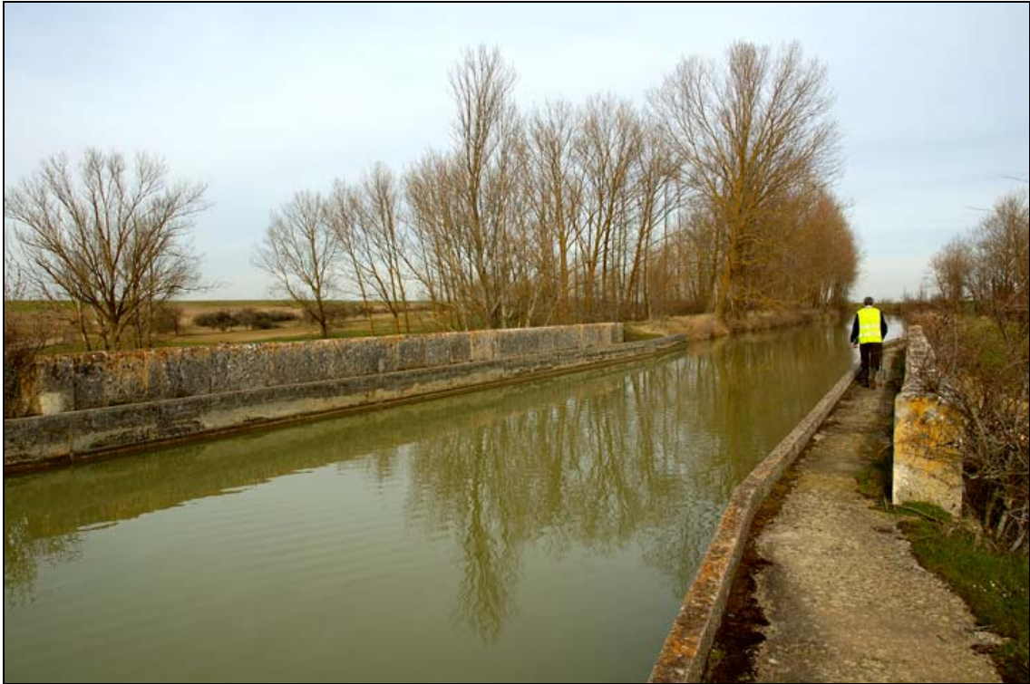
- FOTO 7 “Agua sobre agua”: La planta del acueducto, con el agua del Canal de Castilla, sobre el río Valdeginete.
