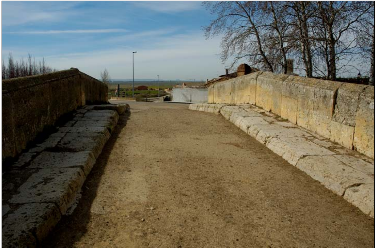
- FOTO 6 La calzada, las aceras y el pretil.
