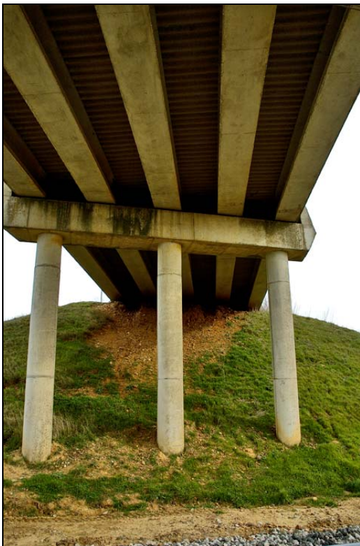
- FOTO 4 Pilas, dintel y vigas.
