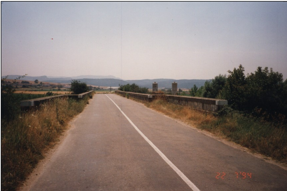
- FOTO 2 Planta desde la margen derecha.
