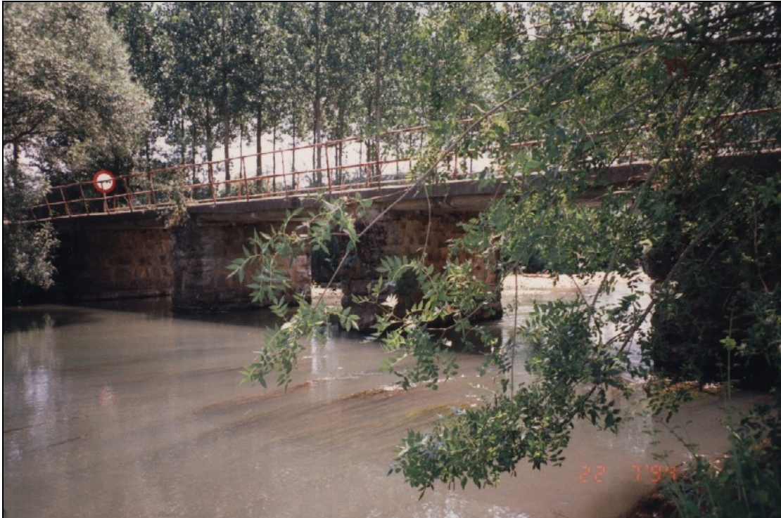
- FOTO 4 El Puente visto desde aguas arriba y la margen derecha. De la visita realizada el 23 de febrero de 2007:
