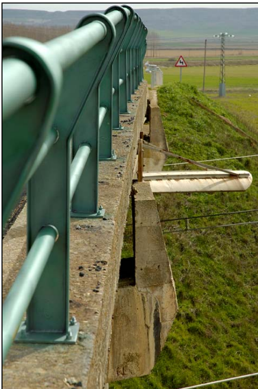
- FOTO 2 Detalle de la barandilla.
