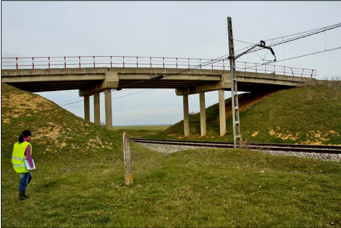
- FOTO 3 Vista frontal de la estructura.
