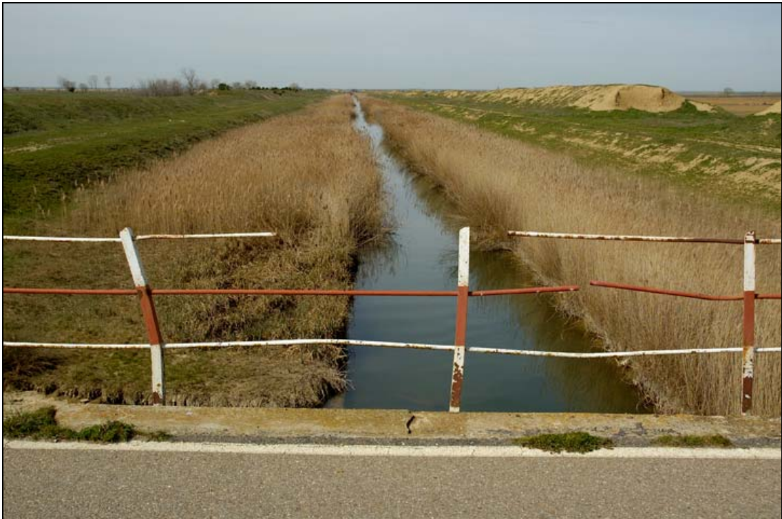
- FOTO 2 Detalle de la barandilla.
