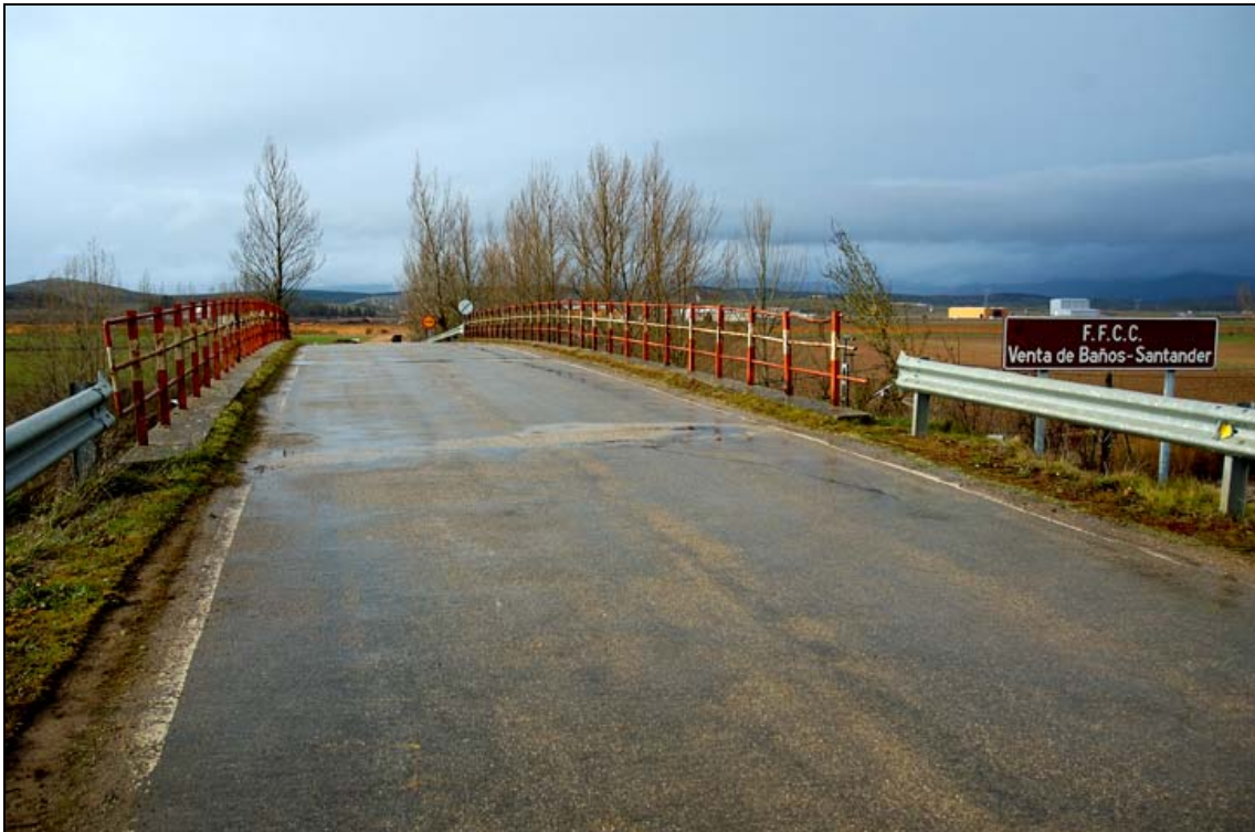
- FOTO 5 La calzada del Puente.
