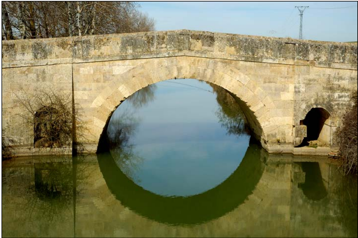
- FOTO 3 El Puente: arco, arquillos y pretil.
