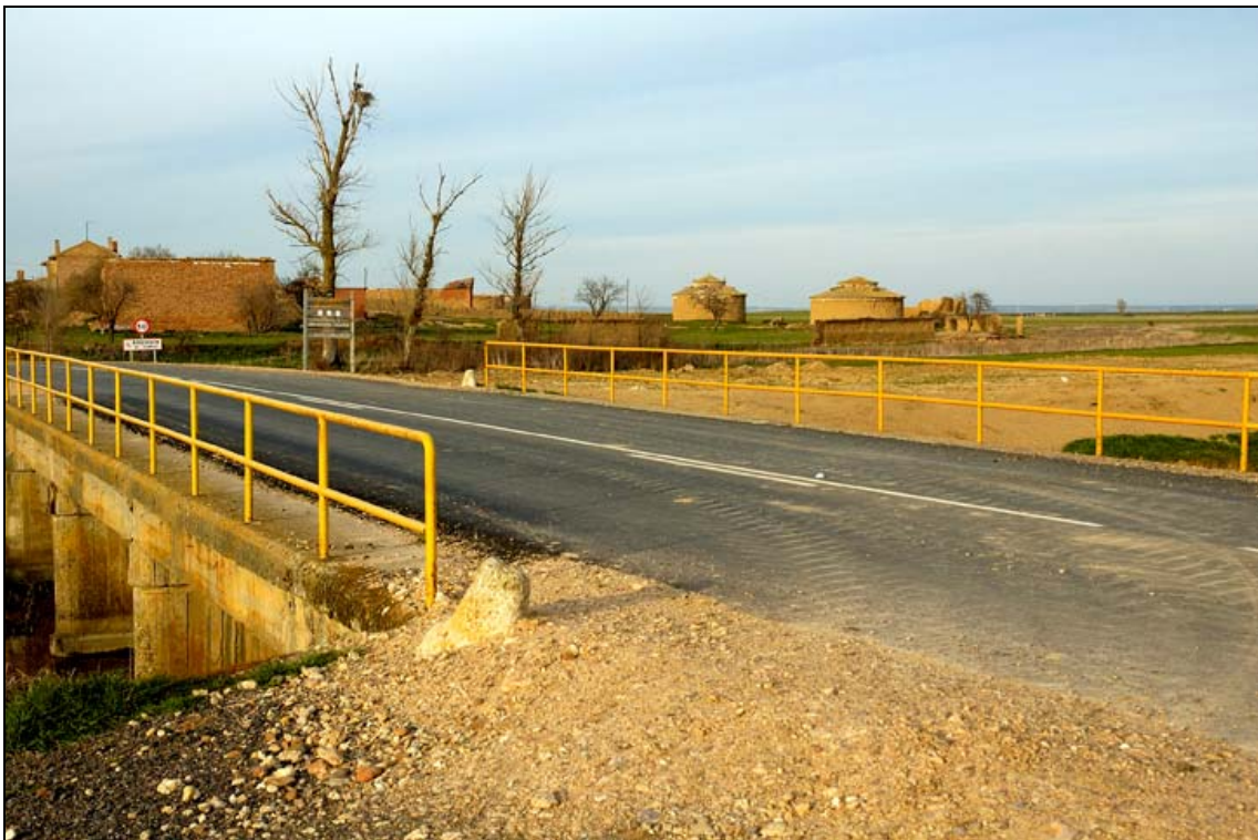
- FOTO 6 La calzada del Puente.
