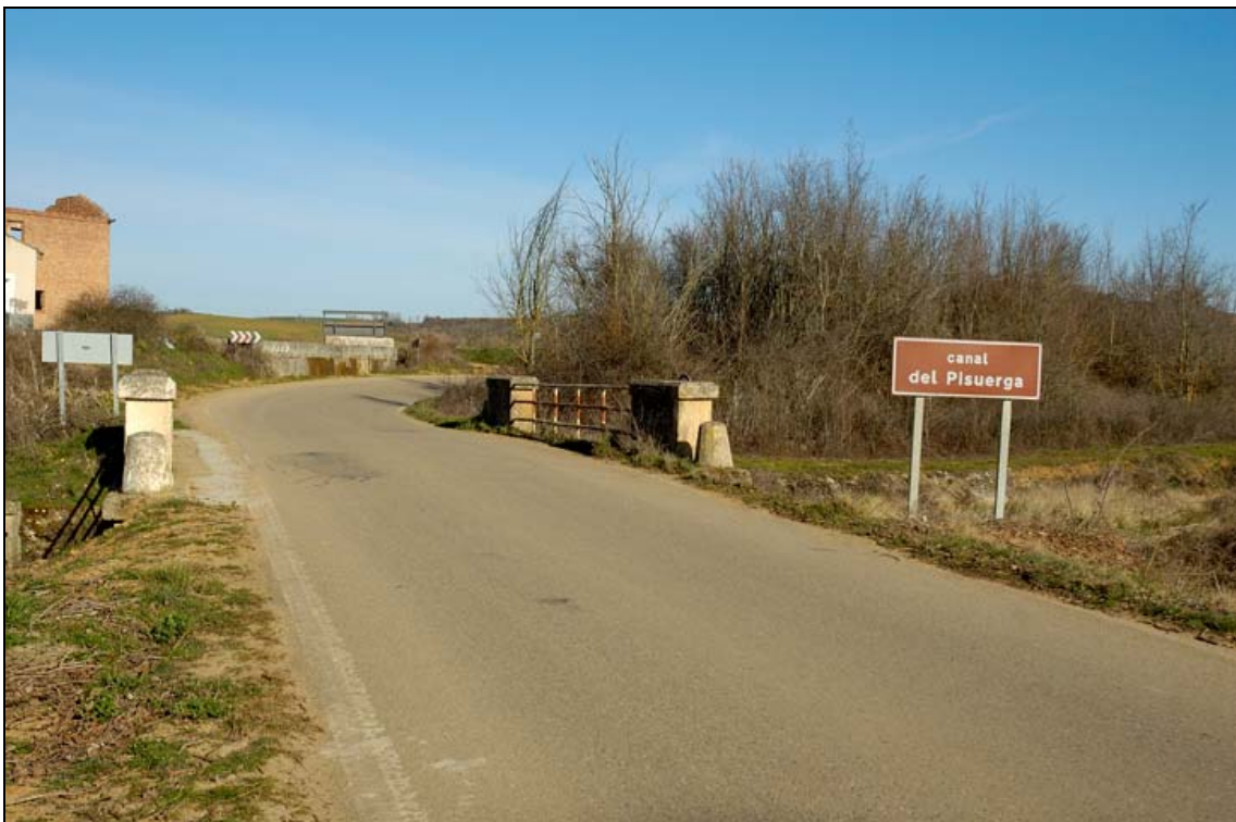
- FOTO 4 Aspecto de la calzada.
