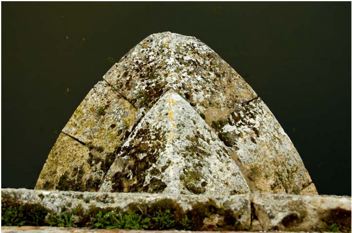
- FOTO 7 Uno de los tajamares, visto desde la plataforma de la calzada.
