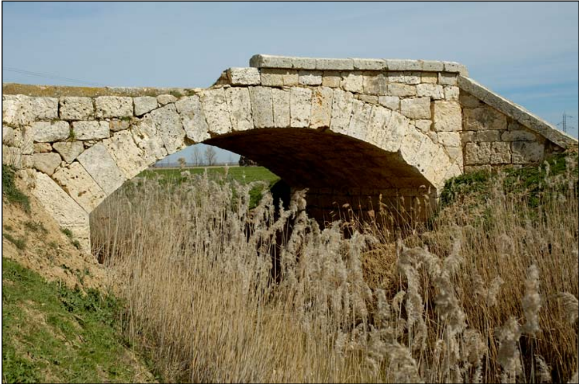
- FOTO 5 Puente de piedra, en las proximidades.
