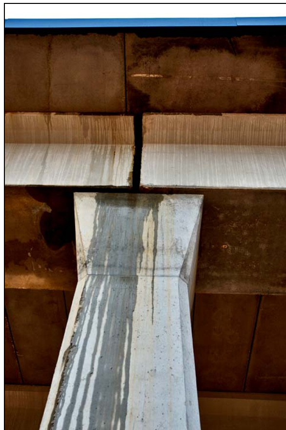
- FOTO 6 Detalle del interior.
