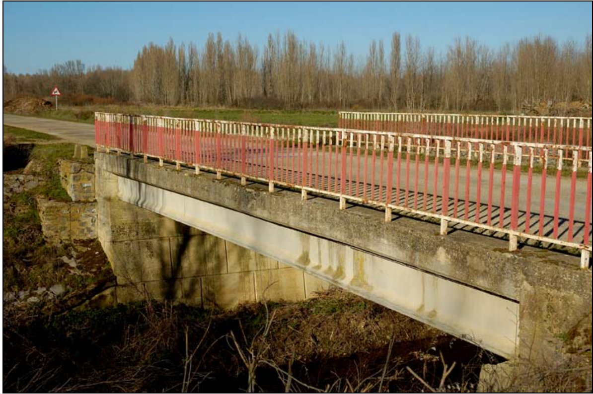
- FOTO 1 Vista del perfil del Puente.
