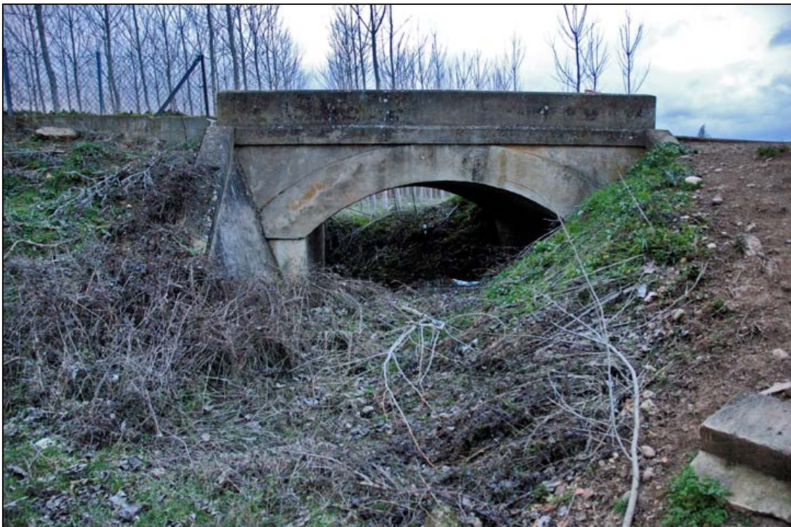
- FOTO 4 Arco aliviadero.
