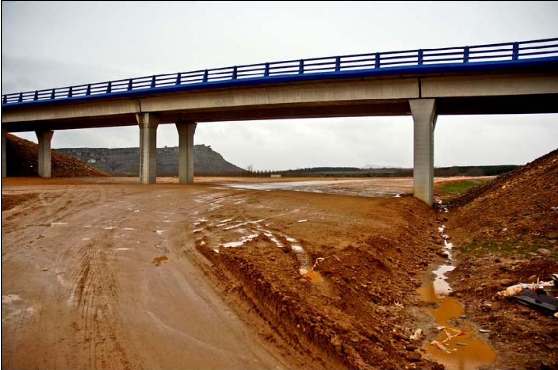
- FOTO 1 Vista general del Puente sobre la futura traza de la autovía.
