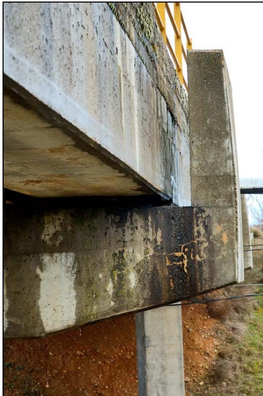
- FOTO 6 Detalle del dintel y la viga.
