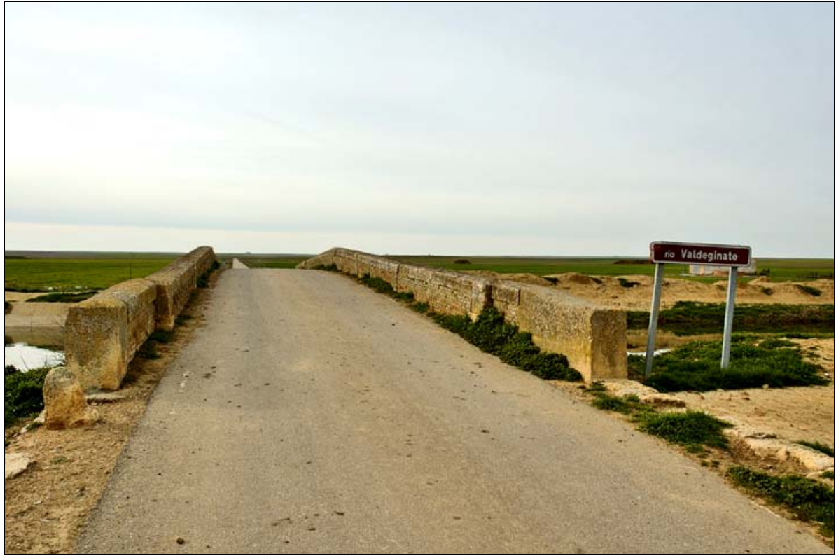
- FOTO 8 La calzada del Puente, con su rasante alomada.
