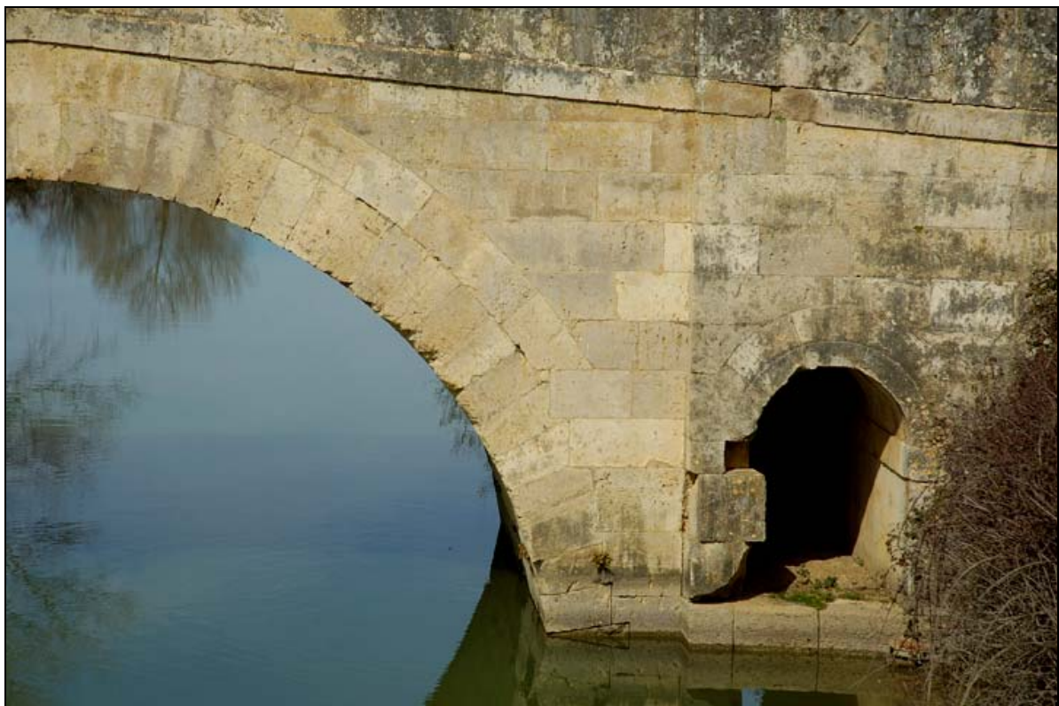
- FOTO 2 Detalle del arco y de uno de los arquillos.
