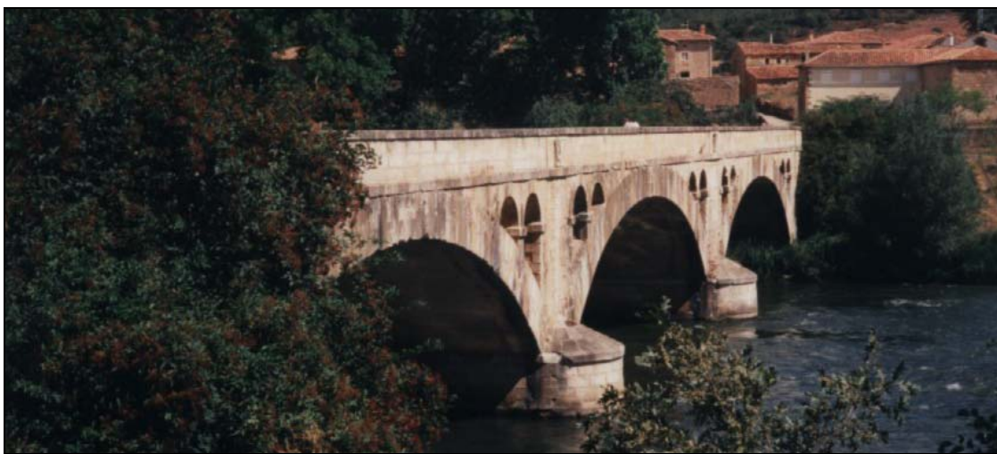
- FOTO 1 Detalle de pila-arcos-arquillos-pretil.
