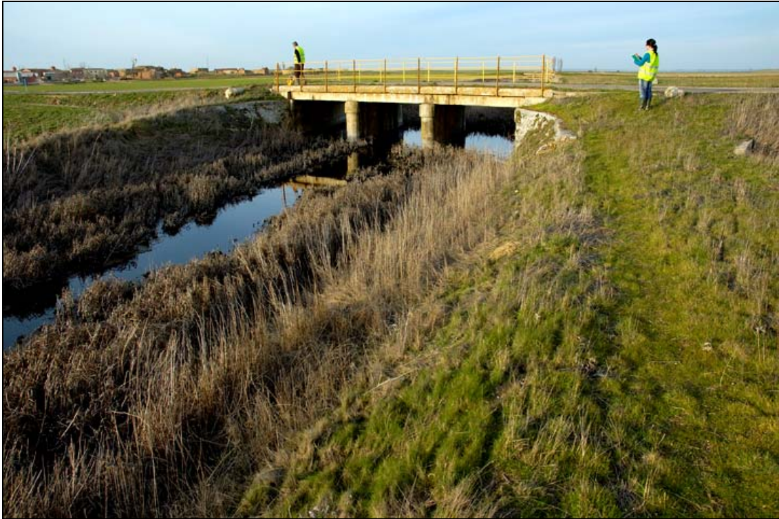
- FOTO 1 Vista general. Al fondo el Puente.
