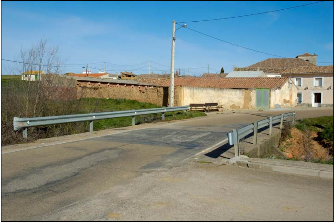
- FOTO 2 La calzada.
