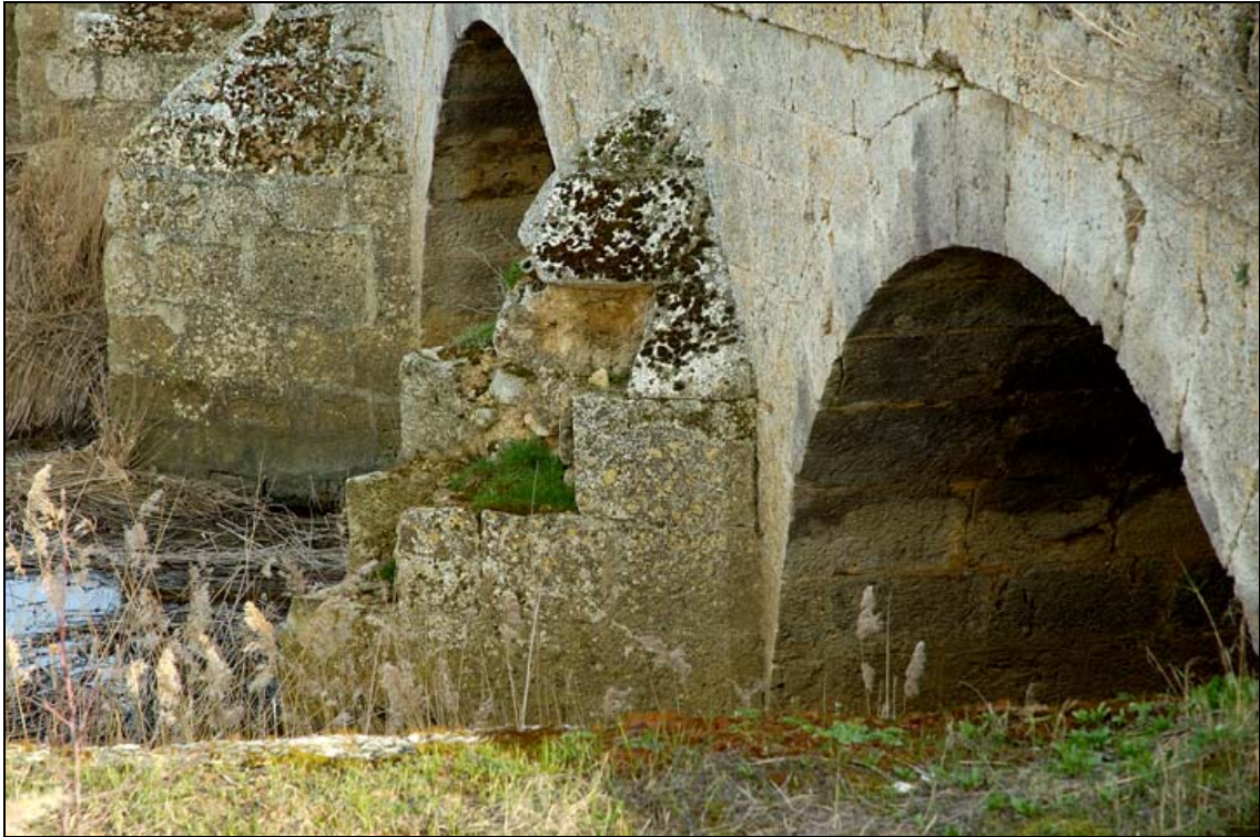
- FOTO 3 Detalle de uno de los espolones y dos de sus cinco arcos.
