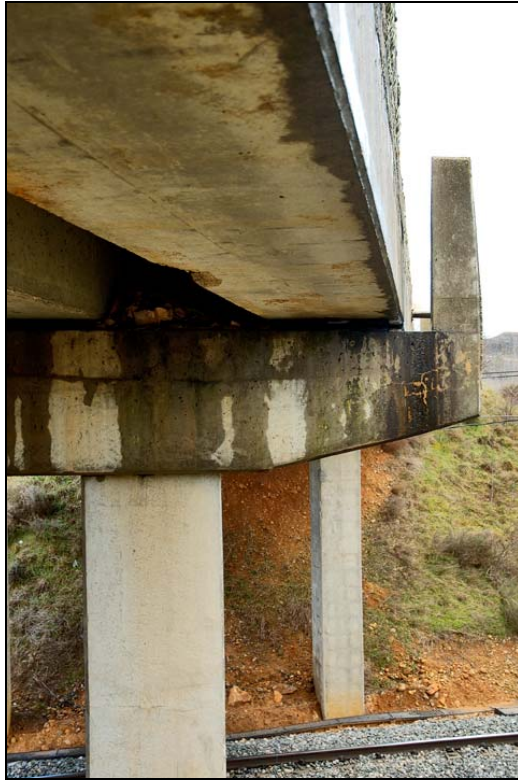
- FOTO 5 Perspectiva del Puente desde abajo.
