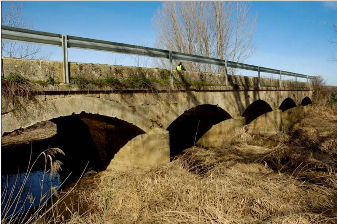
- FOTO 4 Vista general del Puente.
