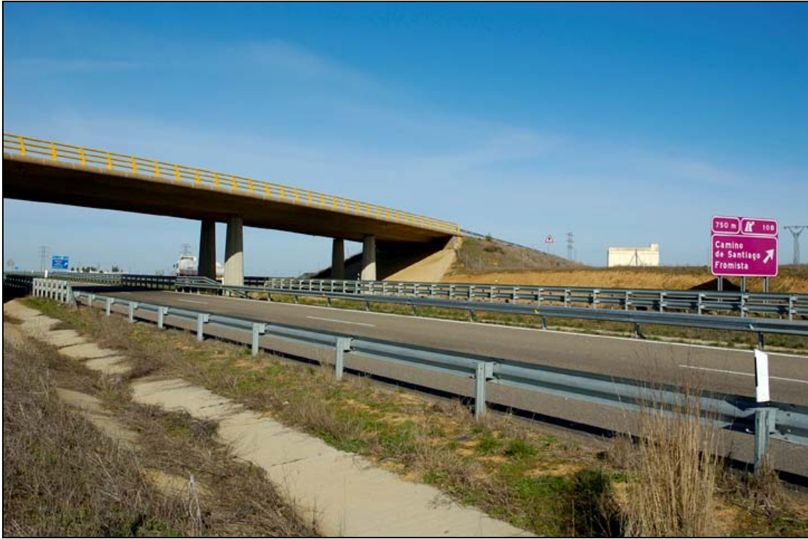
- FOTO 5 El Puente sobre la autovía.
