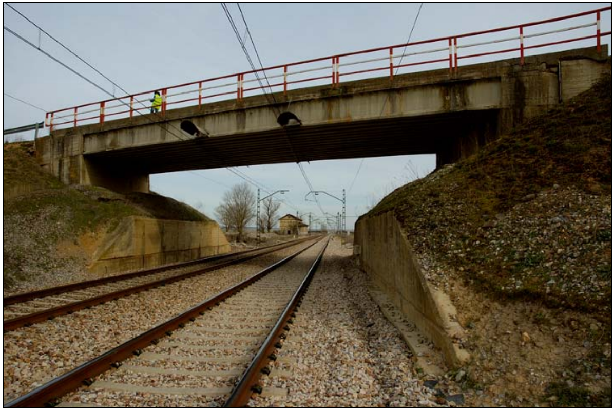
- FOTO 1 Vista general.
