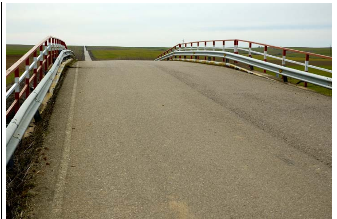
- FOTO 6 Vista de la calzada.
