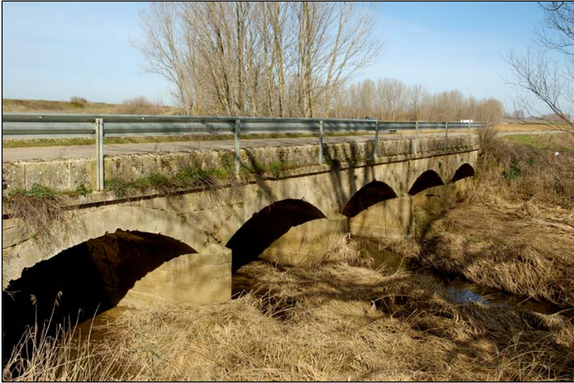
- FOTO 5 Silueta del Puente y su entorno paisajístico.
