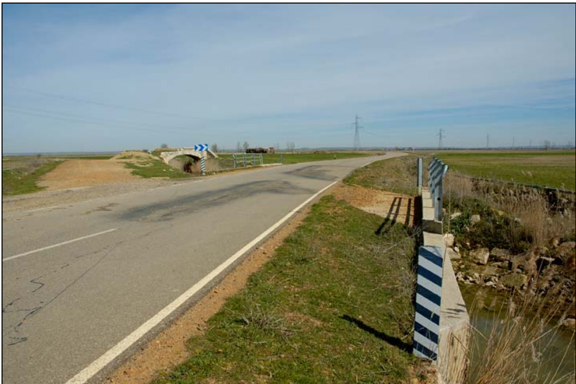
- FOTO 2 La carretera con su Puente. Al fondo el Puente viejo de piedra.
