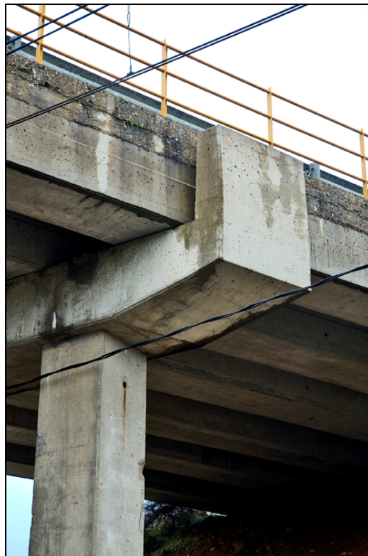
- FOTO 4 Detalle de pila-dintel-vigas-barandilla.
