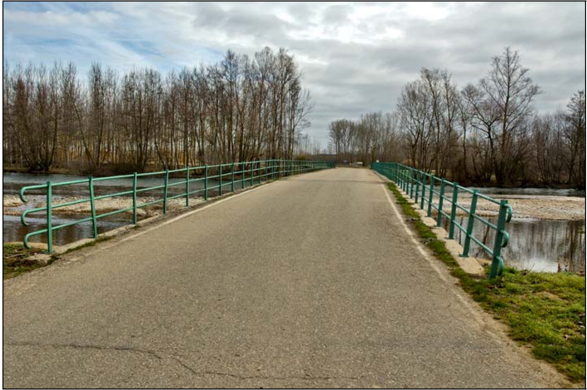
- FOTO 8 La carretera pasa por el Puente.
