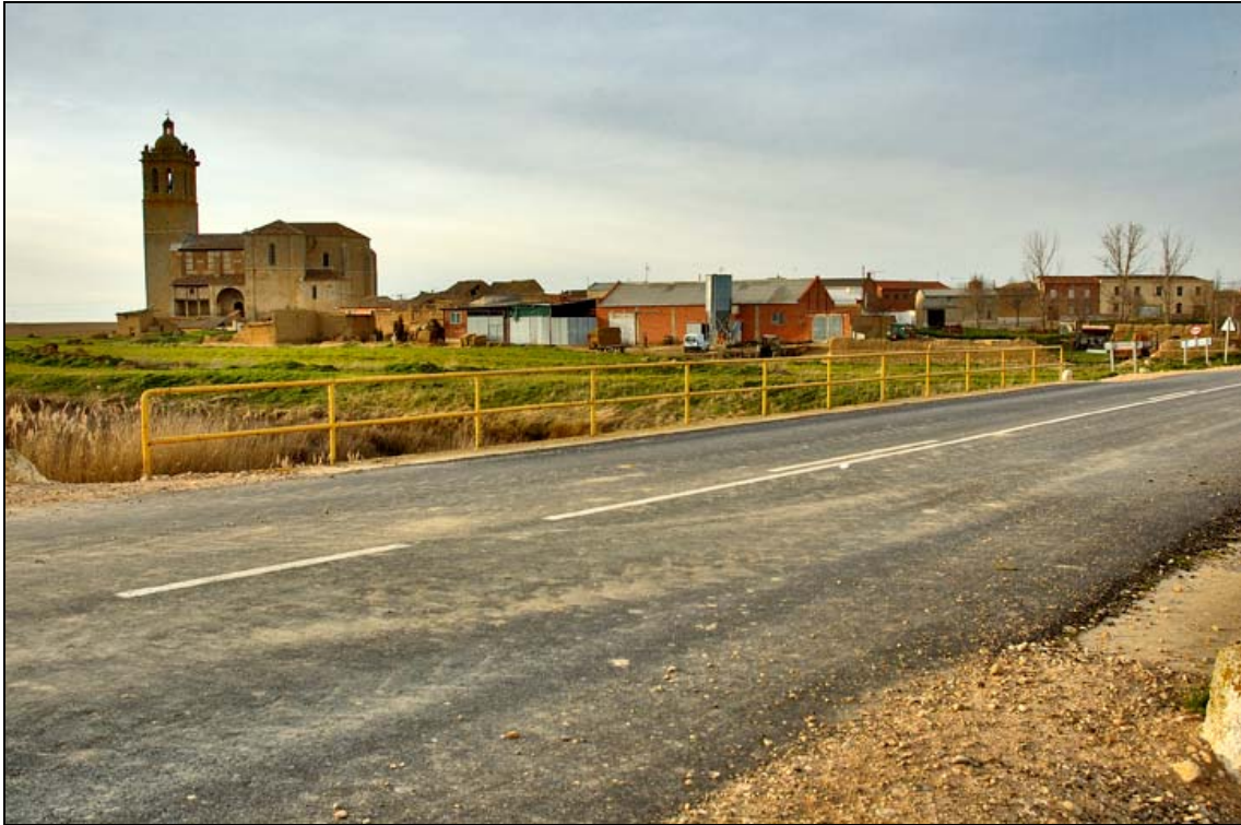
- FOTO 7 Vista longitudinal de la calzada, con el perfil del núcleo urbano al fondo.
