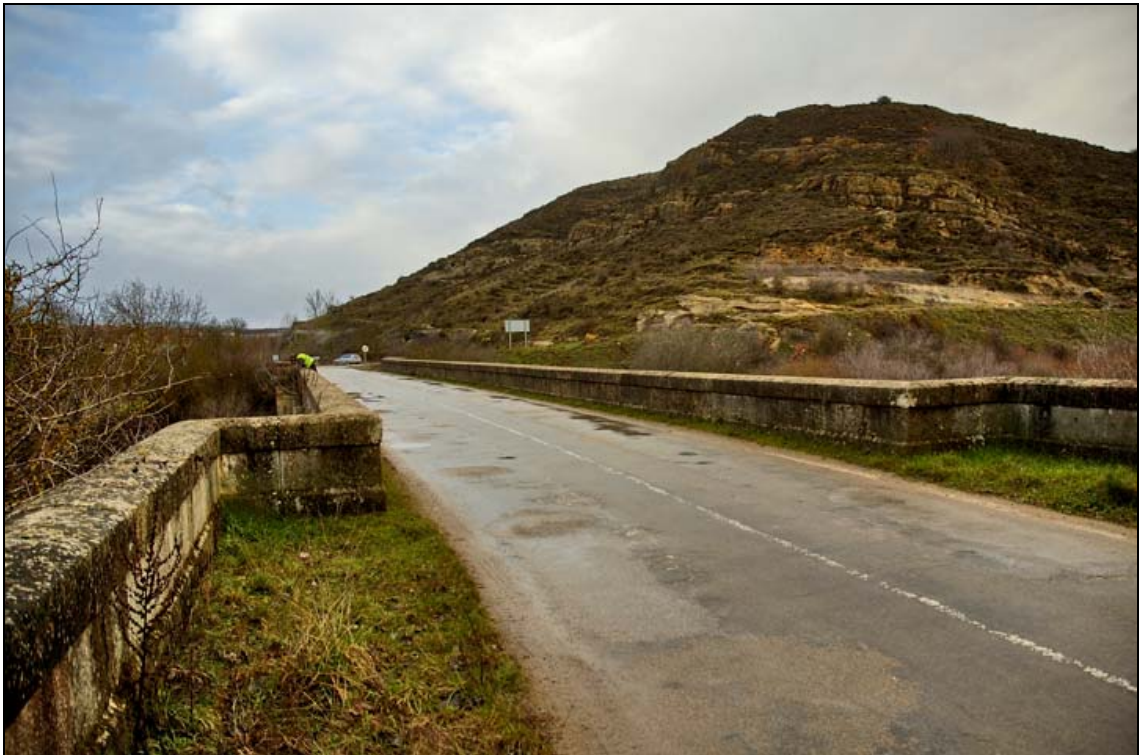
- FOTO 5 Planta del Puente desde la margen izquierda.
