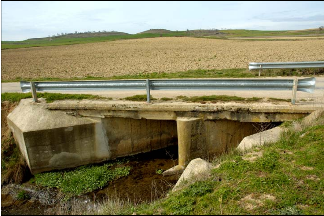
- FOTO 1 Vista del Puente.
