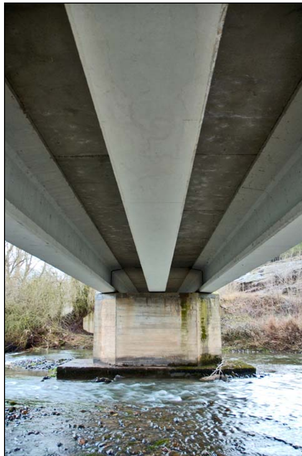
- FOTO 6 Detalle pila y tablero.
