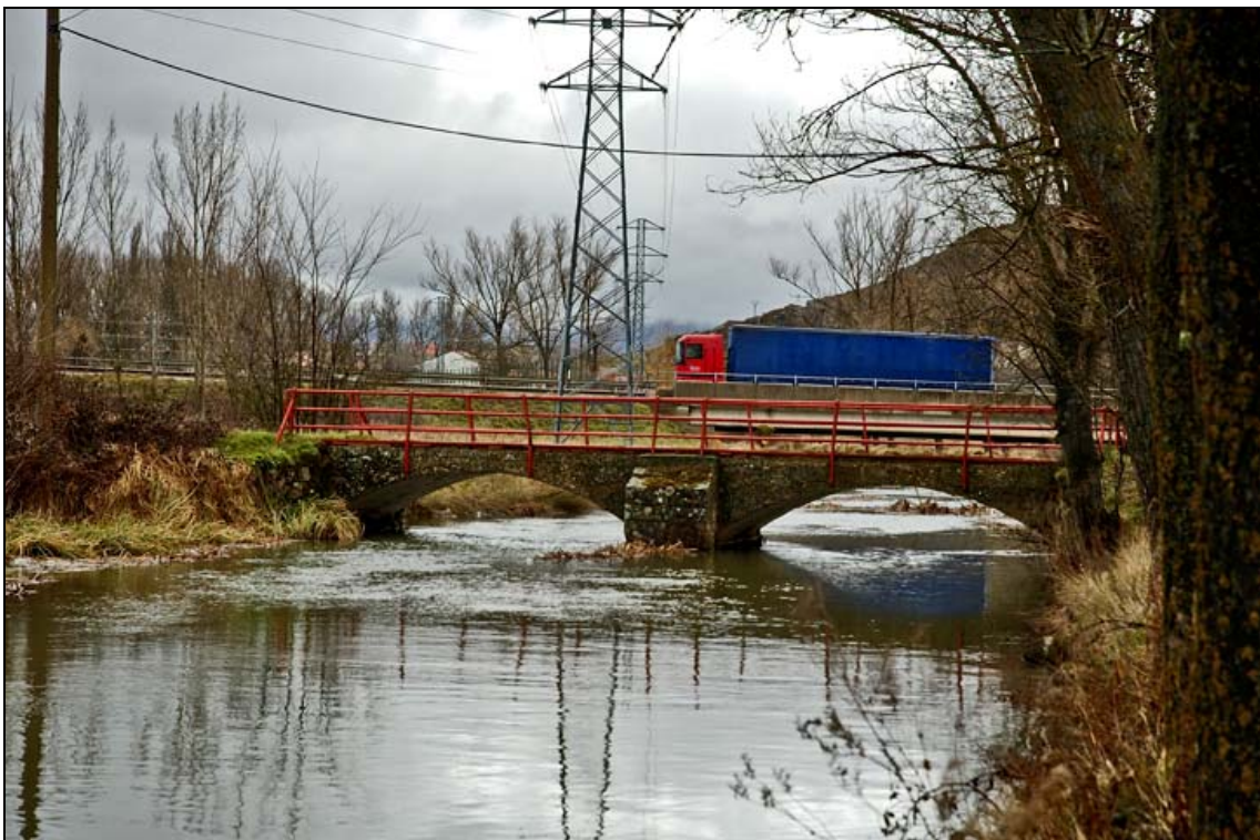
- FOTO 2 Vista dl Puente desde aguas abajo.
