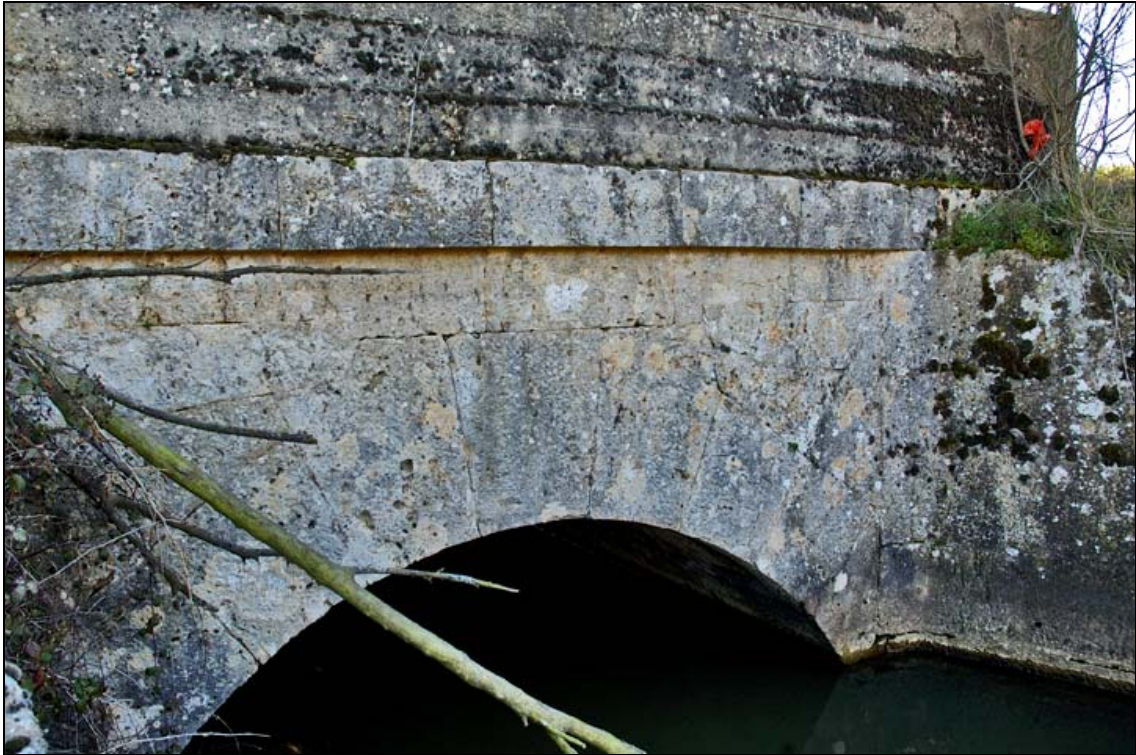
- FOTO 1 Detalle del arco, pretil e imposta.
