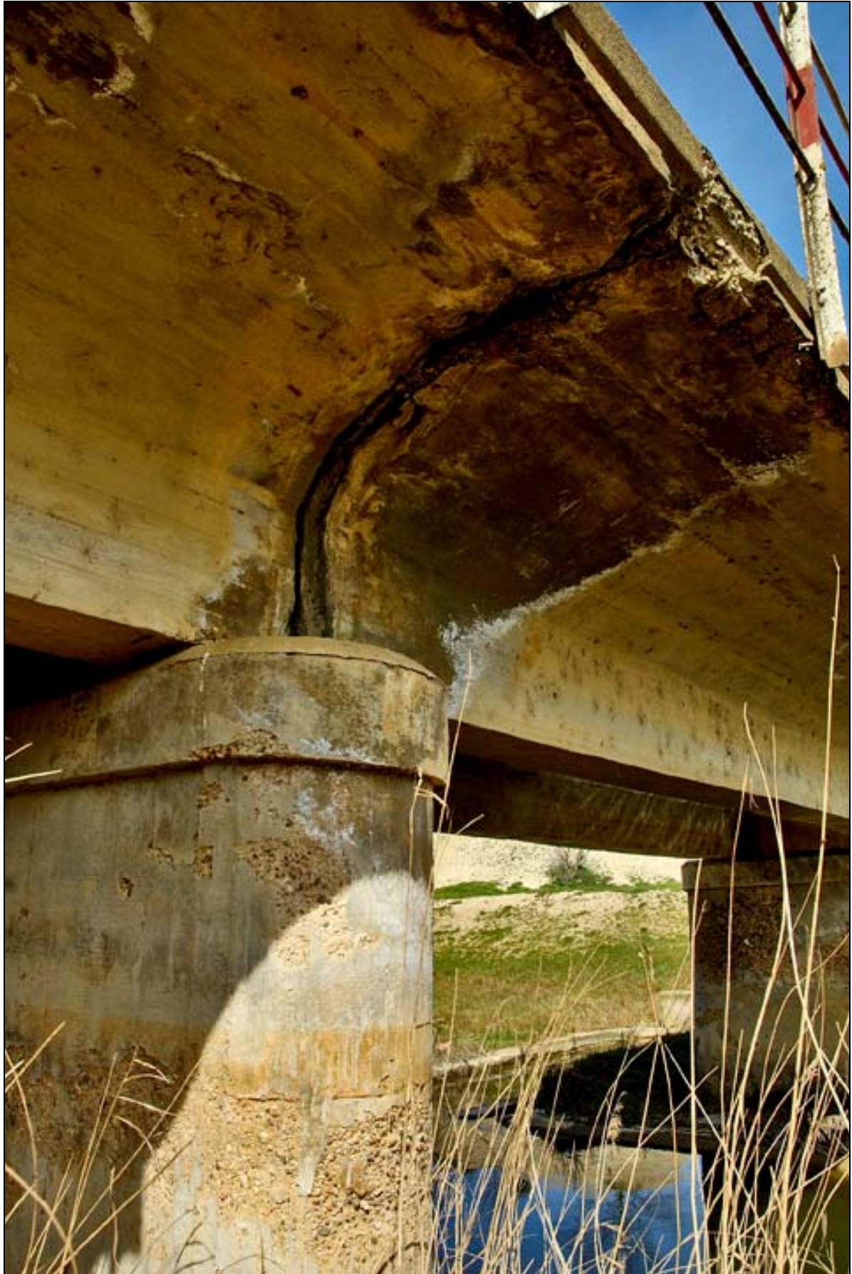
- FOTO 3 Detalle de una de las pilas, con las vigas poyadas.
