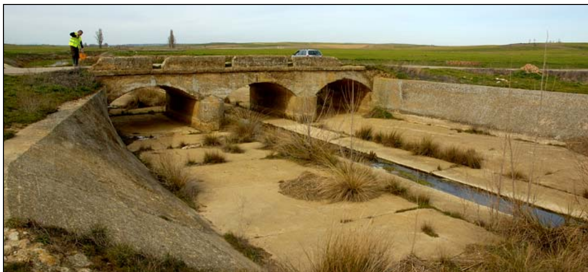
- FOTO 1 Vista del Puente y el río sensiblemente canalizado.
