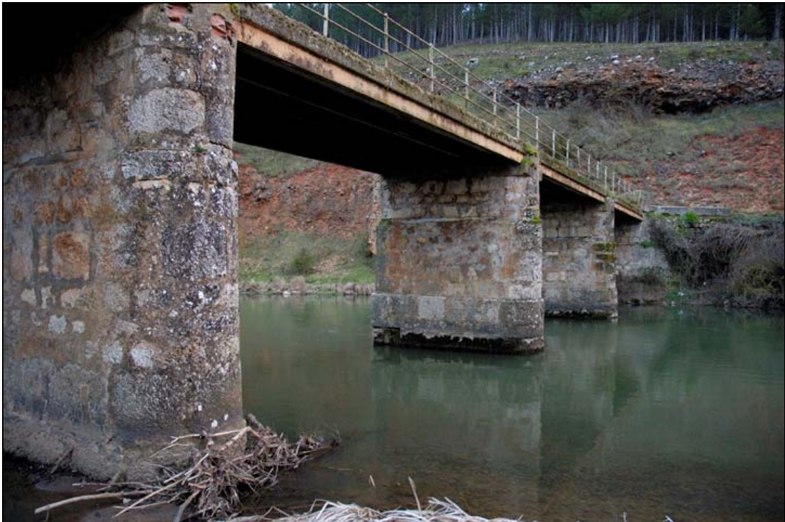
- FOTO 6 Vanos desde aguas arriba.
