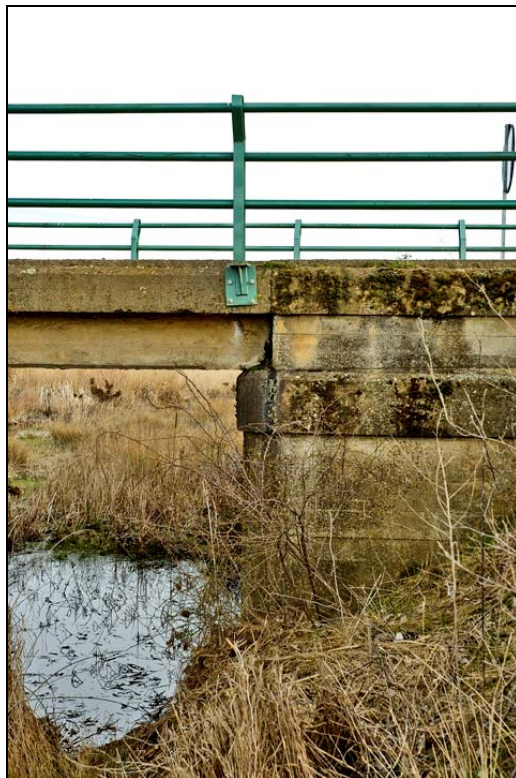
- FOTO 4 Detalle de uno de los estribos.
