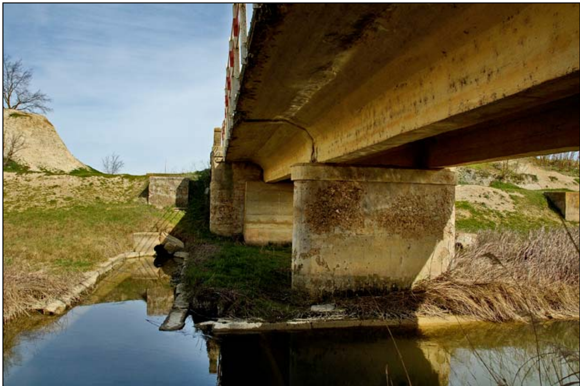
- FOTO 2 Detalle de pila y viga.
