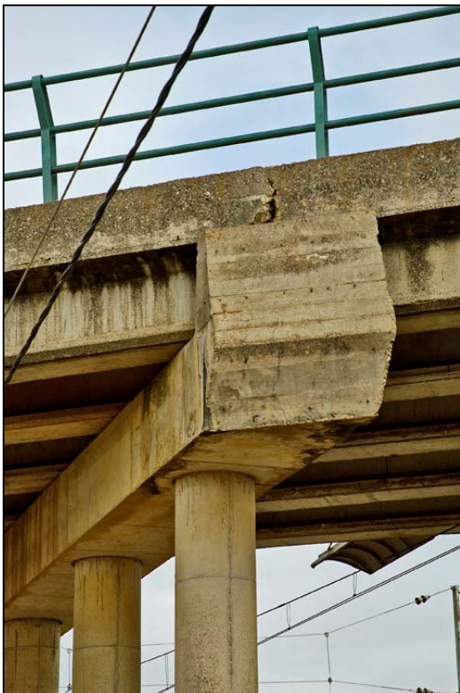
- FOTO 4 Detalle de pilas-dintel-vigas.
