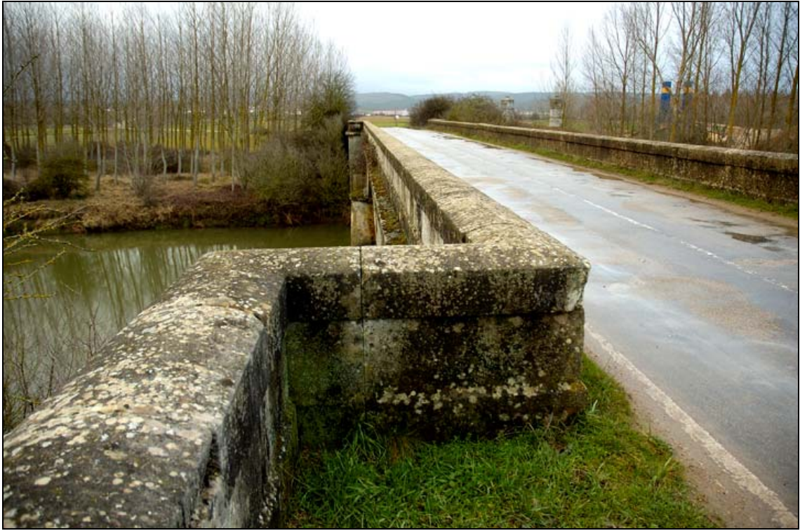
- FOTO 8 La calzada y el pretil.
