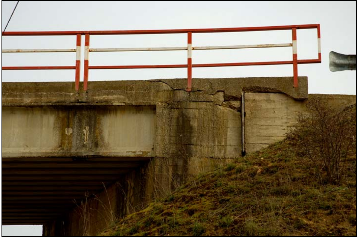
- FOTO 3 Detalle de barandilla-viga-estribo.
