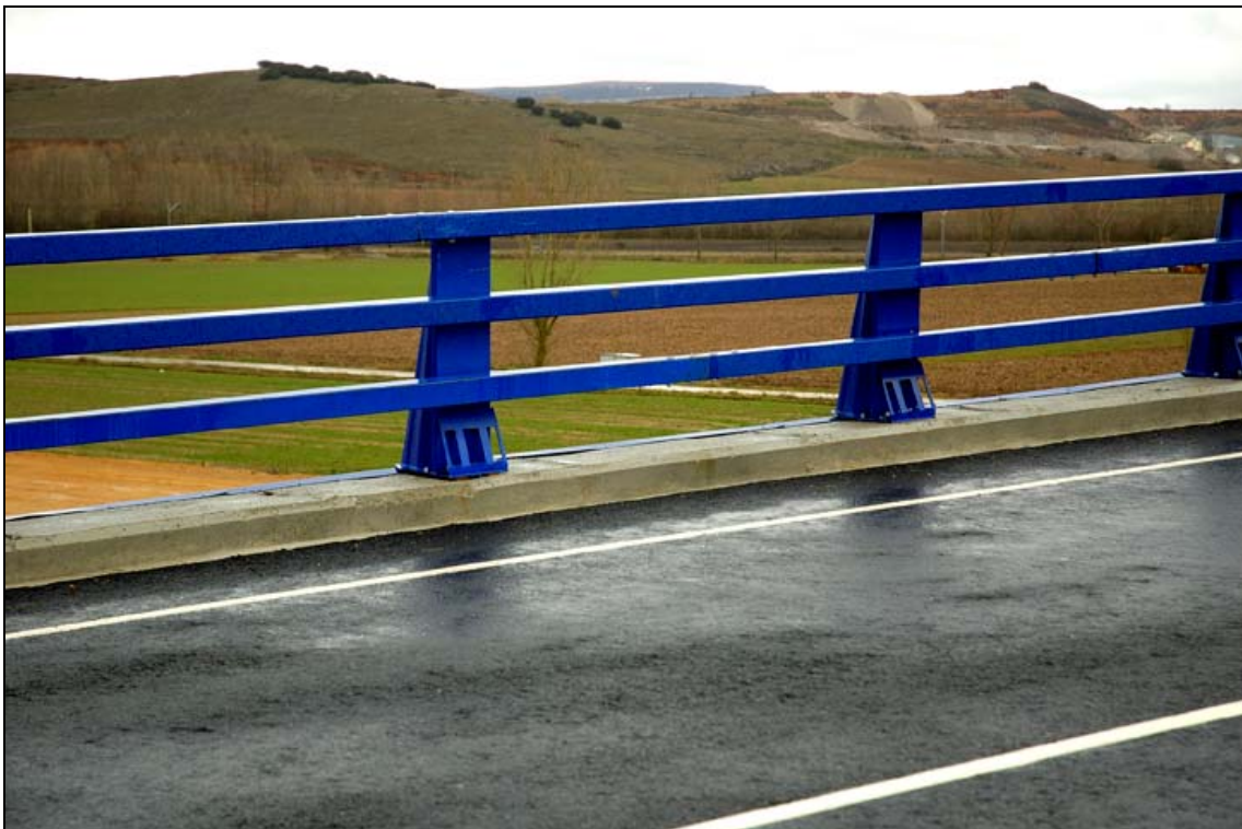
- FOTO 4 Detalle de la barandilla.
