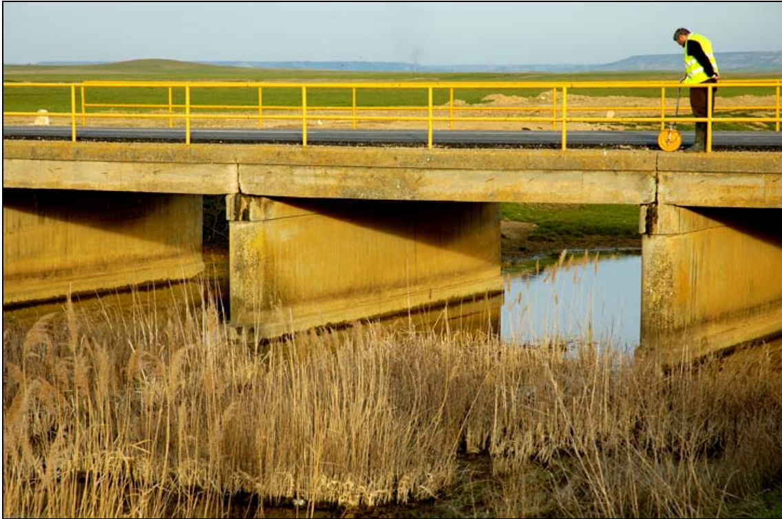
- FOTO 3 Detalle de pilas, losa y barandilla.
