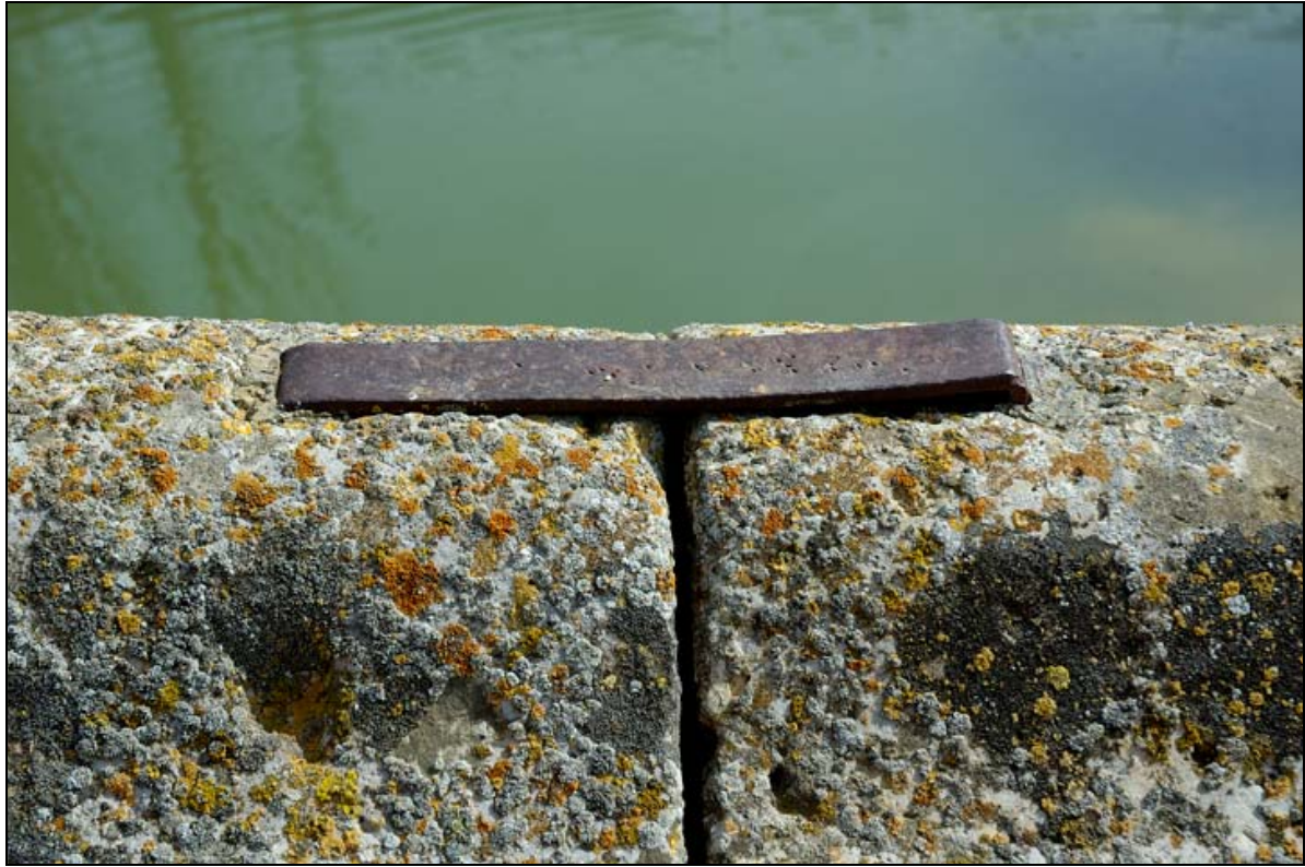
- FOTO 5 Detalle de unión de dos sillares del pretil.
