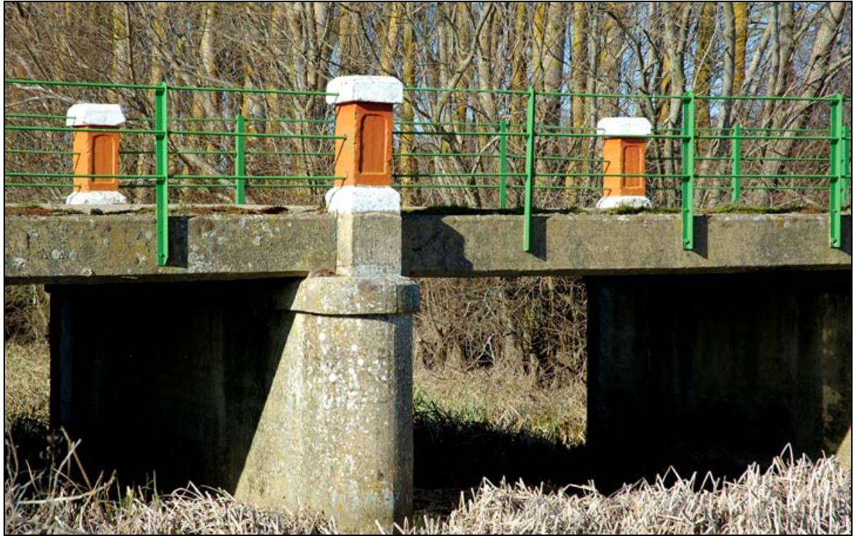
- FOTO 2 Pila, losa, barandilla y machón.
