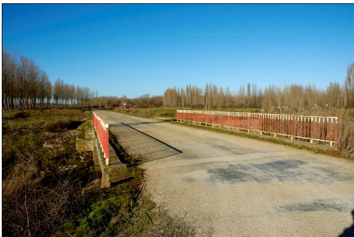
- FOTO 4 La calzada de la carretera pasa por el Puente.
