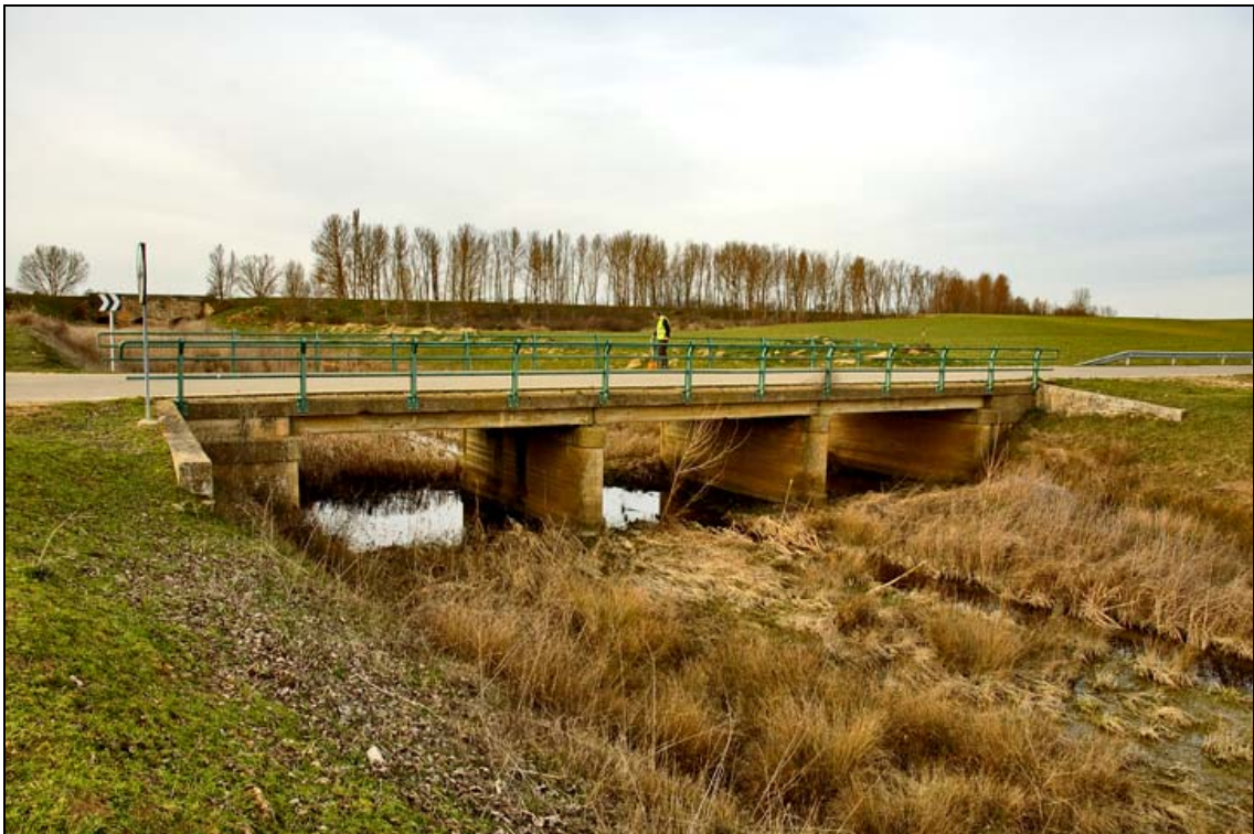
- FOTO 2 Silueta del Puente.
