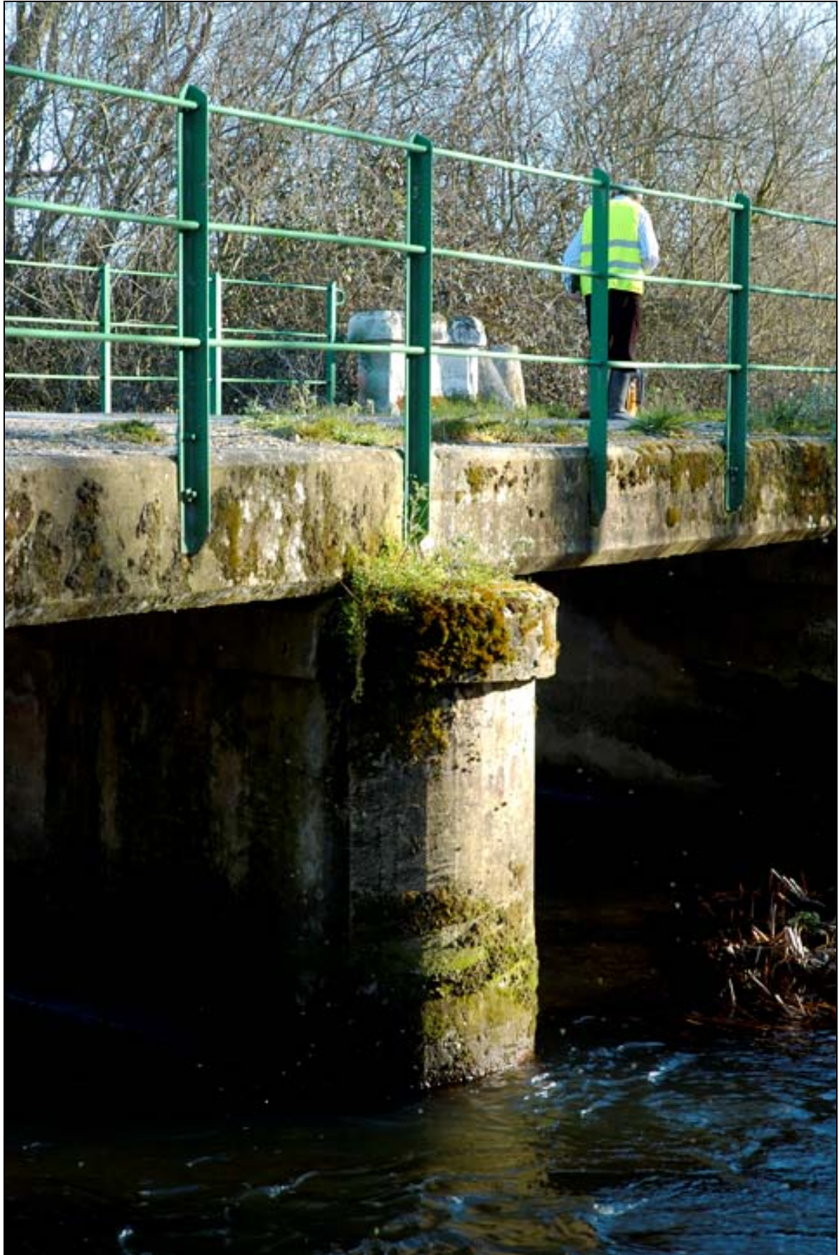
- FOTO 2 Pila, losa y barandilla.
