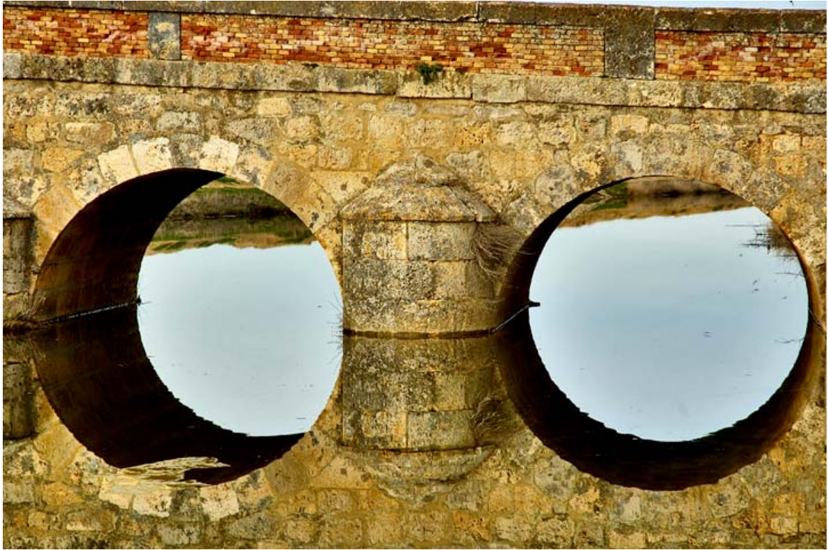
- FOTO 6 Vista parcial de dos de los arcos.
