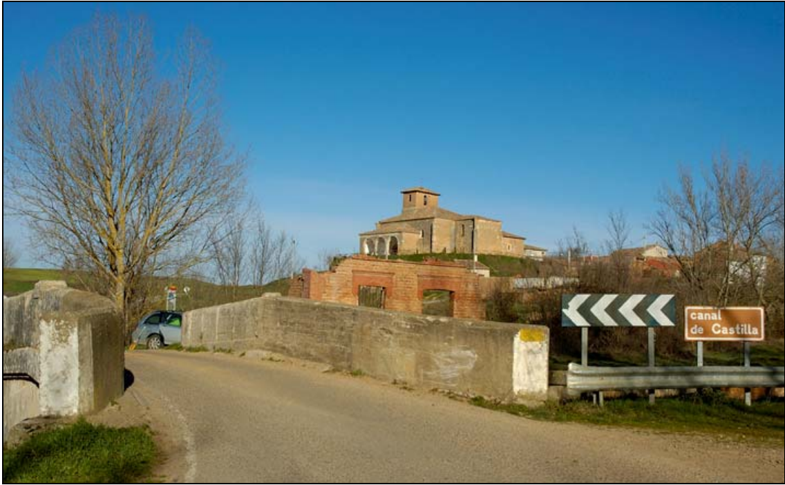
- FOTO 5 La calzada.
