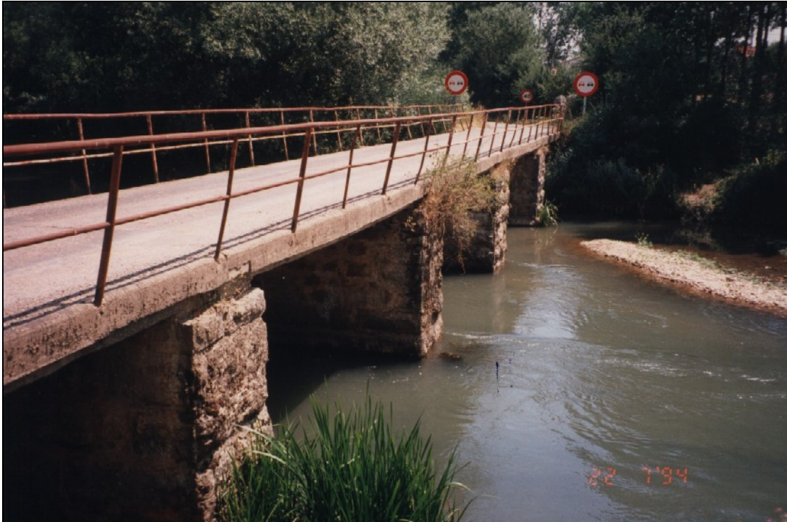
- FOTO 2 Vista del Puente desde aguas abajo.
