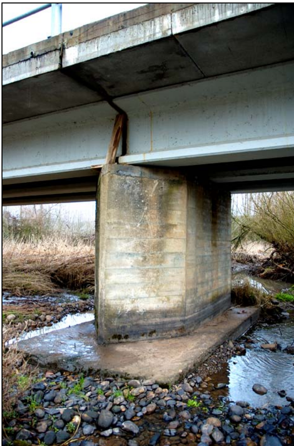
- FOTO 8 Detalle una pila y el tablero.
