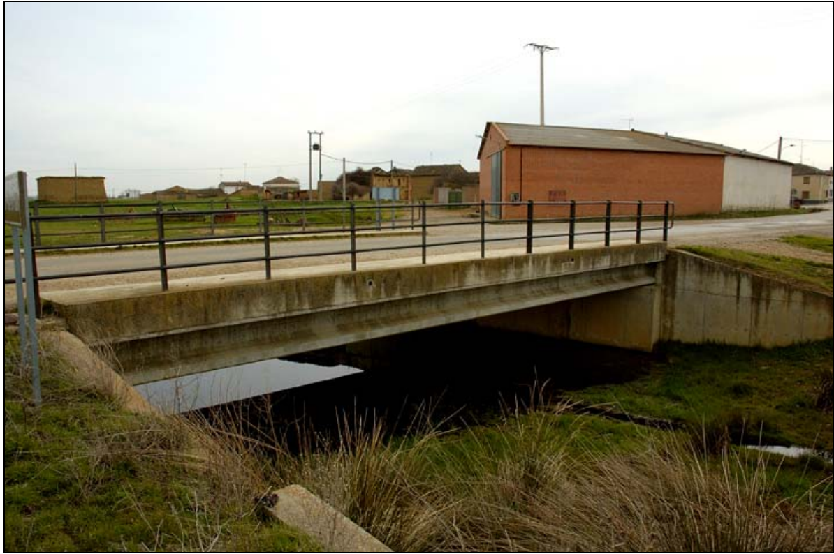
- FOTO 1 Vista general del Puente.
