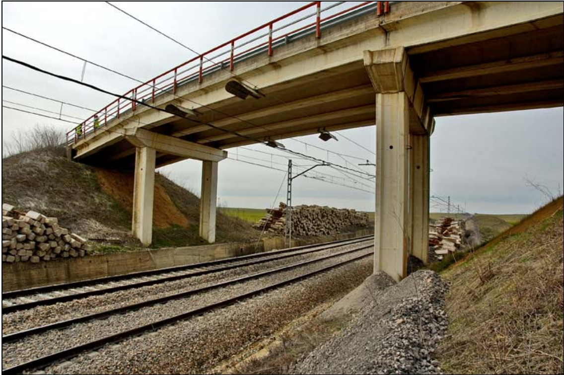
- FOTO 3 El Puente, con sus pilas sus vigas y su barandilla.
