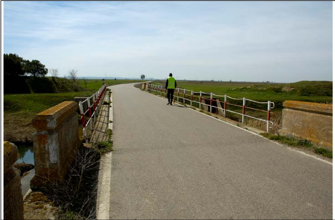
- FOTO 5 Vista de la calzada.
