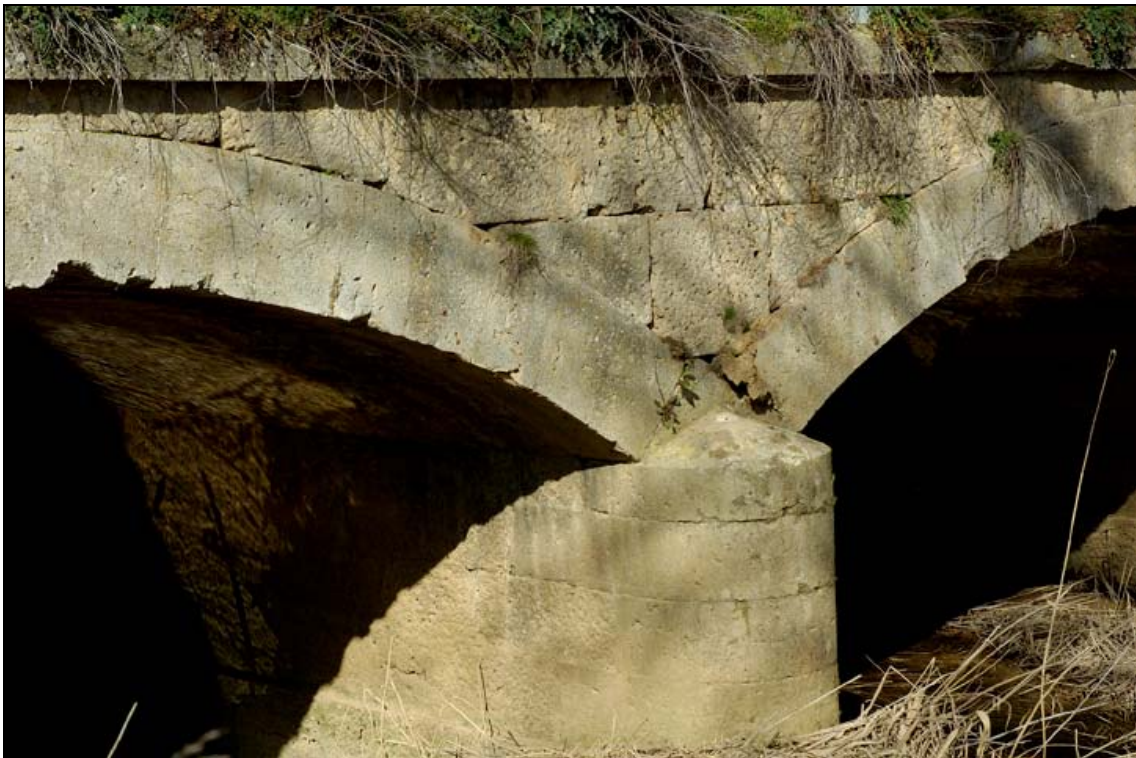
- FOTO 6 Detalle de roscas de los arcos y sillares.
