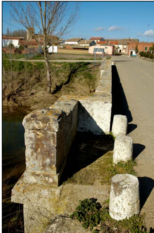
- FOTO 6 Detalle de la entrada y el pretil.
