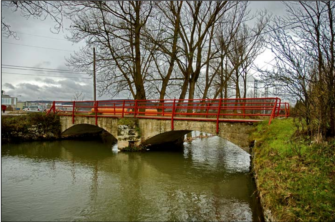
- FOTO 1 Vista del Puente desde aguas arriba.
