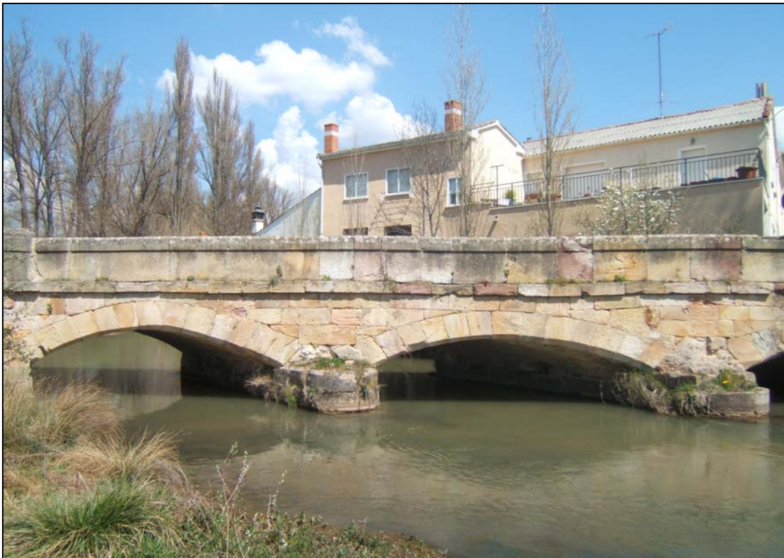
- FOTO 2 Dos de los arcos del Puente.
