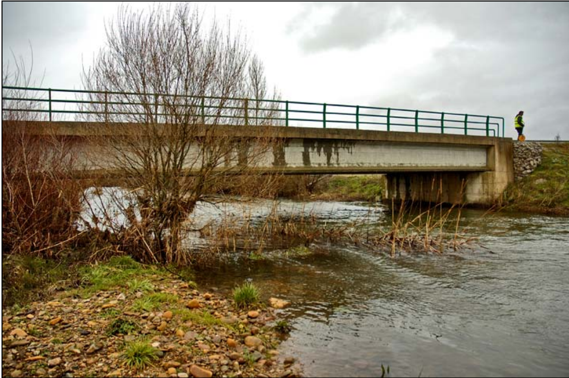
- FOTO 1 Vista del Puente y el río.
