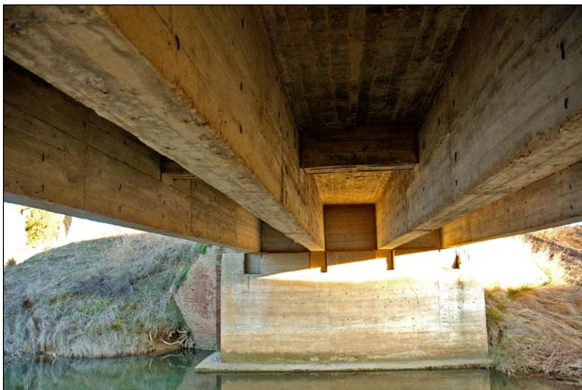
- FOTO 5 El interior: vigas y estribo.
