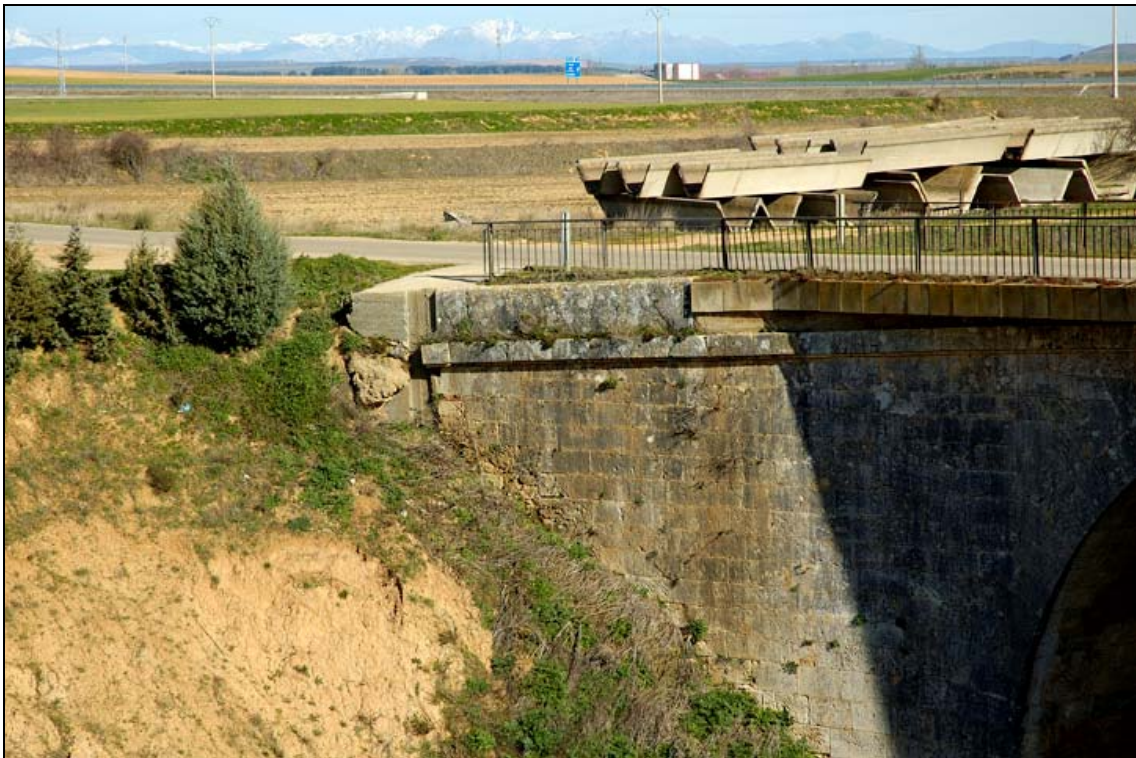
- FOTO 4 Detalle de los sillares de uno de los estribos.
