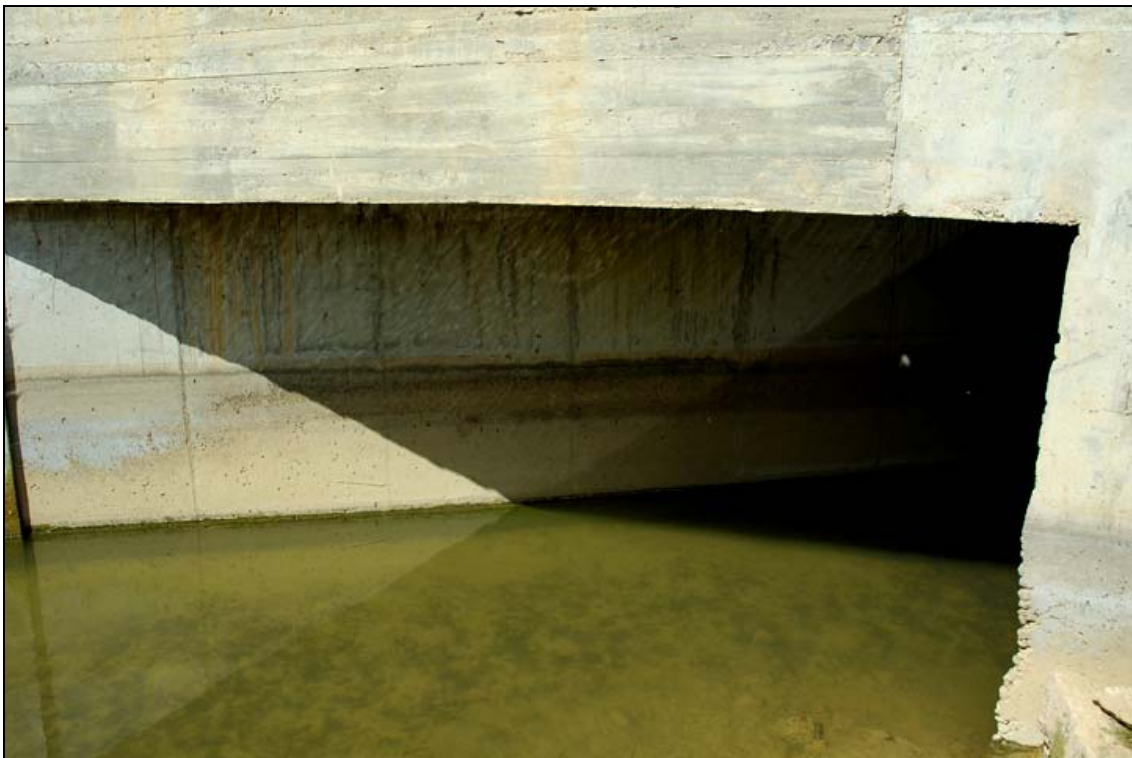
- FOTO 4 Detalle del canto de la losa.
