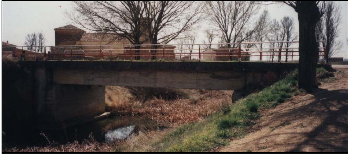
- FOTO 1 Vista de la planta desde la margen derecha.
