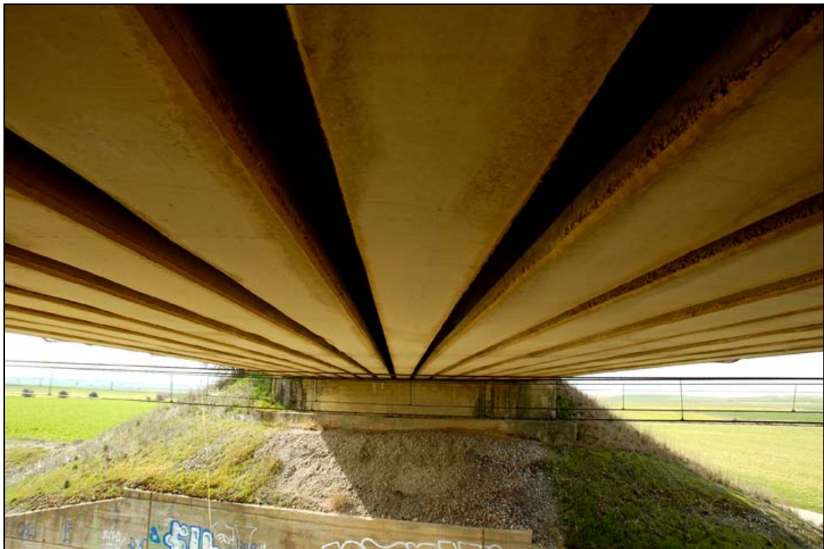
- FOTO 2 Detalle de las vigas desde la parte de abajo.
