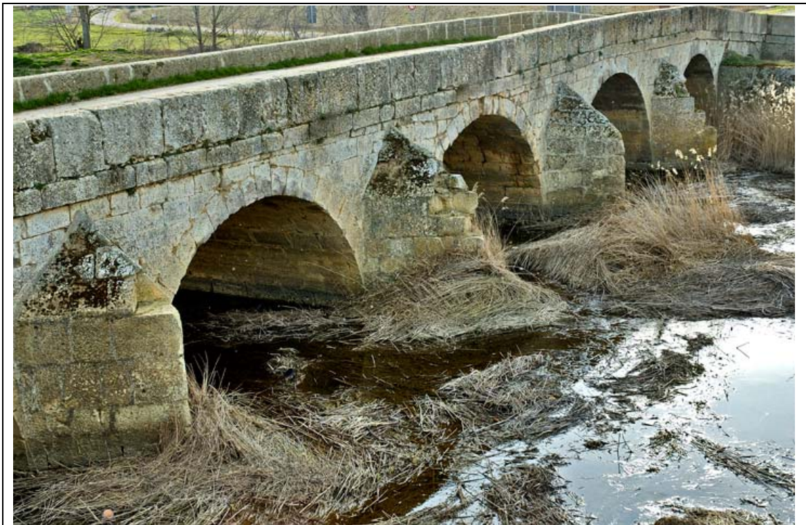
- FOTO 2 Silueta del Puente desde aguas arriba.
