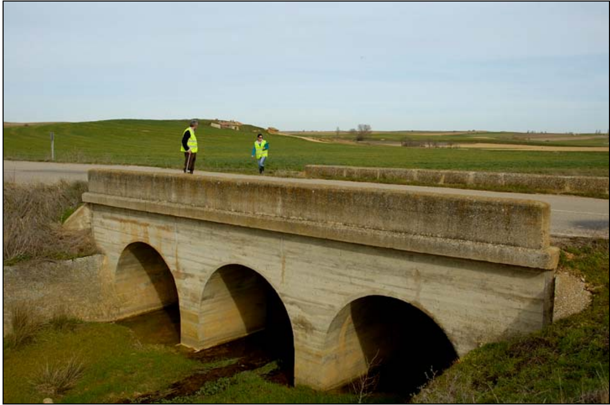
- FOTO 1 Vista general del Puente.
