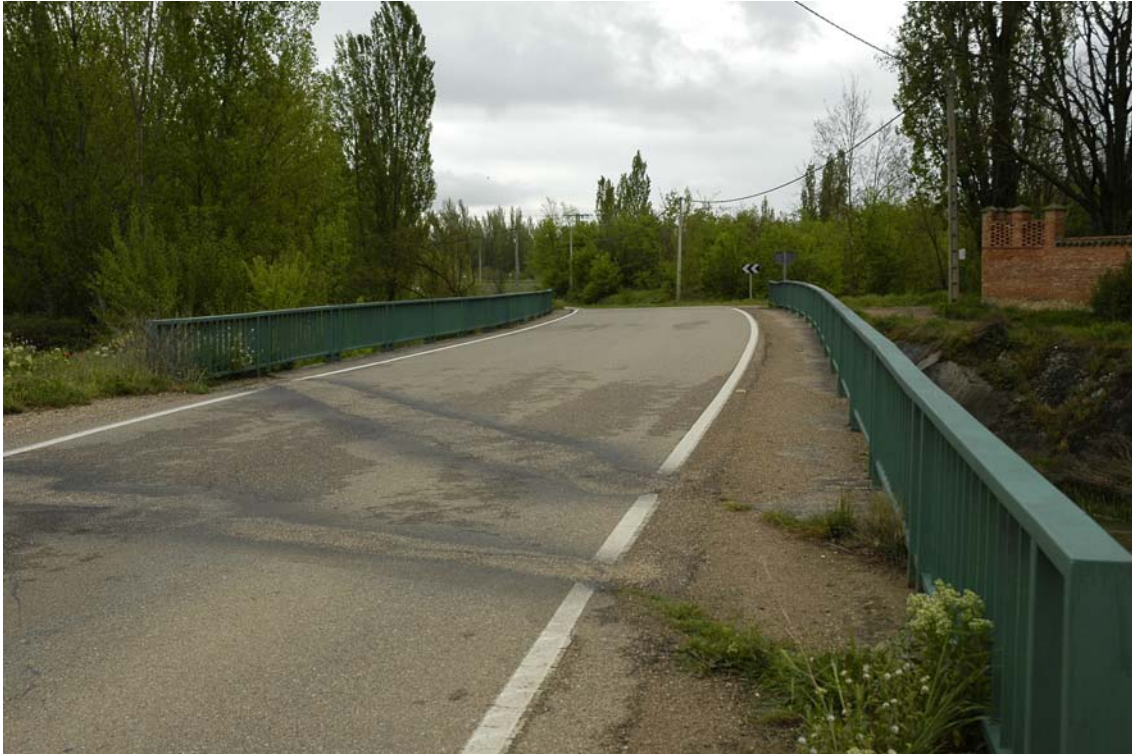
- FOTO 3 La calzada.
