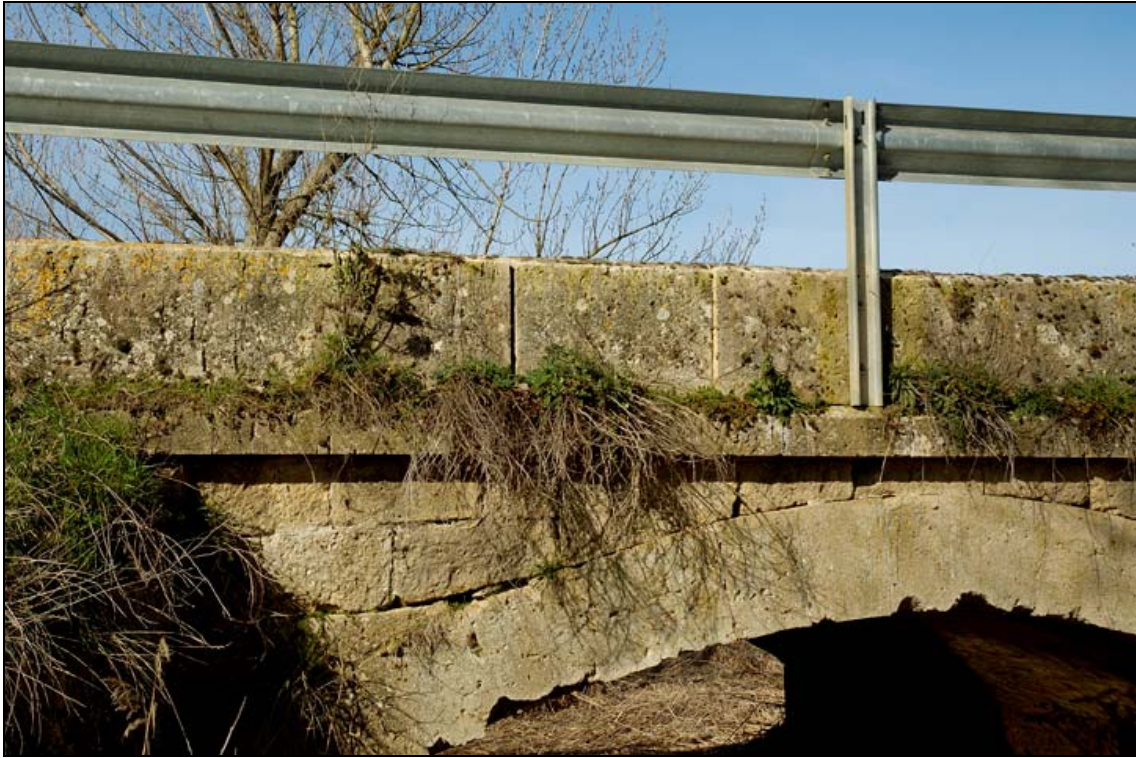
- FOTO 7 Detalle clave de uno de los arcos, imposta, pretil y banda bionda.
