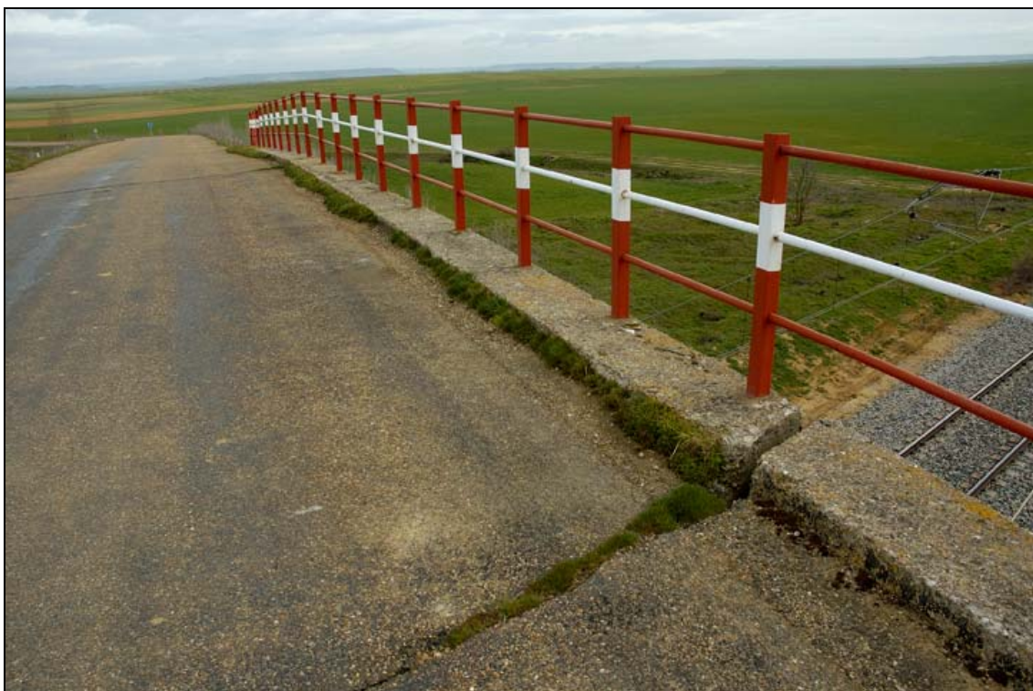
- FOTO 6 Vista de la calzada con la barandilla.
