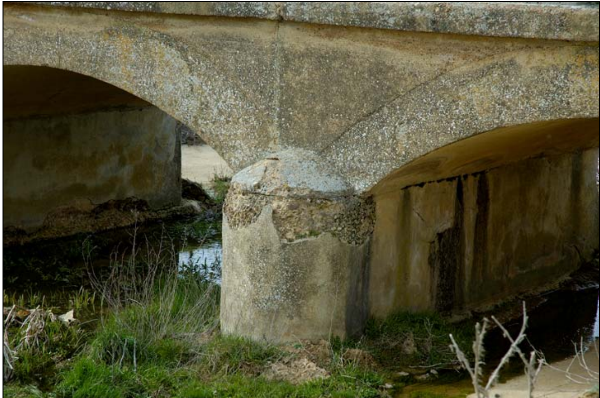
- FOTO 2 Detalle del arranque de los arcos.
