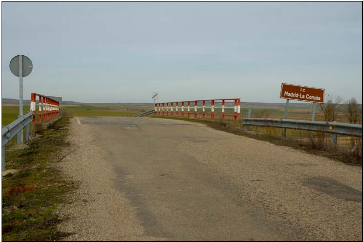
- FOTO 5 Vista de la calzada.
