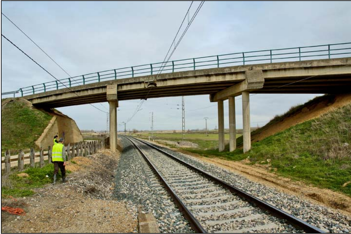
- FOTO 1 Vista general del Puente y la vía.
