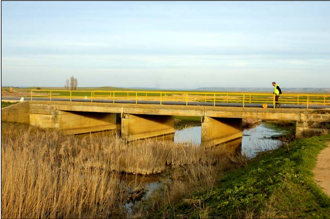
- FOTO 1 Vista del Puente y del río.
