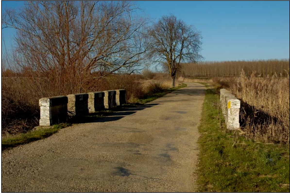
- FOTO 1 La calzada.
