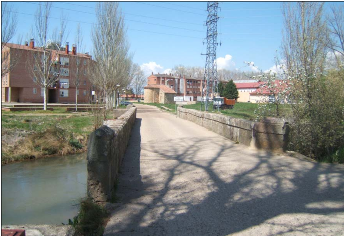
- FOTO 4 La calzada.
