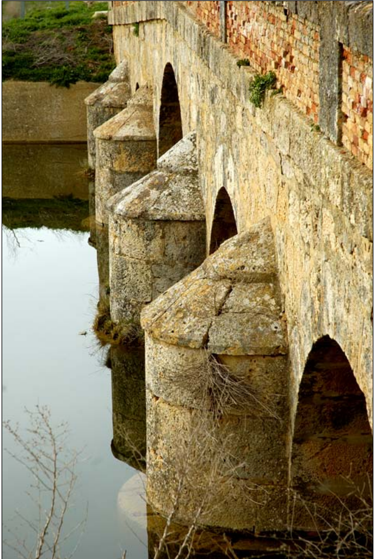
- FOTO 3 Detalle lateral de los espolones, aguas abajo.
