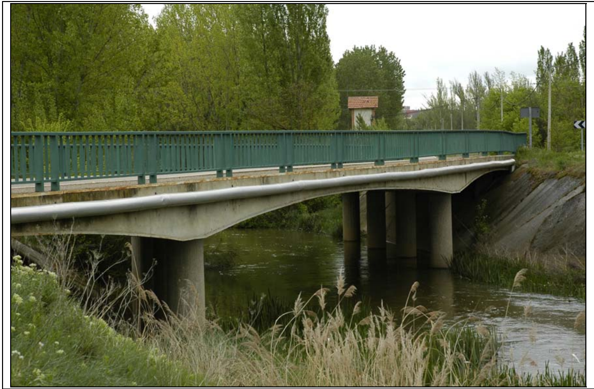
- FOTO 1 Vista general del Puente y el entorno.
