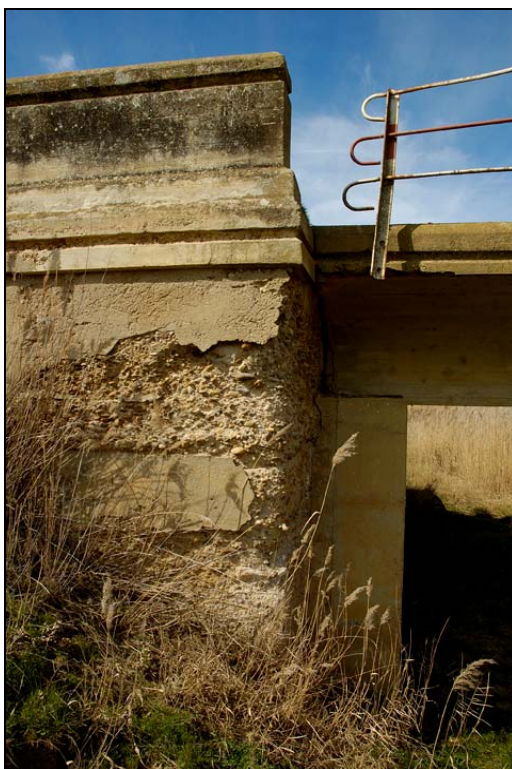
- FOTO 7 Detalle de uno de los estribos
