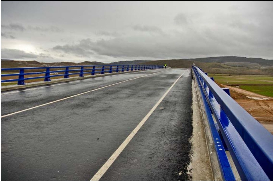
- FOTO 3 La calzada y la barandilla.
