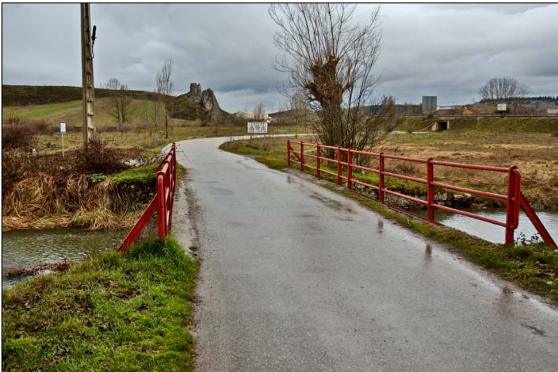
- FOTO 4 La calzada a su paso por el Puente.
