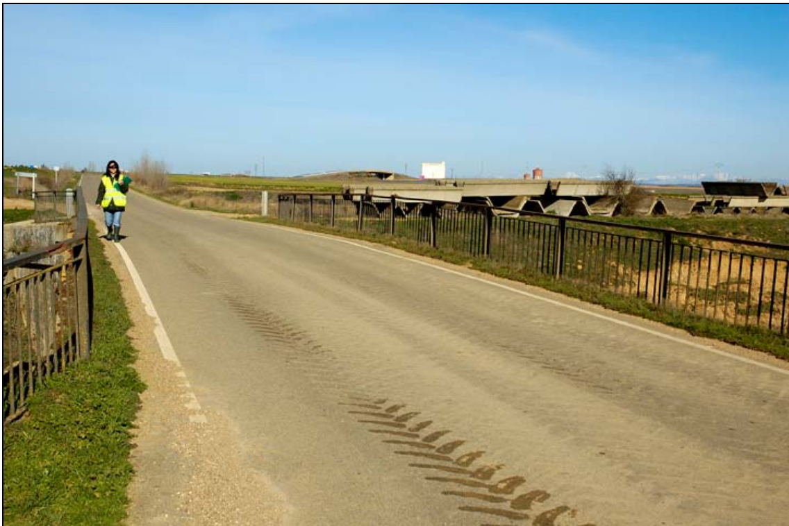
- FOTO 6 Vista de la calzada.
