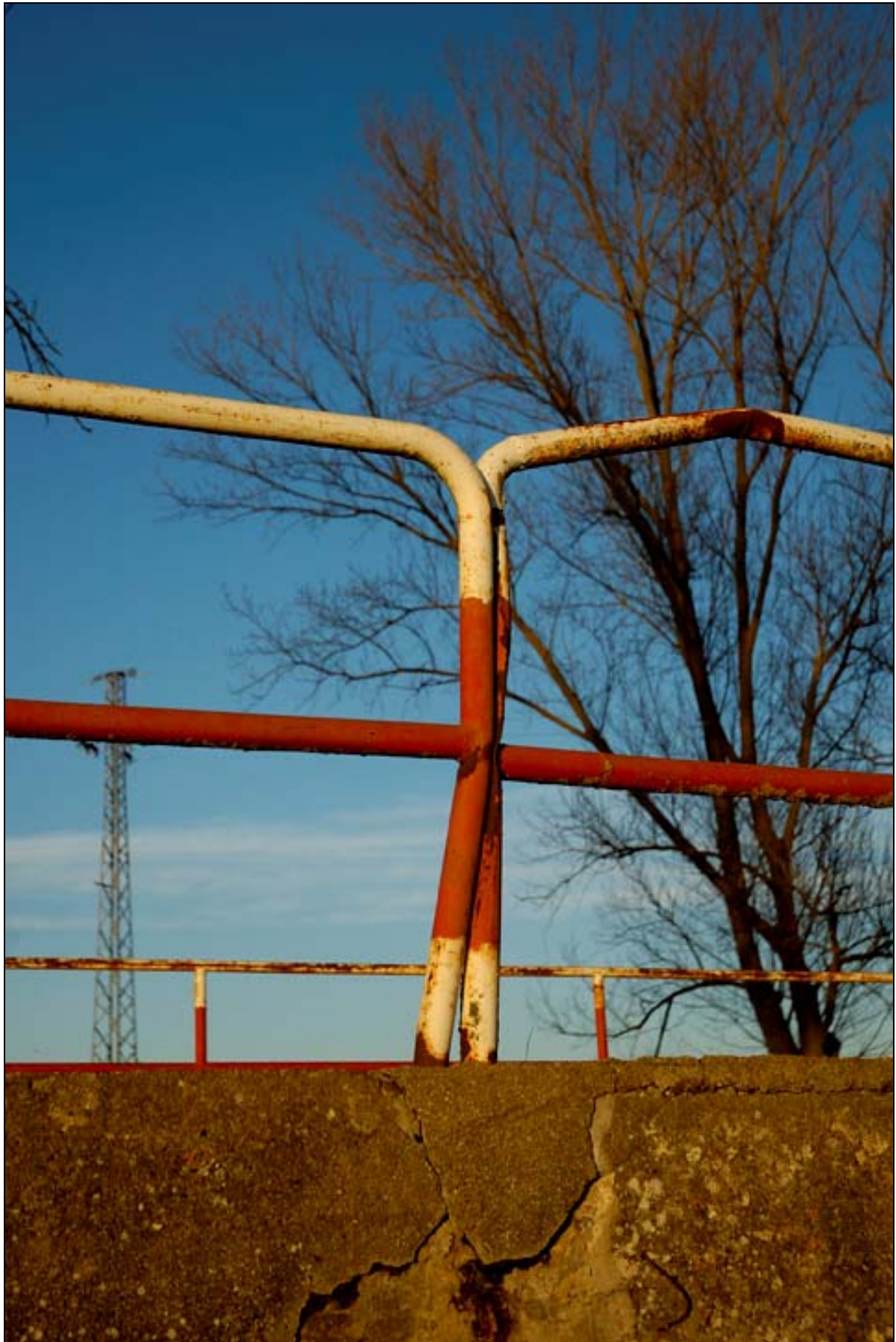
- FOTO 6 Detalle de la barandilla.
