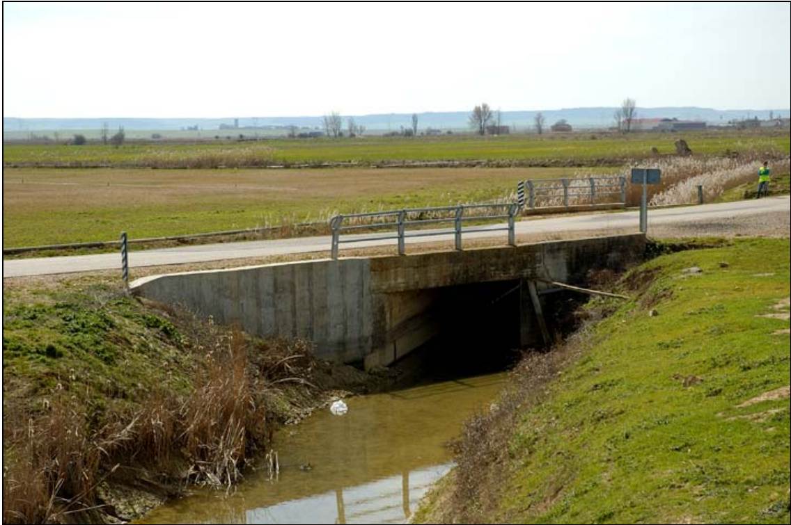
- FOTO 1 Vista general del Puente y su entorno.
