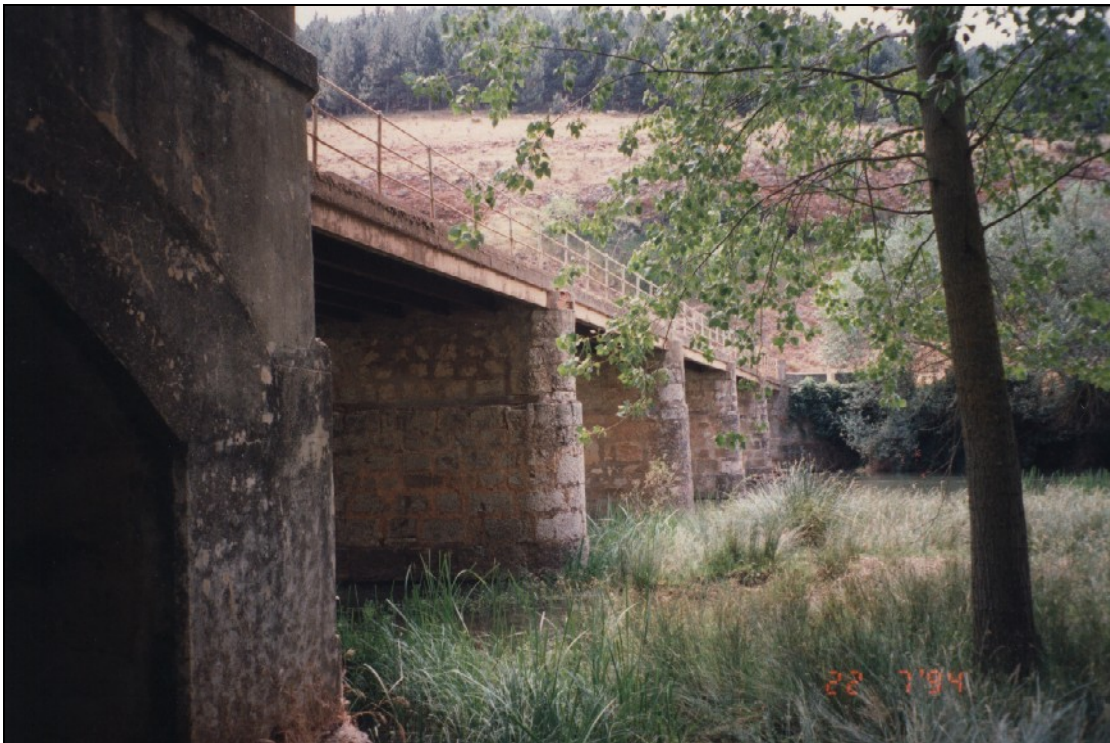
- FOTO 2 Detalle desde aguas arriba
