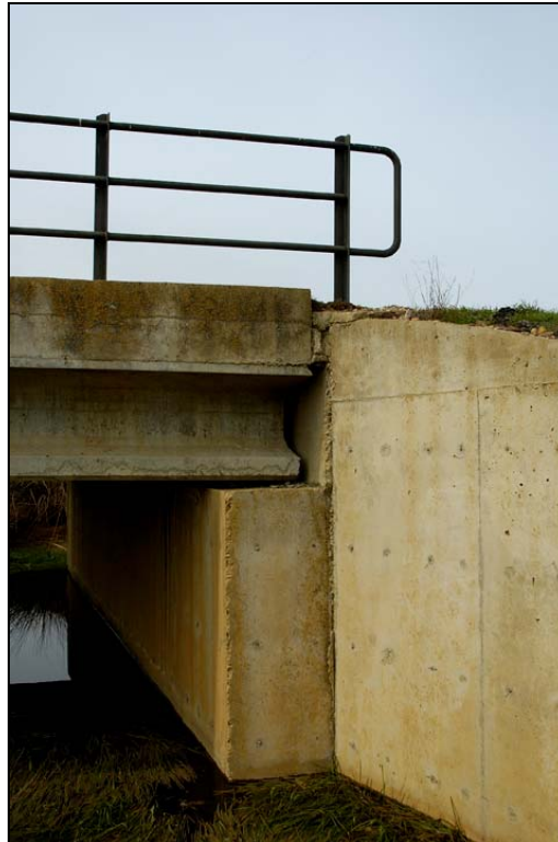
- FOTO 4 Detalle: estribo-viga/losa-barandilla.
