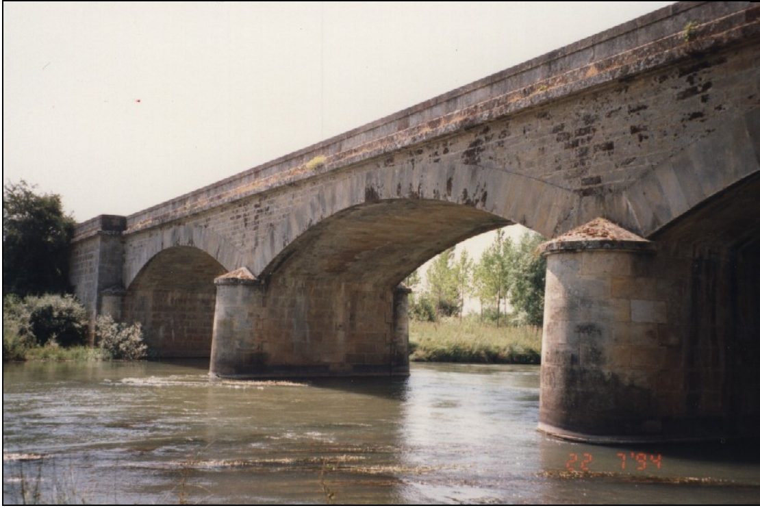
- FOTO 1 Vista del Puente desde aguas arriba.
