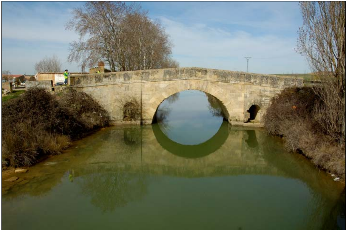
- FOTO 1 Vista general del Puente sobre las aguas del Canal.
