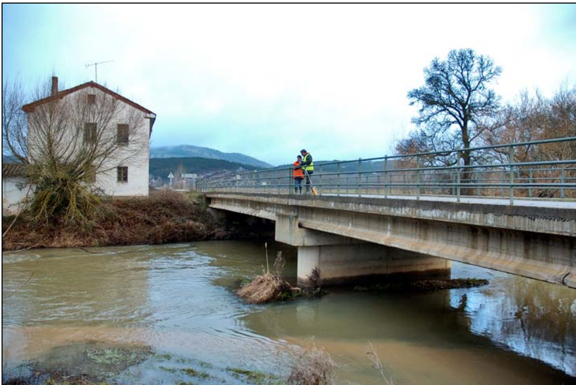
- FOTO 5 Vista desde aguas abajo y margen izquierda.
