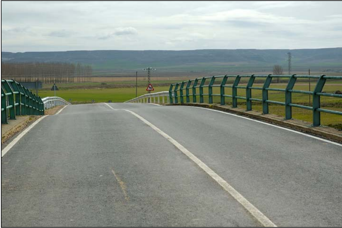
- FOTO 3 Vista de la calzada.
