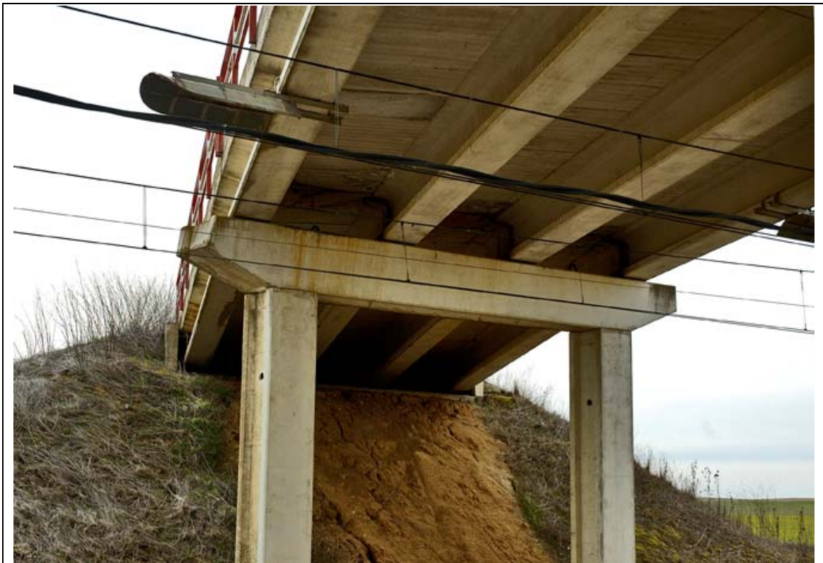
- FOTO 2 Vista de las pilas, dintel, vigas y losa.
