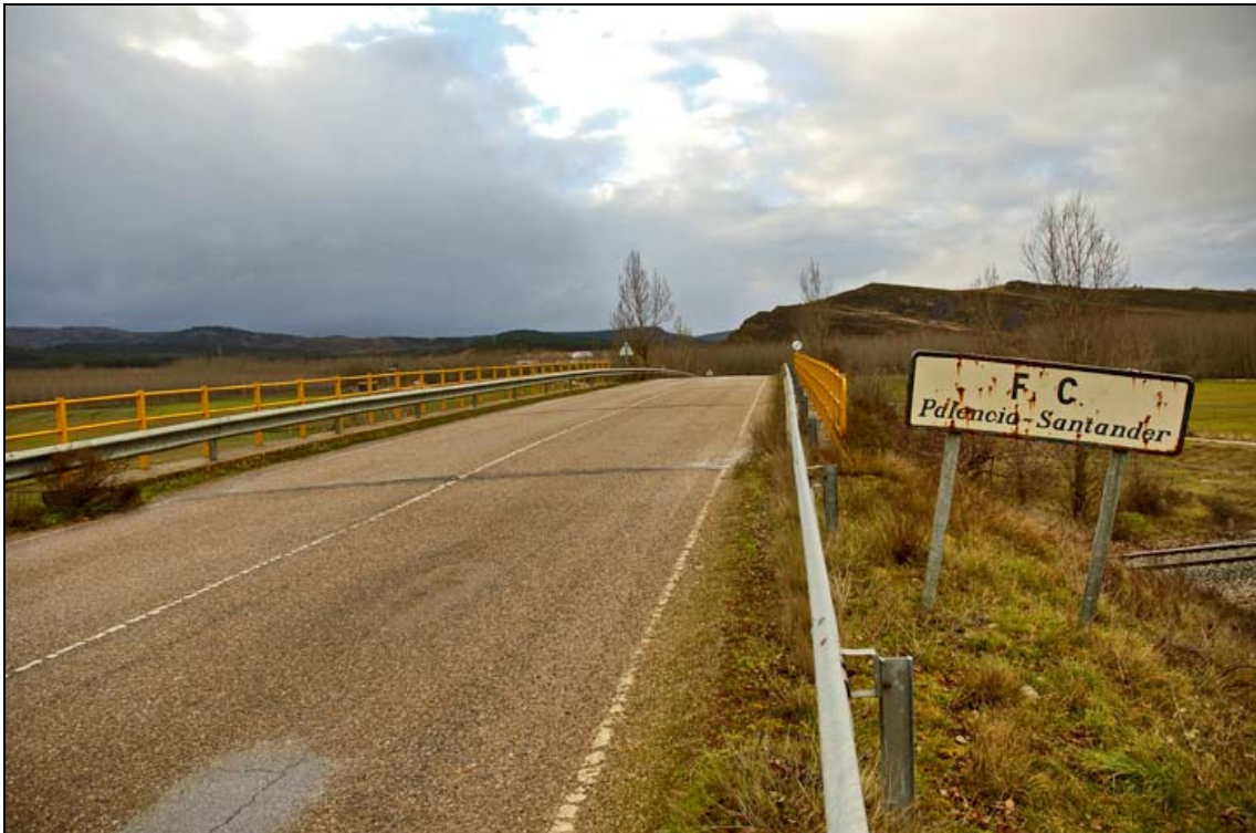
- FOTO 8 La planta y la señalización.
