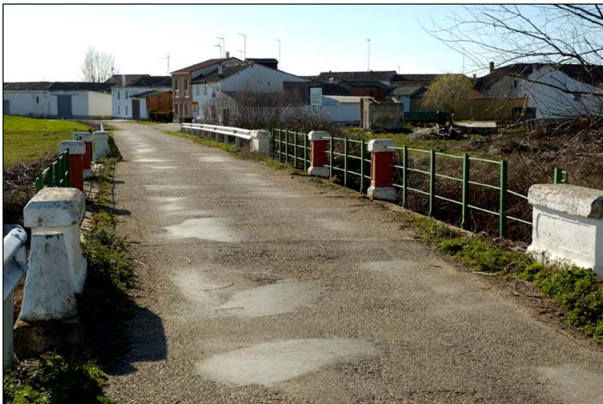
- FOTO 4 La calzada.
