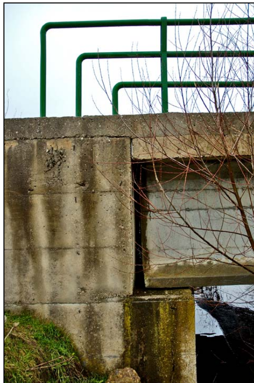
- FOTO 4 Detalle de unión: estribo-viga-barandilla.
