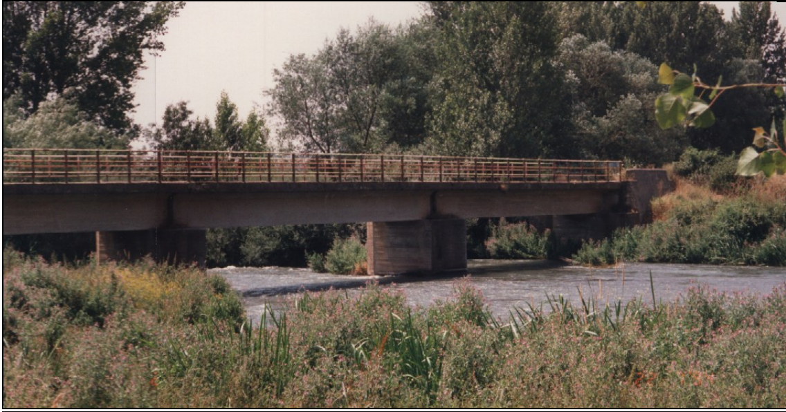
- FOTO 1 Vista desde aguas arriba.
