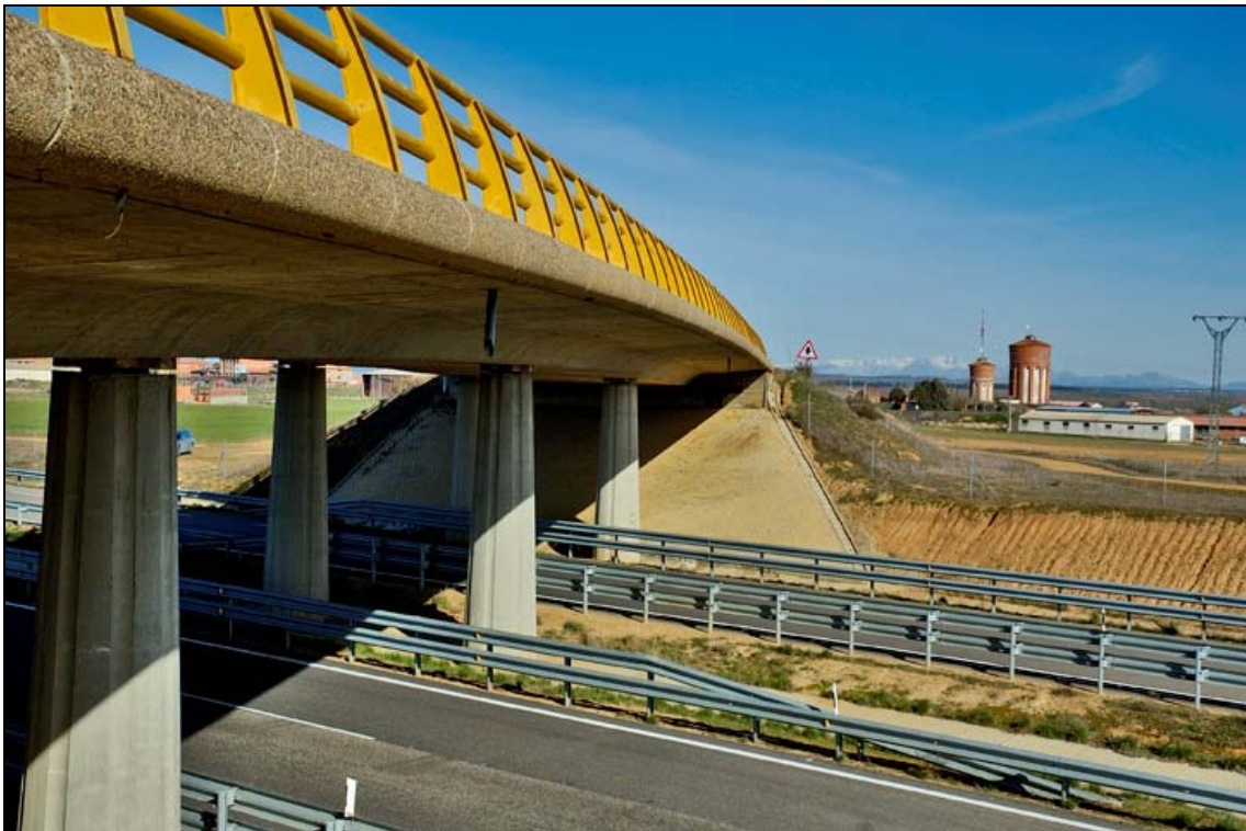
- FOTO 2 Las pilas sujetan la losa del Puente con la barandilla.
