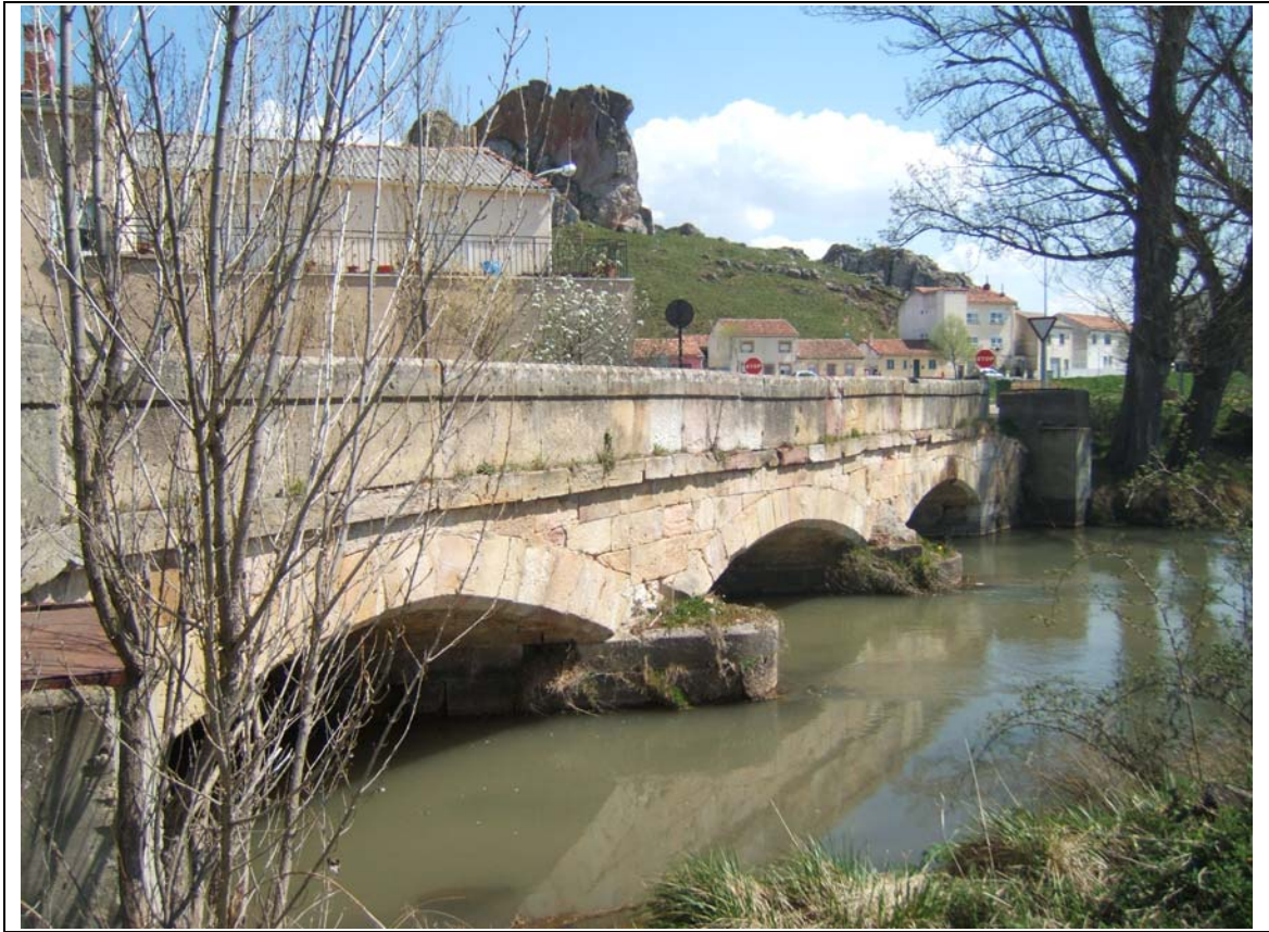
- FOTO 3 El perfil del Puente: arcos, imposta, pretil y albardilla.
