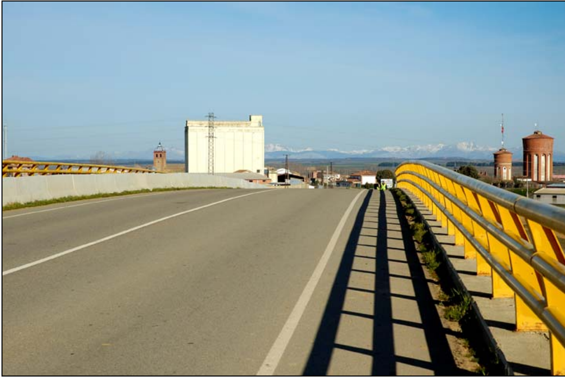
- FOTO 7 Vista de la calzada del Puente.
