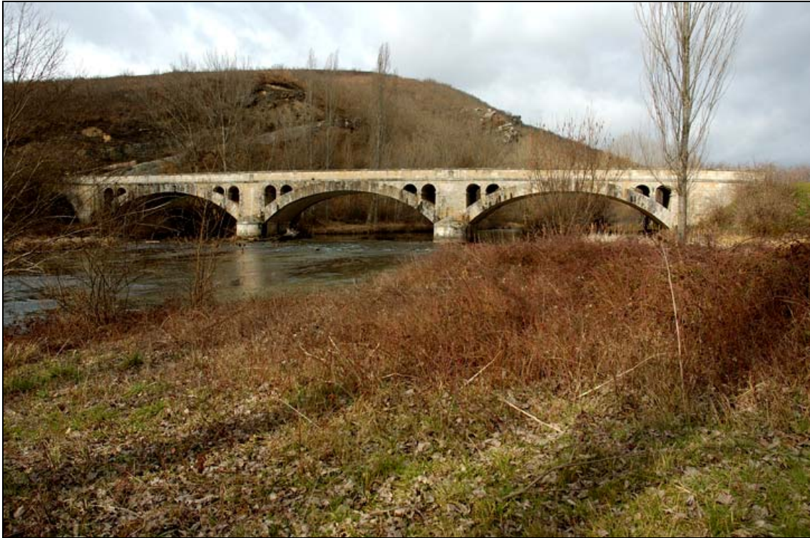
- FOTO 5 Vista general desde aguas abajo del puente y el entorno.
