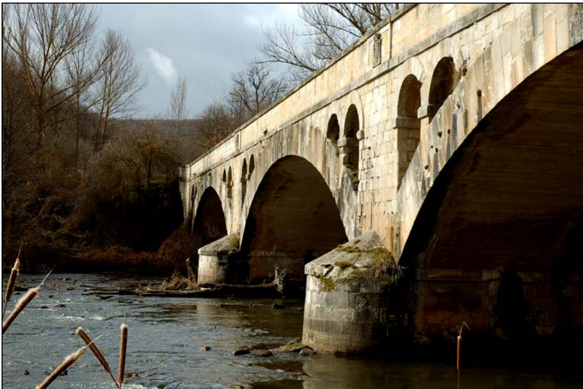
- FOTO 6 Vista desde la margen izquierda.
