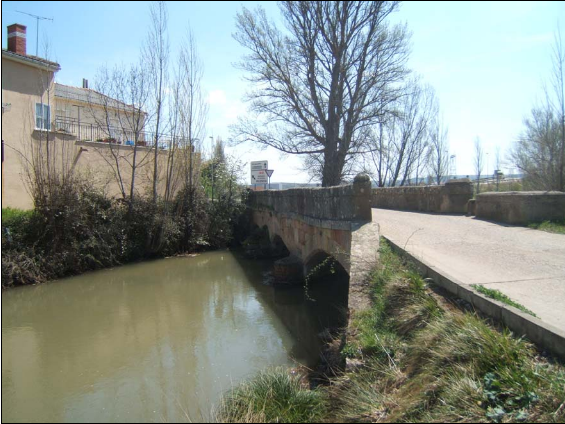
- FOTO 1 Vista del Puente y el río.
