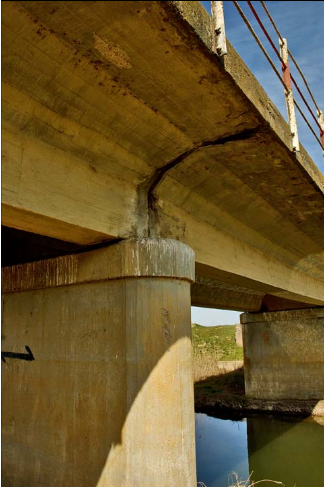
- FOTO 3 Detalle de una de las pilas, con las vigas apoyadas.
