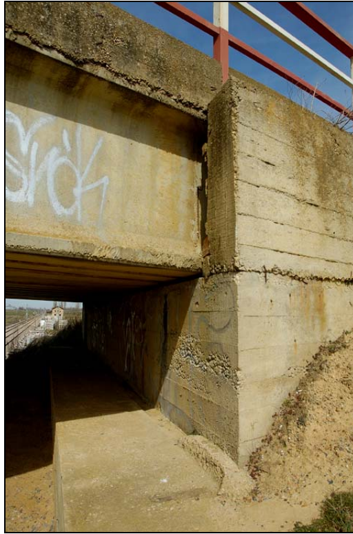
- FOTO 3 Detalle de uno de los estribos, con las vigas apoyadas.
