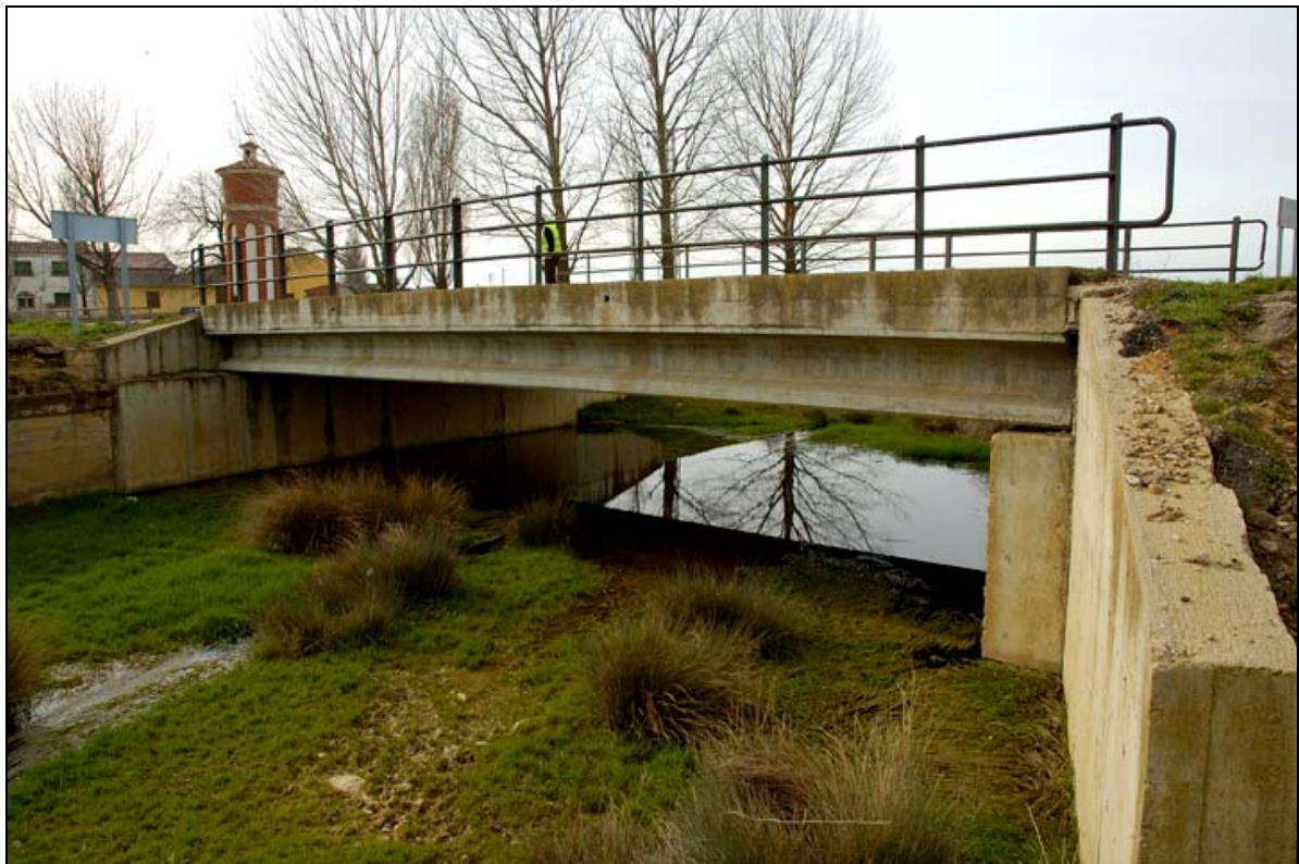
- FOTO 2 El Puente y el cauce.
