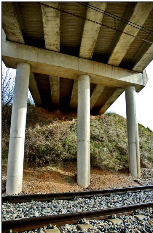
- FOTO 3 Vista de uno de los dinteles con sus tres pilas.
