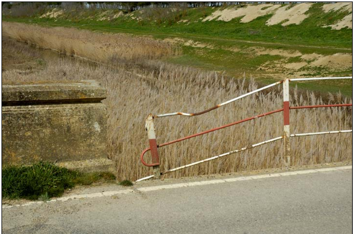
- FOTO 5 Detalle de la barandilla.
