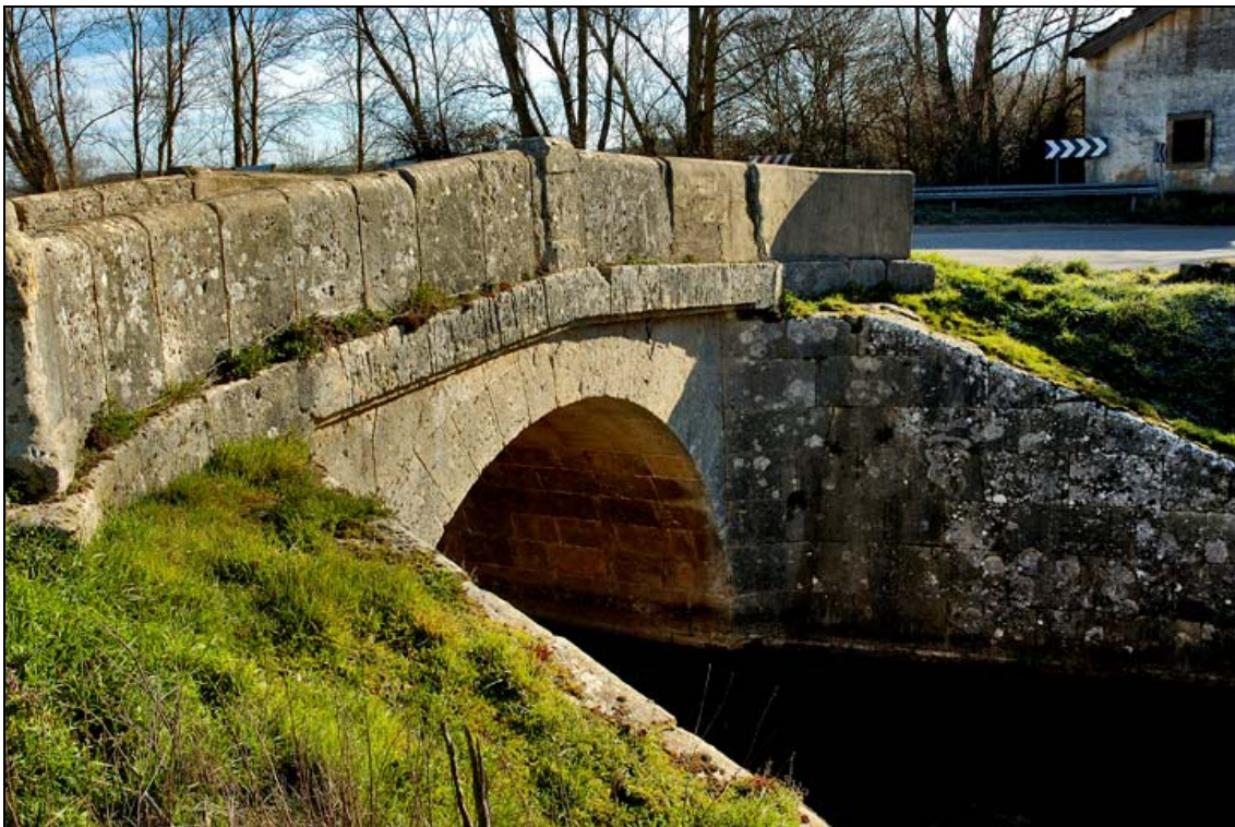
- FOTO 2 Vista del pretil, la imposta y el arco.
