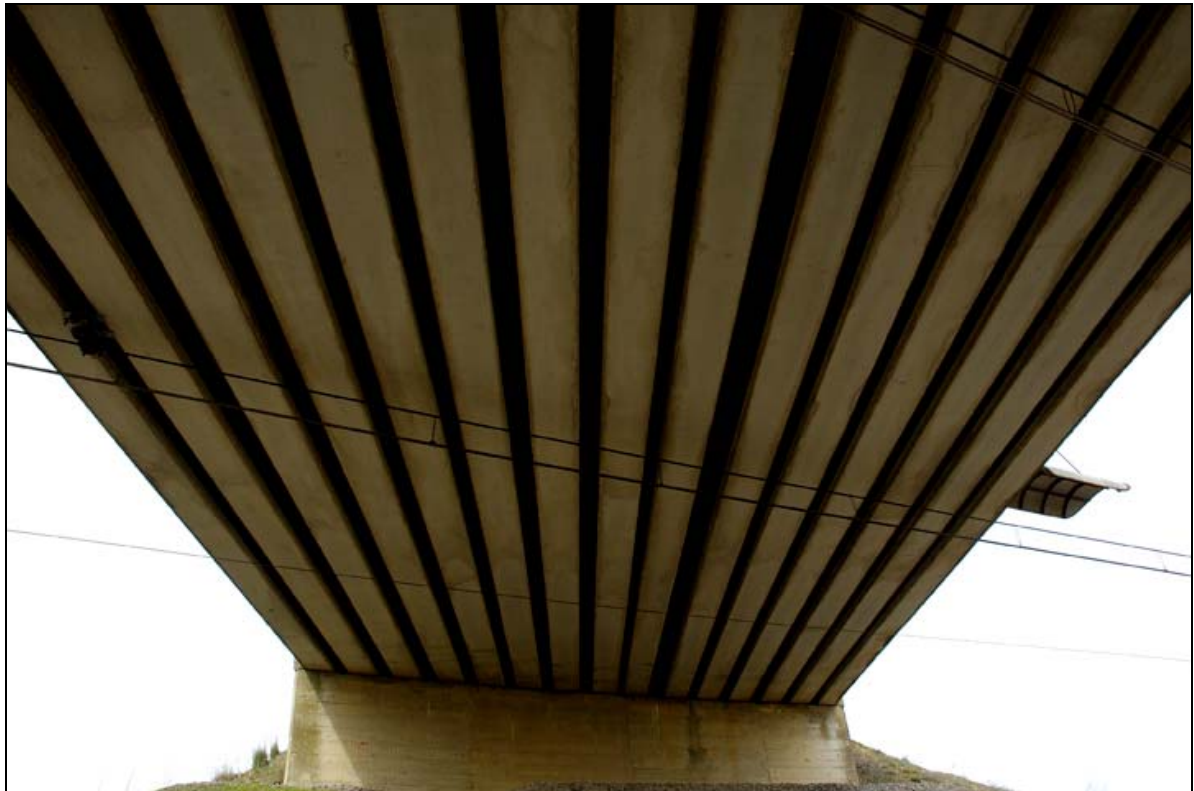
- FOTO 2 Vista inferior de las vigas del tablero.
