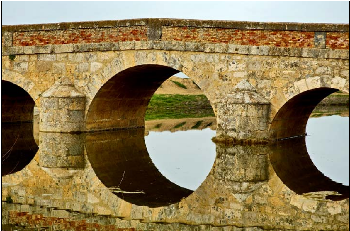
- FOTO 5 Vista parcial de tres de los arcos.
