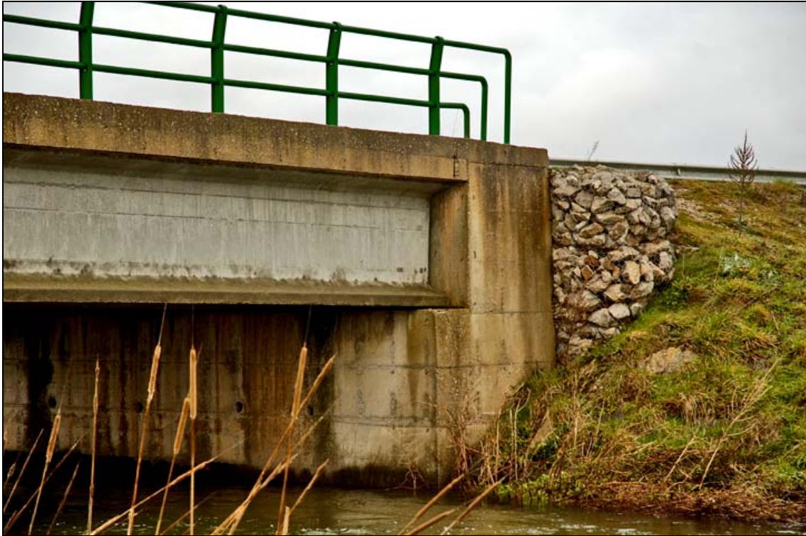
- FOTO 3 Detalle de estribo y talud.
