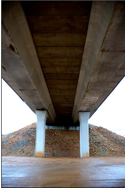
- FOTO 5 Vista interior: vigas y pilas.
