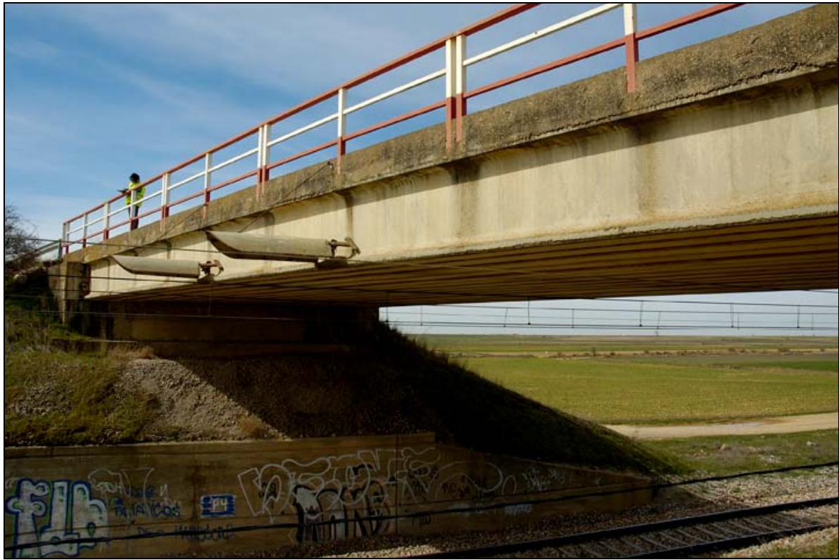
- FOTO 1 Vista general del Puente.
