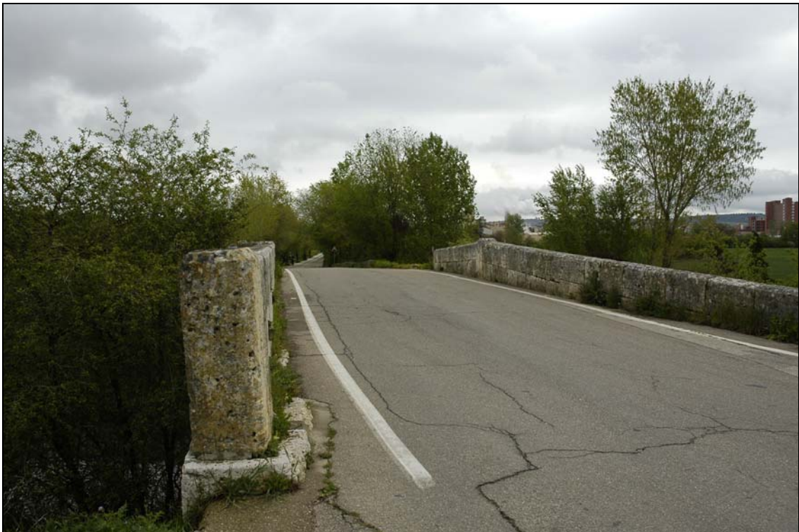
- FOTO 4 La calzada del Puente.
