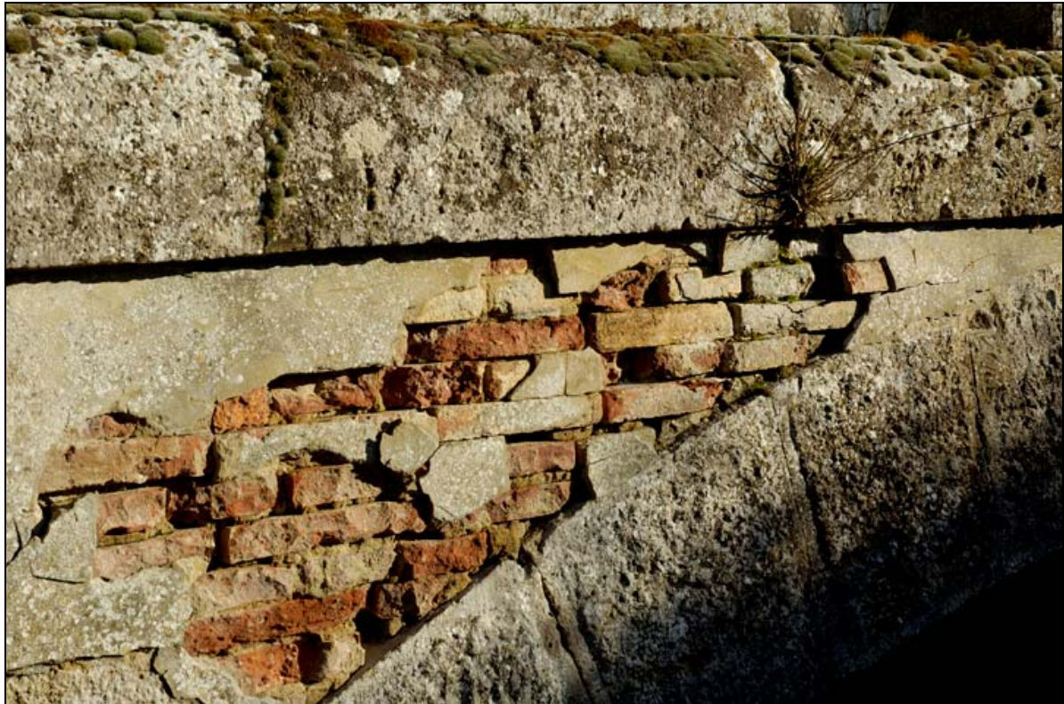
- FOTO 4 Detalle del ladrillo de los tímpanos.
