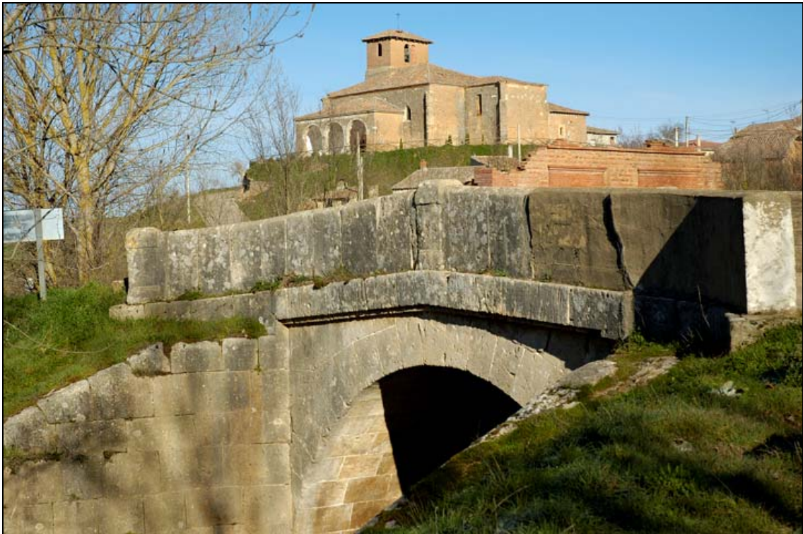
- FOTO 4 Puente e iglesia.
