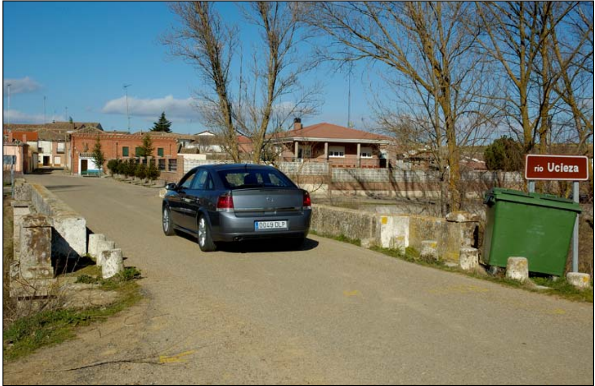
- FOTO 5 La calzada.
