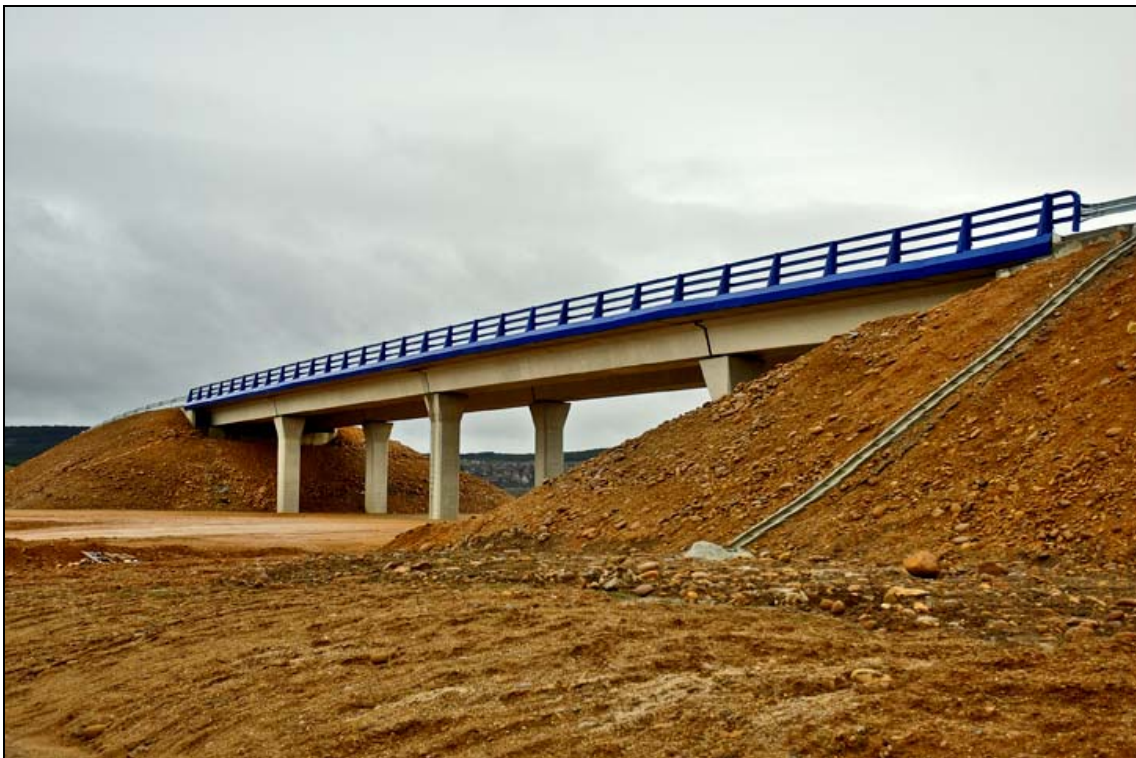
- FOTO 2 Perfil del Puente con su barandilla metálica azul.
