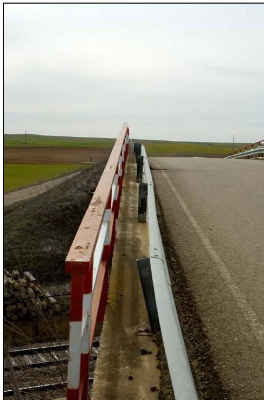
- FOTO 4 Destalle de la barandilla y la banda bionda en uno de los laterales de la calzada.
