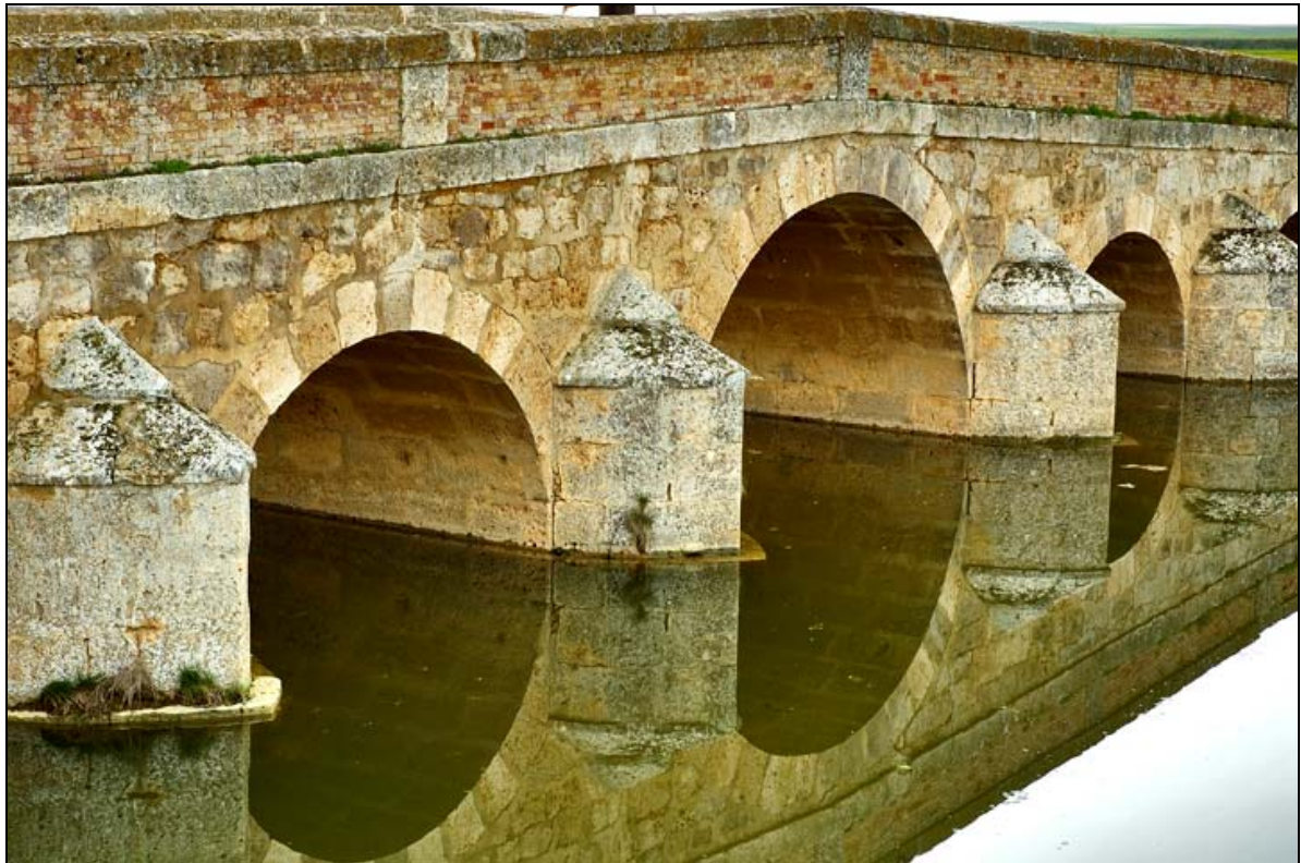
- FOTO 2 Silueta del Puente, con sus tajamares, con sus arcos, con su imposta, con su pretil y con su albardilla.
