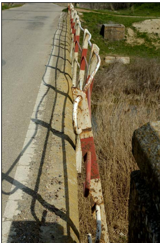
- FOTO 6 Vista longitudinal de la barandilla.
