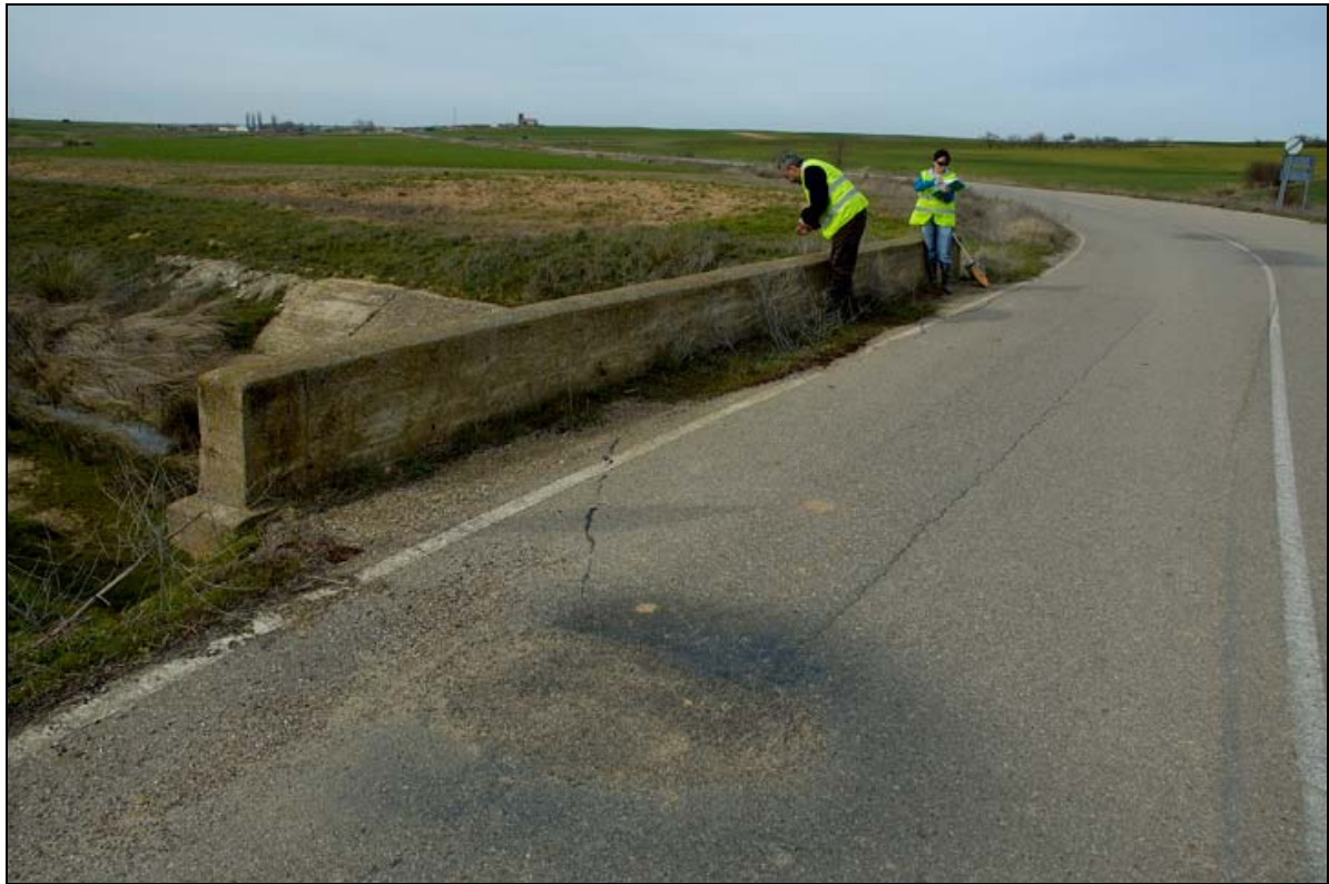
- FOTO 3 Calzada y pretil.
