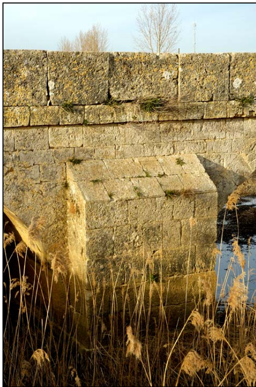
- FOTO 6 Detalle de uno de los espolones, imposta y pretil.
