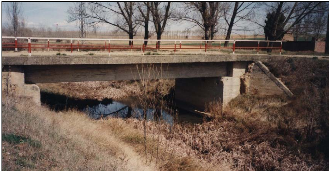
- FOTO 3 El Puente desde aguas abajo.
