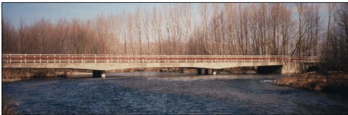
- FOTO 2 Vista general desde aguas abajo.
