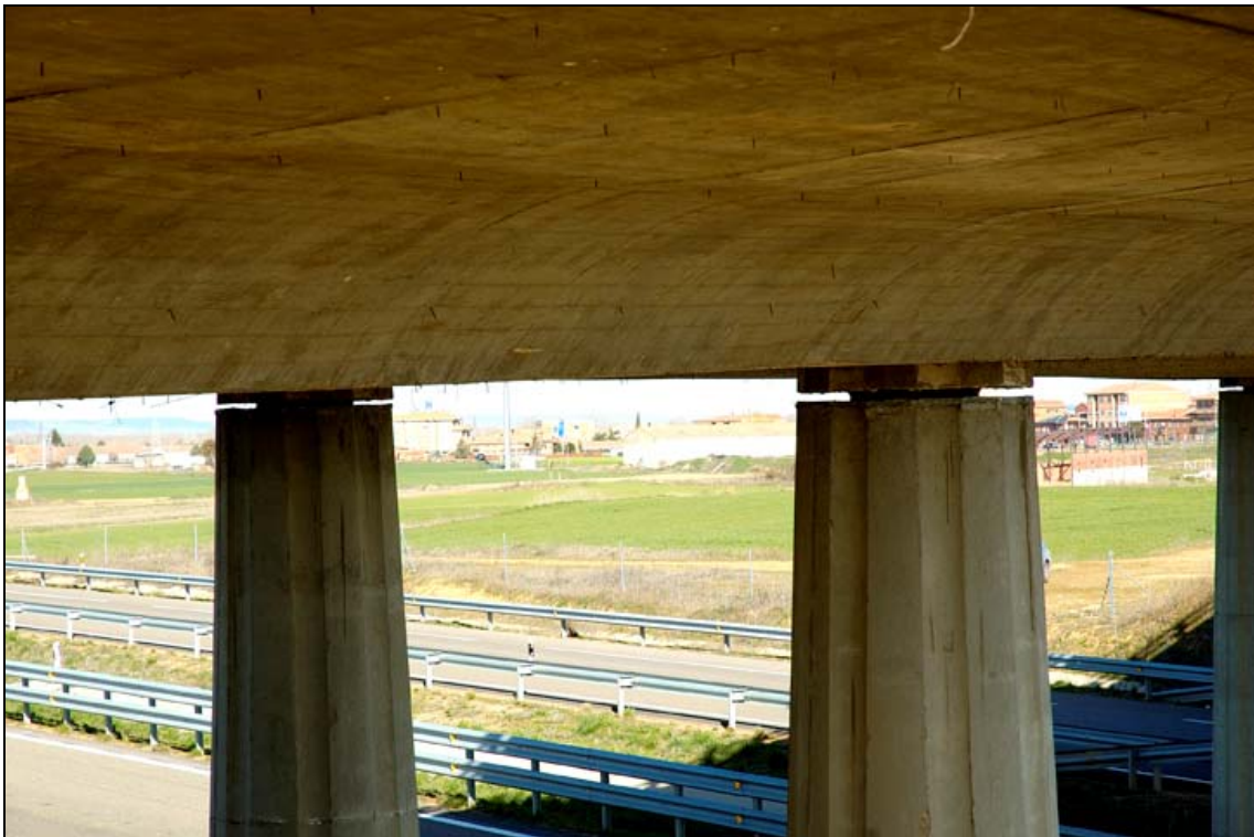
- FOTO 4 Detalle de pilas, apoyos y losa.
